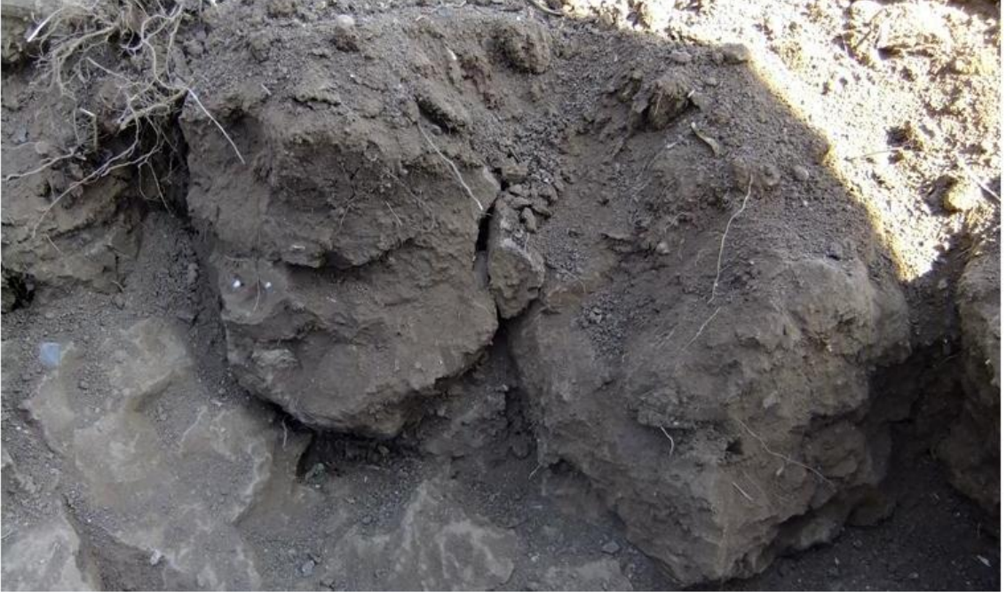
Şekil 4.2. Yüksek kil içeriğine sahip topraklarda oluşan geçirimsiz pulluk katmanı
