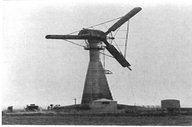
Şekil 7. Danimarka'da faaliyete geçirilen ve ilk modern uygulama olarak kabul edilen Gedser Türbini(Johannes Juul,1959)
