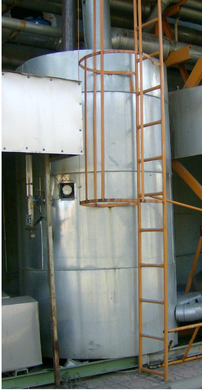
Şekil 5.4 : Flash Buhar Tankı
