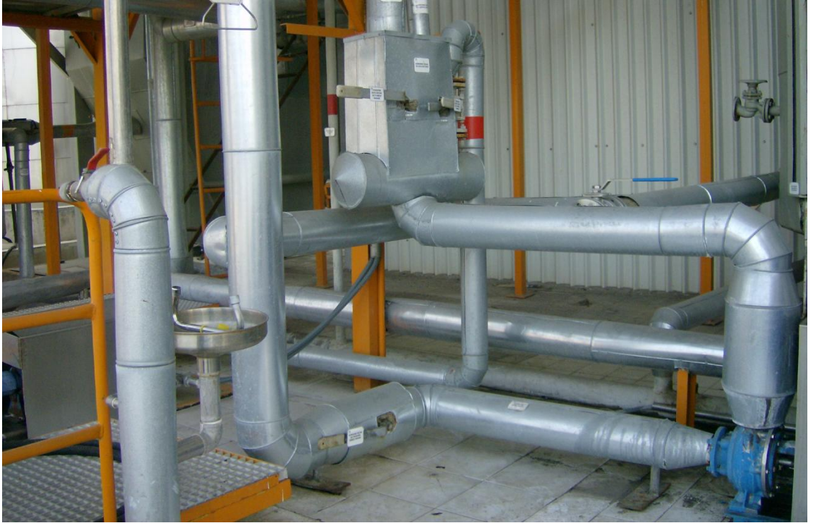
Şekil 5.1 : Buhar Tesisatlarında Boru ve Vana izolasyonu
