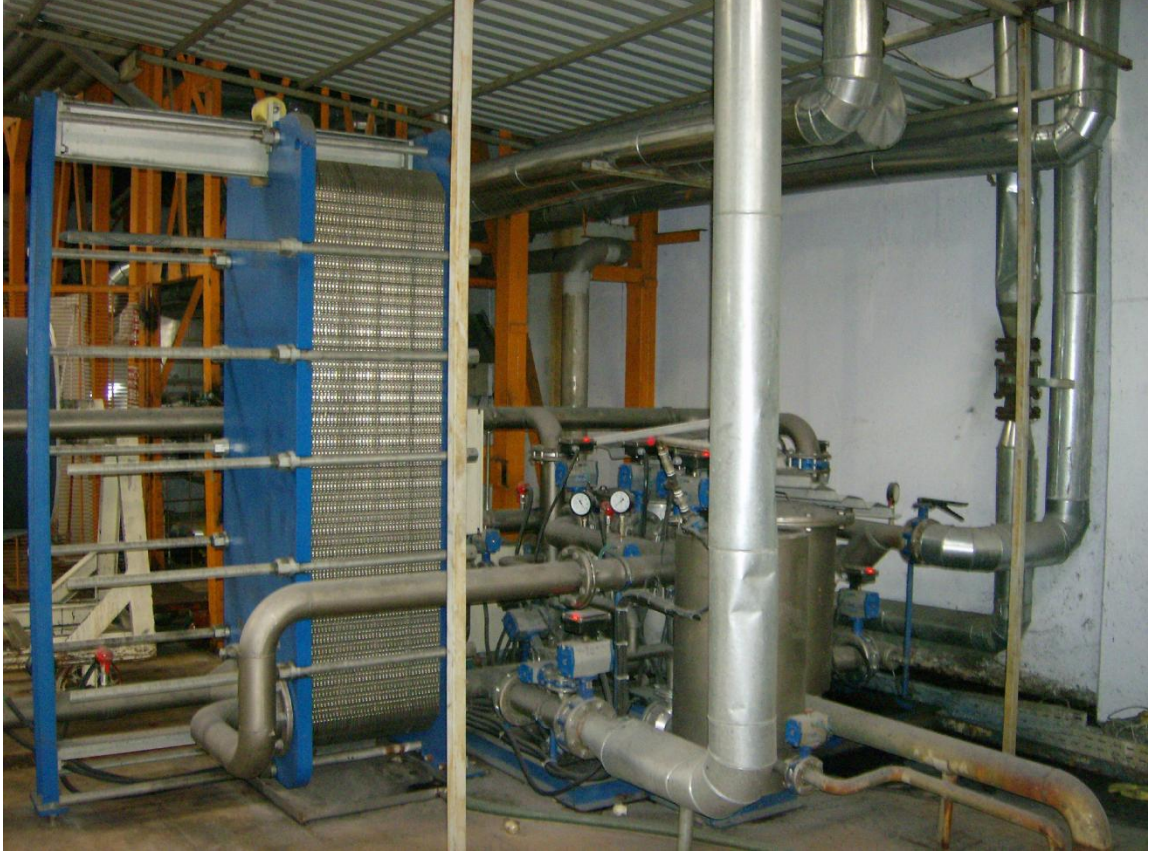
Şekil 5.3 : Blöf Suyu Eşanjörü
