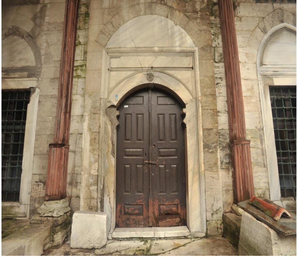
Bayram Paşa Türbesi'nin Kapısı
