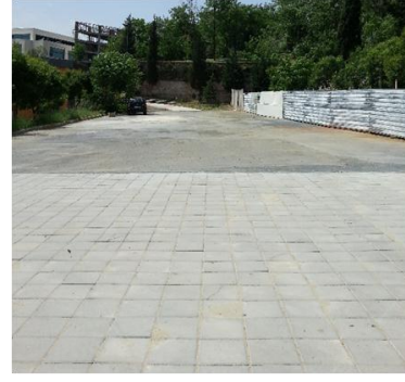
Resim 1.4 : Yerleşke zemin döşemeleri
