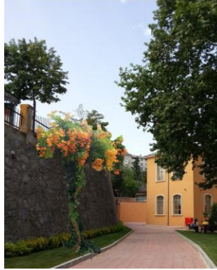
Resim 6.15 : Çevre duvarı üzerine sarılıcı tırmanıcılar
