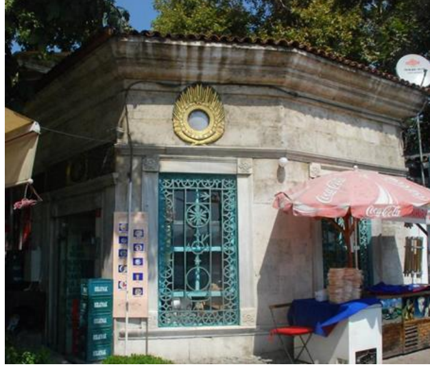
Şekil 3.10 Muvakkithane'nin günümüzdeki durumu.
