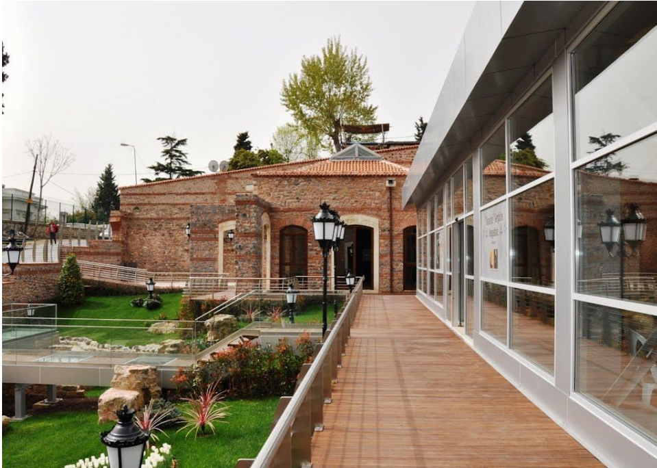
Şekil 3.64 Yapılara girişler (Url-11, 2013).
