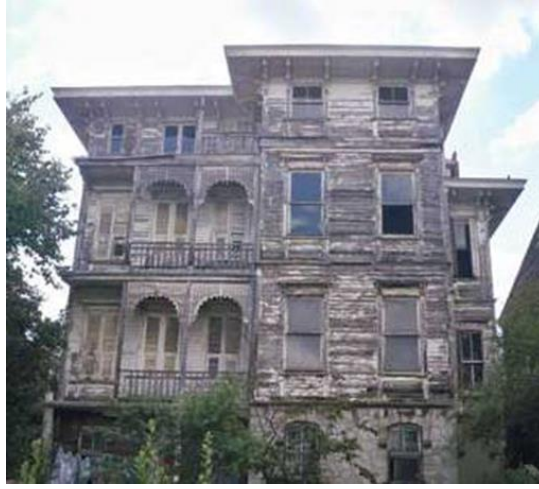
Şekil 3.21 Köşkün restorasyondan önceki durumu (Url-7, 2013).
