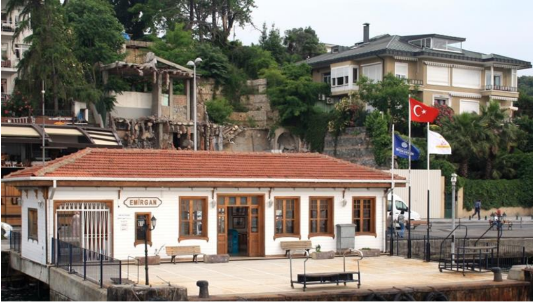
Şekil 3.55 İskele yapısının arkasında yıkıntı halindeki Mürre Yalı Rekonstrüksiyonu (Url-4, 2013).
