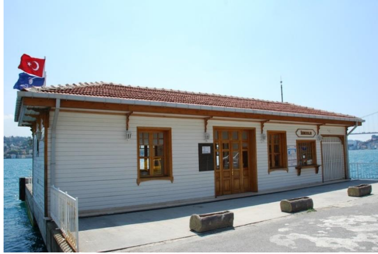
Şekil 3.4 Günümüzde Emirgan iskele yapısı (Url-4, 2013).
