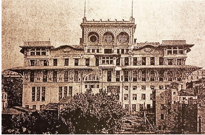
Resim 4.33: Bank-ı Osmani-i Şahane Binası deniz cephesi(Dengiz, 2005: 20)
