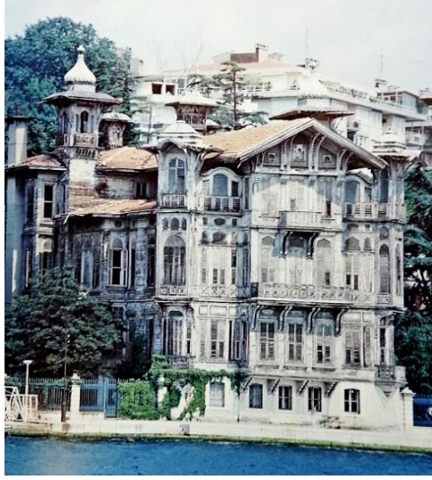
Resim 4.42: Muhayyeş Yalısı giriş cephesi(Kuban, 1995: 95)
