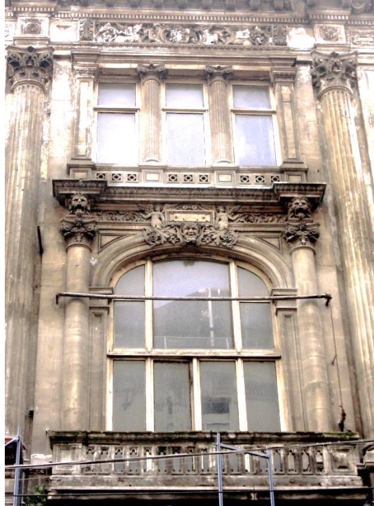
Resim 4.36: Cercle d'Orient Binası giriş cephesi detayı(URL-4)
