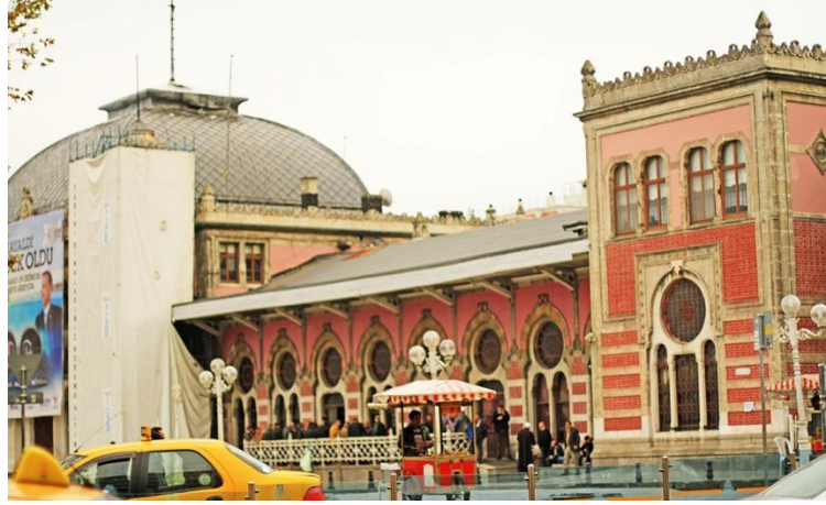
Resim 4.60: Sirkeci Tren İstasyonu cephe fotoğrafı
