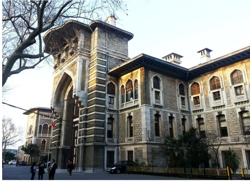
Resim 4.31: Düyun-i Umumiye Binası giriş cephesi
