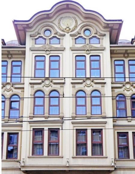
Resim 4.22: Tayyare Apartmanları cephe fotoğrafı
