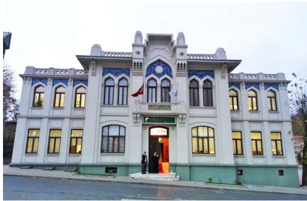
Resim 4.27: Fatih Sultan Mehmet Vakıf  niversitesi Rekt rl k Binası
