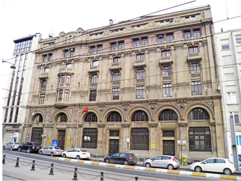
Resim 4.59: Karaköy Palas cephe fotoğrafı
