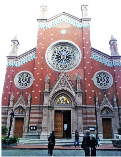
Resim 4.48: Saint-Antonie Kilisesi giriş cephesi
