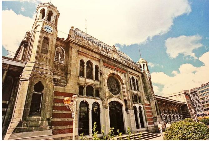
Resim 4.49: Sirkeci Tren İstasyonu ana binasının ön cephesi(Aslanapa, 2004: 546)
