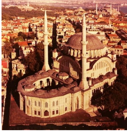
Resim 2.3: Nuruosmaniye Cami cephesi (Kuban, 2013: 43)
