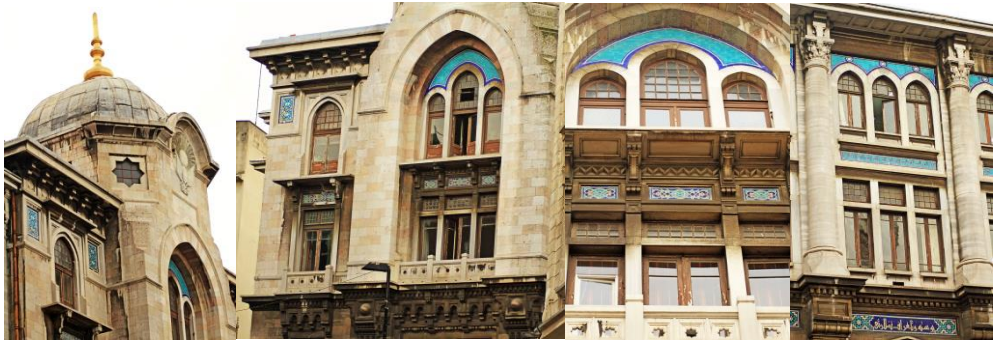
Resim 4.61: Posta ve Telgraf Nezareti Binası
