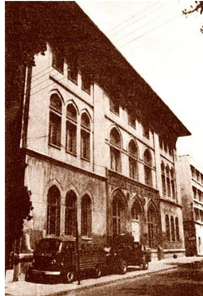
Resim 4.14: Medreset-ül Kuzat cephe fotoğrafı(Dengiz, 2005: 51)
