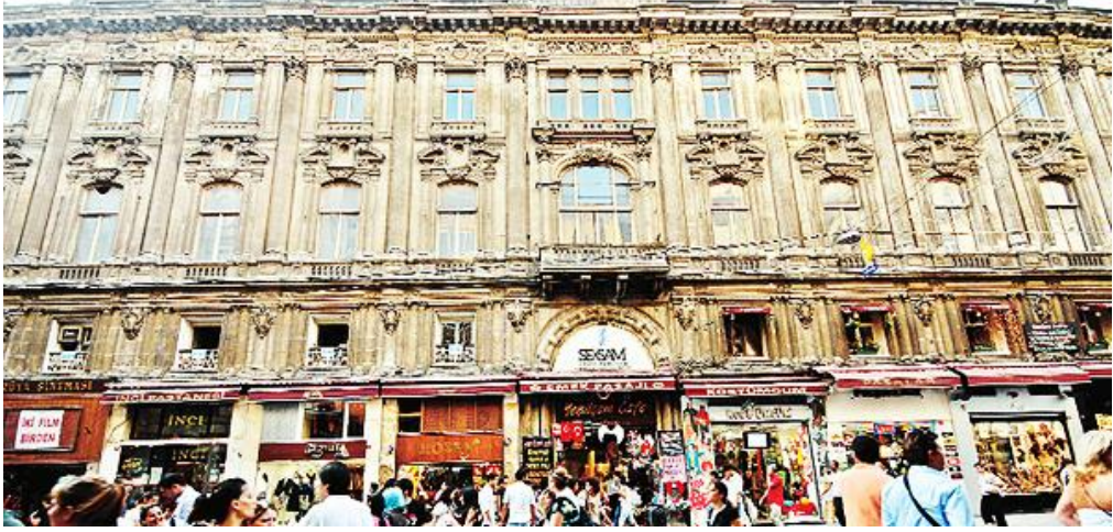
Resim 4.35: Cercle d'Orient Binası ön cephesi(URL-3)
