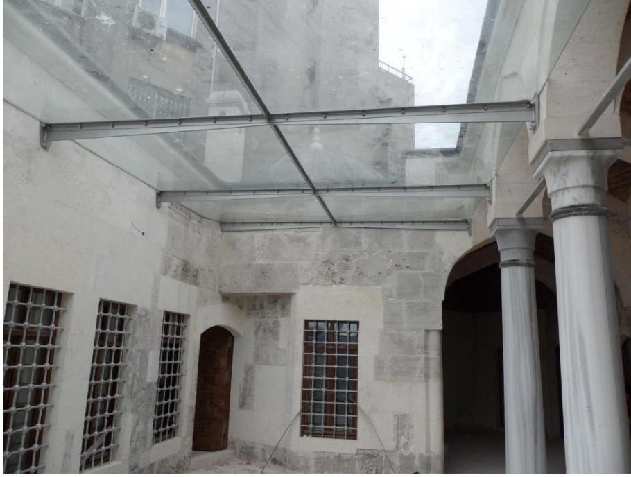
Resim 5. 34 Hadım Hasan Paşa Medresesinin Kapatılan Avlusu (Memoğlu, 2011)
