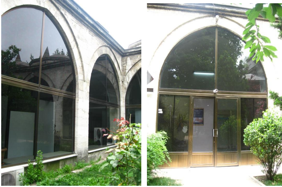
Resim 5. 72 Sultan Selim Medresesi Revakları (Üveysuna, 2013)
