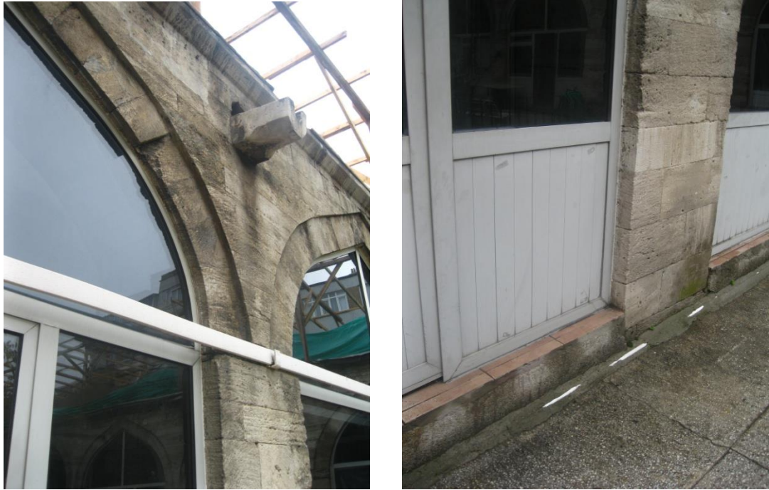
Resim 5. 19 Cedid Ali Paşa Medresesi Taşıyıcı Revak Kemerlerin Taşıyıcı Elemanları (Üveysuna, 2013)
