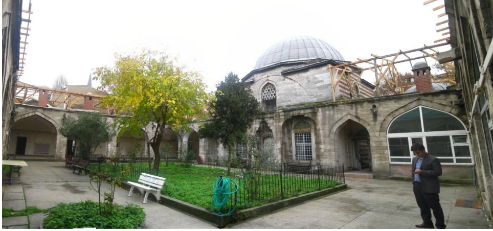
Resim 5. 16 Cedid Ali Paşa Medresesi Avlu ve Dershanesi (Üveysuna, 2013)
