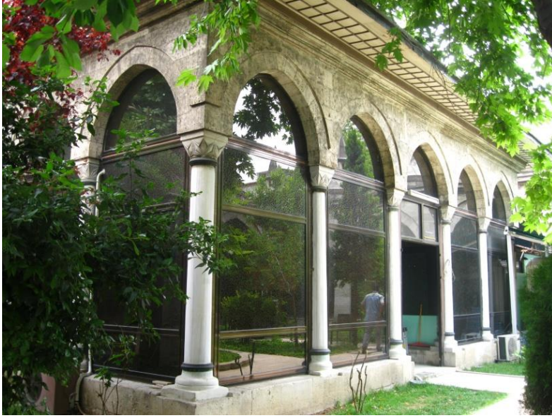
Resim 5. 74 Sultan Selim Medresesi Dershanesi (Üveysuna, 2013)
