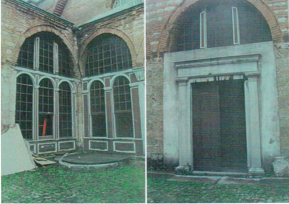
Resim 2. 18 1982-83 Atriumdaki Ahşap Pencere Doğramalarının Onarım Sonrası Fotoğrafları (Yücel, 2009)
