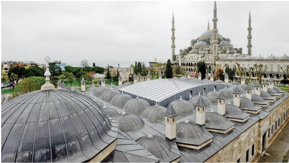
Resim 5. 67 Sultanahmed Medresesi Üst Avlu Örtüsü
