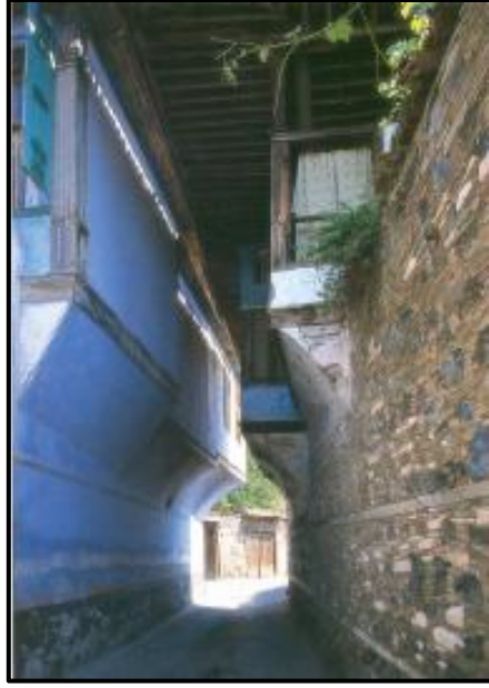
Resim 6 Kula sokaklarında çıkmalar (Bektaş, 1996)
