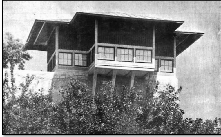
Resim 46 Taşlık Kahvesi Cephe
