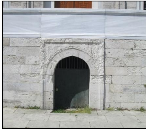
Resim 53 Darülkurra Altında Kemerli Açıklık (Aykutlu, 2014)
