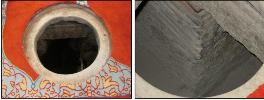
Resim36 Cami İçindeki Kapak ve Zemin Altındaki Galeriler (Aykutlu, 2014)
