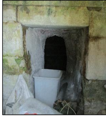
Resim 52 Darülkurra Altı Sarnıç, Havalandırma Açıklığı (Aykutlu, 2014)
