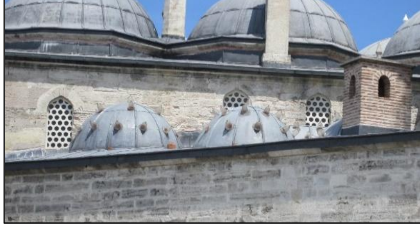
Resim 66 Darüşşifa Hamamı Kubbeleri (Aykutlu, 2014)
