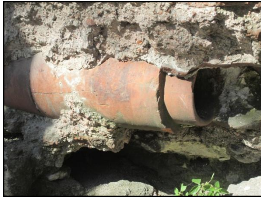
Resim37 İmaret Duvarında Suyolu ve Künk (Aykutlu, 2014)
