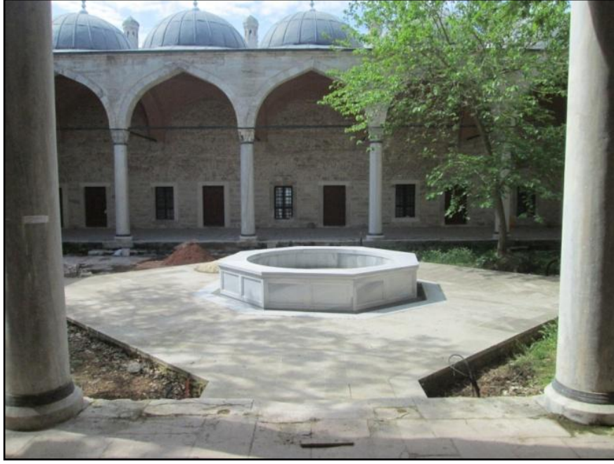
Resim 67 Darüşşifa Havuzu 1 (Aykutlu, 2014)
