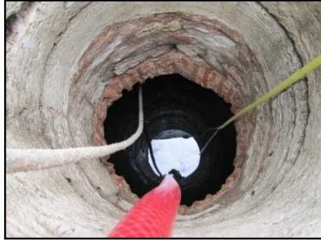
Resim 50 Kuzeydoğu Sarnıca Açılan Kuyu Ağzı
