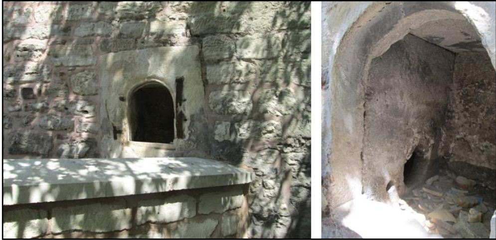
Resim 83 Darülhadis Duvarındaki Maksem'den Detay (Aykutlu, 2014)
