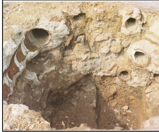
Resim 2 Bozdoğan Kemerini Üzerinde Künkler (Çeçen, 1992)
