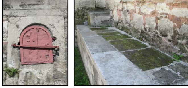
Resim 63 Maksem ve Suyolunun Geçtiği Set (Aykutlu, 2014)
