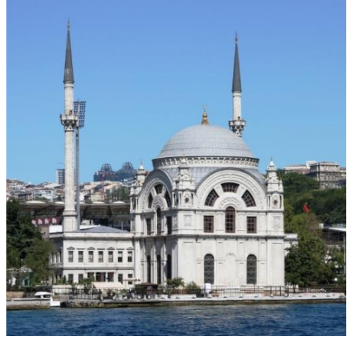
Resim 2.37 Dolmabahçe Cami (Cambaz, 2009)
