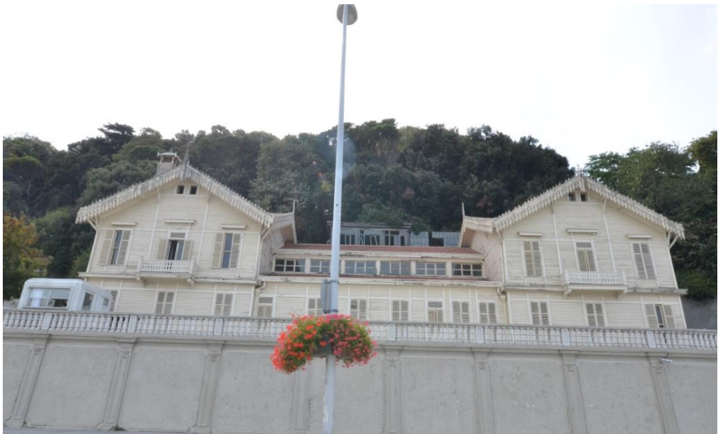
Resim 3.23 Faytonhane mevcut durumu
