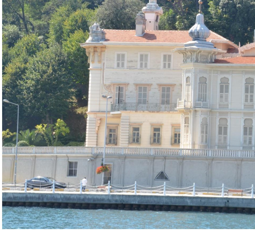
Resim 4.63 Huber Köşkü şarap mahzenindeki havalandırma delikleri
