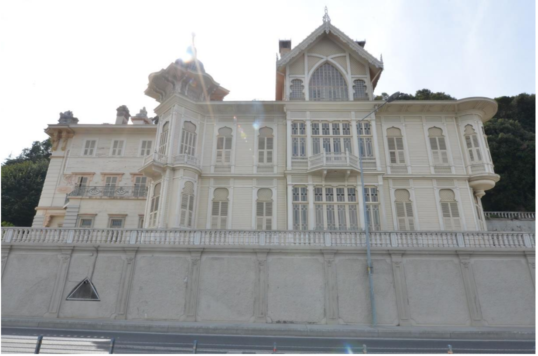
Resim 4.38 Huber K şk  sahil duvarları
