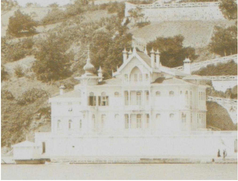
Resim 4.48 Huber Köşkü açık balkon cephesi (İstanbul Üniversitesi Nadir Eserler Kütüphanesi).
