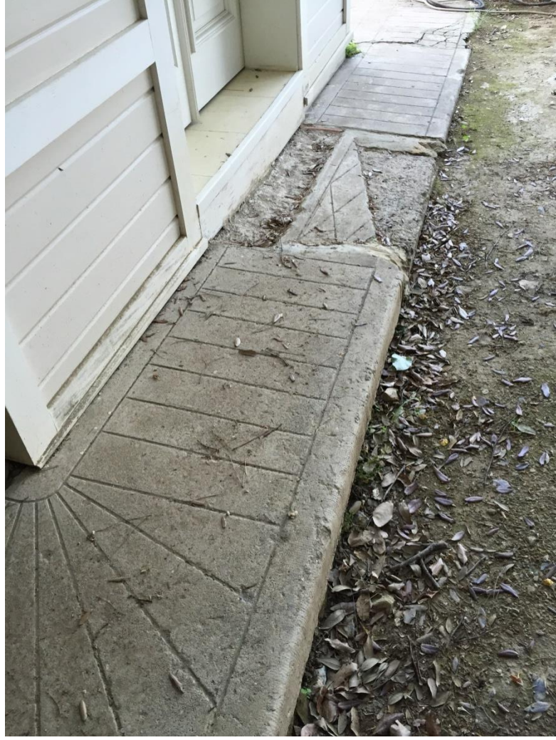
Resim 4.61 Set Köşkü İngiliz betonu orijinal kaldırımı
