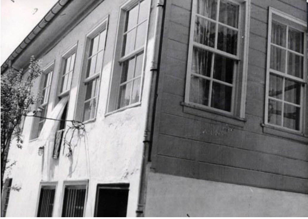
Resim-46. Vani Mehmed Efendi Cami güneydoğu cephesi, 1968 onarımı. (VGM arşivi)
