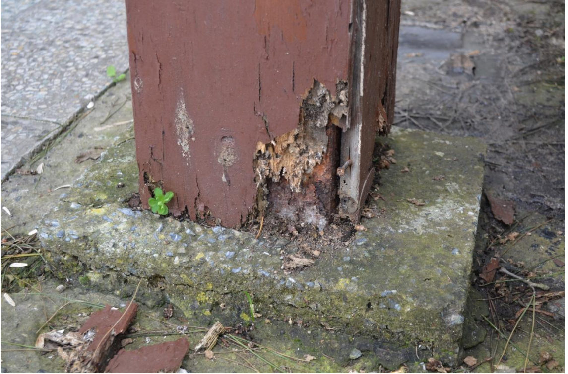
Resim-292. Hünkar Köşkü çıkmasını taşıyan metal putrel ayak, üzeri ahşap kaplama ve beton kaide detayı. 03.04.2015
