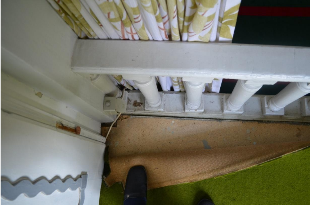
Resim-169. Kadınlar mahfili döşeme ahşap üzeri sunta levha kaplama üzeri halı kaplama. 03.04.2015.
