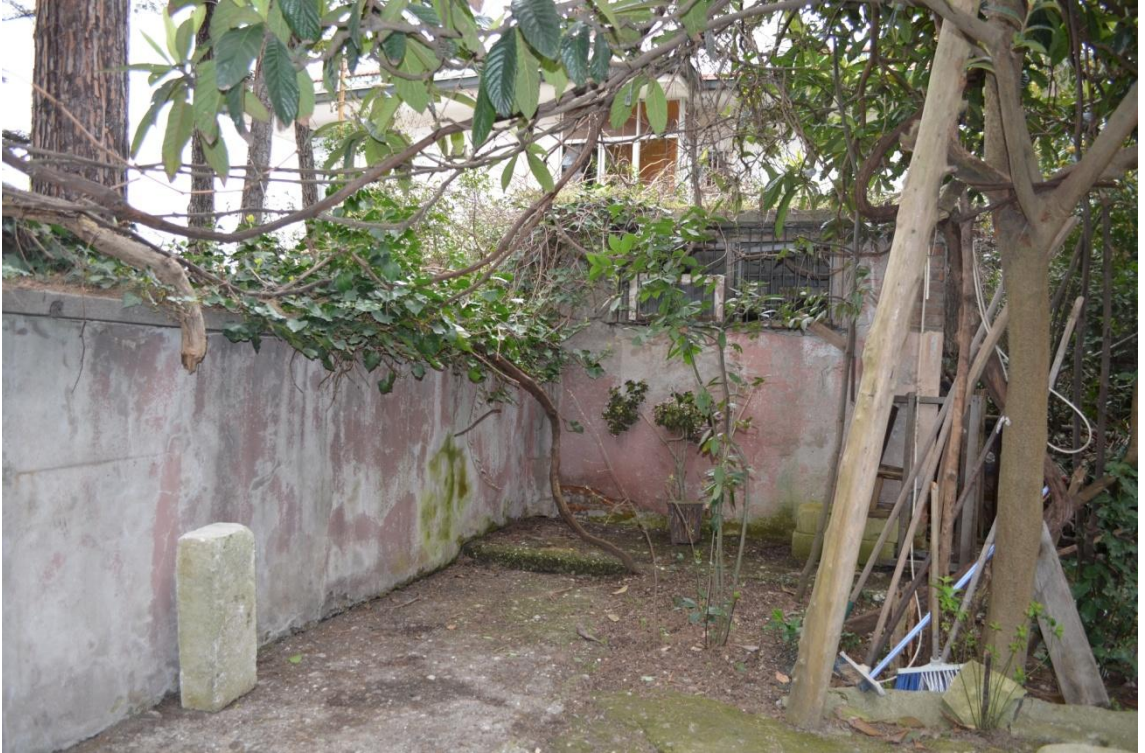
Resim-87. 27 parselin kuzeydoğu köşesine Kandilli Rasathanesi Müdürlüğüne 1969 senesinde inşa ettirilen tuğla kargir yapı. 03.04.2015
