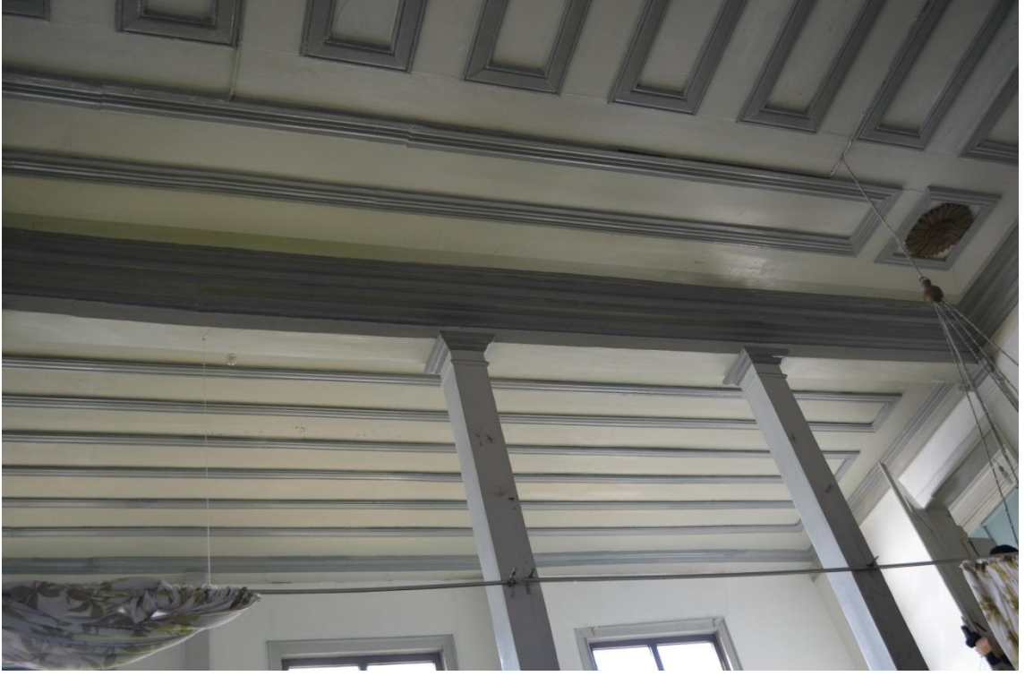
Resim-182. Kadınlar mahfili tavan kaplaması kuzeye doğru bakış.. 03.04.2015.
