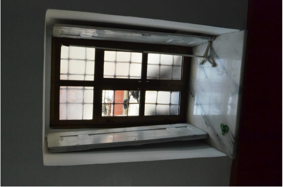
Resim-251. Harim güneybatı duvarı üzerindeki alt sıra pencerenin harimden görünüşü. 03.04.2015.
