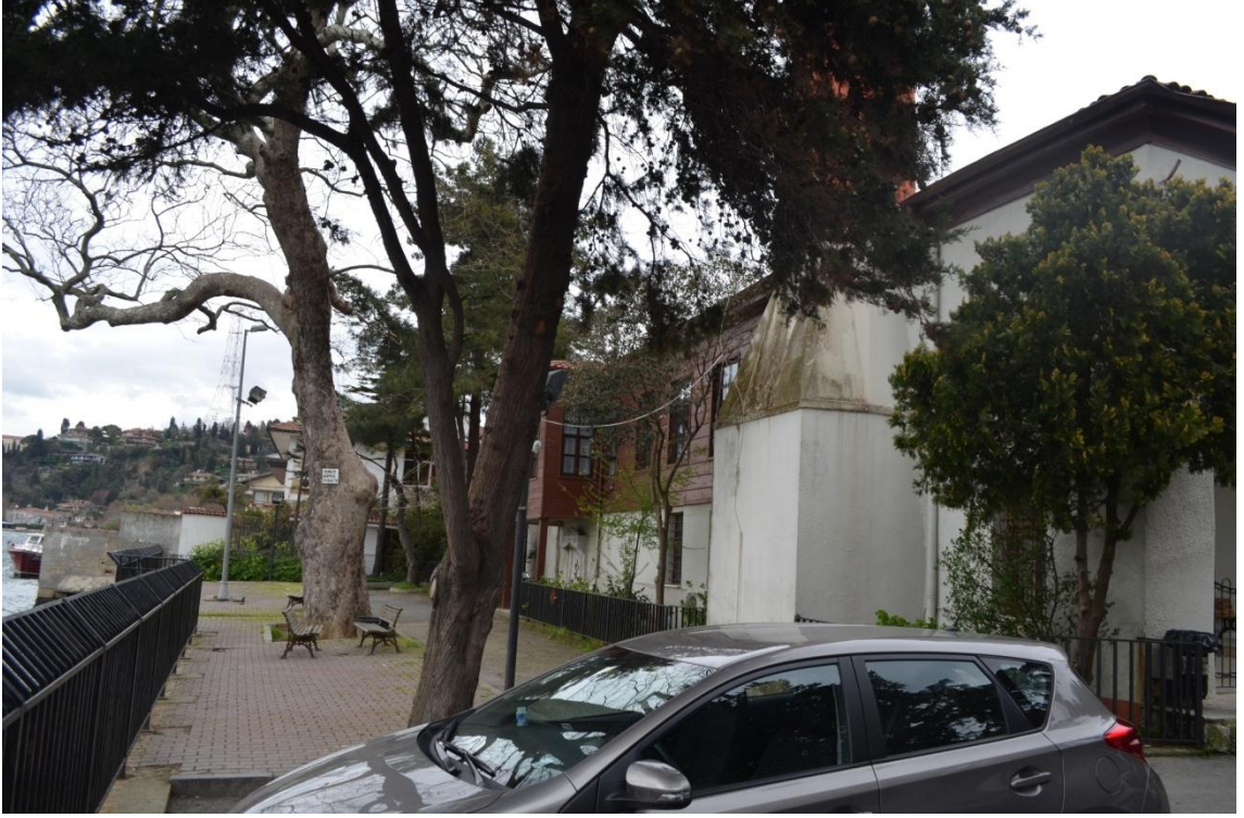
Resim-60. Vaniköy Cami Sokak üzerinden Son Cemaat kısmı, minare kaidesi, mahfil katı kuzeybatı cephesi görünüşü. Ortadaki çınar ağacı tescillidir. 03.04.2015
