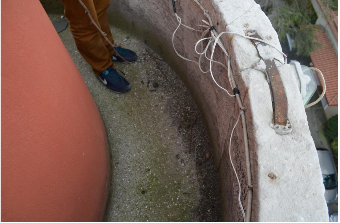
Resim-216. Minare şerefesi, zemin kaplaması ve petek gövdesi. 03.04.2015.
