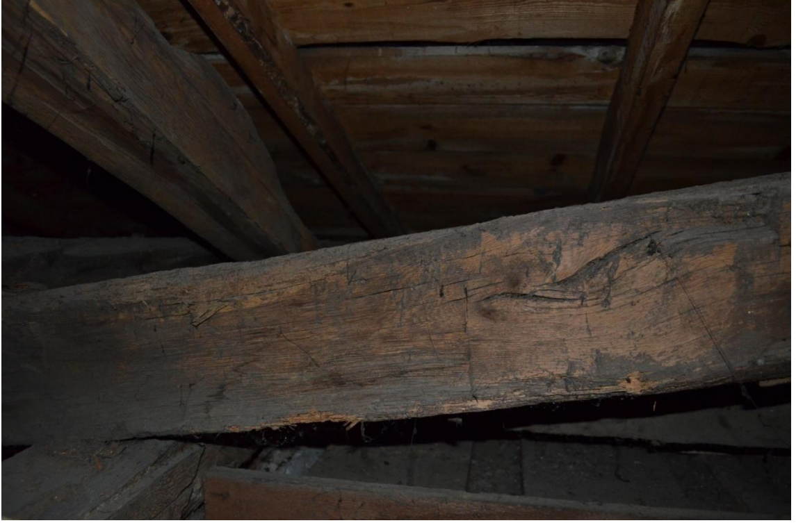
Resim-198. Harim Köşkü mutfak bölümü tavanın deliğinden çatı makası görünüşü. 03.04.2015.
