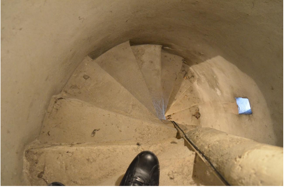
Resim-208. Minare gövde bölümü çekirdek kısmı ve basamaklarının üstten görünüşü. 03.04.2015.
