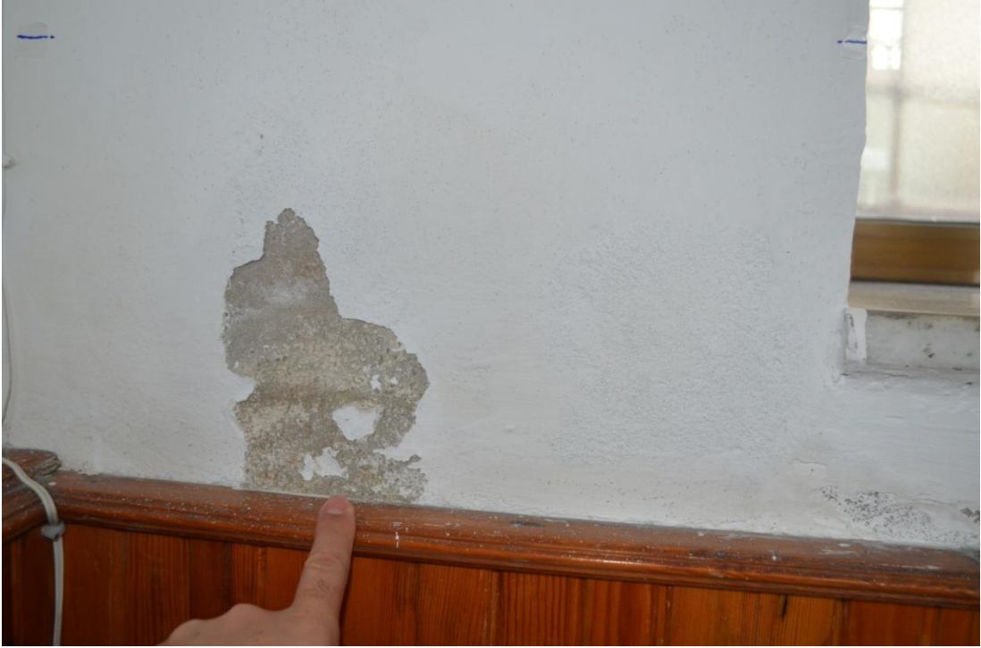
Resim-286. Harim Bölümü güneydoğu duvarı çimento esaslı iç sıvası, pamuklanma ve boya dökülmesi detay görünüşü. 03.04.2015
