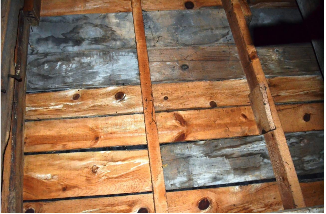
Resim-196. Harim Köşkü mutfak bölümü tavanının deliğinden çatı içi kiremit altı tahta kaplaması görünüşü. 03.04.2015.
