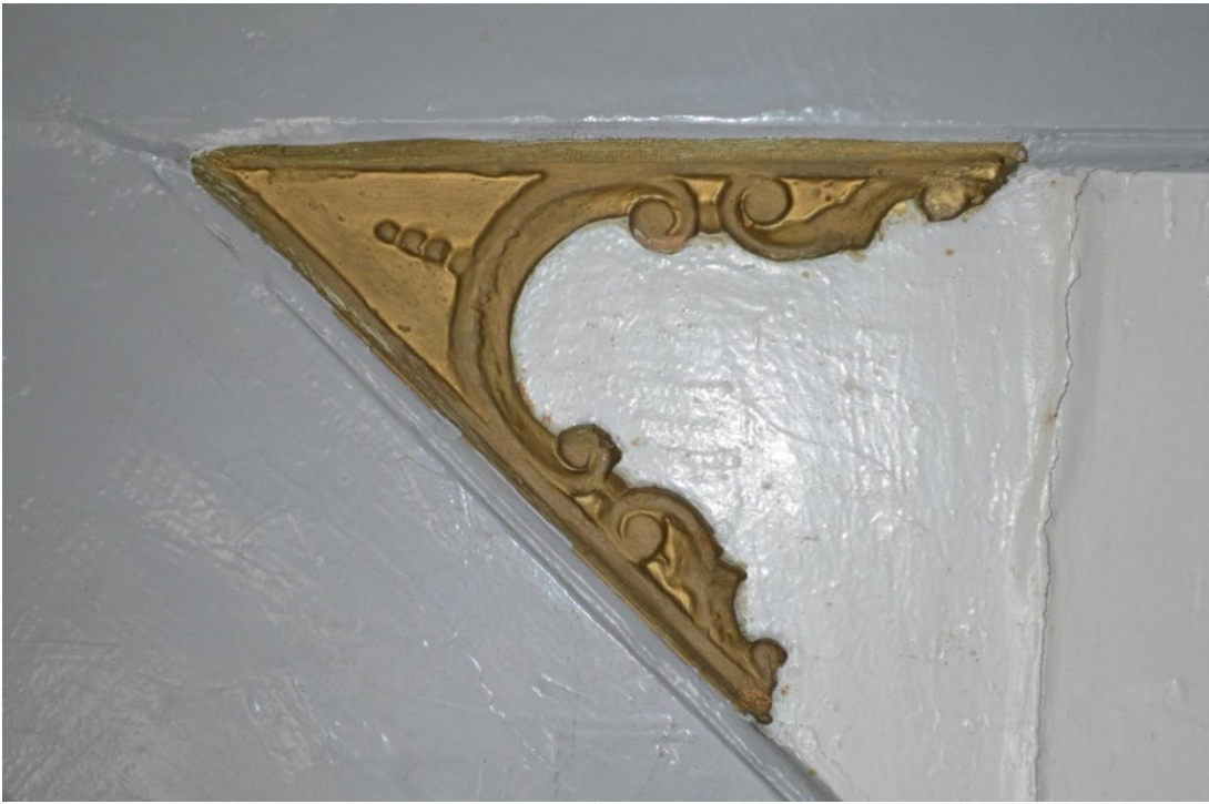
Resim-229. Harim kible duvarındaki minber korkuluk aynası köşe detayı ön görünüşü. 03.04.2015.
