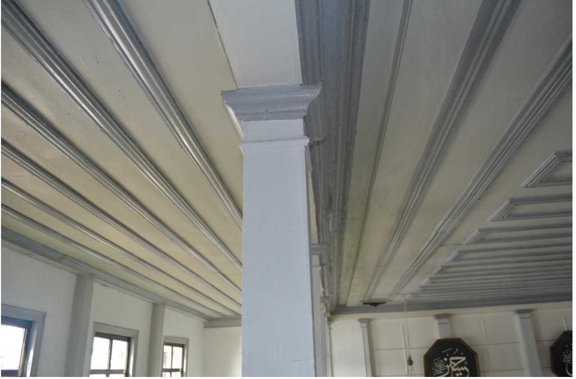
Resim-180. Kadınlar mahfili tavan kaplaması kuzeydoğuya doğru bakış.. 03.04.2015.
