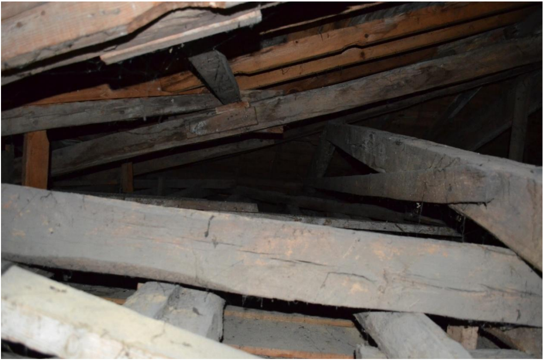
Resim-197. Harim Köşkü mutfak bölümü tavanının deliğinden çatı içi kuzey görünüşü. 03.04.2015.
