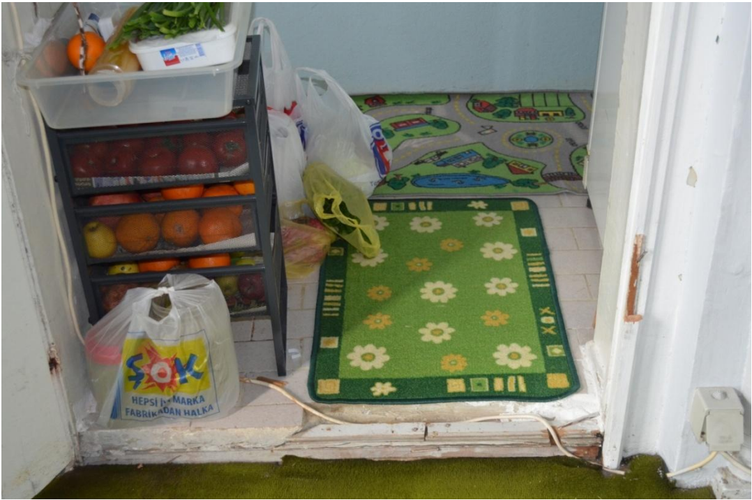
Resim-171. Hünkar köşkü mutfak döşeme ahşap kaplaması üzeri seramik kaplama. 03.04.2015.
