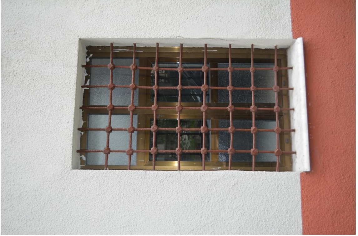
Resim-254. Harim güneydoğu duvarı üzerindeki alt sıra pencerenin bahçeden görünüşü. 03.04.2015.
