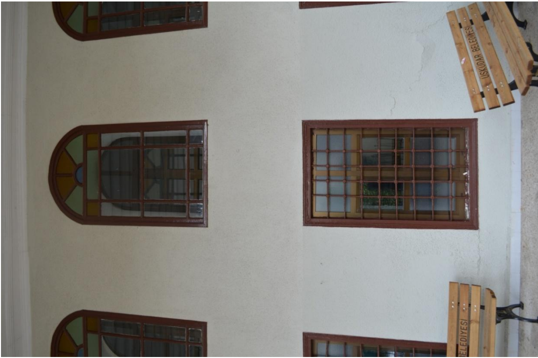
Resim-249. Harim güneybatı duvarı üzerindeki pencerelerin son cemaatten görünüşü. 03.04.2015.
