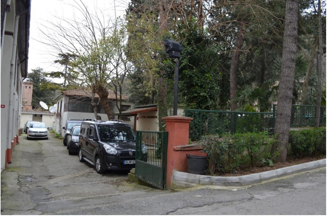
Resim-301. 27 parselin güneydoğu bahçe duvarı ve bahçe giriş kapısı.Solda cami, ortada şadırvan, arkada müstemilat yapısı ve tuvaletler. 03.04.2015
