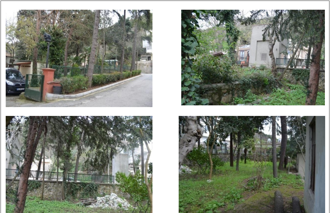
Şekil-12. Bahçe duvarlarına ait görüntüler.
