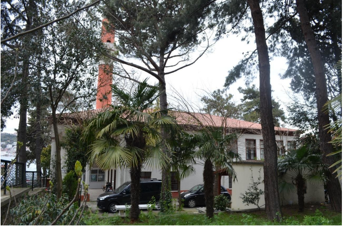
Resim-93. 27 parselin güney köşesinden, Cami güneydoğu cephesi görünüşü. 03.04.2015
