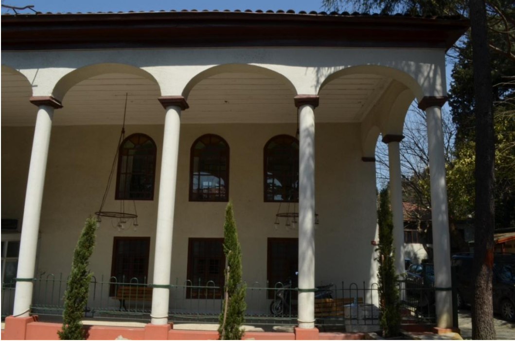
Resim-59. Vaniköy Cami Sokak üzerinden Son Cemaat kısmı güneybatı cephesi (giriş cephesi) görünüşü. 03.04.2015
