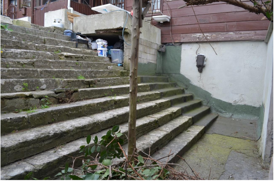
Resim-80. Hünkar Köşkü girişi önü taş merdiven basamakları kuzeydoğu görünüşü.
