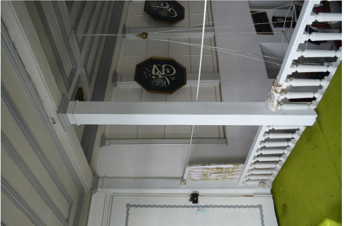
Resim-135. Kadınlar mahfilinden harim kuzeydoğu duvarı iç görünüşü. 03.04.2015.
