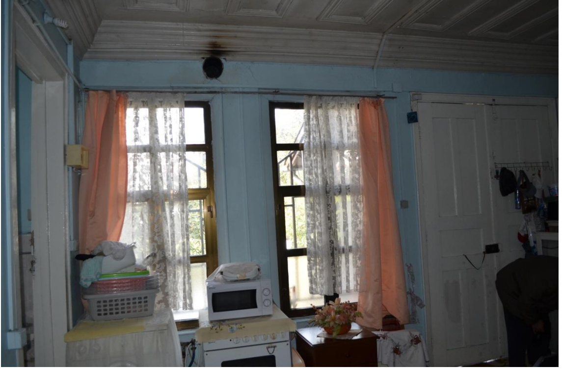
Resim-146. Hünkar köşkü Sofa bölümü kuzeydoğu duvarı iç görünüşü.Sofa giriş kapısı. 03.04.2015.
