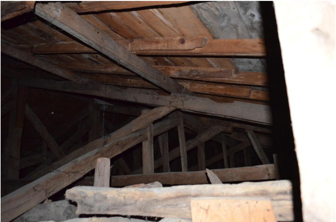
Resim-195. Harim Köşkü mutfak bölümü tavanının deliğinden çatı içi batı görünüşü. 03.04.2015.
