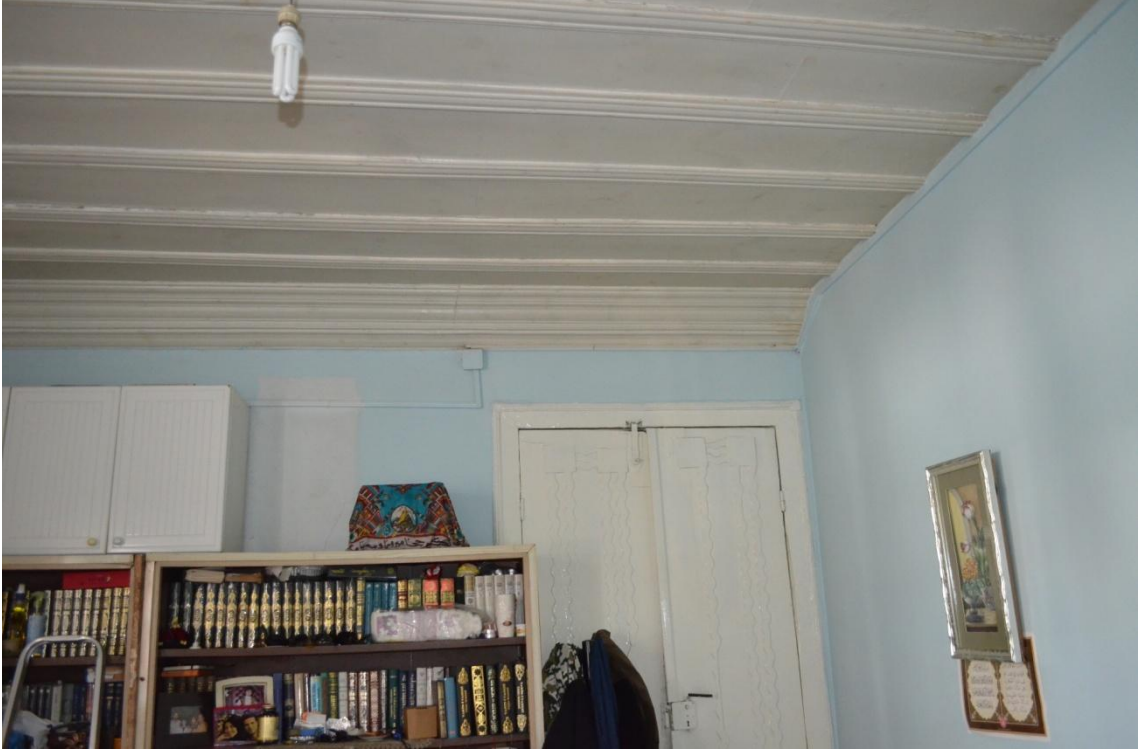
Resim-148. Hünkar köşkü Sofa bölümü güneydoğu duvarı iç görünüşü.Yatak Odası giriş holü kapısı. 03.04.2015.
