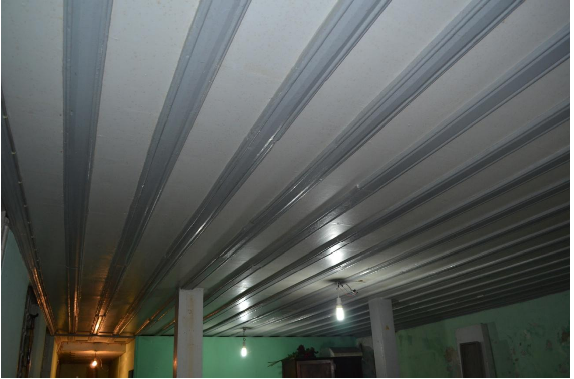
Resim-183. Hünkar Köşkü alt katı tavan kaplaması kuzeybatıya doğru bakış.. 03.04.2015.
