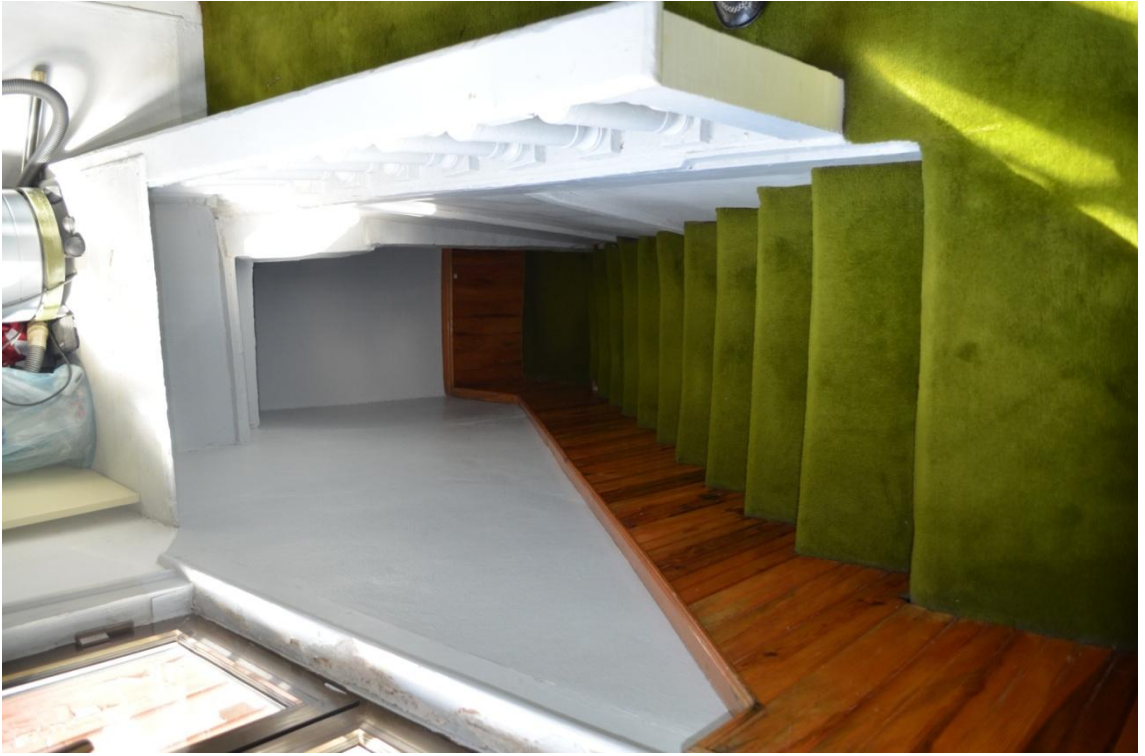
Resim-129. Kadınlar mahfili girişi merdiveni görünüşü. 03.04.2015.
