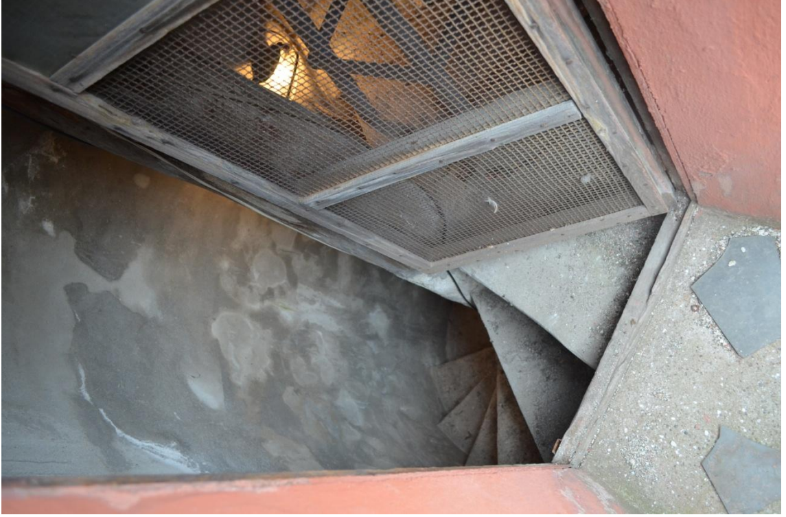
Resim-214. Minare şerefesine çıkış kapısı ve telli kapı kanadı. 03.04.2015.
