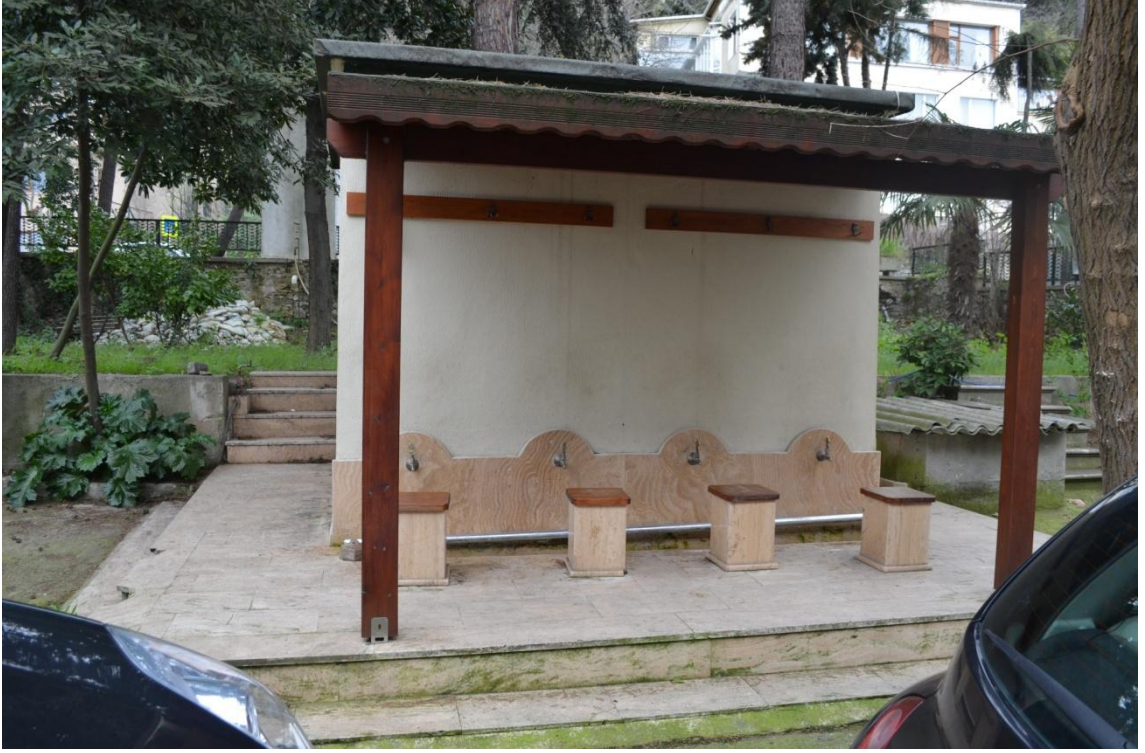
Resim-305. Bahçedeki şadırvanın güneydoğu görünüşü. 03.04.2015
