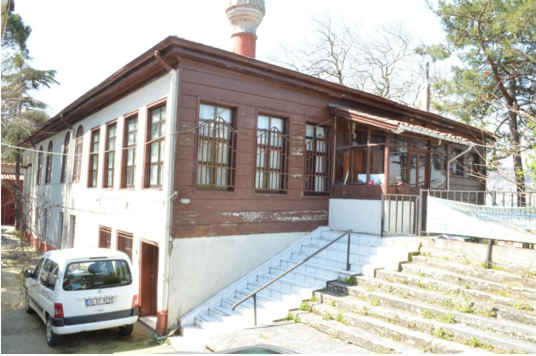
Resim-72. Bahçe duvarı üzerinden, Cami doğu görünüşü. Cami kuzeydoğu ile güneydoğu cepheleri , Hünkar Köşkü ve girişi, Hünkar Köşkü kuzeydoğu girişi ve önü taş merdivenler. 03.04.2015
