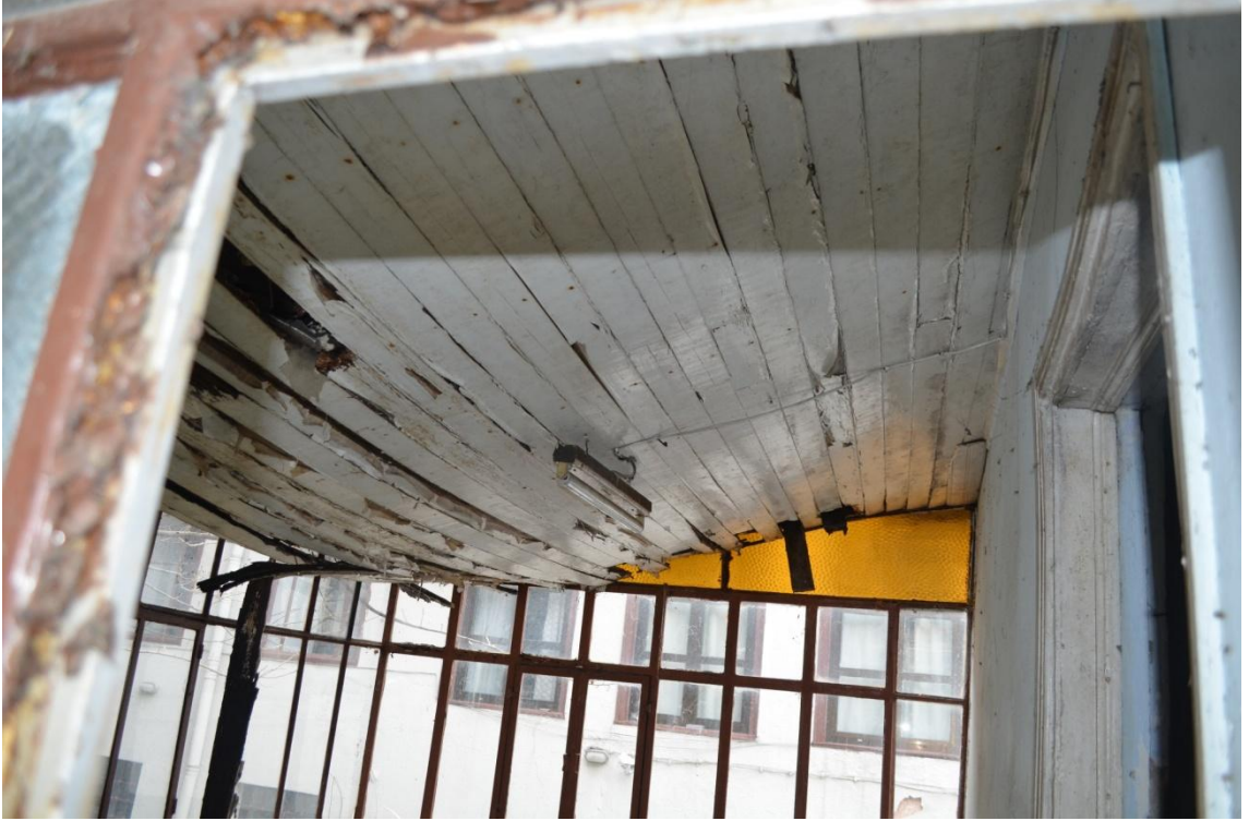
Resim-312. Bahçedeki müştemilat yapısının tavan kaplaması görünüşü. 03.04.2015
