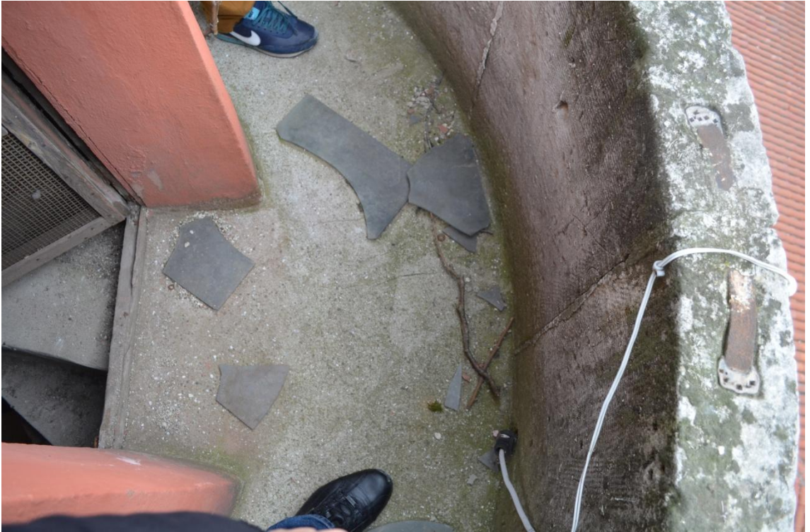
Resim-215. Minare şerefesi, çimento esaslı şap zemin kaplaması. 03.04.2015.
