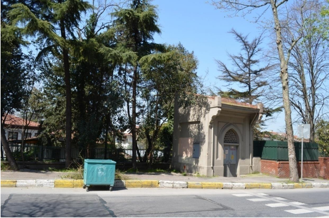
Resim-53. 27 parselin Vaniköy Caddesi üzerindeki güney cephesi ile ek trafo binası ve yanı 25 parsel avlu duvarı, 03.04.2015.
