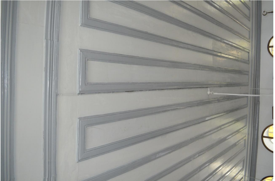
Resim-177. Harim tavan kaplaması güneydoğuya doğru bakış.. 03.04.2015.
