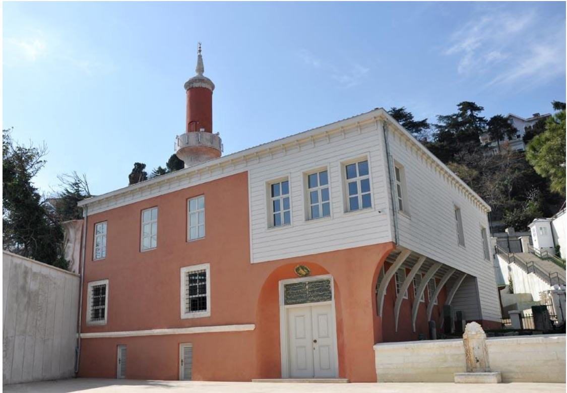
Defterdar İbrahim Paşa Cami'nin denize bakan cephesi fotoğrafı ( www.keremaydinlarvakfi.org ).
