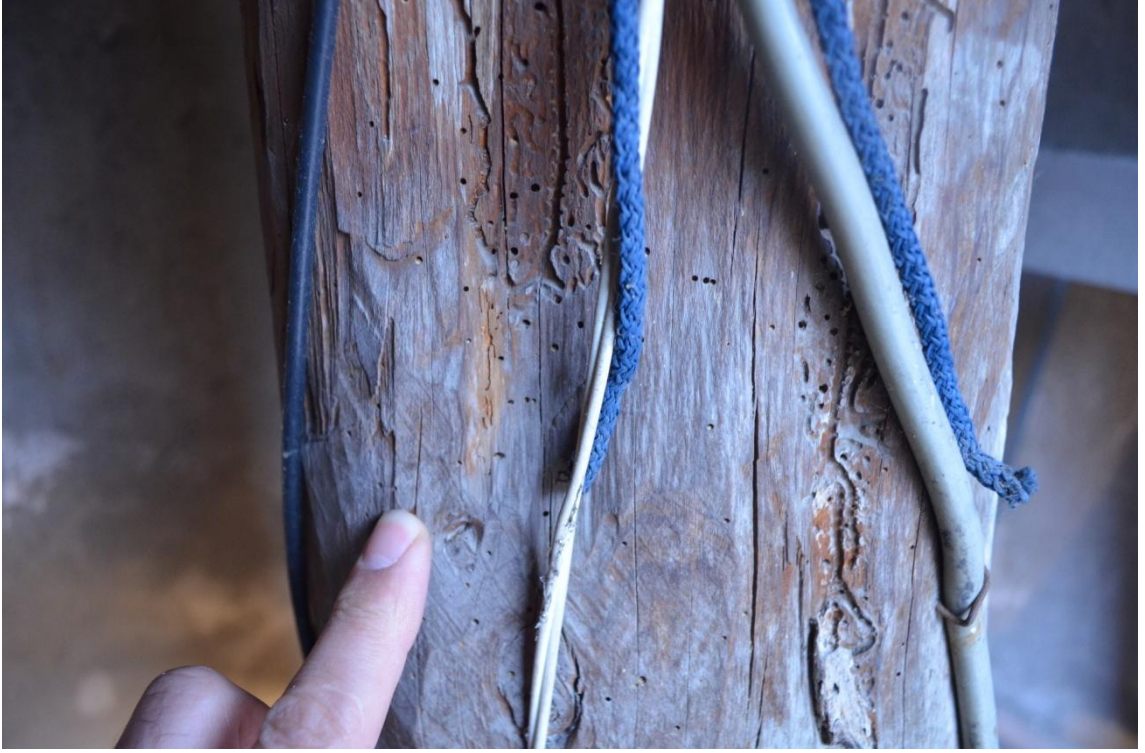
Resim-212. Minare sereni yüzeyindeki böcek ve kurt delikleri. 03.04.2015.
