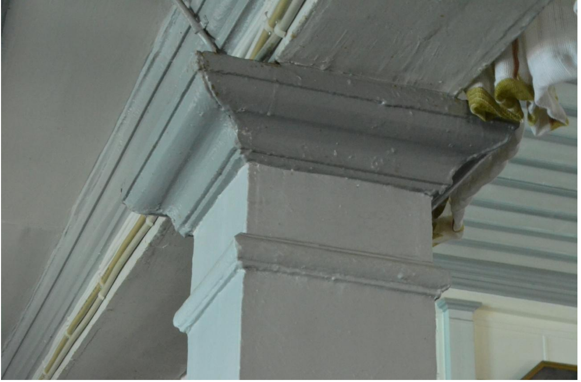
Resim-264. Mahfili taşıyan ayakların ahşap başlık detay görünüşü. 03.04.2015.
