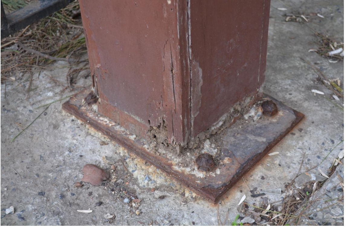
Resim-293. Hünkar Köşkü çıkmasını taşıyan metal putrel ayak, üzeri ahşap kaplama ve beton kaide detayı. 03.04.2015
