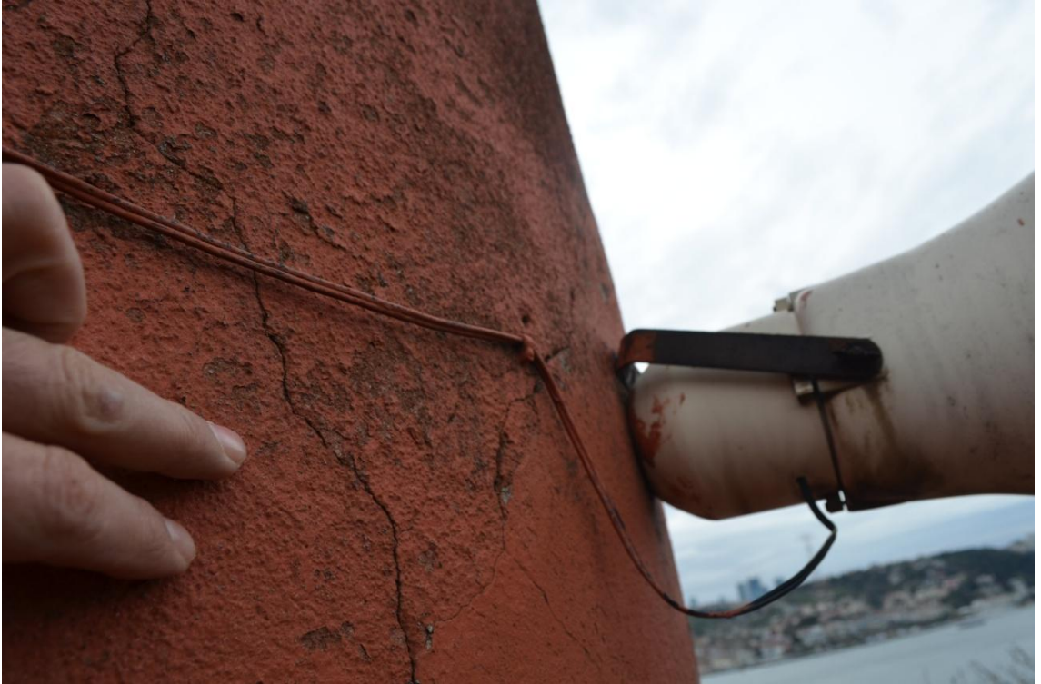
Resim-219. Minare petek kısmı çimento esaslı sıva kaplaması ve hoparlör detayı. 03.04.2015.
