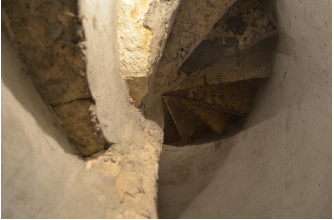
Resim-206. Minare kaide bölümü çekirdek kısmı ve basamaklarının alttan görünüşü. 03.04.2015.
