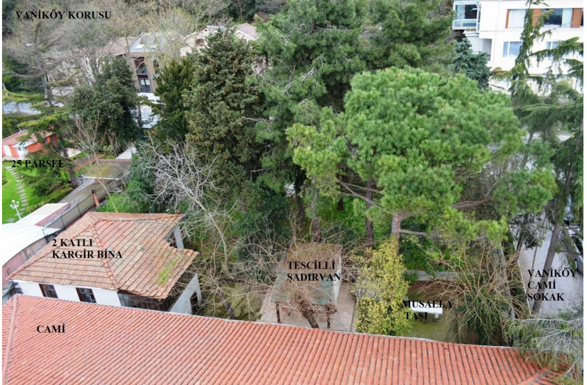
Resim-298. 27 parsel üzerindeki müstemilat yapıları ve bahçeye şerefeden bakış. 03.04.2015
