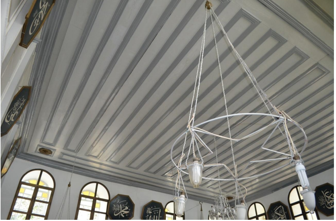
Resim-176. Harim tavan kaplaması güneydoğu-güneye doğru bakış.. 03.04.2015.
