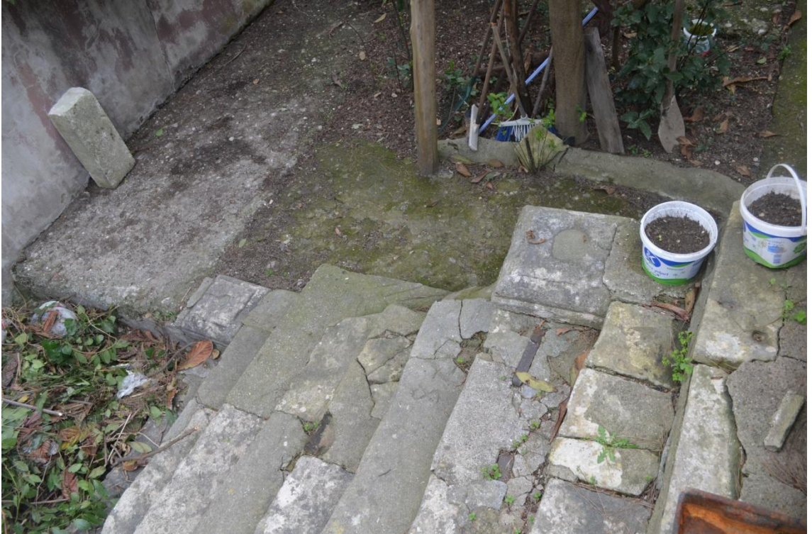
Resim-85. Hünkar Köşkü önü taş merdivenler sahil tarafı. Merdiven korkuluklarının bastığı taş kaide ve metal kenetler görülmekte... 03.04.2015
