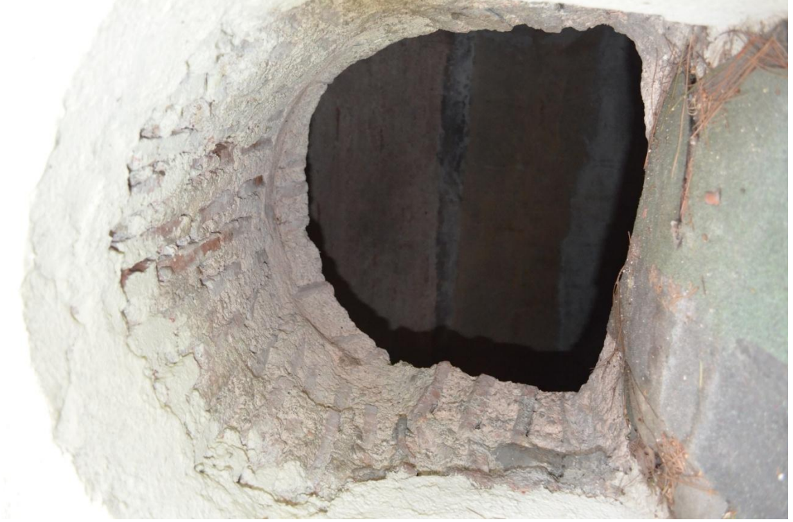
Resim-289. Bahçedeki Şadırvan'ın güneydoğu duvarında yer alan kemerli pencere boşluğu, çimento esaslı dış sıva ve tuğla kemer detay görünüşü. 03.04.2015
