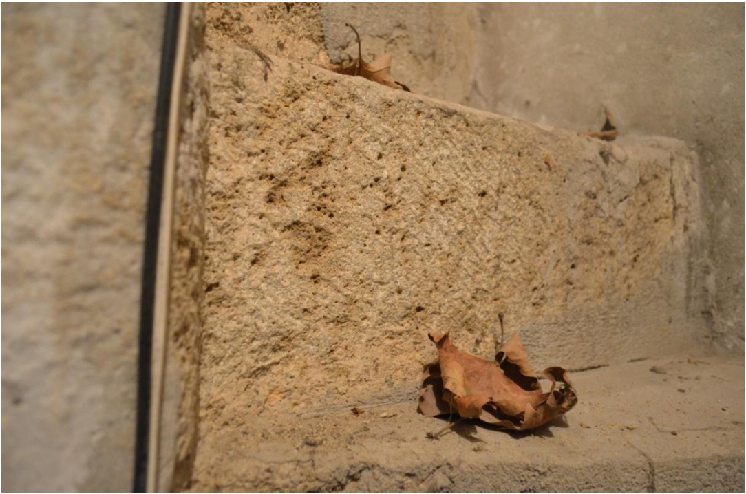
Resim-207. Minare kaide bölümü çekirdek kısmı ve basamaklarının önden görünüşü. 03.04.2015.
