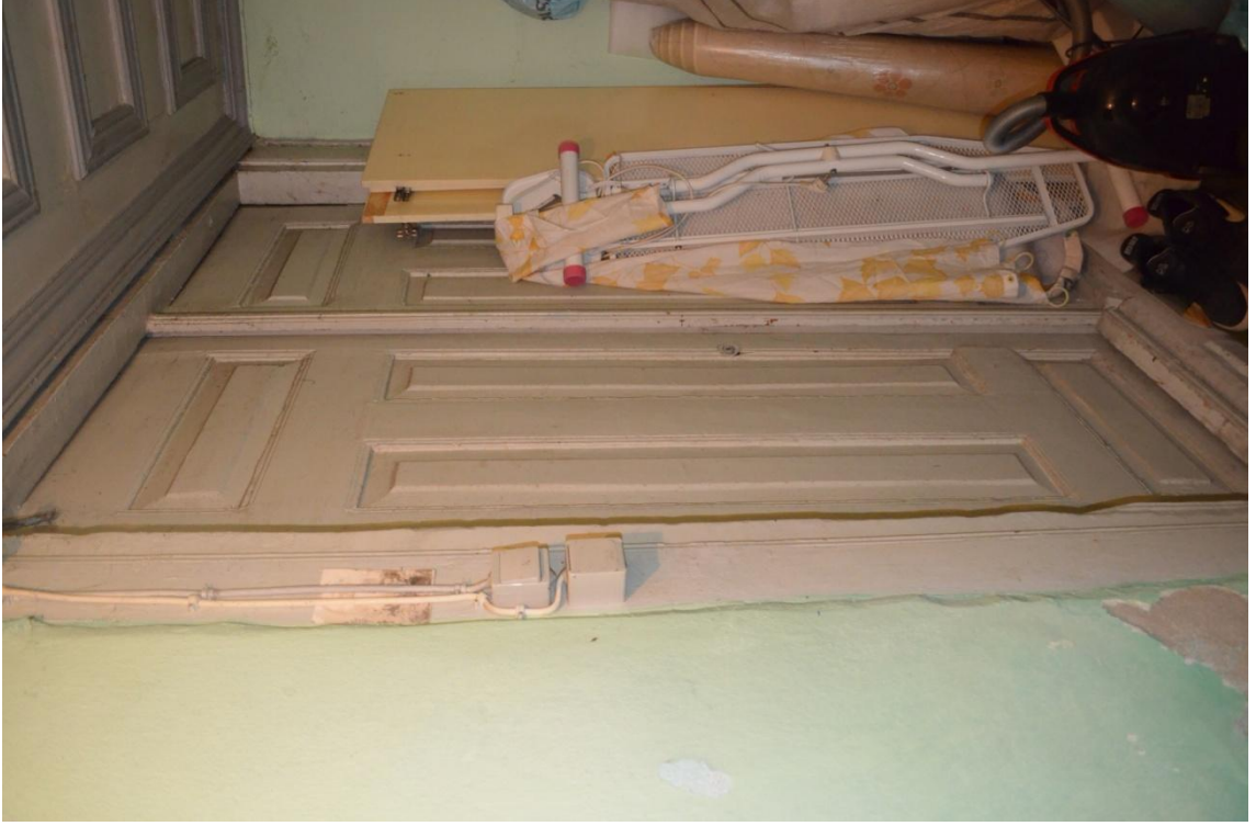
Resim-244. Hünkar köşkü alt kat depo bölümü giriş kapısının içerden görünüşü. 03.04.2015.
