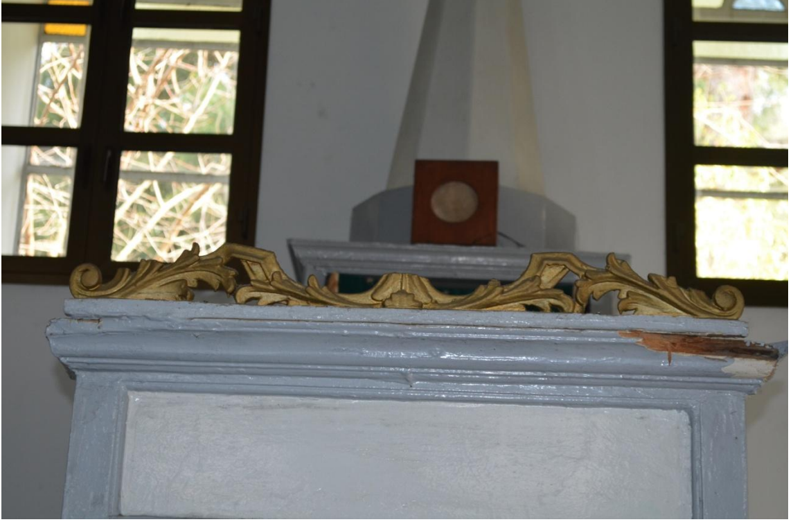
Resim-226. Harim kible duvarındaki minber kapısı alınlık ön görünüşü. 03.04.2015.
