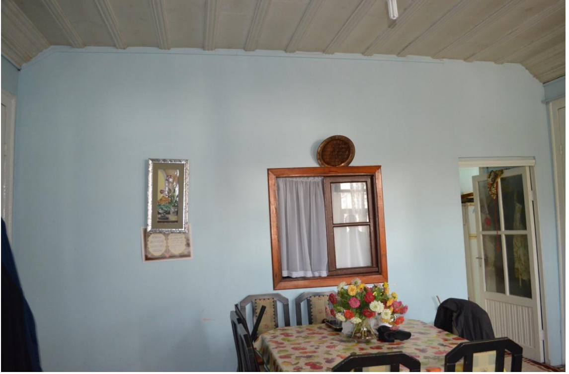
Resim-144. Hünkar köşkü Sofa bölümü güneybatı duvarı iç görünüşü. 03.04.2015.
