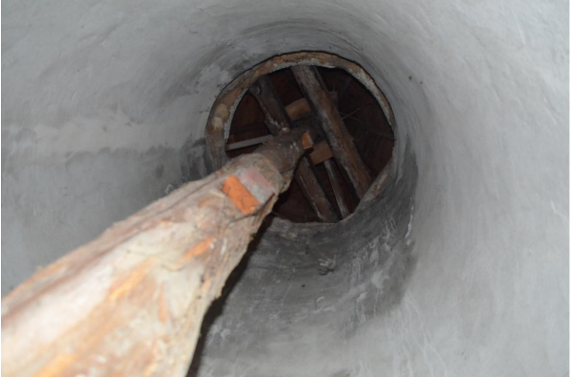
Resim-213. Minare sereni ve petek kısmı iç yüzeyi ile külah kısmı ahşap konstrüksiyonu iç görünüşü. 03.04.2015.
