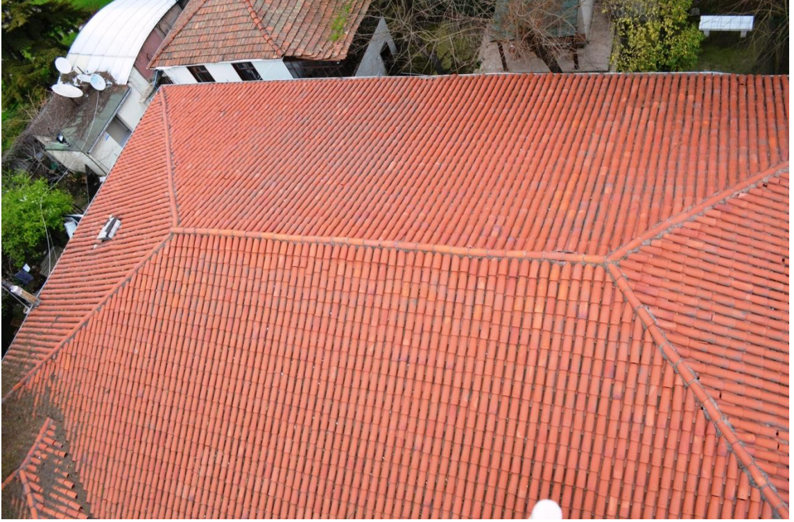
Resim-192. Minare şerefesinden Cami çatısının güneye doğru üstten görünüş. 03.04.2015.
