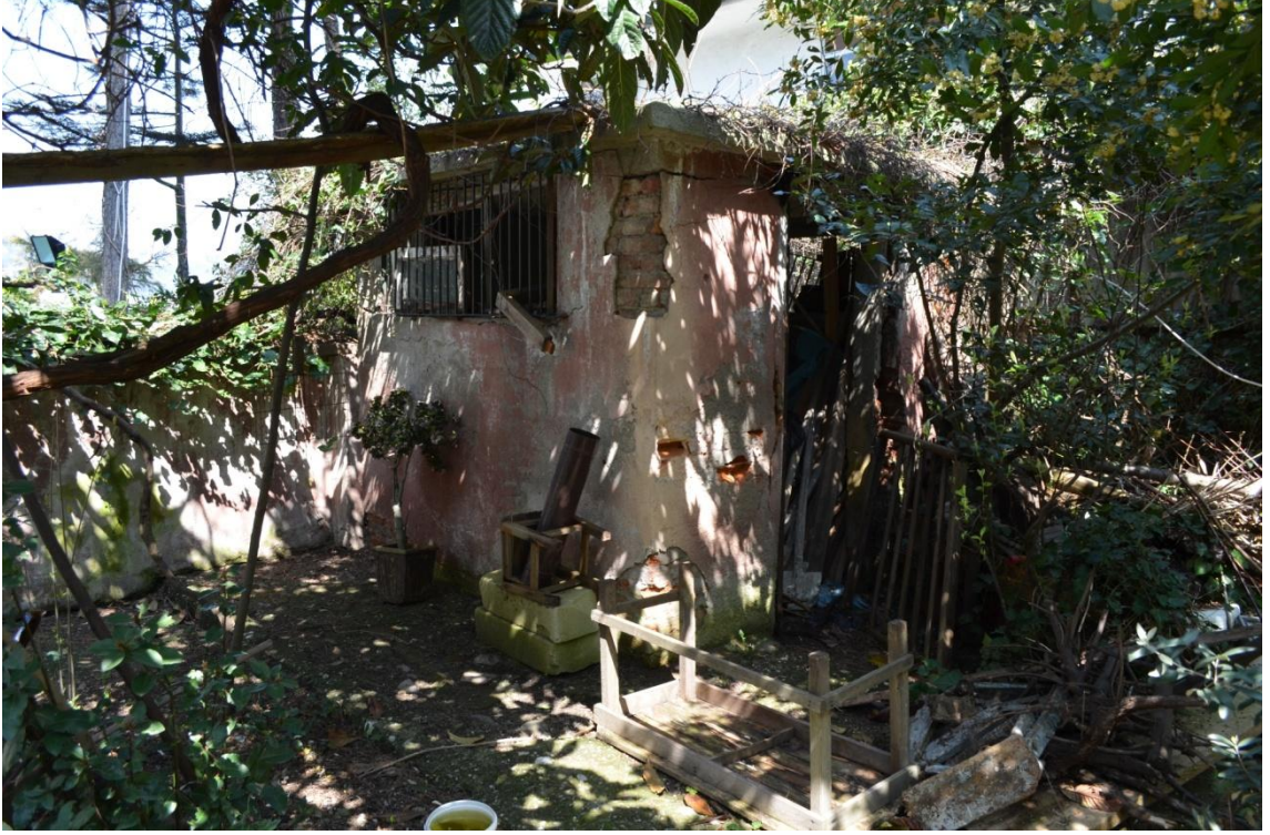
Resim-88. 27 parselin kuzeydođu köşesine Kandilli Rasathanesi Müdürlüğünce 1969 senesinde inşa ettirilen tuđla kargir yapı. 03.04.2015
