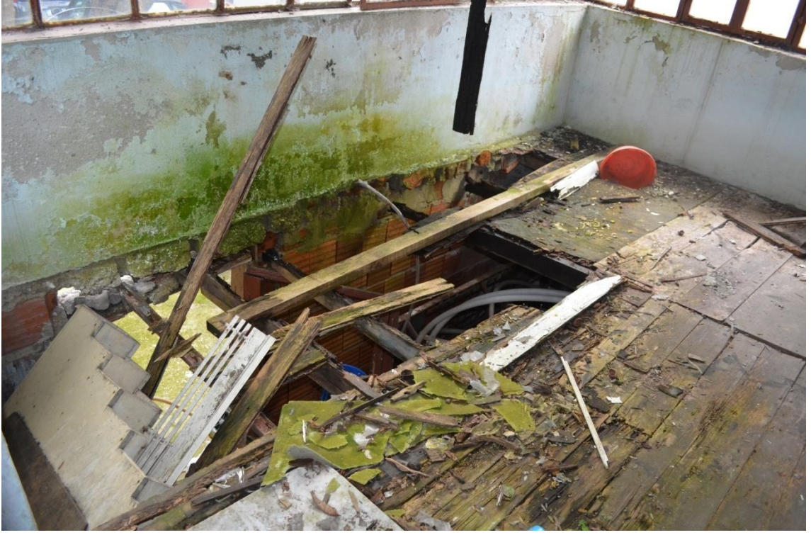
Resim-311. Bahçedeki müştemilat yapısının 1. kat döşemesi görünüşü. 03.04.2015
