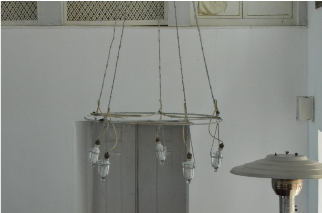
Resim-275. Harim tavanın köşelerinden sarkan üç adet aydınlatma avizesi detay görünüşü. 03.04.2015
