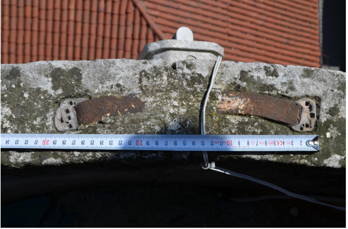
Resim-291. Minare şerefesi taş korkuluk ve demir kenet detayı. 03.04.2015
