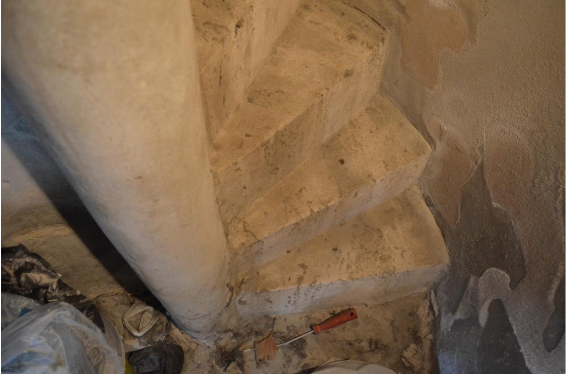
Resim-205. Minare kaide bölümü çekirdek kısmının giriş kapısından iç görünüşü. 03.04.2015.
