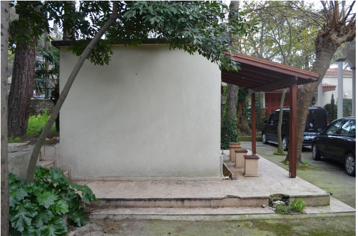
Resim-306. Bahçedeki şadırvanın kuzeydoğu görünüşü. 03.04.2015
