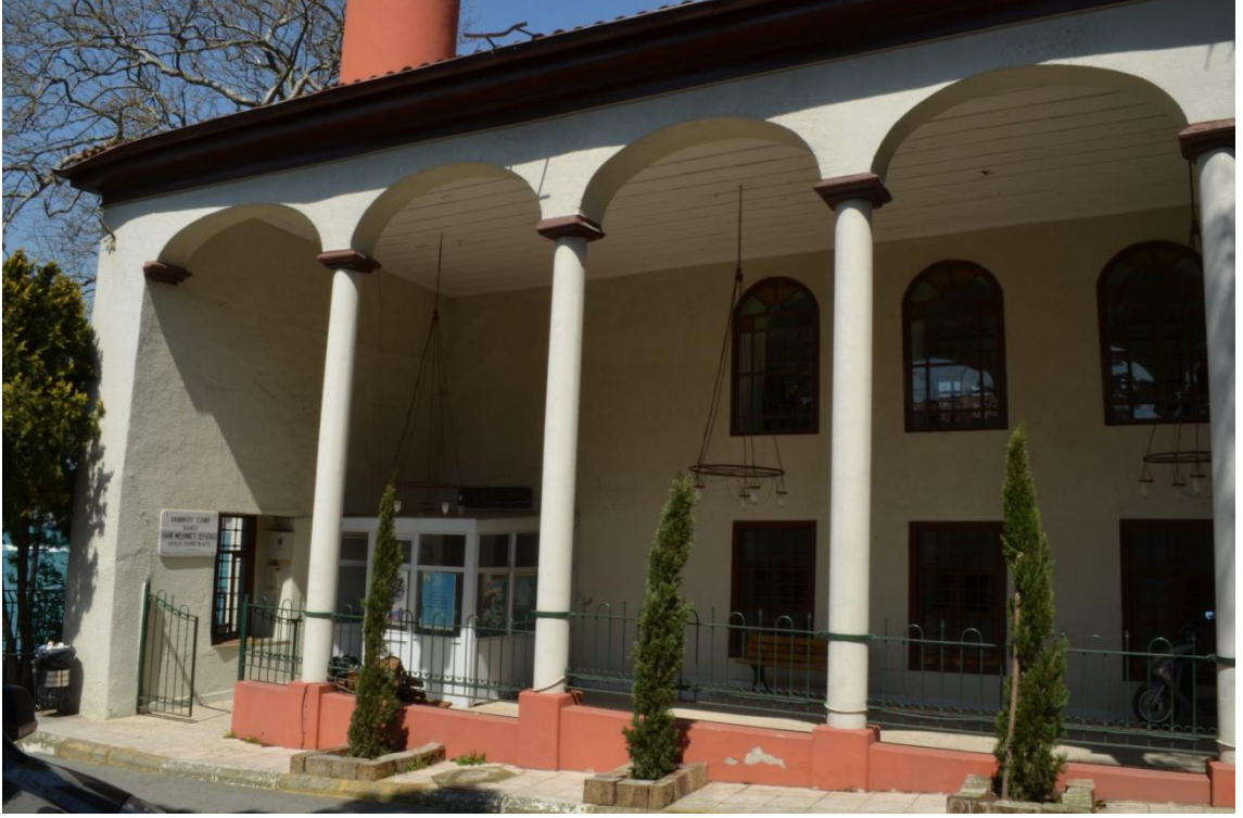
Resim-58. Vaniköy Cami Sokak üzerinden Son Cemaat kısmı güneybatı cephesi (giriş cephesi) görünüşü. 03.04.2015
