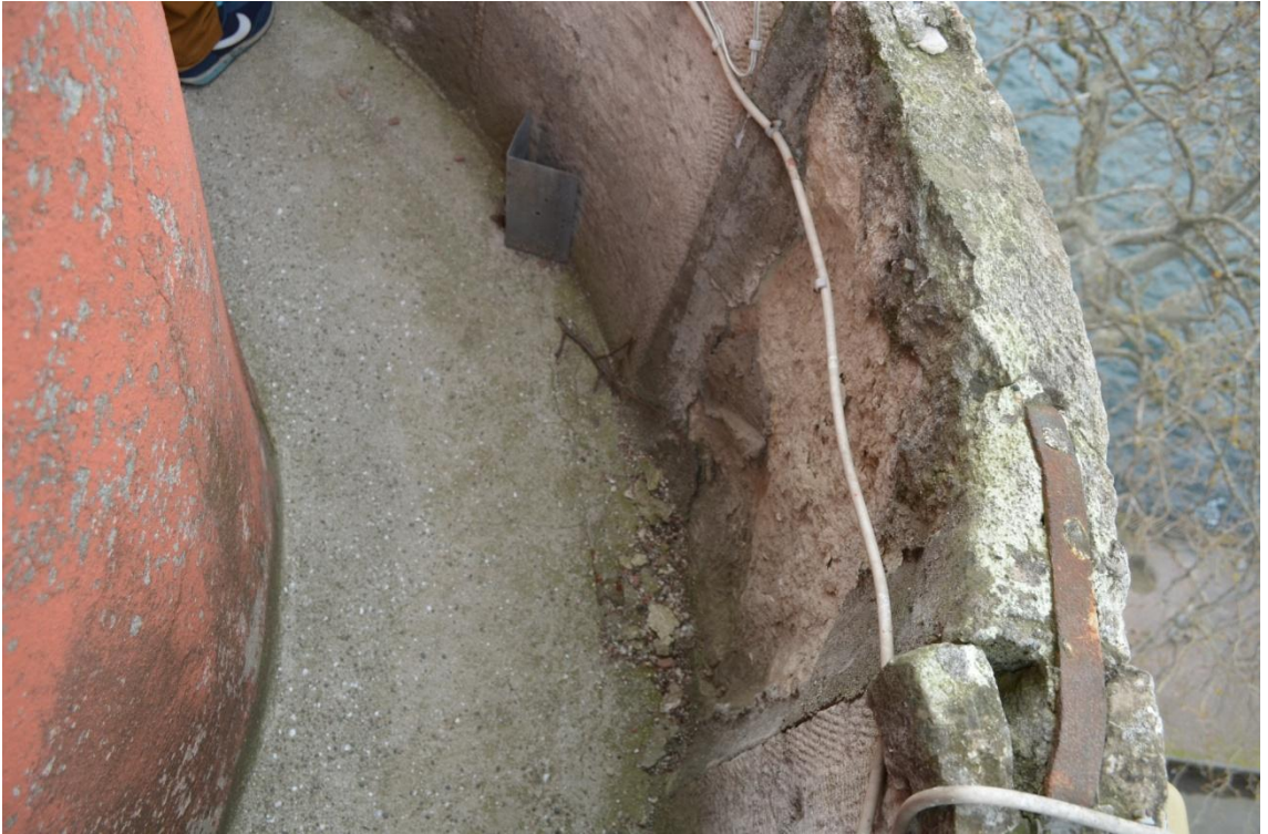
Resim-217. Minare şerefesi, zemin kaplaması, petek gövdesi, korkuluk. 03.04.2015.
