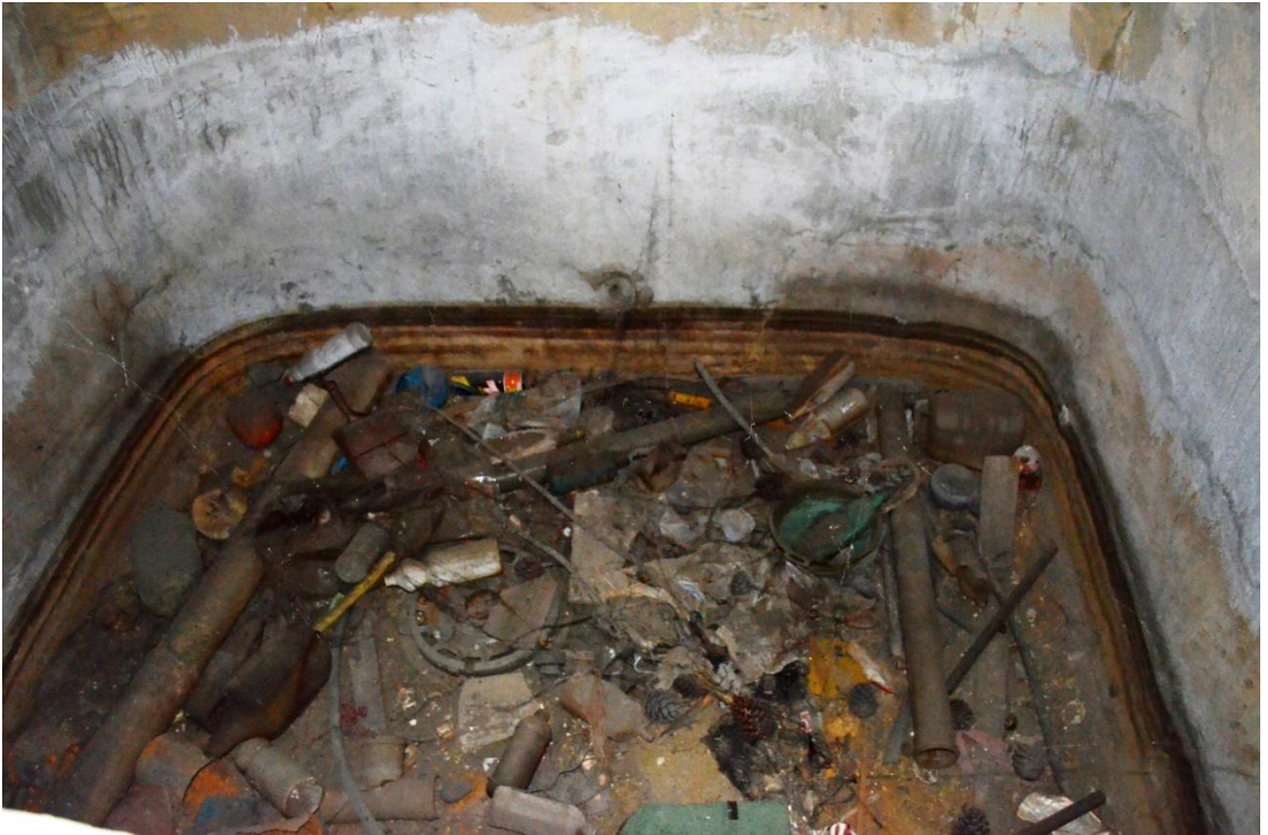
Resim-308. Bahçedeki şadırvanın su haznesi iç görünüşü. 03.04.2015
