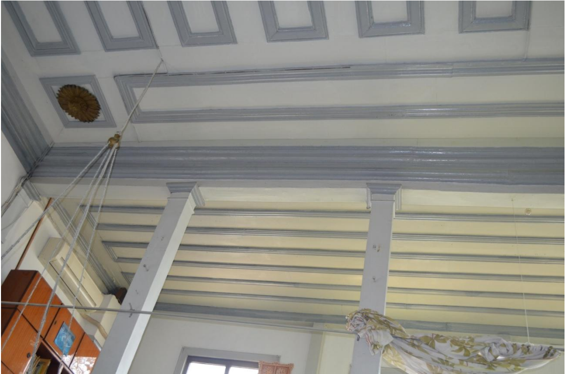
Resim-181. Kadınlar mahfili tavan kaplaması kuzeybatıya doğru bakış.. 03.04.2015.
