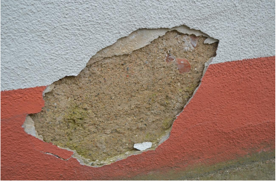
Resim-285. Harim Bölümü güneydoğu duvarı çimento esaslı dış sıvası, kireç-çimento katkılı iç sıva detay görünüşü. 03.04.2015
