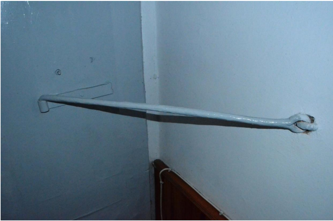
Resim-261. Harim giriş kapısı kanatları üzerindeki sabitleme çubuğu detay görünüşü. 03.04.2015.
