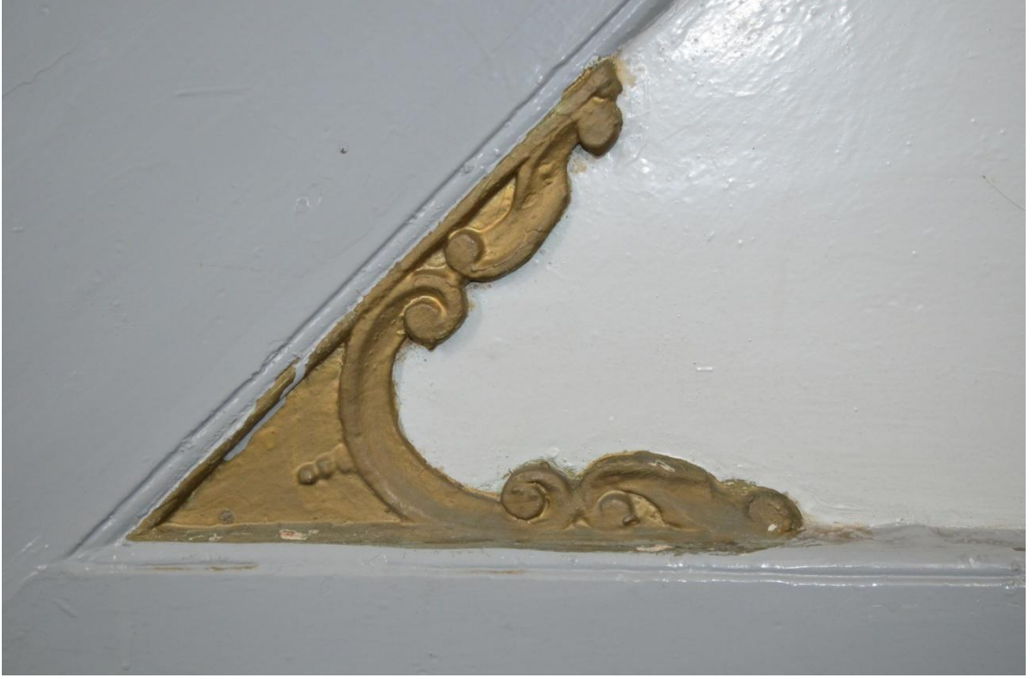
Resim-232. Harim kible duvarındaki minber korkuluk aynası köşe detayı ön görünüşü. 03.04.2015.
