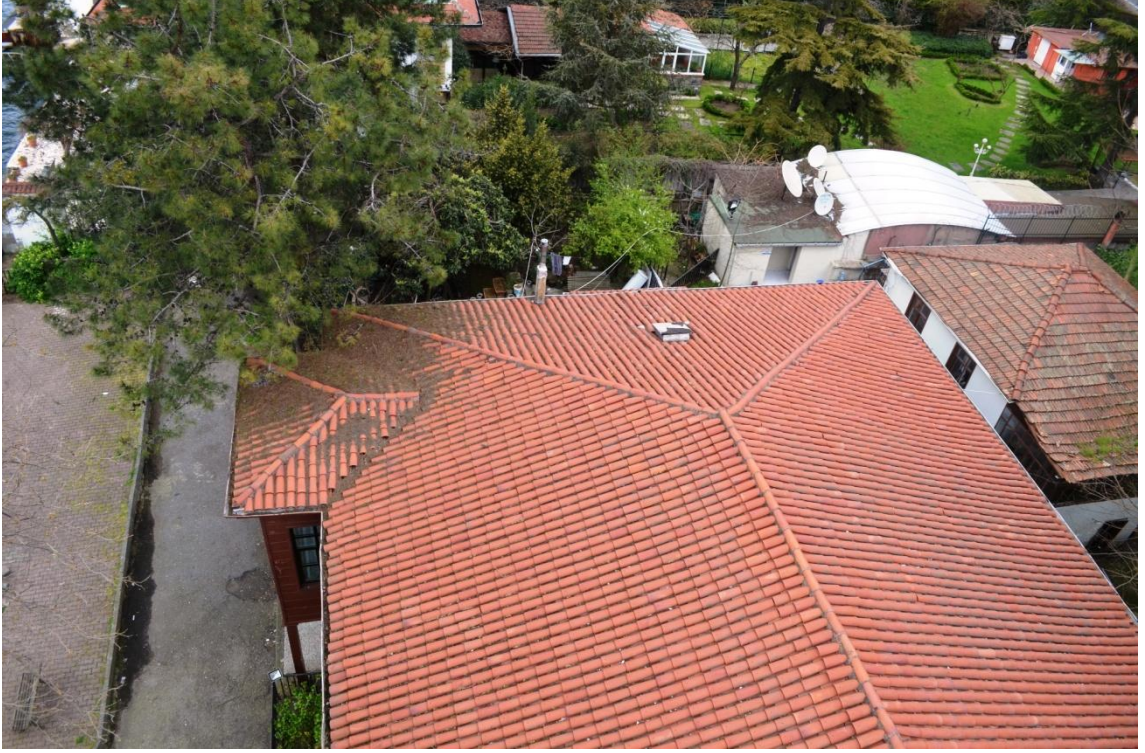
Resim-190. Minare şerefesinden Cami çatısının kuzeybatıya doğru üstten görünüş. 03.04.2015.
