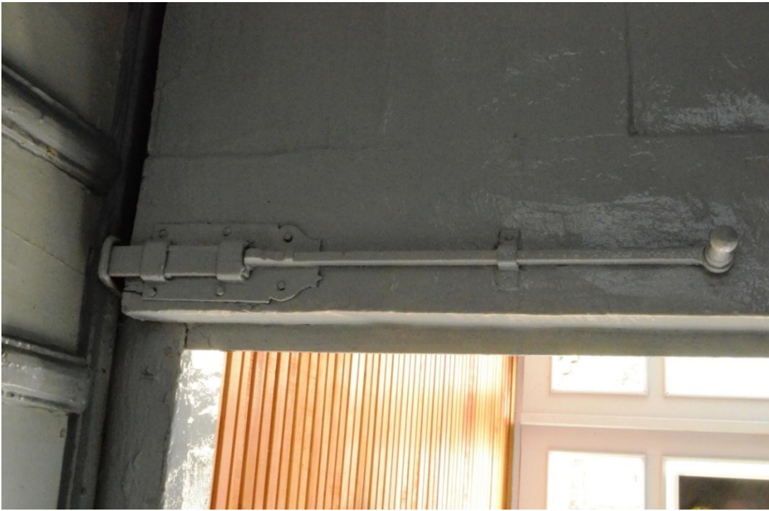
Resim-259. Harim giriş kapısı kanatları üzerindeki üst kilit sistemi detay görünüşü. 03.04.2015.
