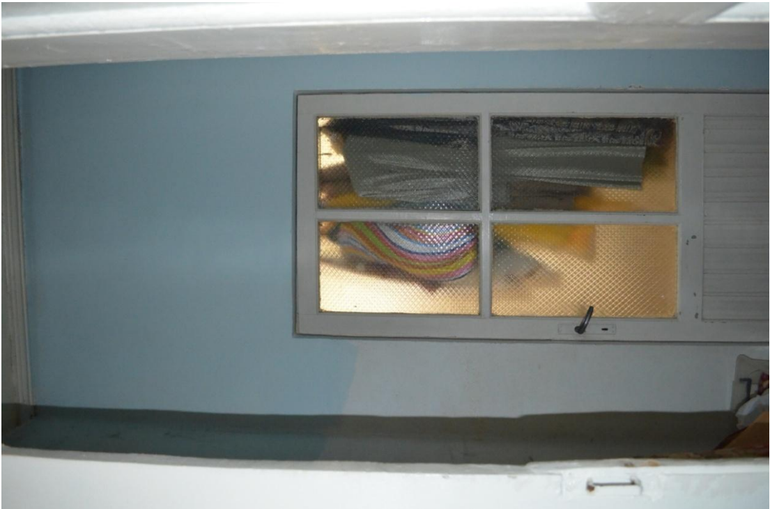
Resim-155. Hünkar köşkü Sofadan yatak odasına geçiş holü güneydoğu duvarı iç görünüşü. 03.04.2015.
