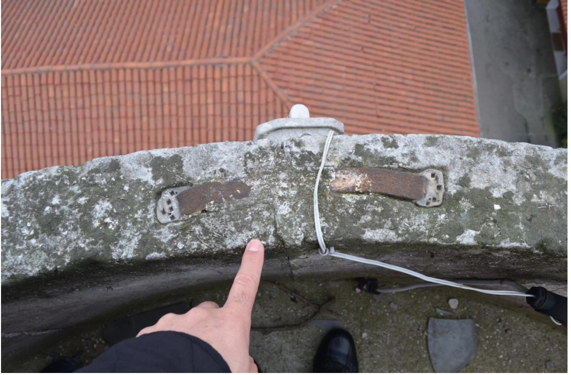
Resim-218. Minare şerefe korkulukları ve kenet detayı. 03.04.2015.
