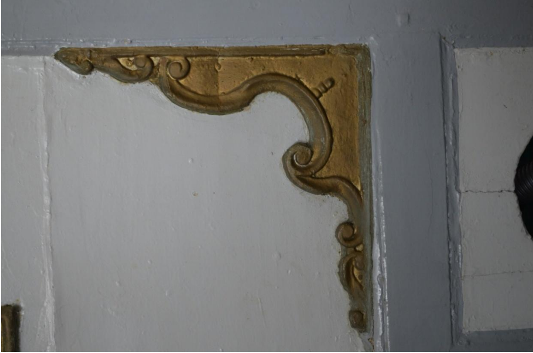
Resim-231. Harim kible duvarındaki minber korkuluk aynası köşe detayı ön görünüşü. 03.04.2015.
