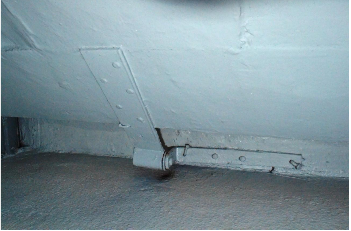
Resim-260. Harim giriş kapısı kanatları üzerindeki menteşe detay görünüşü. 03.04.2015.
