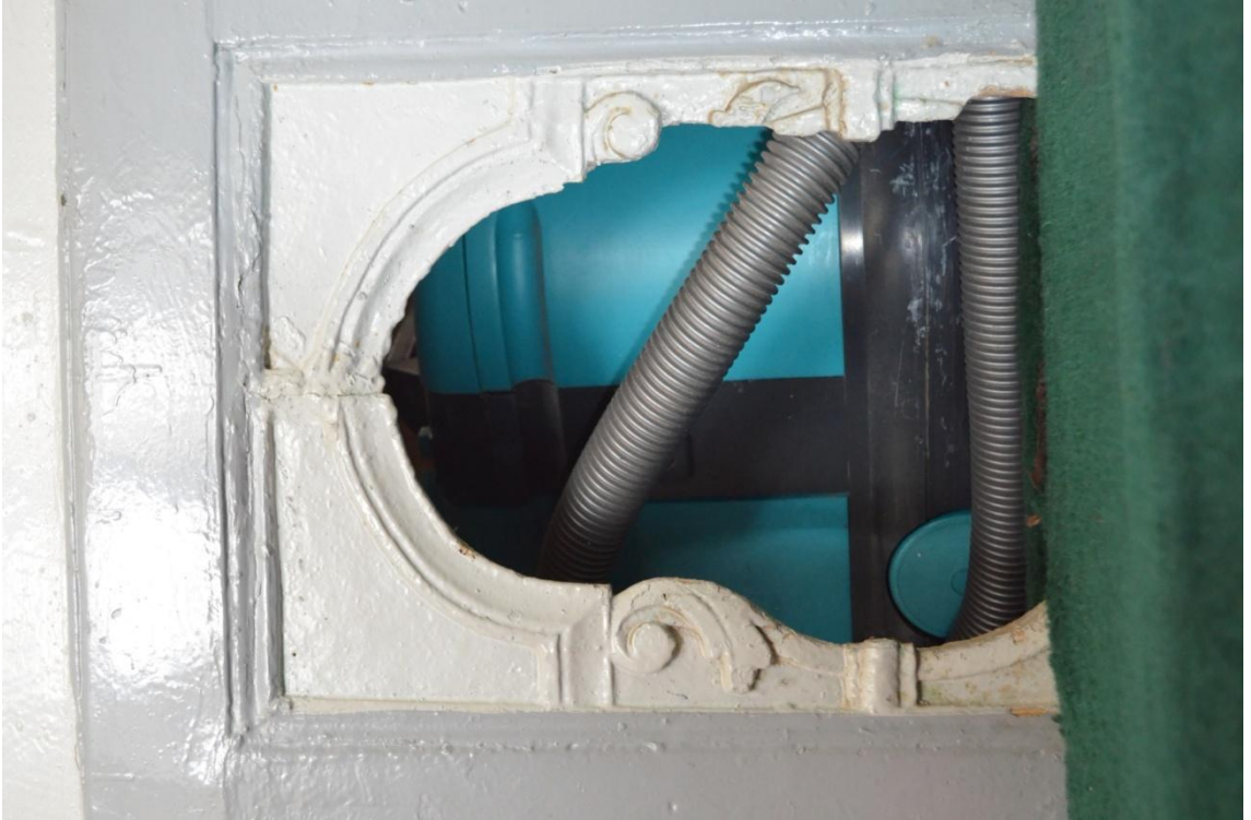
Resim-233. Harim kible duvarındaki minber pervaz kısmı ön görünüşü. 03.04.2015.
