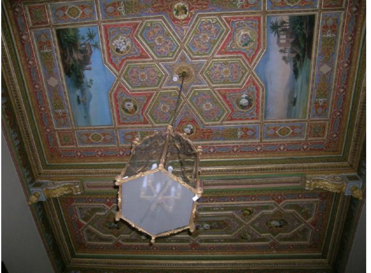
Şekil 14: Sarı Köşk merdiven sahanlığı tavan fotoğrafı
