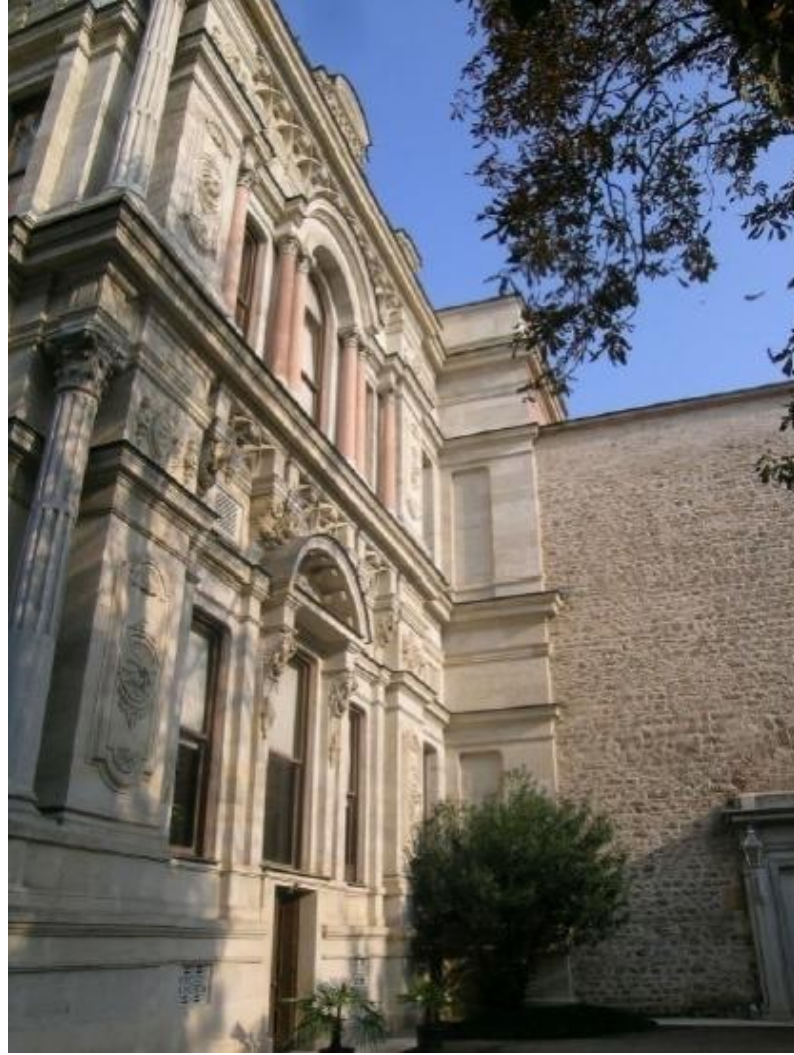
Şekil 8: Beylerbeyi Sarayı, Doğu Cephe Mabeyn Kısmı
