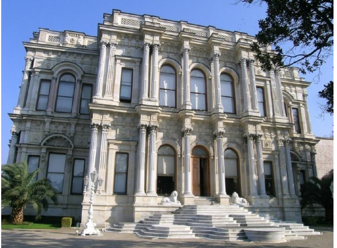
Şekil 6: Beylerbeyi Sarayı Güney cephe
