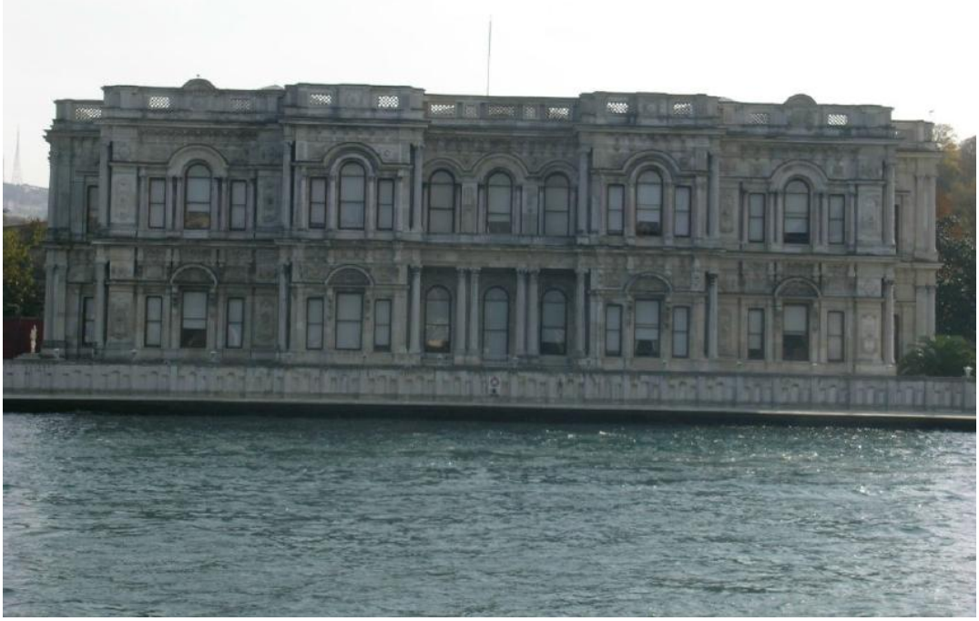
Şekil 9: Beylerbeyi Sarayı Batı Cepheden görünüş
