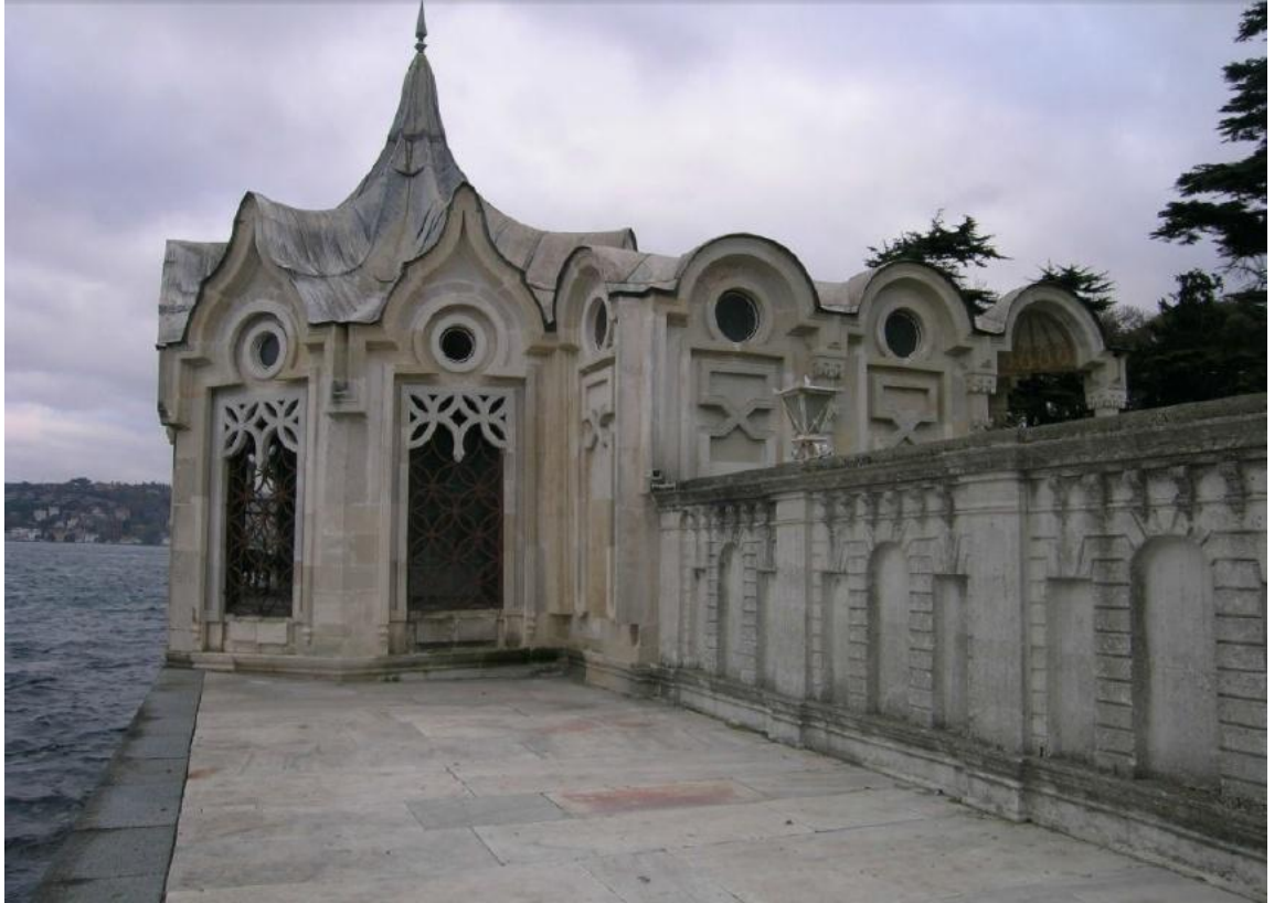
Şekil 27: Deniz Köşk güney cepheden görünüm
