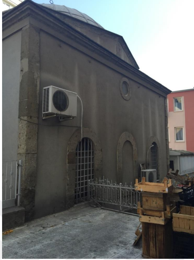
Ek. D. 25: Güney cephe genel görünüm
