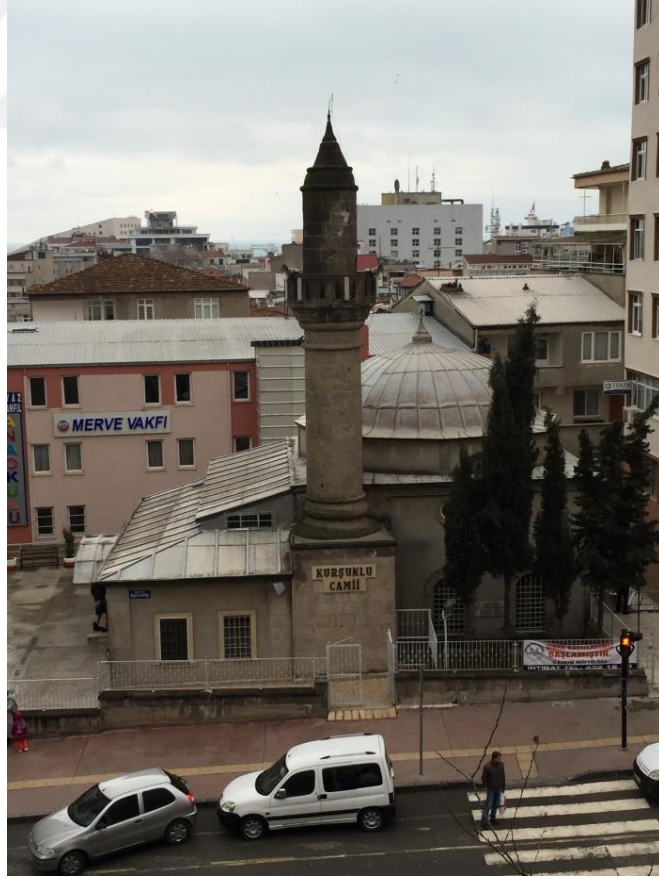
Ek. D. 6: Kurşunlu Camii Batı Cephesi
