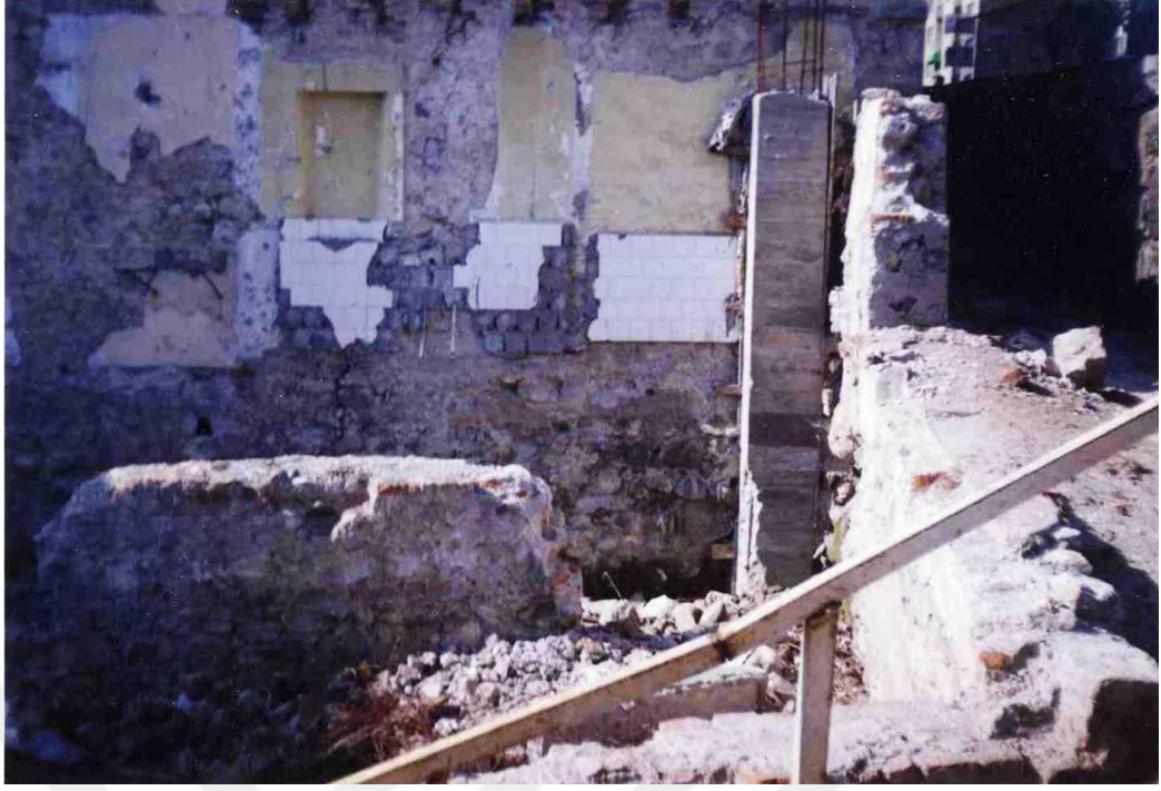
Ek. C. 42: Bitişik Yapı Yıkımı (Vakıflar Genel Müdürlüğü Arşivi)
