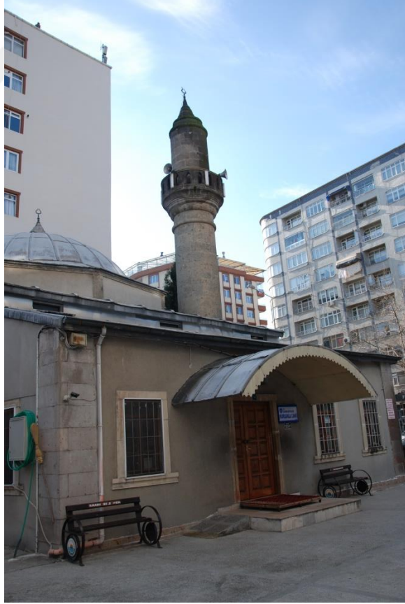
Ek. D. 22: Son cemaat mahalli kuzey duvarı
