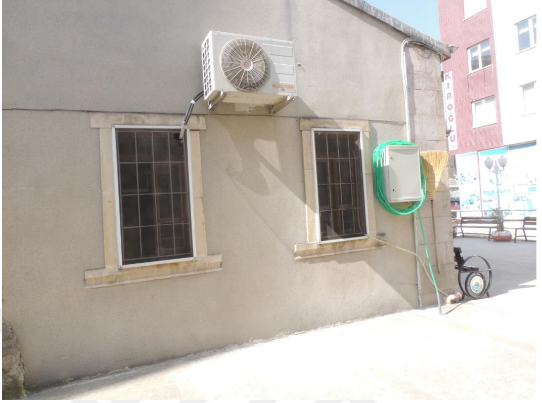
Ek. D. 15: Son cemaat mahallinin dođu duvarındaki pencereleri
