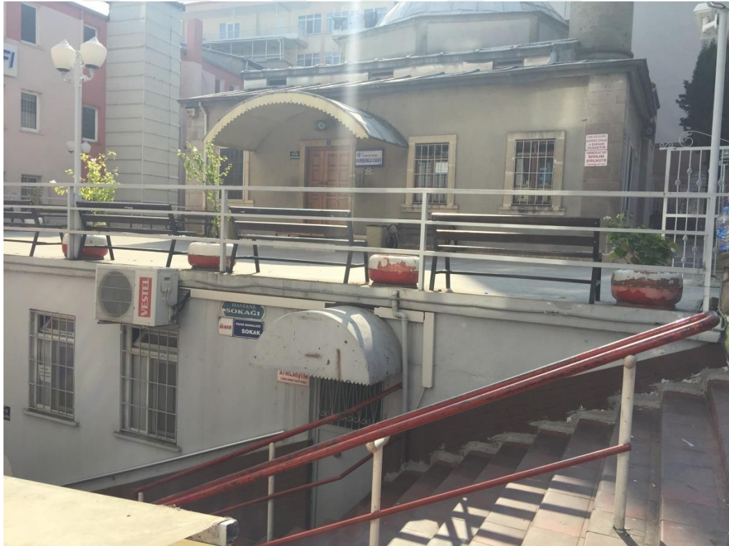
Ek. D. 18: Kuzey cephe genel görünüm
