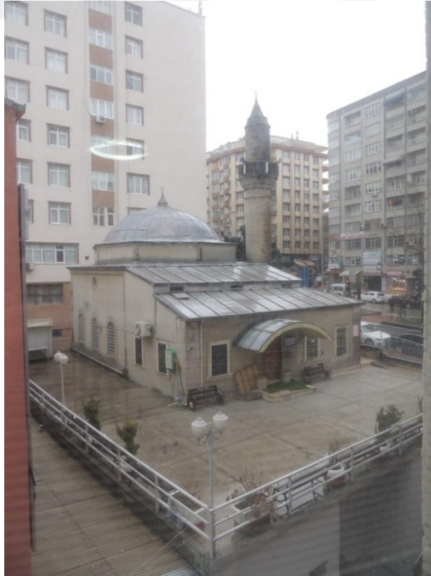
Ek. D. 20: Kuzey cephe genel görünüm
