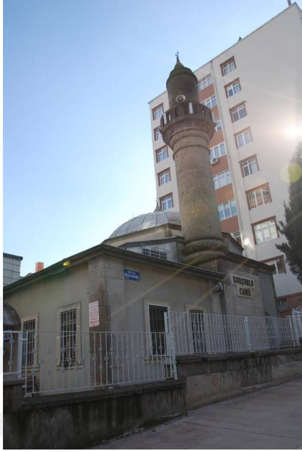
Ek. D. 7: Kurşunlu Camii Batı Cephesi
