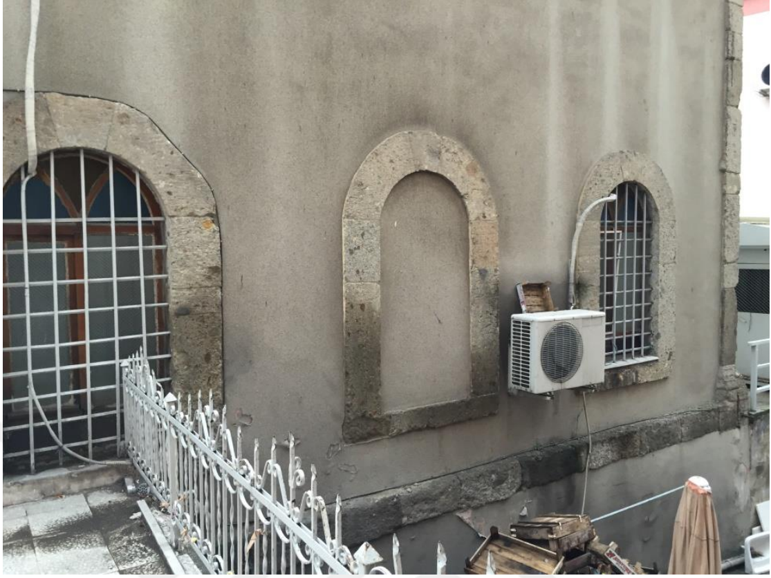
Ek. D. 27: Harimin güney duvarının pencereleri
