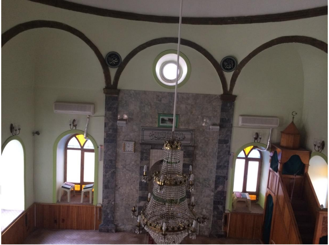
Ek D. 51: H04 Harim güney duvarı mihrap ve pencereleri
