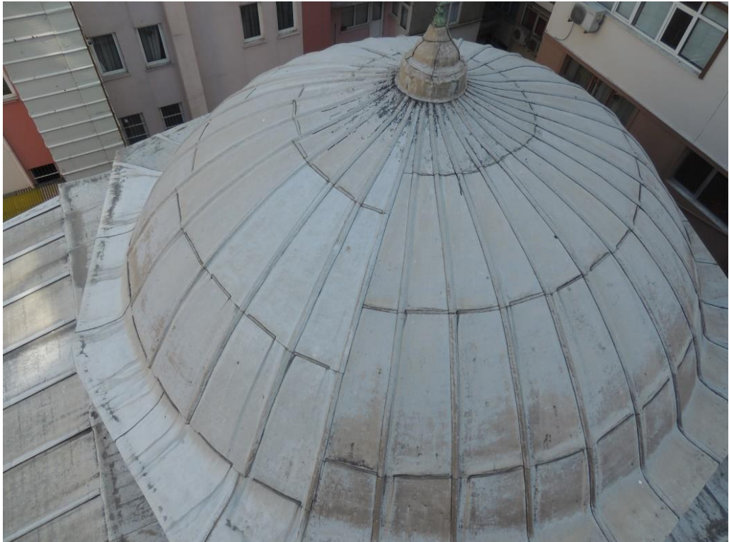
Ek D. 38: Kurşun kaplama kubbe üst örtüsü
