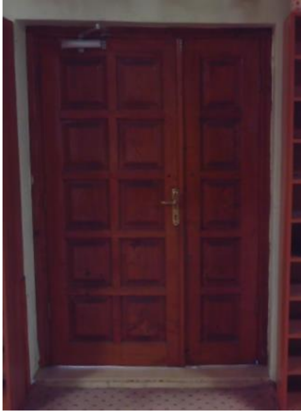
Ek D. 85: H04 Harim kapısı detayı, iç görünüş
