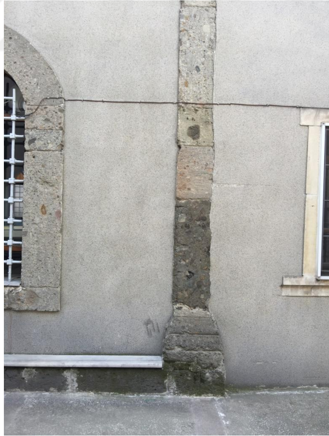
Ek. D. 14: Harimin doęu duvarındaki dūşey kōşey silmesi
