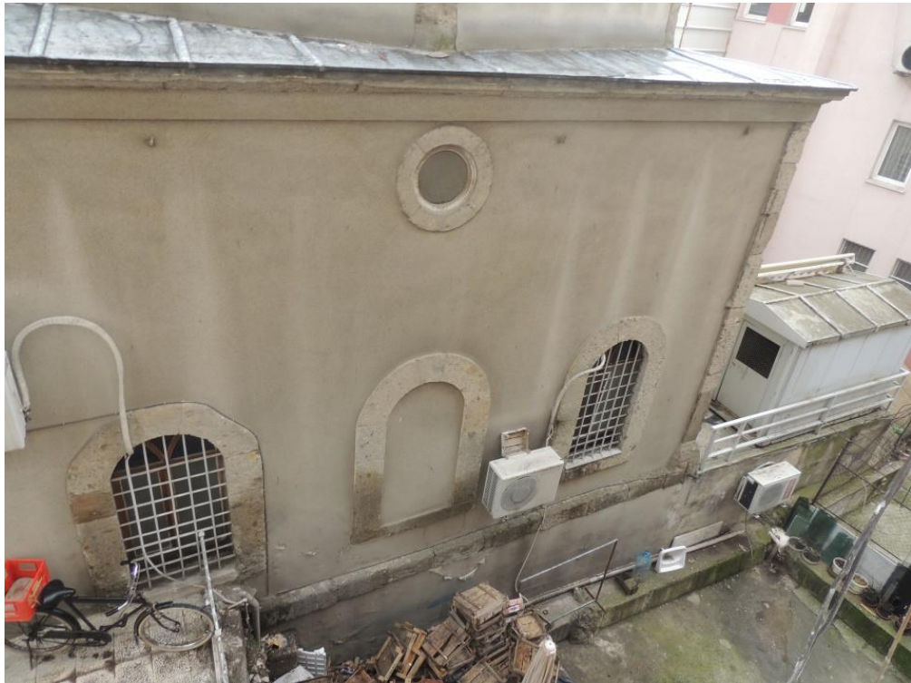
Ek. D. 26: Güney cephe genel görünüm
