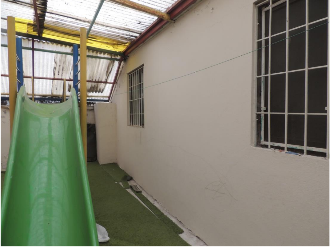
Ek. D. 16: Z05 harime ait dođu duvarı
