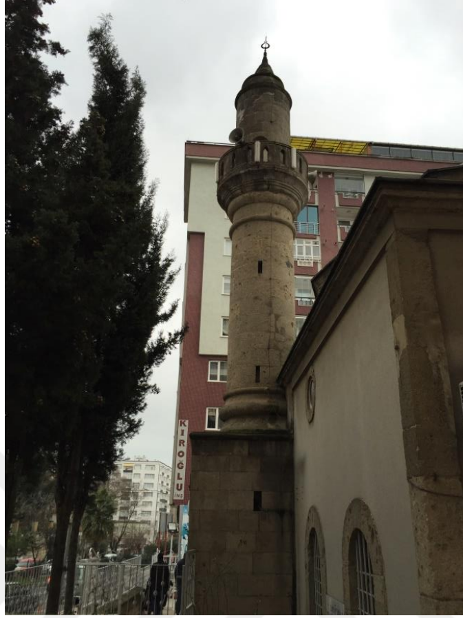
Ek. D. 29: Minare ve kaidesi güney duvarı
