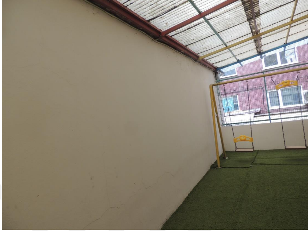
Ek. D. 17: Tuvaletlerin dođu duvarı
