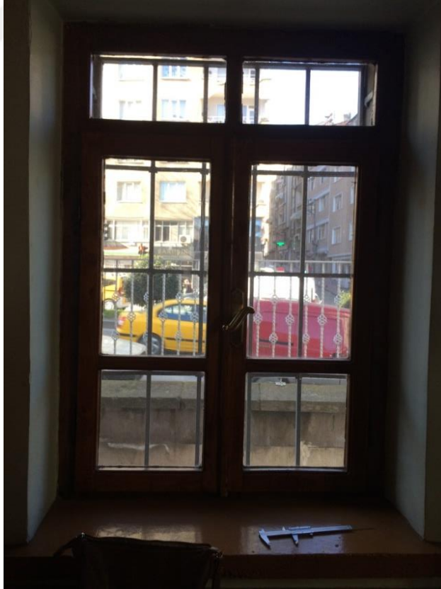
Ek D. 83: H01 Son cemaat mahalli pencere detayı, iç görünüş
