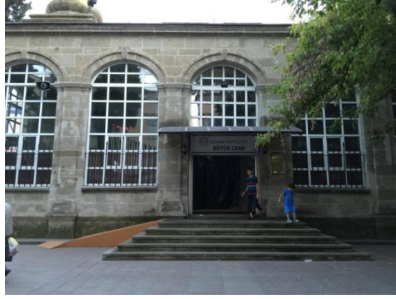
Şekil 1. 12: Samsun Büyük Camii Son Cemaat Mahalli Giriş Cephesi (2015)
