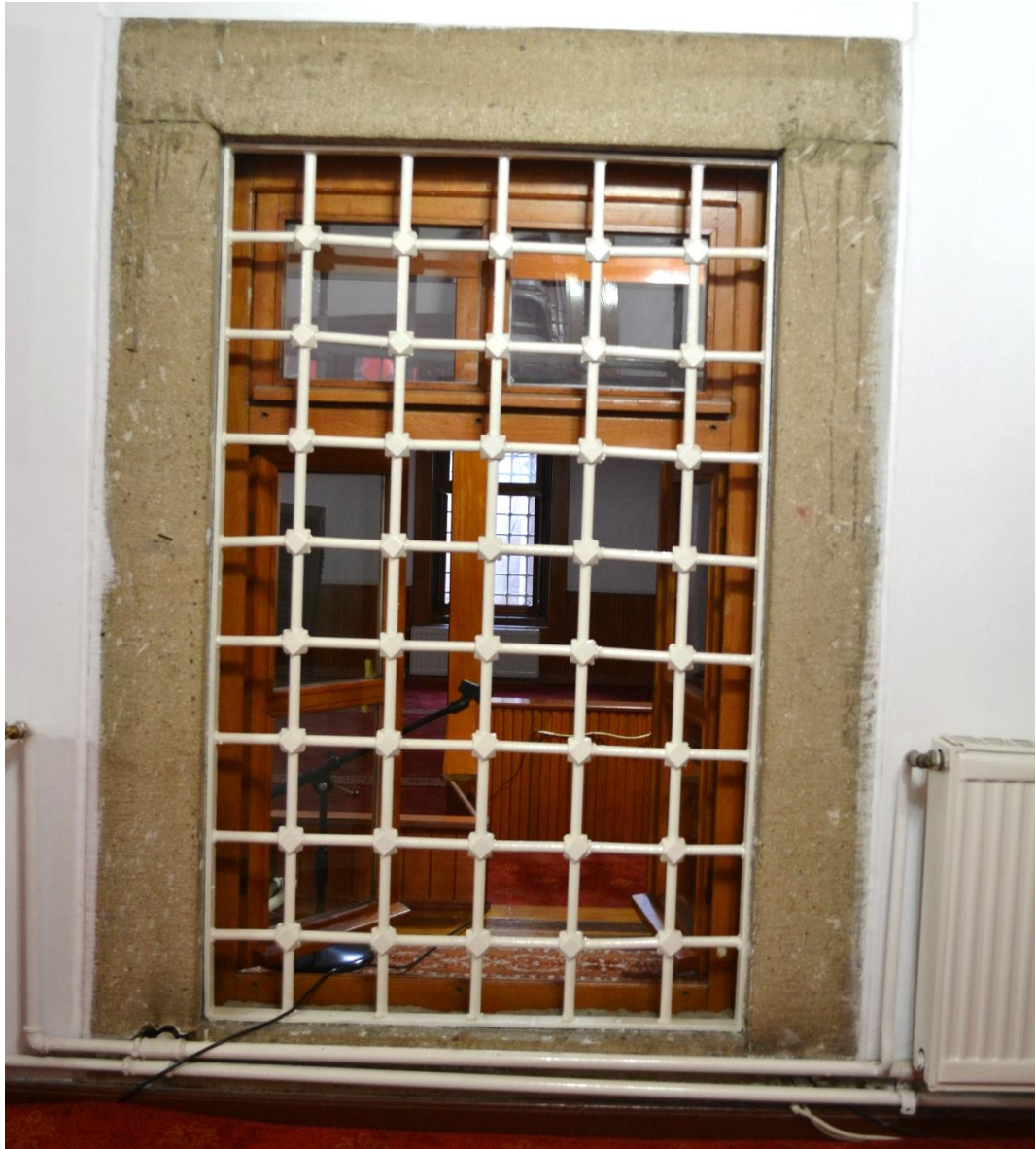
Şekil 170 :Isıtma İhtiyacı İçin Taş Sövenin Uğratılması (E.Aluç 2014)
