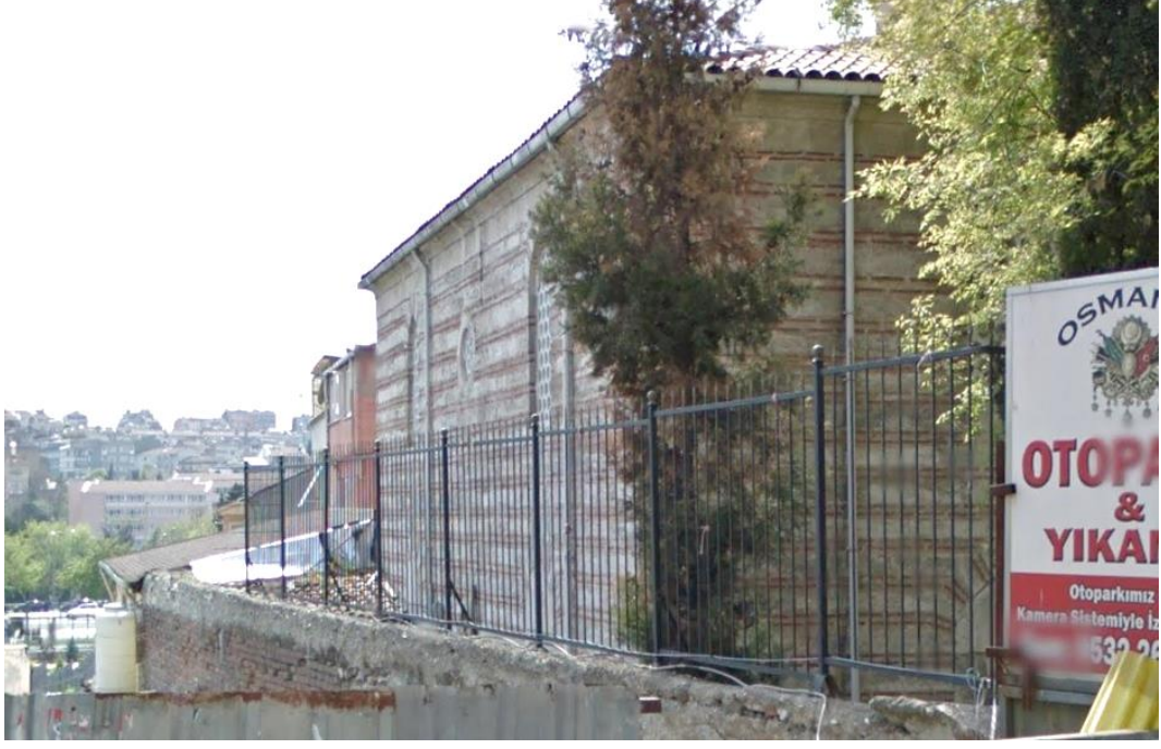
Şekil 70 :Mihrap Cephesi Fotoğrafı (İ.B.B. C.B.S.M 2014)
