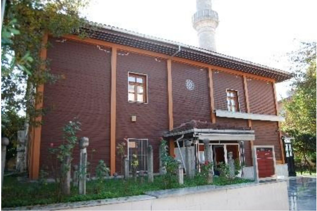
Şekil 67 :Giriş Cephesi Fotoğrafı (Kaynağı Bilinmiyor)
