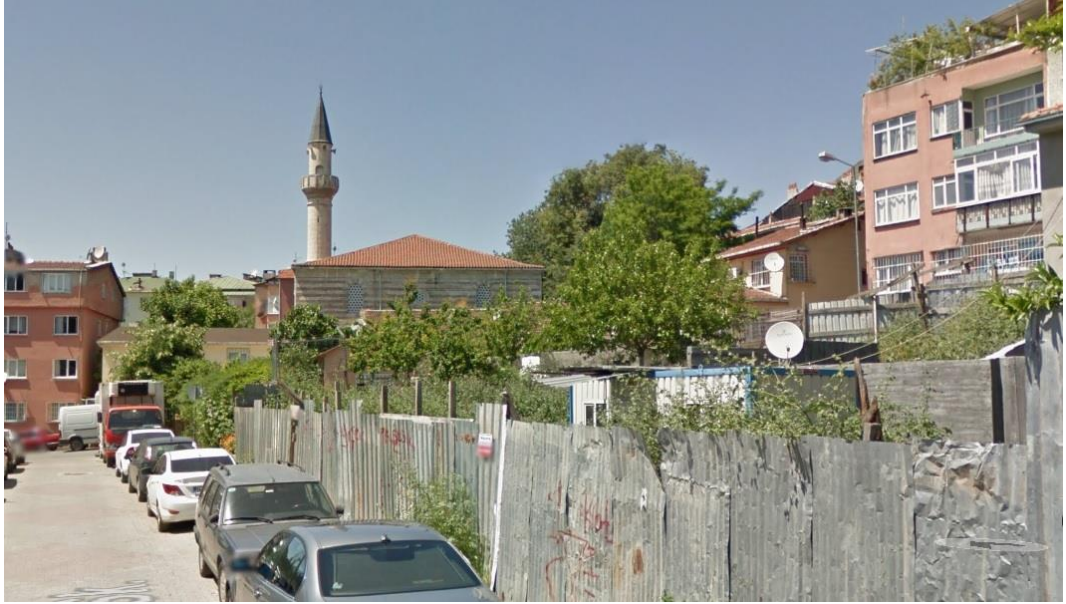
Şekil 71 :Mihrap Cephesi Fotoğrafı (İ.B.B. C.B.S.M 2014)
