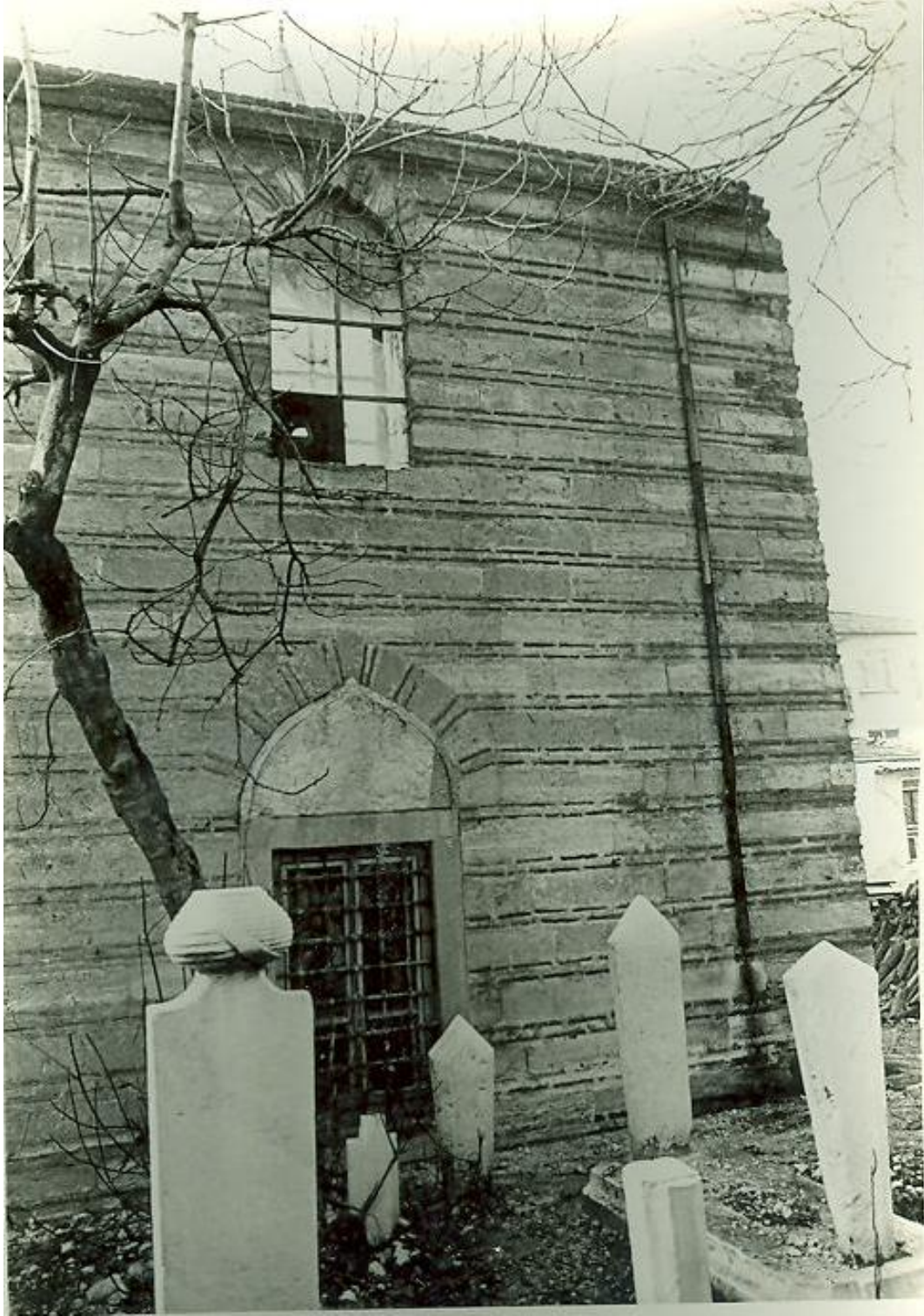
Şekil 162 :Yol Cephesi (Kurul Arşivi 1979)
