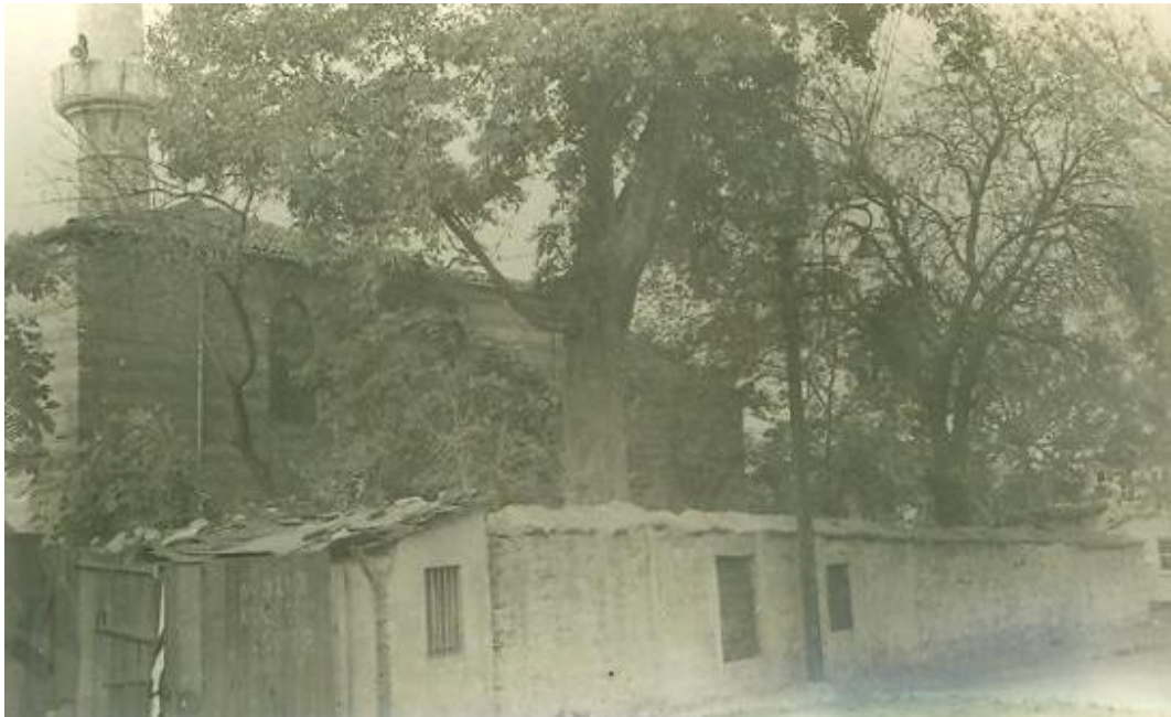
Şekil 160 :Yol Cephesi (Kurul Arşivi 1968)
