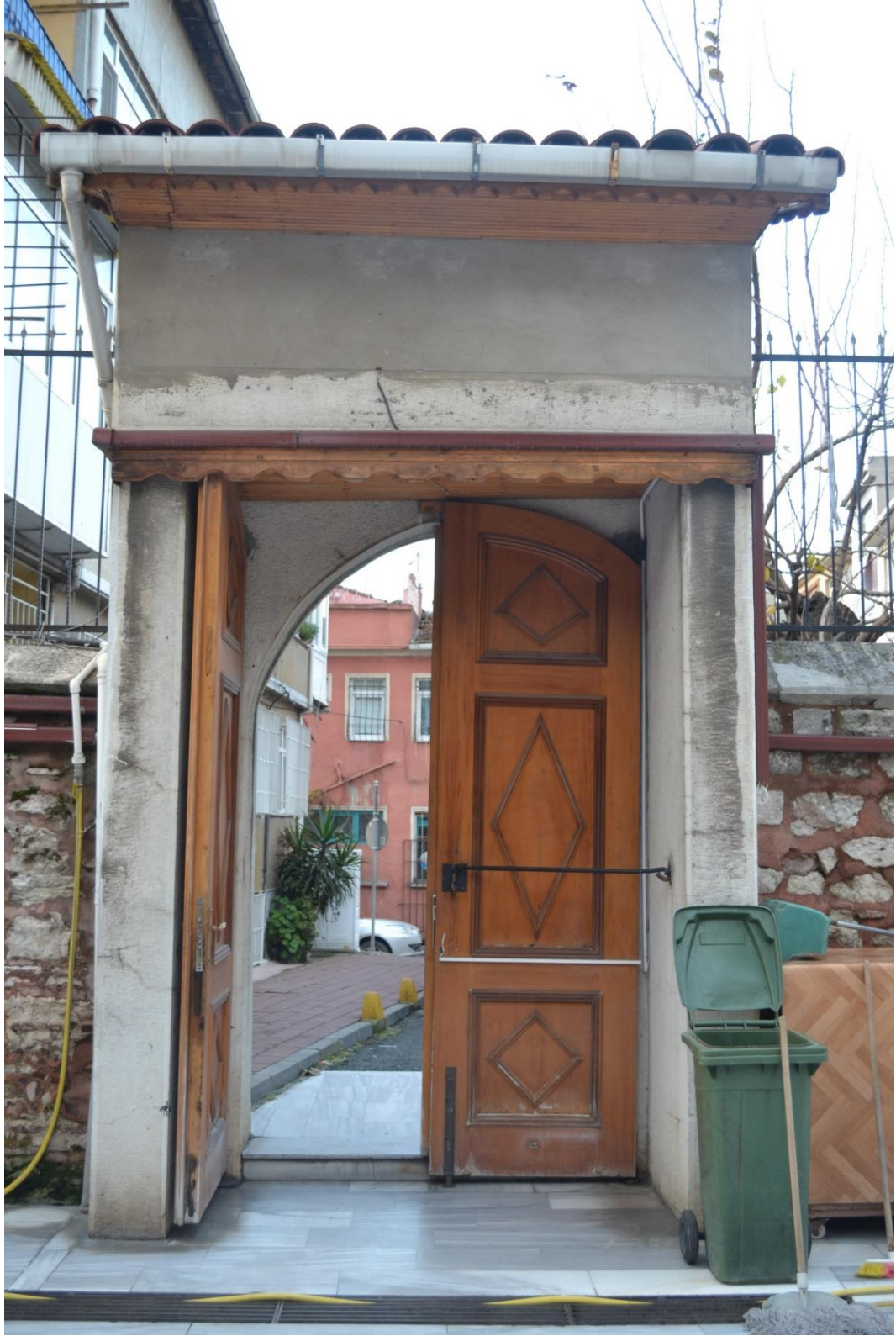
Şekil 50 :Avlu Giriş Kapısı İçerden Görünüm (E.Aluç 2014)
