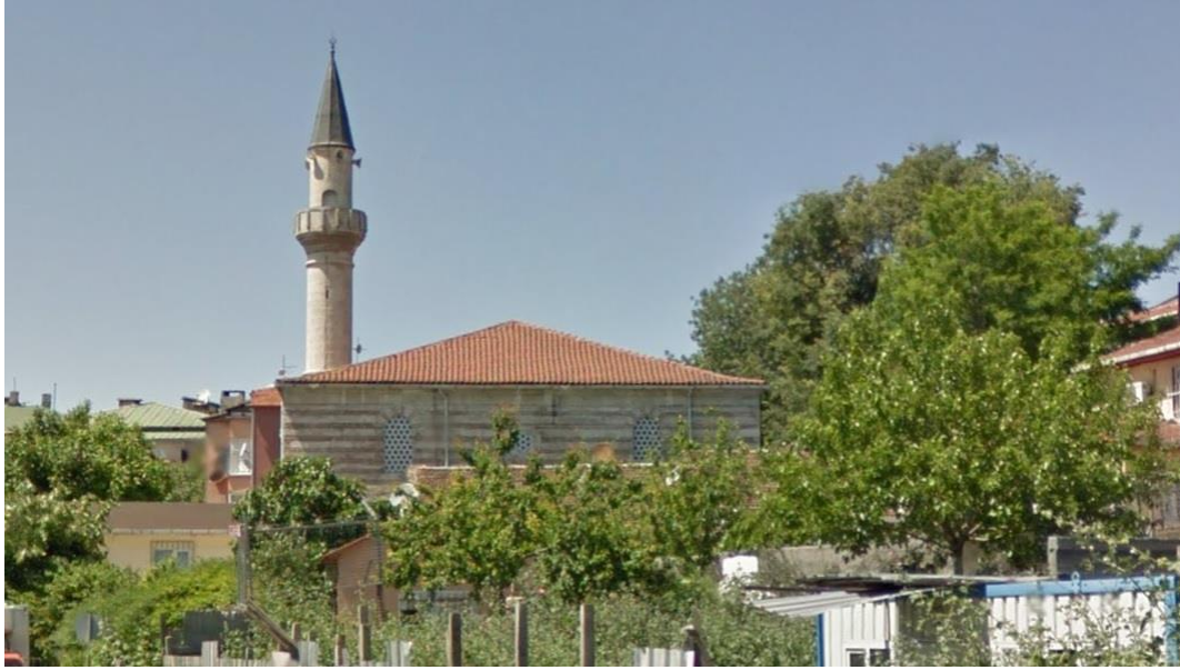
Şekil 72 :Mihrap Cephesi Fotoğrafı (İ.B.B. C.B.S.M 2014)
