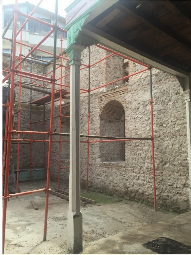
Şekil 4.25 Batı Cephesi iç kısım Görünüşü (Raspa sonrası), 2015
