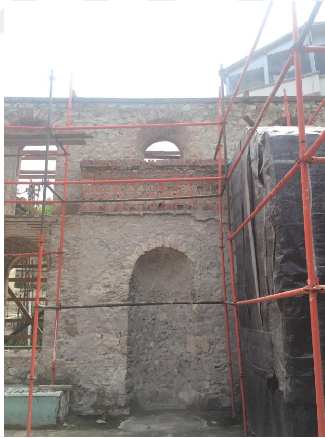
Şekil 4.10 Kaya Camii Harim Bölümü mihrap kısmı (raspa sonrası), 2016
