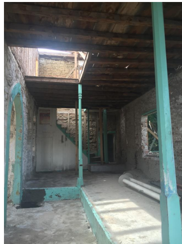
Şekil 4.5 Son cemaat mahalli görünüş (raspa sonrası), 2016
