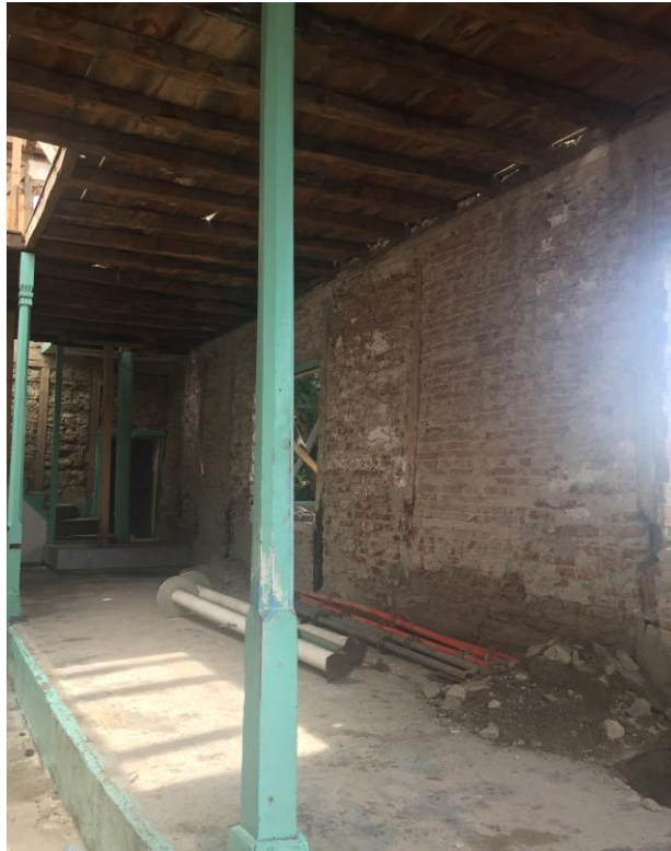
Şekil 4.31 Kuzey Cephesi Görünüşü iç kısım (Raspa sonrası), 2016
