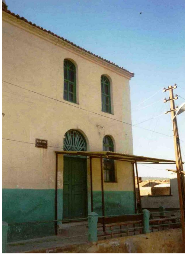
Şekil 6.23 Kaya Camii Giriş Bölümü, (Gönen,F. 1992)
