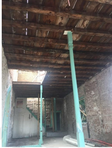
Şekil 5.9 çürümeye maruz kalmış tavan ( son cemaat mahalli tavan karkası), 2016
