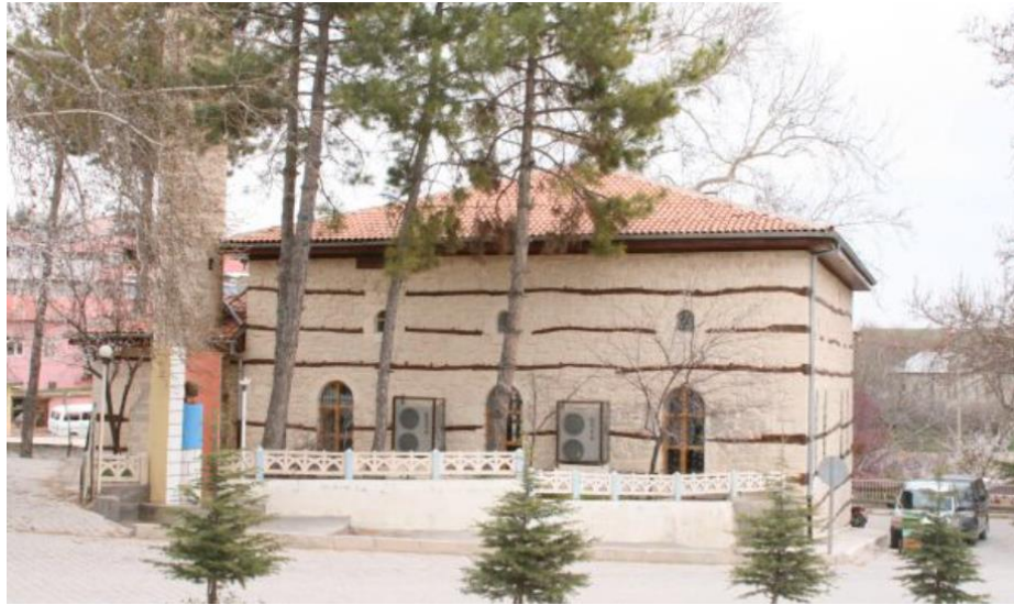
Şekil 6.3 Agin Merkez Camii Doğu Cephesi (Elazığ), 2014
