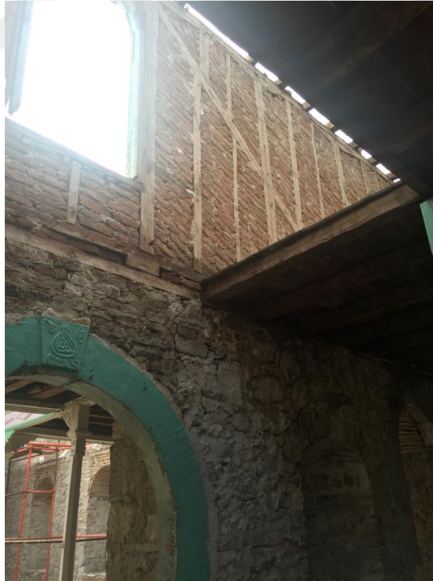
Şekil 4.39 Harim-son cemaat mahalli ara Duvar Örgüsü Raspa sonrası, 2016
