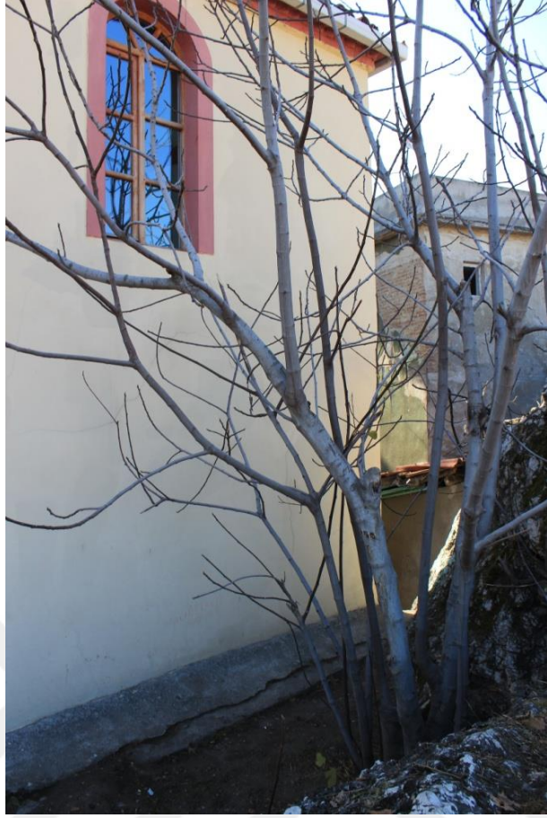
Şekil 4.30 Kuzey Cephesi Görünüşü, 2015
