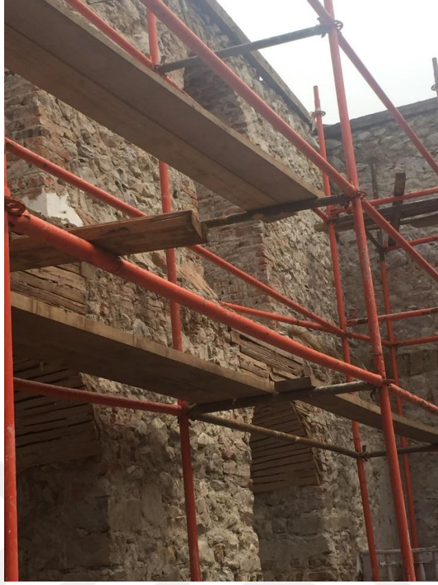
Şekil 4.29 Doğu Cephesi Giriş Bölümü iç kısım (Raspa sonrası), 2016
