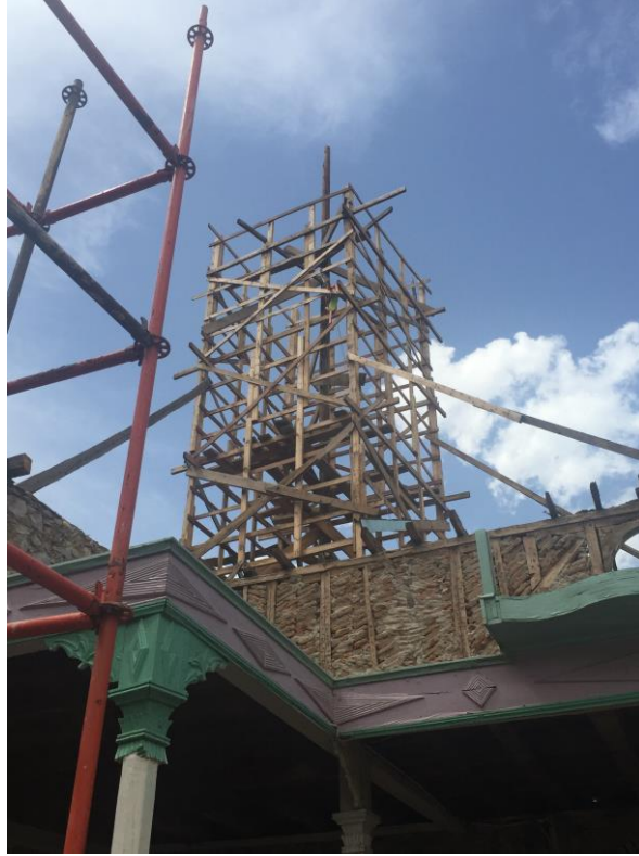
Şekil 4.20 Ahşap Minare direği, 2016
