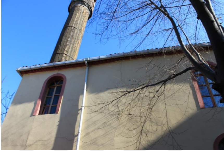
Şekil 4.22 Batı Cephesi Minare Köşesi, 2015
