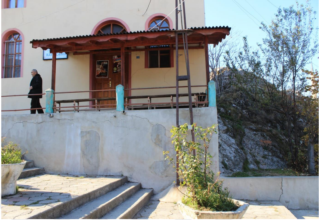
Şekil 4.27 Doğu Cephesi Giriş Bölümü, 2015
