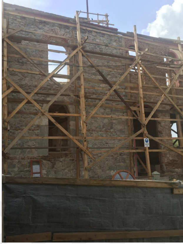
Şekil 4.40 Doğu cephesi Duvar Örgüsü Raspa sonrası, 2016
