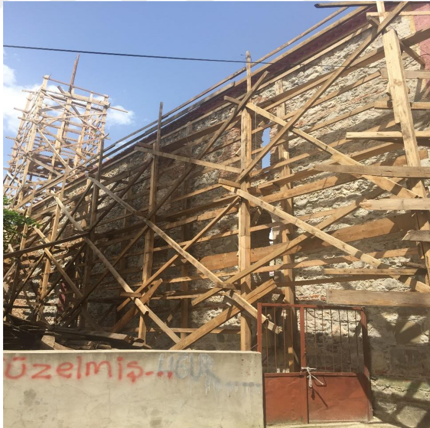
Şekil 4.23 Batı Cephesi Raspa Sonrası, 2016
