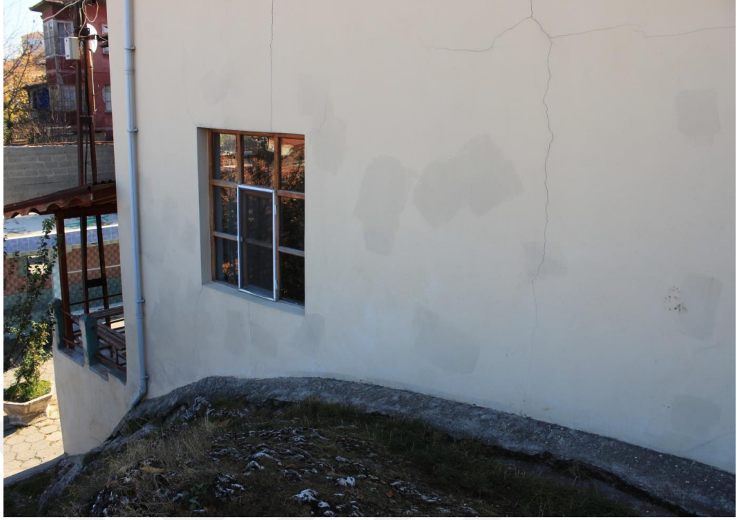
Şekil 4.32 Kuzey Cephesi muhdes Pencere, 2015
