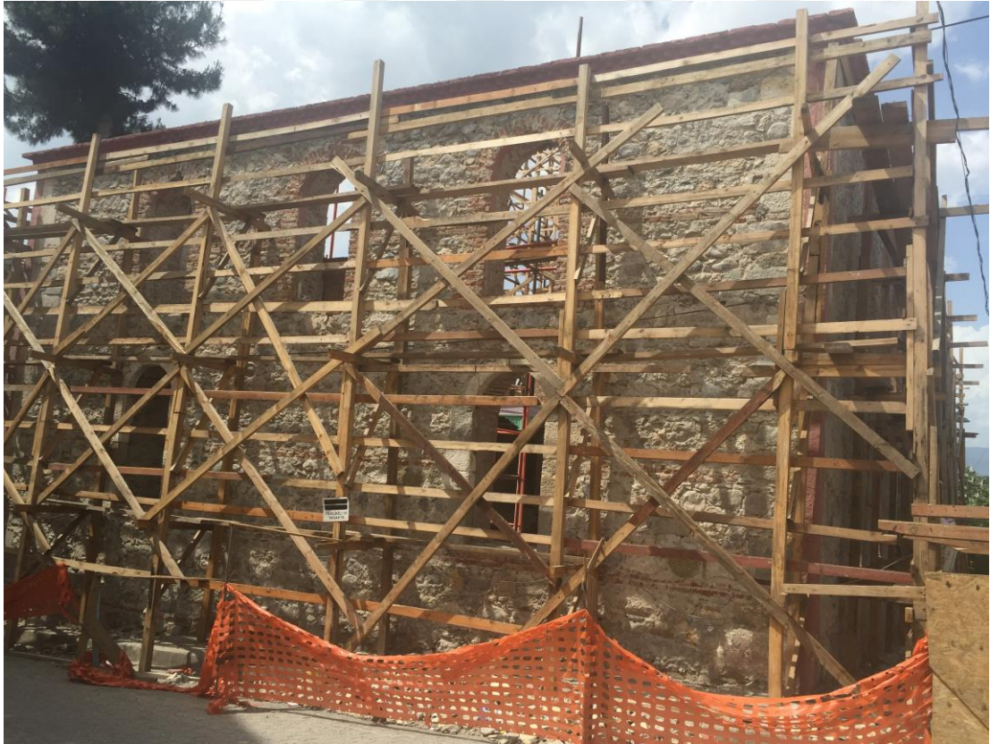
Şekil 4.34 Güney Cephesi Görünüşü (Raspa sonrası), 2016
