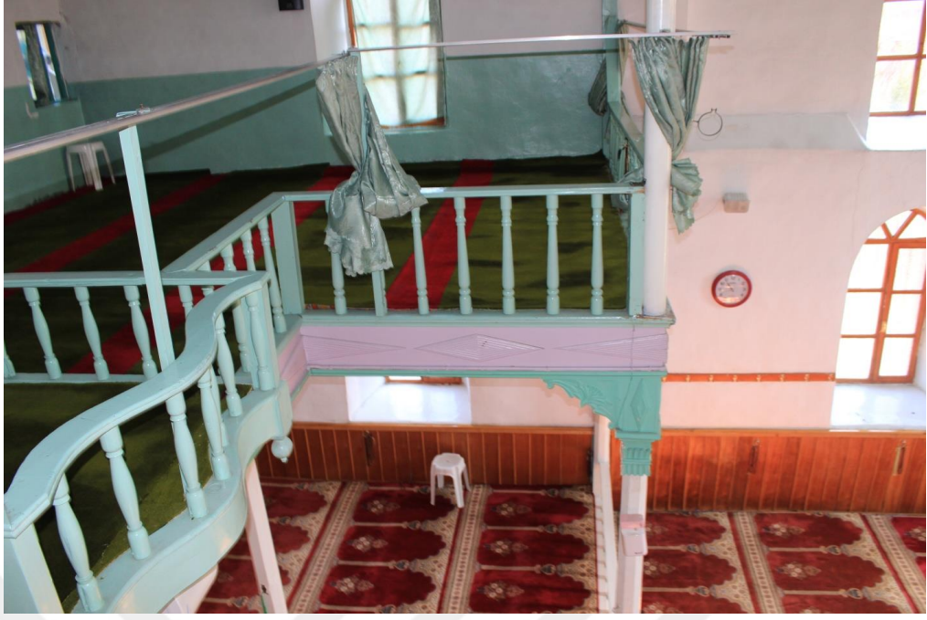
Şekil 4.14 Kadınlar Mahfili Taşıyıcı Ahşap Dikmeler, 2015
