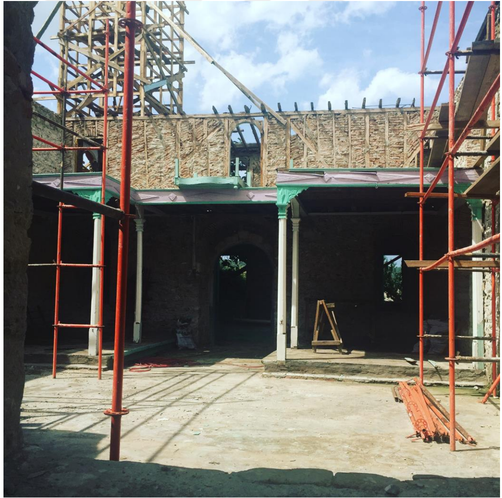
Şekil 4.15 Kadınlar Mahfili Taşıyıcı Ahşap Dikmeler (Raspa sonrası), 2016
