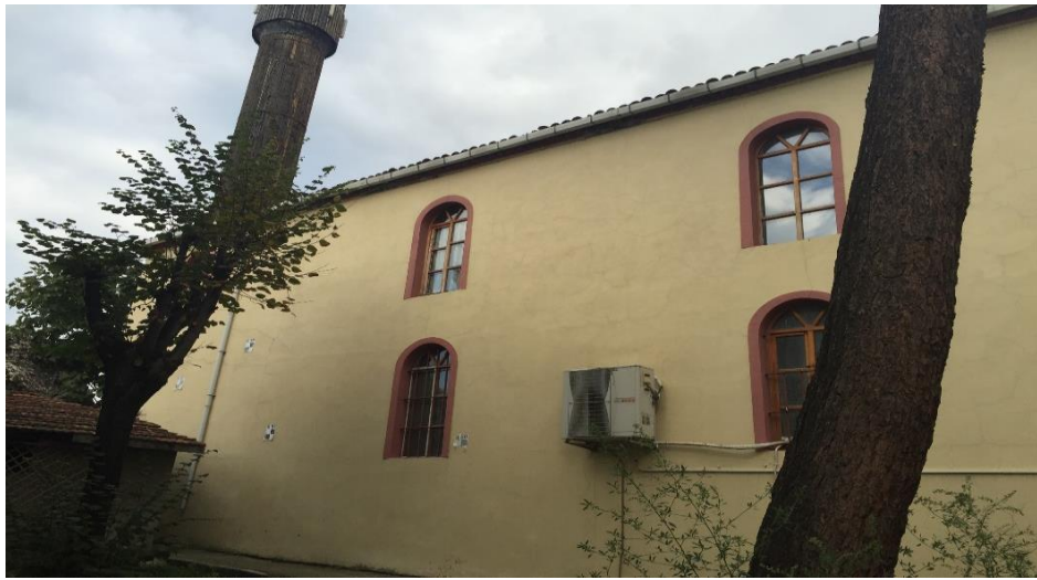
Şekil 4.21 Batı Cephesi Görünüşü, 2015
