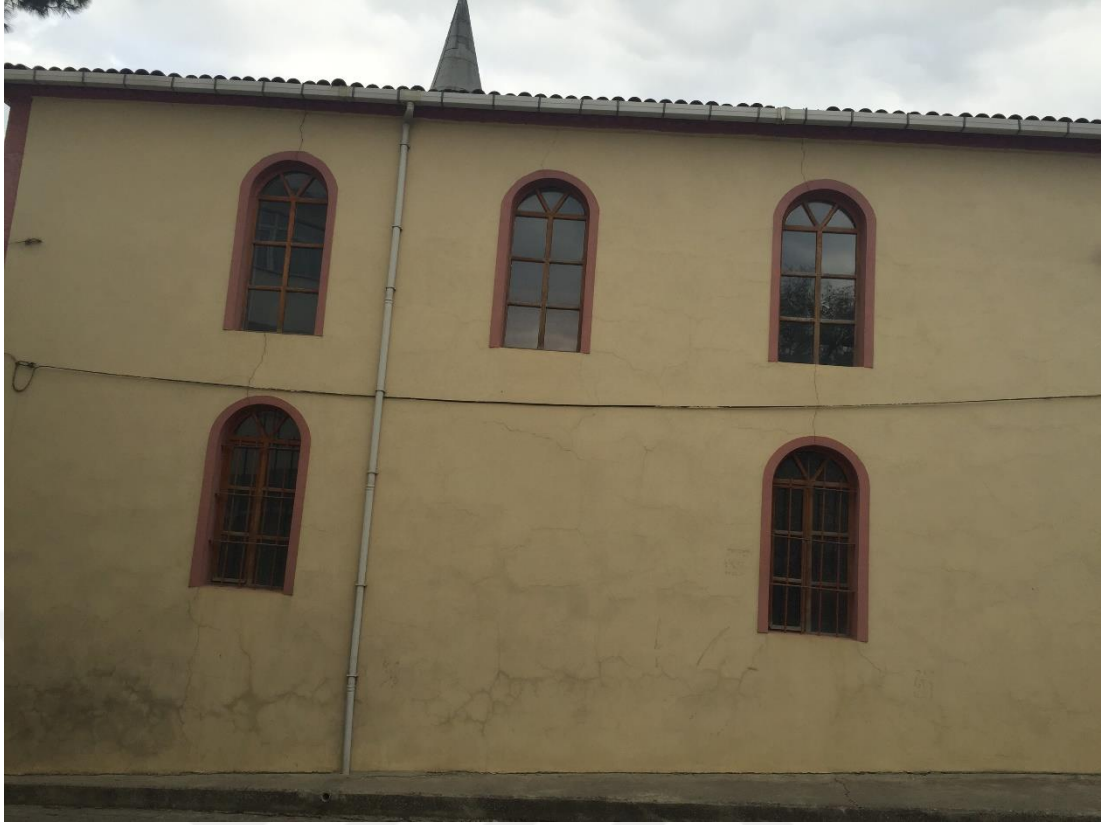
Şekil 4.33 Güney Cephesi Görünüşü, 2015
