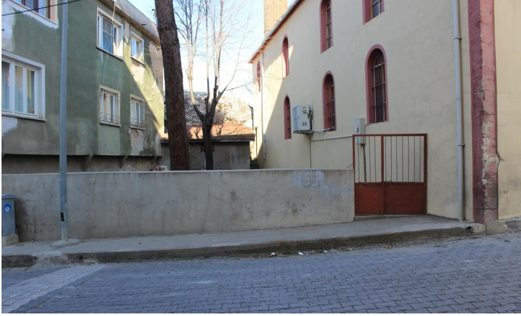
řekil 4.2 Kaya Camii Bahe kısmı, 2015
