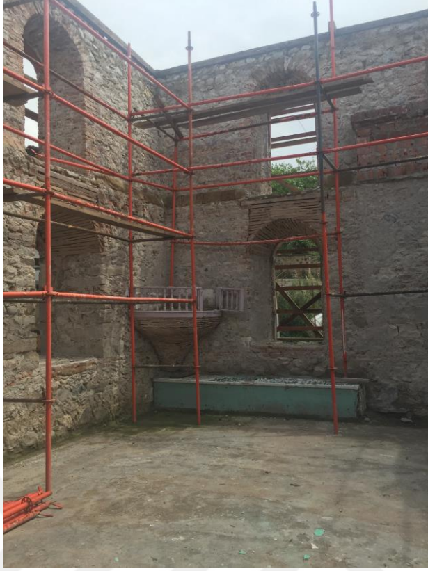
Şekil 4.9 Kaya Camii Harim Bölümünü kürsü köşesi (raspa sonrası), 2016
