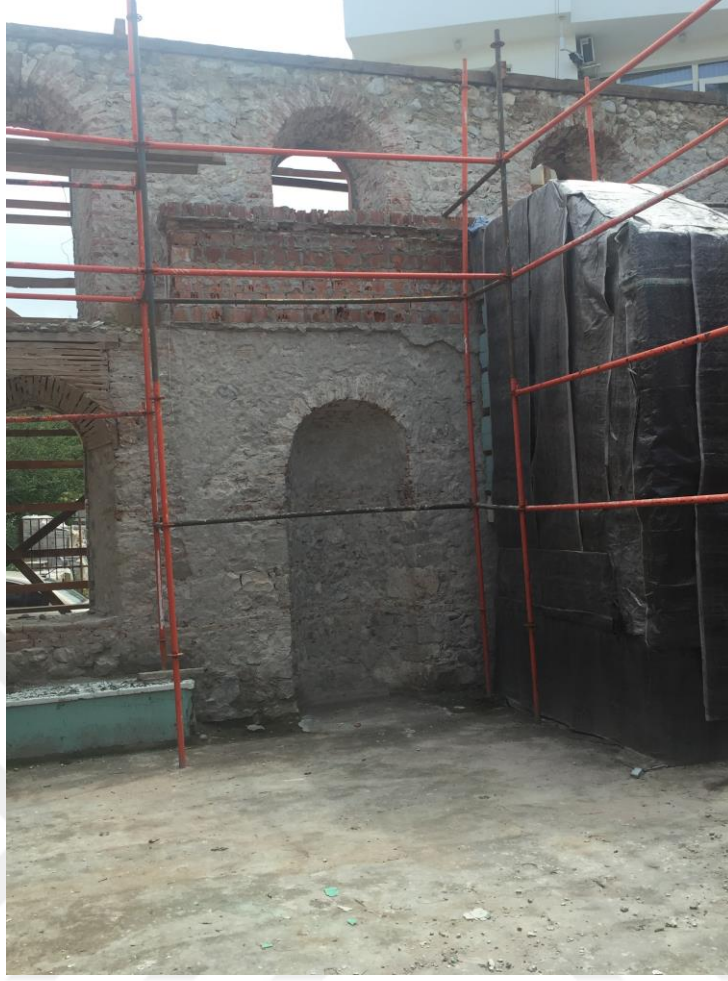
Şekil 4.35 Güney Cephesi Görünüş iç kısım (Raspa sonrası), 2016
