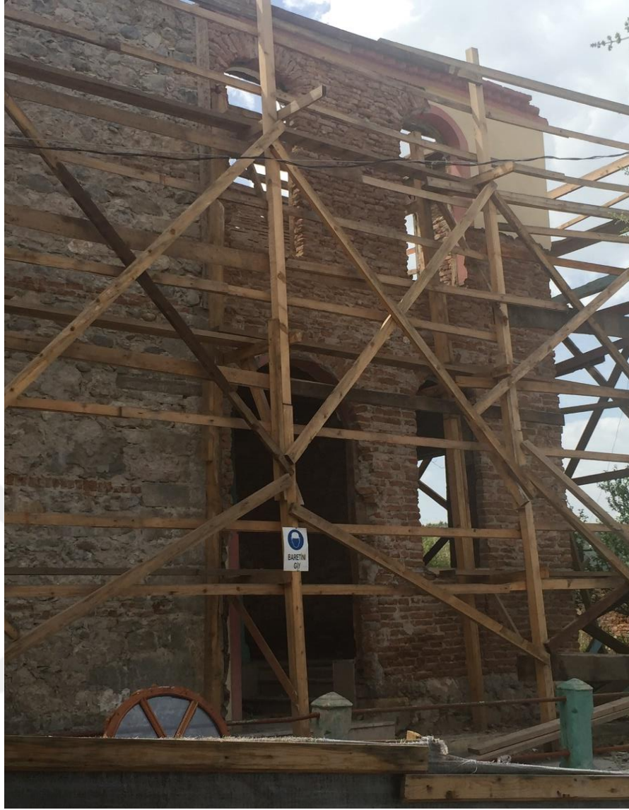
Şekil 4.36 Doğu Cephesi farklı dönem duvar örgüsü (Raspa sonrası), 2016
