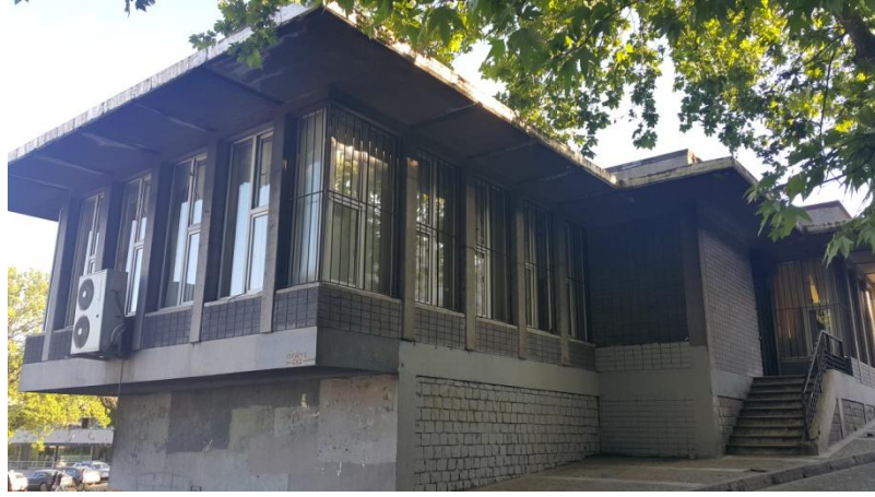
Şekil 4.42: Zeyrek SSK Kompleksi (Reşat BADUR)
