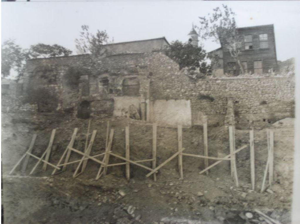
Şekil 4.26: İnşaat Öncesi Parselin Fotoğrafi (1966) (Anıtlar Kurulu Proje Dosyası)
