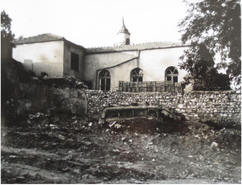
Şekil 4.25: İnşaat Öncesi Parselin Fotoğrafi (1966) (Anıtlar Kurulu Proje Dosyası)
