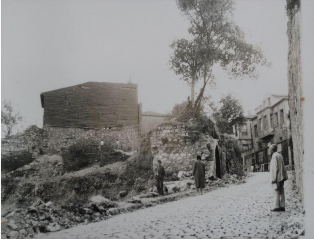
Şekil 4.22: İnşaat Öncesi Parselin Fotoğrafi (1966) (Anıtlar Kurulu Proje Dosyası)
