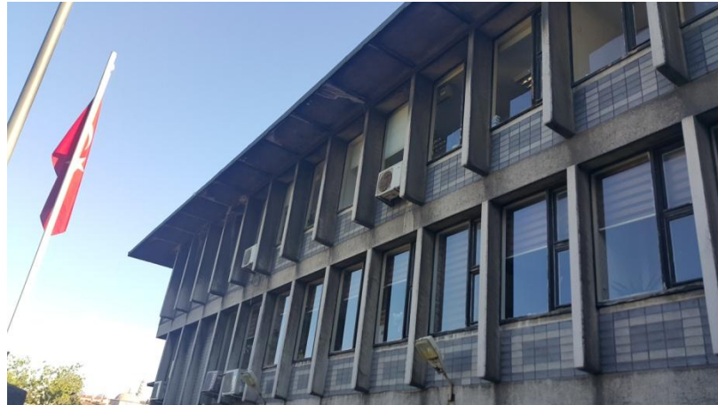
Şekil 4.43: Zeyrek SSK Kompleksi (Reşat BADUR)
