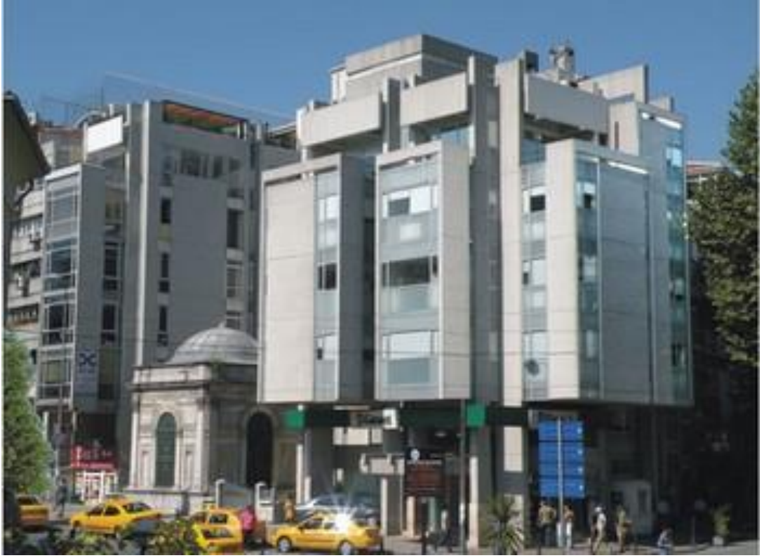
Şekil 4.7: İstanbul Reklam Binası(www.yapı.com.tr)
