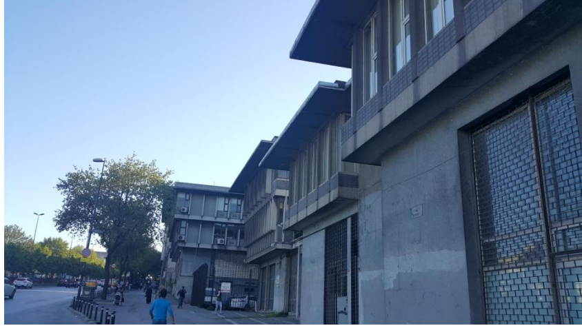
Şekil 4.44: Zeyrek SSK Kompleksi (Reşat BADUR)
