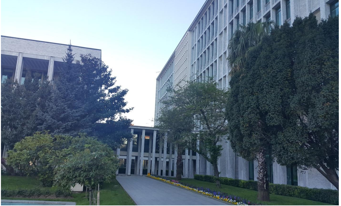
Şekil 4.112: İki Blok Arasındaki Bağlantı 2016(Reşat BADUR Özel Arşivi)
