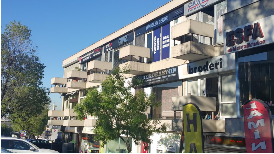
Şekil 4.69: Tabelalarla doldurulmuş İMÇ Yapısının Cephesi 2016 (Reşat BADUR Arşivi)
