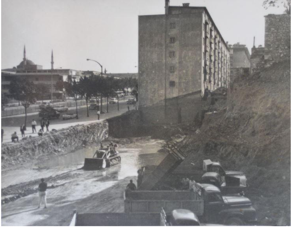
Şekil 4.23: İnşaat Öncesi Parselin Fotoğrafi (1966) (Anıtlar Kurulu Proje Dosyası)
