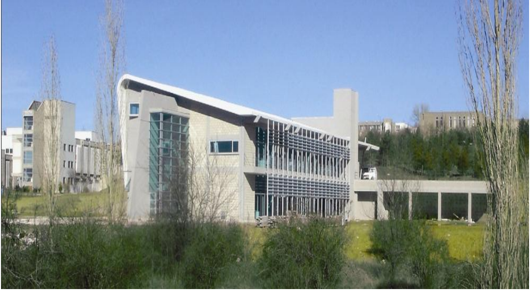
Şekil 4.6: Orta Doğu Teknik Üniversitesi Mimarlık Fakültesi(Behruz Çinici)
