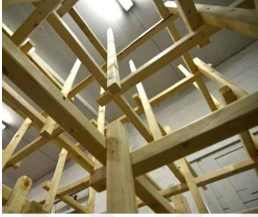
Resim 4.15 : Strüktürün köşe birleşimleri [Parigi, Pugnale s:164]
