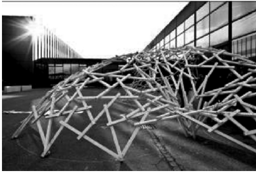
Resim 3.13 : Farklılaşmış örgü strüktür, deneme montajı[Thönnissen, Werenfels s:371]
