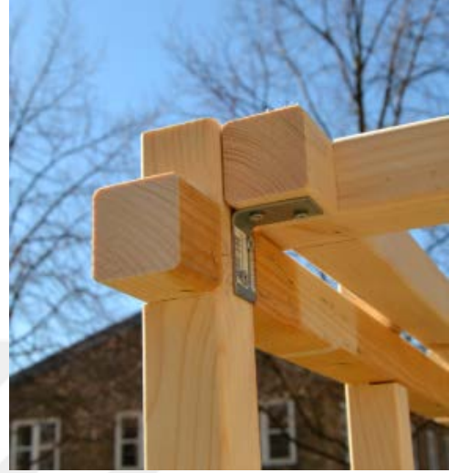
Resim 5.11: Mütekabil strüktür prensibine göre oluşacak bağlantı[Larsen, Lee 2013 s:3]
