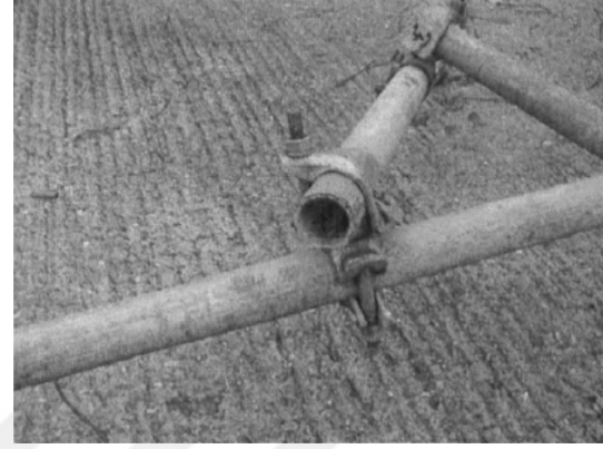
Resim 4.10 : İskele kelepçesi kullanılan bir bağlantı[Baverel, 2000 s:269]
