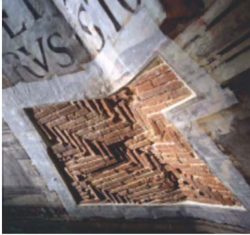
Resim 2.10 : Fresklerin restorasyonu esnasında açığa çıkmış olan kubbenin balıksırtı örgüsü [Pizzigoni, 2014 s:7]
