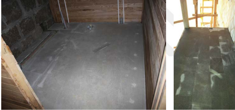
Şekil 5.57: Banyolarda betopan uygulaması ve balkonda granit döşeme uygulaması.
