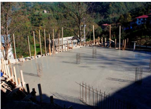
g. Radye temel ve hazır kolon ve duvarlar
