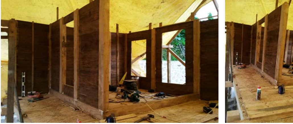
Şekil 5.82: Eski tahtalarla yığma sistem duvarların oluşturulması.
