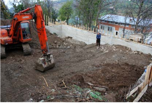
c. Dere çakılı serilmesi
