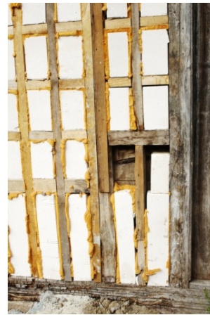
Şekil 4.120: Göz dolma duvarlara gaz betondan sikon köpükle dolgu yapılması.
