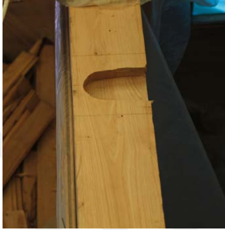
Şekil 5.38: Dişi ve erkek kırlangıç geçme detaylarının açılması.
