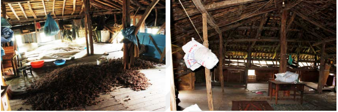
Şekil 4.37: Çatı katı genel görünüm.
