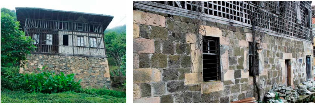
Şekil 4.47: Ahır katı taş duvar örnekleri.
