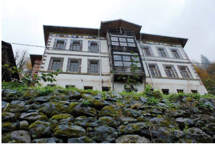
Şekil 3.8: Araziye oluşan setler.
