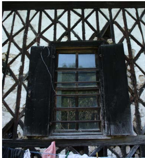
Şekil 3.26: Giyotin pencere sistemi ve kepenkler.
