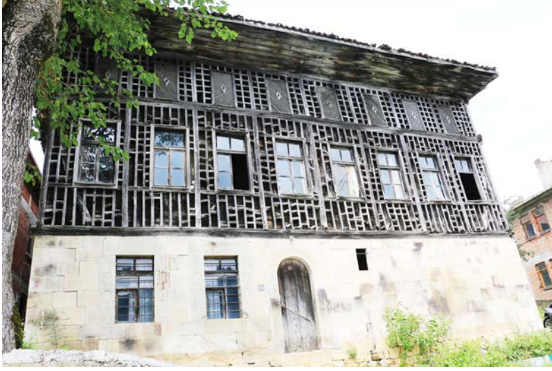
Şekil 4.91: Yapının ön cephe görünümü.
