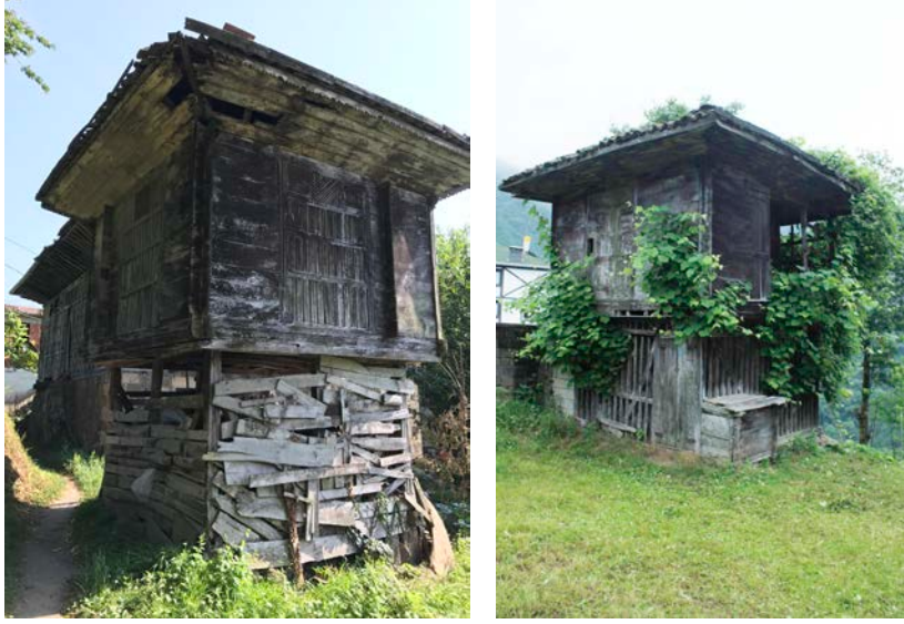
Şekil 4.74: Karma sistemle yapılan seranderler.
