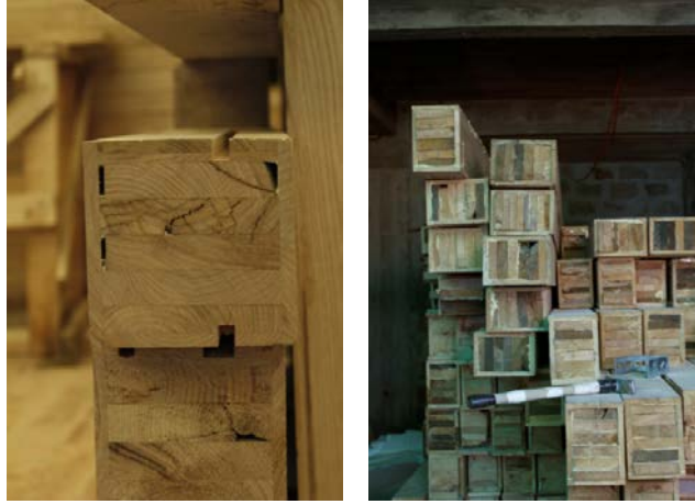
Şekil 5.32: Lamine edilmiş taşıyıcı dikmeler.
