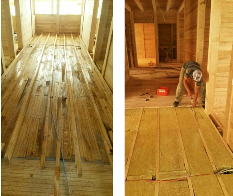
Şekil 5.56: Birinci kat lambrilerinin döşenmesi.
