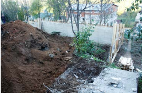
a. İstinat Duvarının yapımı
