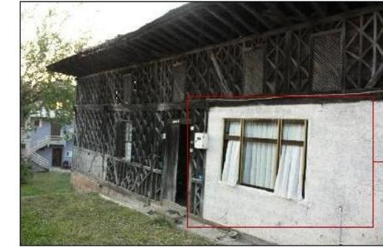
Aşenanın yıkılan ağşap dış duvarının yerine örülen briket duvar ve doğrama
