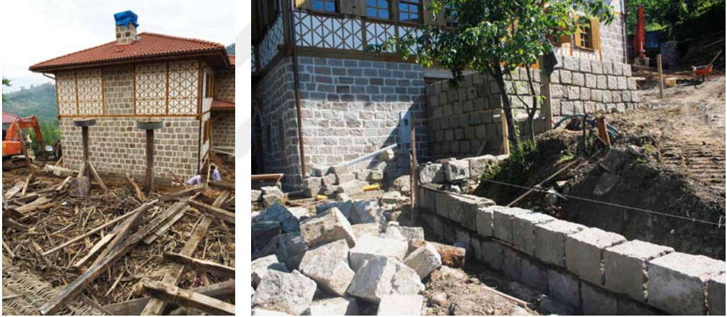
Şekil 5.73: Seranderin sökülmesi ve taş duvarların örülmesi.
