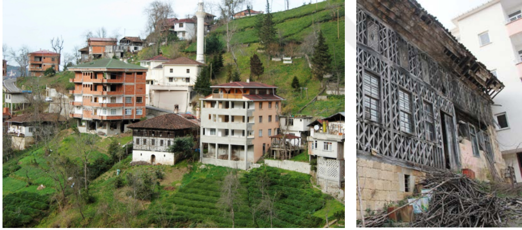
Şekil 4.121: Çevreye duyarsız betonarme yapılar.
