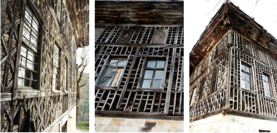
Şekil 4.96: Muska ve göz dolma sistemlerinin kullanıldığı dış cephe duvarları.
