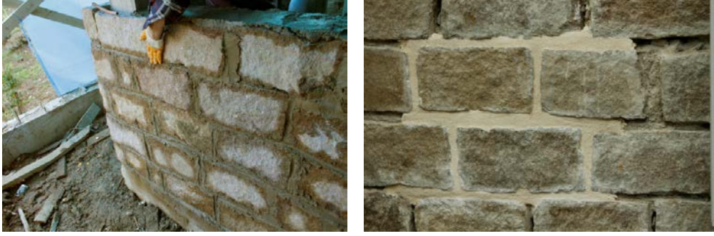
Şekil 5.68: Harçla duvarların örülmesi ve derz yapılması.
