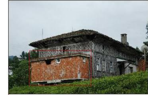
Manzaraya çılan cepheye eklenen betonarme-tuğla banyo eklentisi
