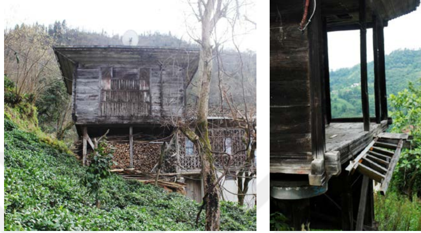
Şekil 4.72: Odun depolanan ambar ve üst kata çıkan hareketli merdiven.
