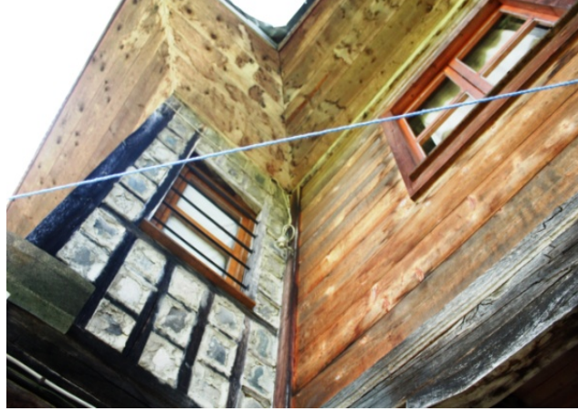
Şekil 3.46: Karma sistem detayı (Tayla,2007) (yazara ait).
