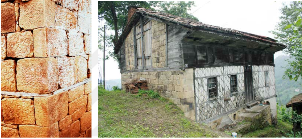
Şekil 4.48: Ahır katından devam eden aşena taş duvarı.
