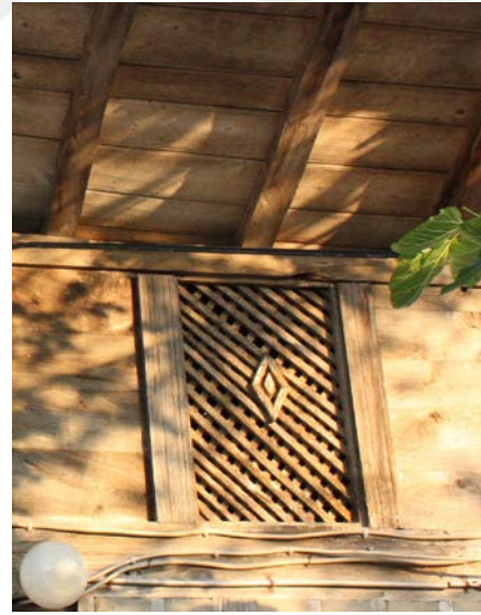
Şekil 4.59: Yığma sistem çatı katı duvarı ve ahşap örgü sistem pencereler.
