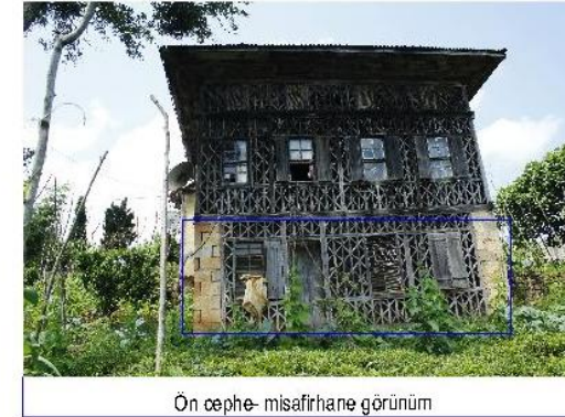
Ön cephe- misafirhane görünüm
