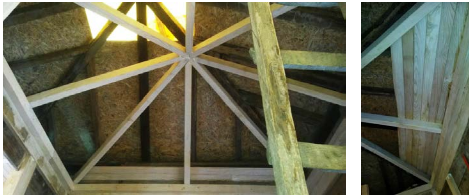
Şekil 5.86: Seranderin ve odanın çatı sistemi.
