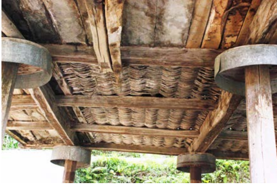
Şekil 4.76: Ambar zemin döşemesi ve cephe detayı.
