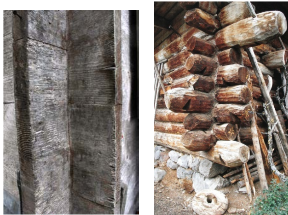
Şekil 3.36: Kurt boğazı geçme (yazara ait) ve kara boğaz geçme detayı (Batur, 2005).
