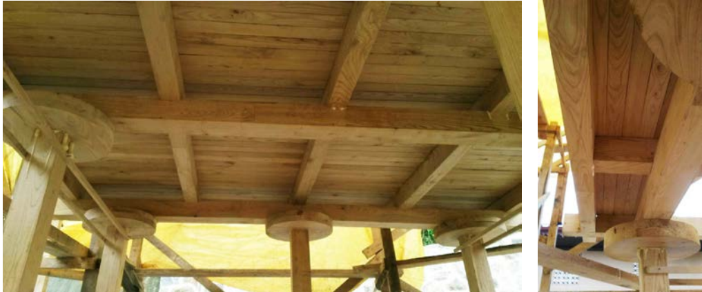
Şekil 5.81: Dikmeler, tekerler, kirişler ve döşemeler.
