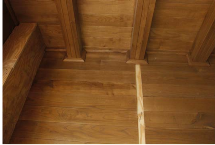
Şekil 3.67: Bölümlü’de inşa edilen yeni yapı.
