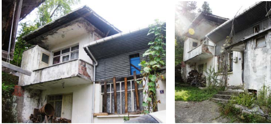
Şekil 5.4: Betonarme ek yapının balkon ve tuvalet birimi.
