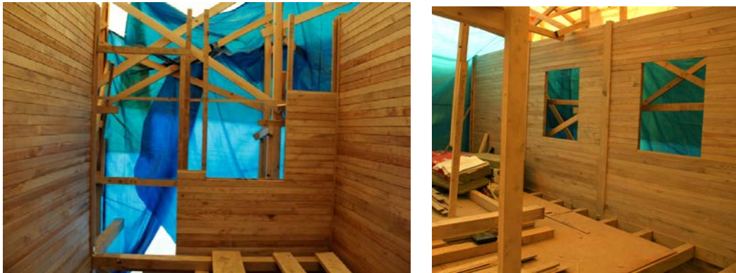
Ŗekil 5.48: DıŖ duvarlarda kapı ve pencere boŖluklarının bırakılması.
