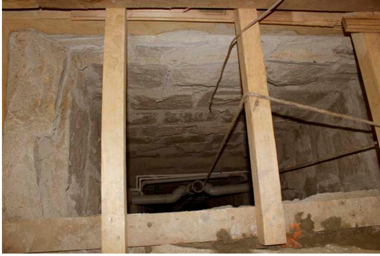
Şekil 5.71: Taş duvar tesisat boşluğu.
