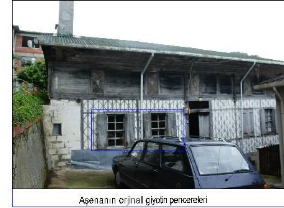
Aşenanın orjinal giyotin pencereleri
