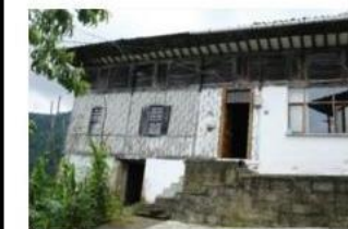
Değiştirilen aşena duvar ve doğramaları
