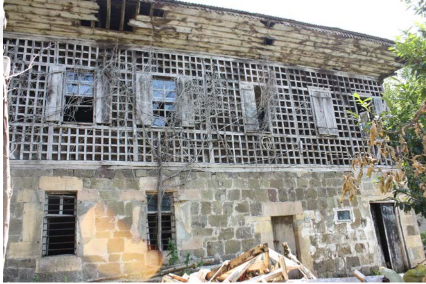
Şekil 4.108: Aynı kottaki konut giriş ve ahır kapıları.
