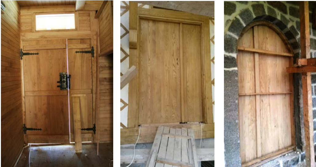
Şekil 5.64: Kuşaklı giriş kapısının iç ve dış görünümü ve bodrum katı kuşaklı giriş kapısı.
