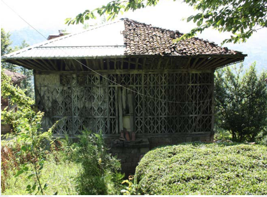
Şekil 4.109: Yapının arka cephe görünümü.
