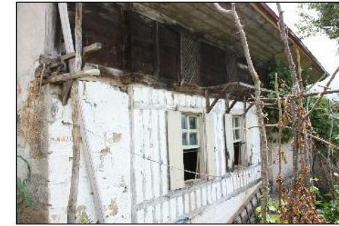
YAN CEPHE GÖRÜNÜM
