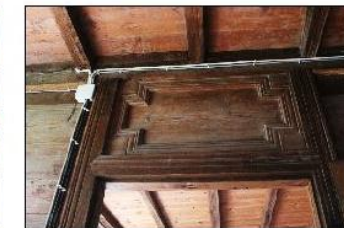
Aşena ve çordak kapı üstü detayları
