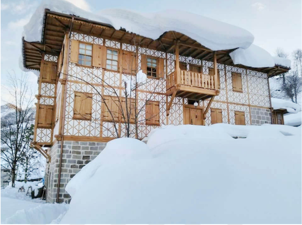
Şekil 5.30: Ön cephedeki çıkma ve yan cephedeki balkon.
