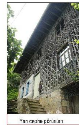
Yan cephe görünüm
