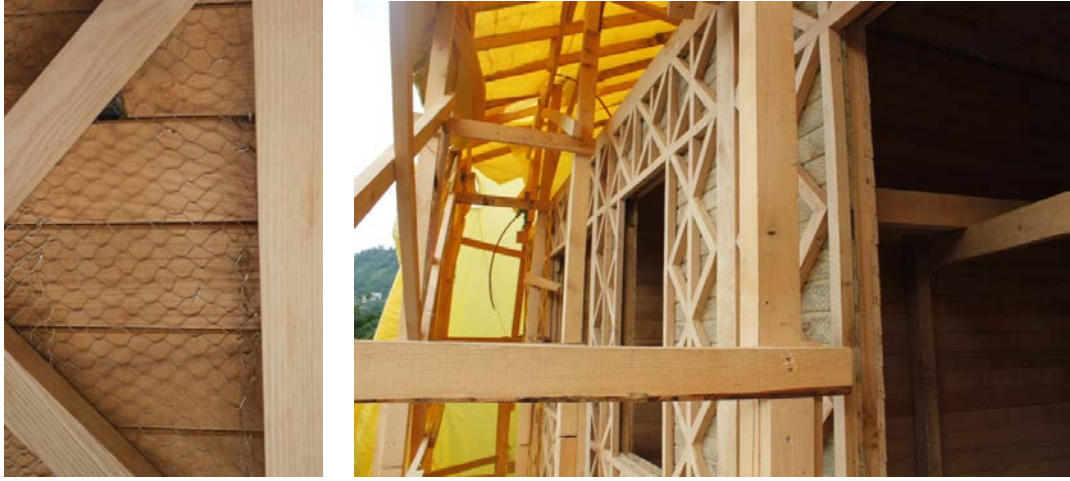
Şekil 5.49: Sıva telinin üzerine ahşap çıtaların çakılması.
