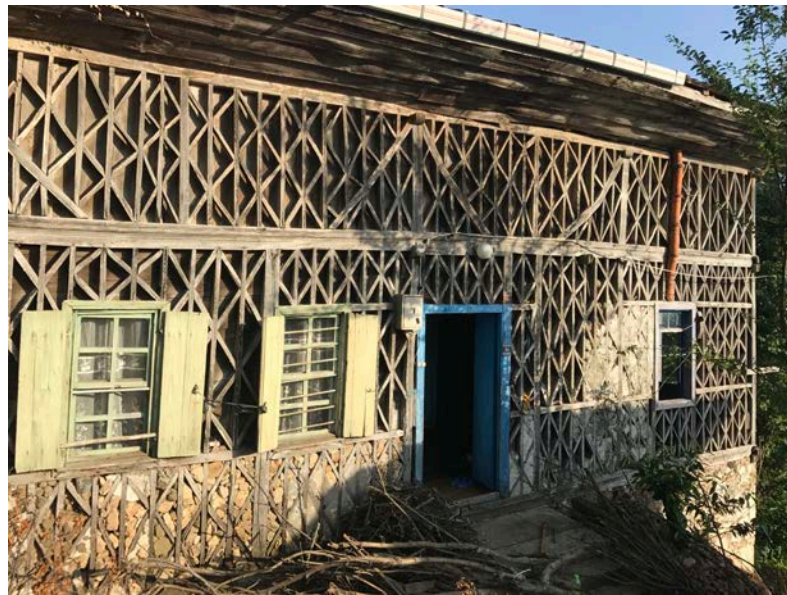
Şekil 4.53: Muska dolma duvar sistemiyle yapılan konut örnekleri.
