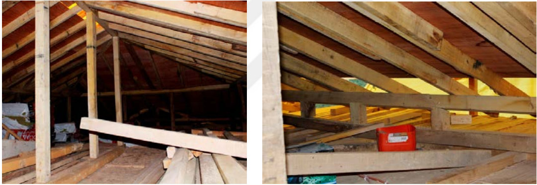
Şekil 5.53: Ana mahya ve yardımcı mahyaların konulması ve iskeletin oluşturulması.
