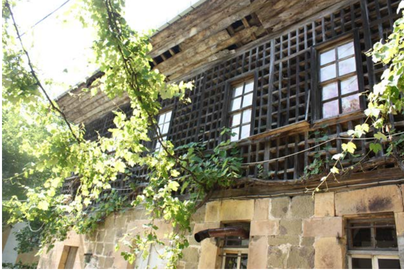
Şekil 4.114: Yapının göz dolma sistemle inşa edilen yan cephesi.
