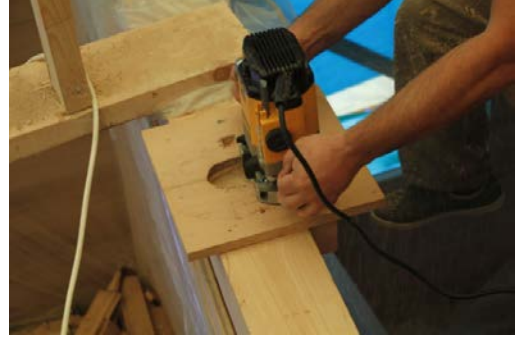
Şekil 5.37: Kalıbın kirişe matkapla sabitlenmesi ve el frezesiyle kanal açılması.
