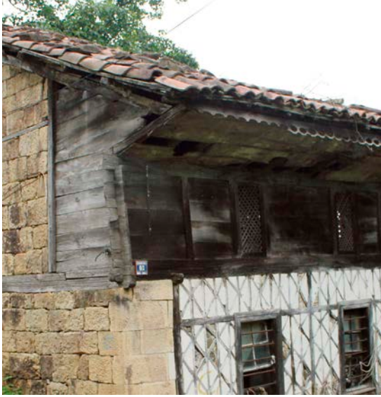
Şekil 4.59: Yığma sistem çatı katı duvarı ve ahşap örgü sistem pencereler.
