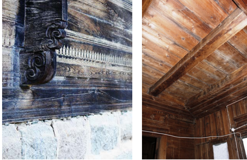
Şekil 3.49: Taş duvar üzerine yerleştirilen taban kirişler ve döşeme tahtaları.
