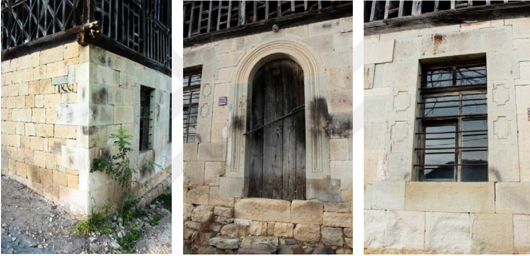
Şekil 4.97: Bodrum kat yan ve ön cephe taş duvarı, misafirhane kapı ve pencere detayları.
