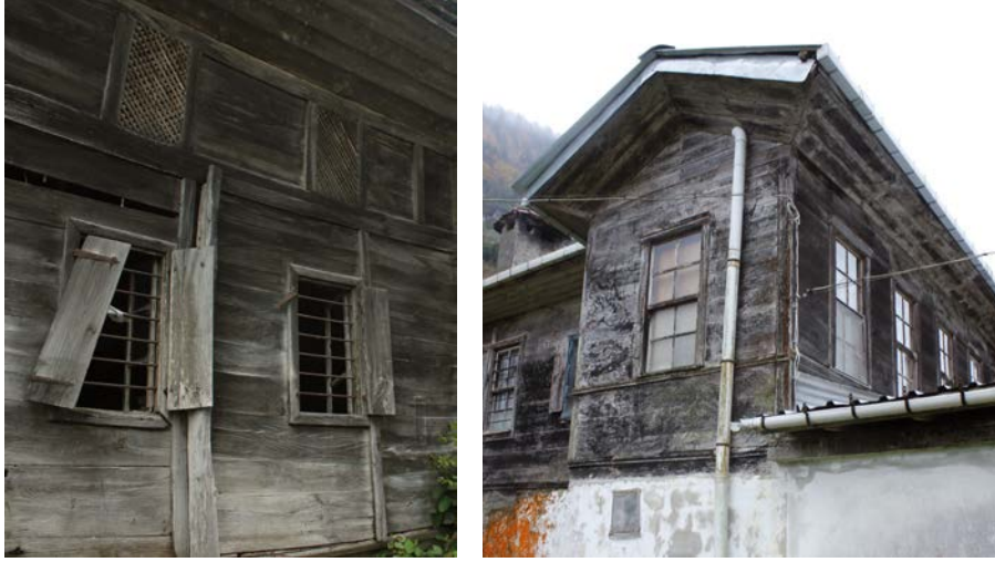
Şekil 3.39: Blok ahşap dolma cephe görünümü.
