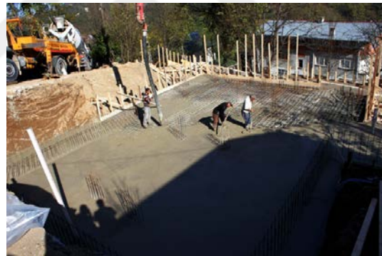
f. Radye temelin betonunun atılması
