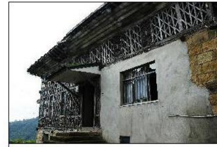
Briketle örülen aşena duvarı ve değiştirilen doğramalar
