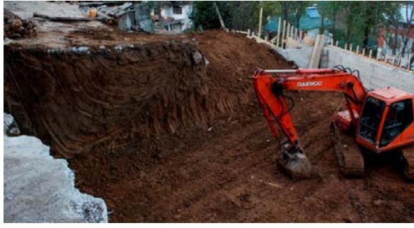
b. Hafriyat yapılması
