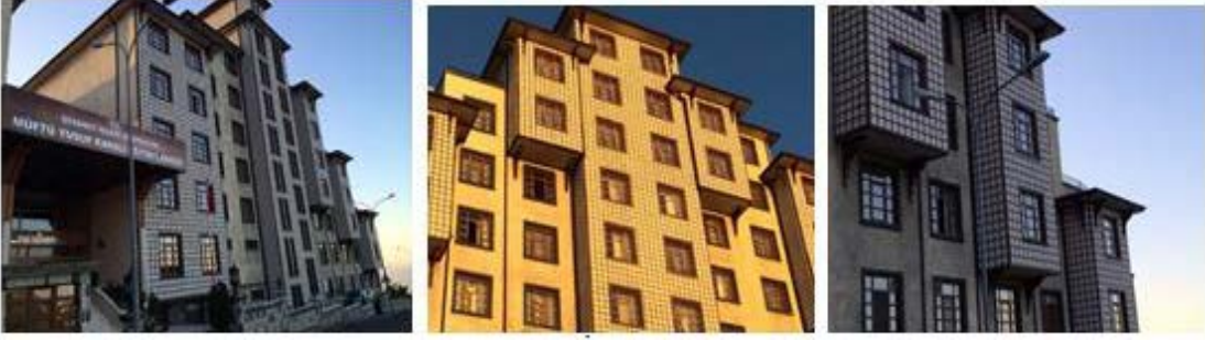
Şekil 3.62: Rize Diyanet İşleri Başkanlığı Eğitim Binasının ‘göz dolma’ formundaki cepheleri (Aydın, Alemdağ,2014).
