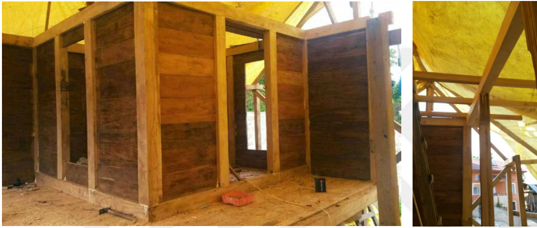
Şekil 5.83: Çardak başlarının monte edilmesi.
