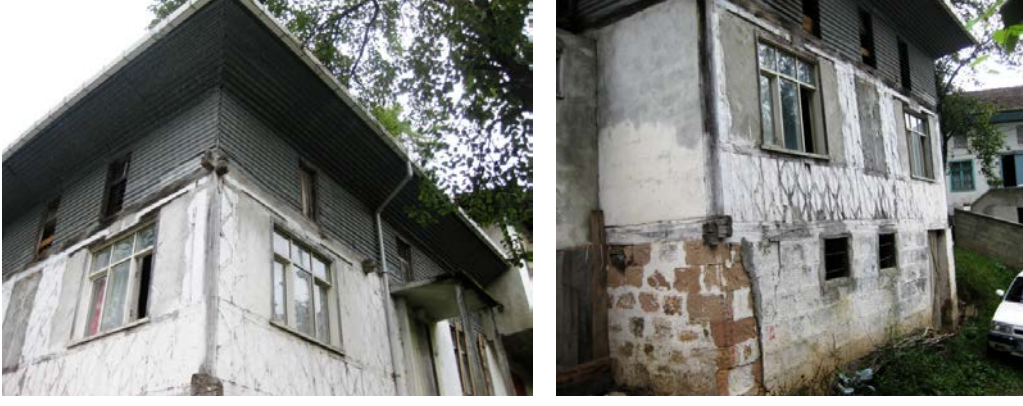
Şekil 5.5: Kaplanan saçaklar ve çatı katı duvarları, boyanan duvarlar.
