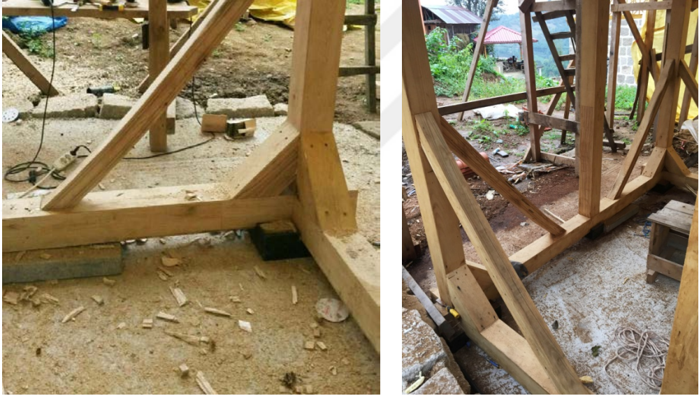
Şekil 5.80: Betonarme tabla, kauçuk takozlar, taban kirişleri, direkler ve köşe payandaları.
