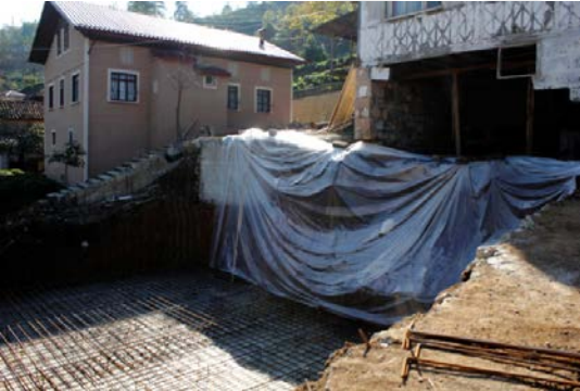
e. Radye temelin hasırlarının örülmesi
