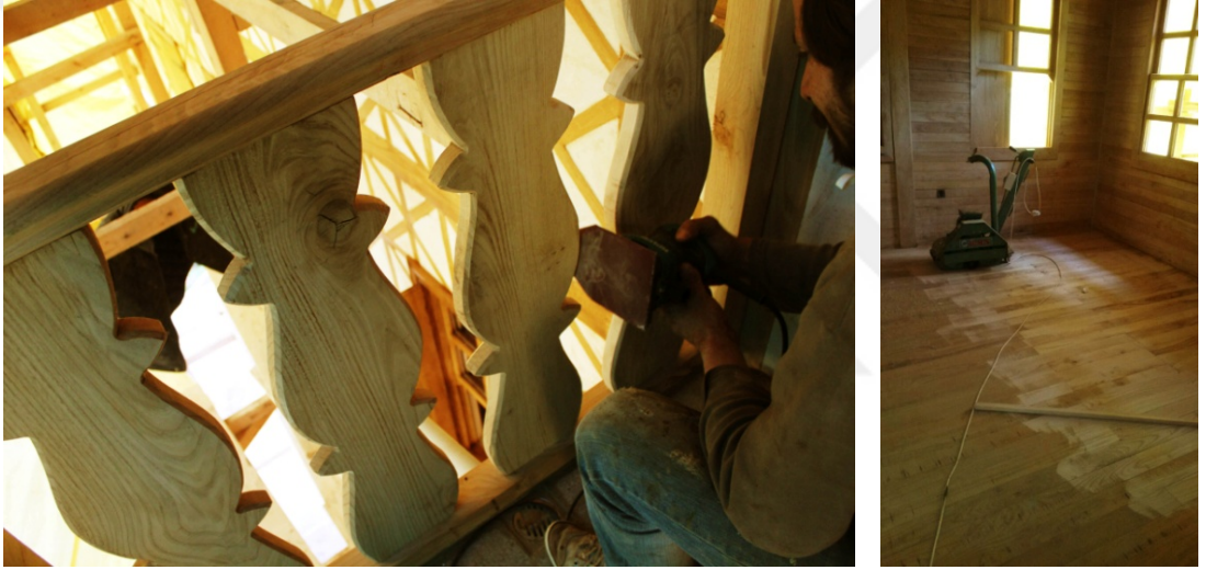
Şekil 5.65: Zımpara motoruyla zımpara işlemi yapılması, sistre makinesiyle zemin döşemelerinin zımparalanması.
