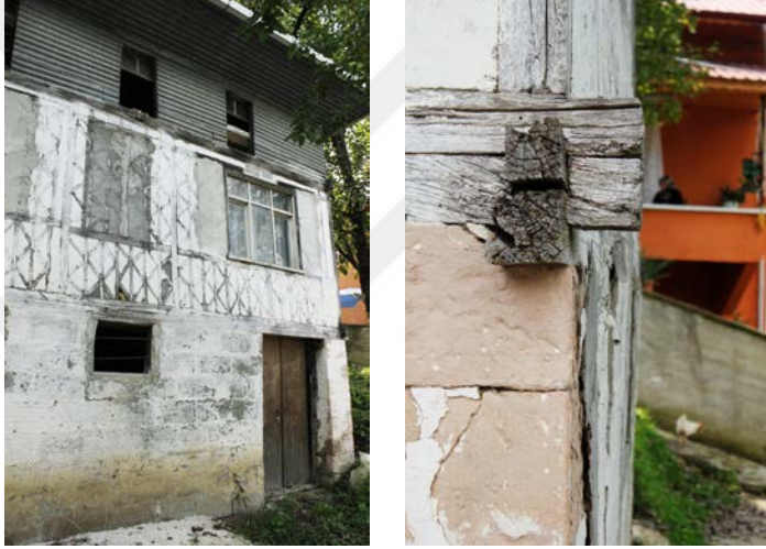
Şekil 5.6: Kapatılan pencere, doldurulan yüzeyler ve boyanan ahşap kirişler.
