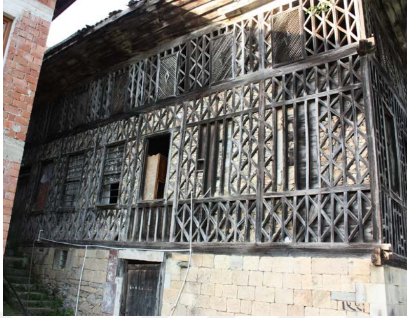
Şekil 4.94: Yapının sol yan cephe görünümü.
