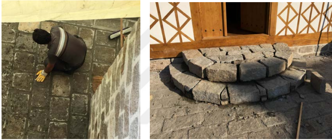
Şekil 5.76: Derzlerin fırçalanma işlemi ve su basman merdivenlerinin yapımı.
