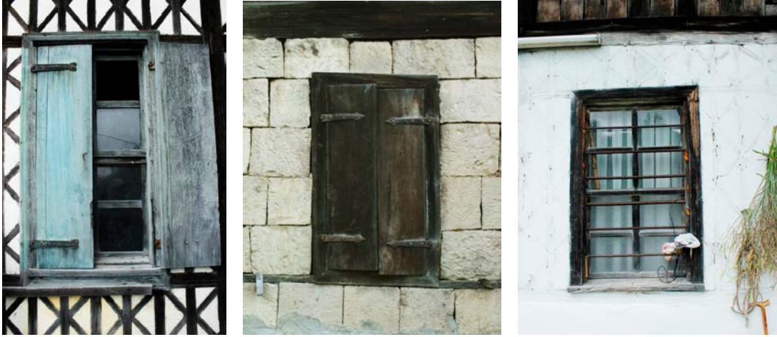
Şekil 4.66:Ahşap kepenk ve demir parmaklık örnekleri.
