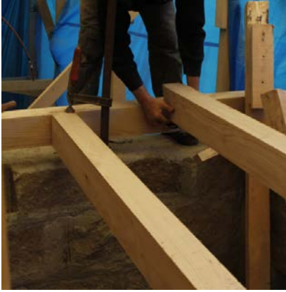
Şekil 5.42: Kirişlerin birbirine geçirilip tutkallanması ve işkenceyle preslenmesi.
