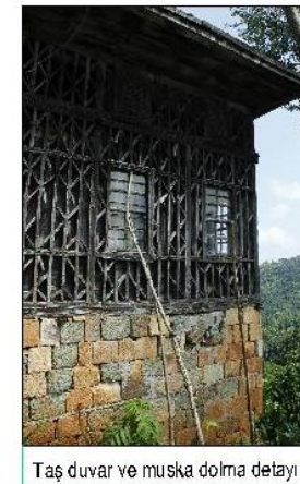
Taş duvar ve muska dolma detayı
