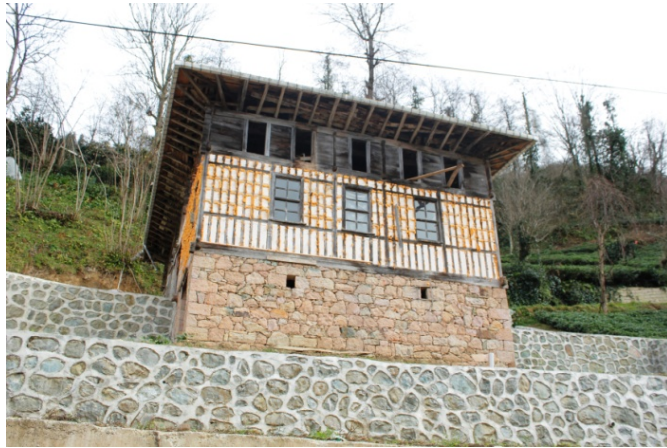
Şekil 4.120: Göz dolma duvarlara gaz betondan sikon köpükle dolgu yapılması.
