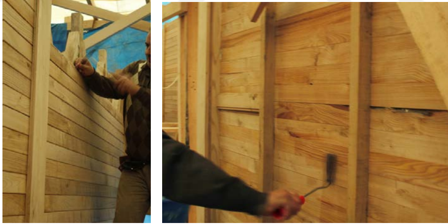
Şekil 5.45: Lambrilerin çakılması ve emprenye işlenmenin yapılması.
