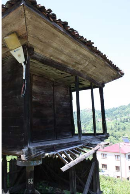
Şekil 4.78: Eğik kaplamalı ve eğik kaplamasız saçak biçimleri.
