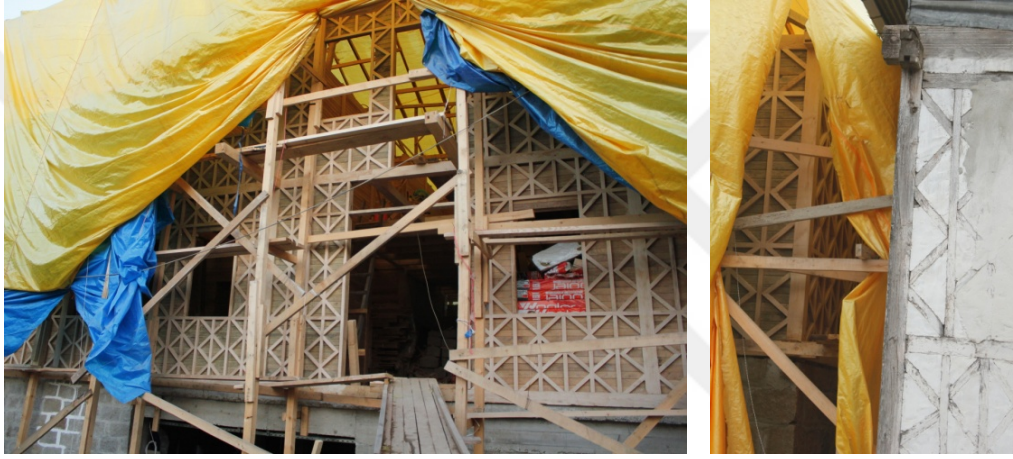
Şekil 5.50: Muska dolma sistem dış cephe örüntüsünün yapımı.
