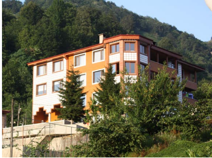
Şekil 4.124: Göz dolma sistemi cephede uygulayan yapı örneği.
