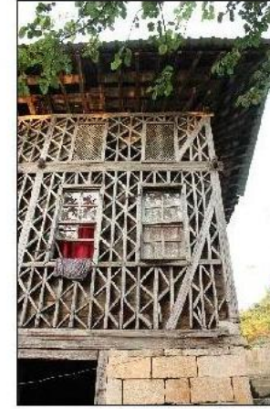
Glyotin pencere detayı Eğik kaplamasız saçak detayı
