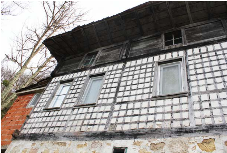
Şekil 4.56:Göz dolma duvar sistemiyle yapılan konut.
