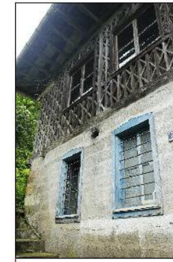
Briketle örülen duvar ve pencereler
