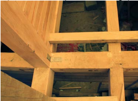
Şekil 5.43: Dikme ve kirişlerin birleşim detaylarında 'I' ve 'L' demir profil kullanılması.
