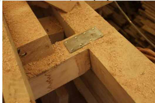
Şekil 5.43: Dikme ve kirişlerin birleşim detaylarında 'I' ve 'L' demir profil kullanılması.
