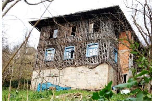
Şekil 4.27:Yapının yan cephesine eklenen briket ve tuğla duvarlı banyo birimleri.
