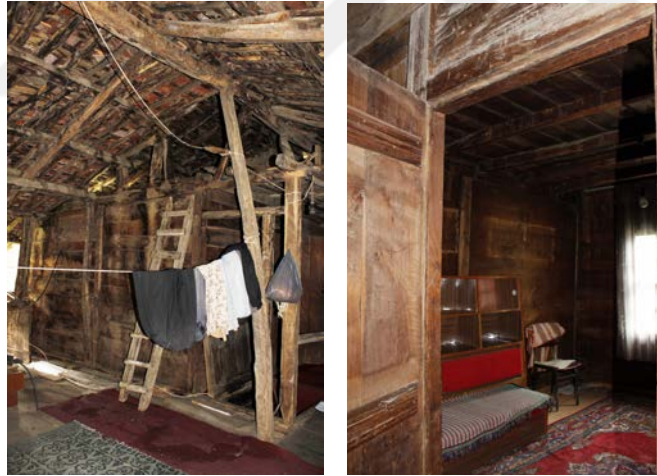
Şekil 4.38: Çatı katı misafir odası- Hanım Teyze Evi.
