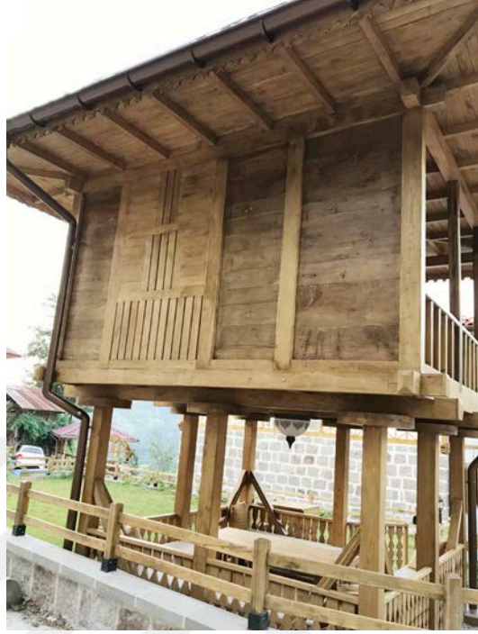
b. Arka Cephe Görünümü
