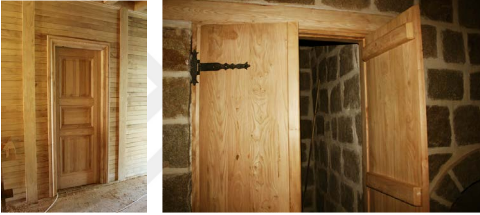
Şekil 5.63: Göbekli oda kapısı ve kuşaklı kiler kapıları.
