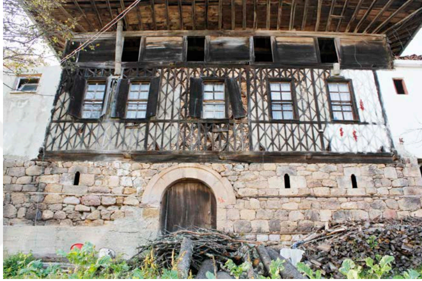
Şekil 3.30: Taş malzemedен ahır katı ve ahşap malzemedен yaşama bölümü.
