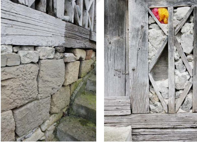
Şekil 4.46: Kırma taş dolgu malzemesi ve moloz taş duvar örgüsü.
