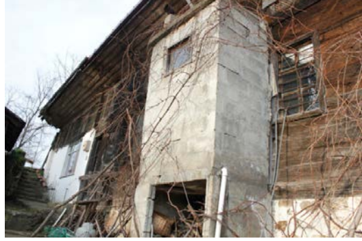
Şekil 4.118: Konutlara eklenen tuğla ve briket duvar ekler.
