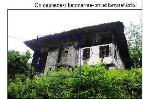
Ön cephedeki betonarme-briket banyo eklentisi
