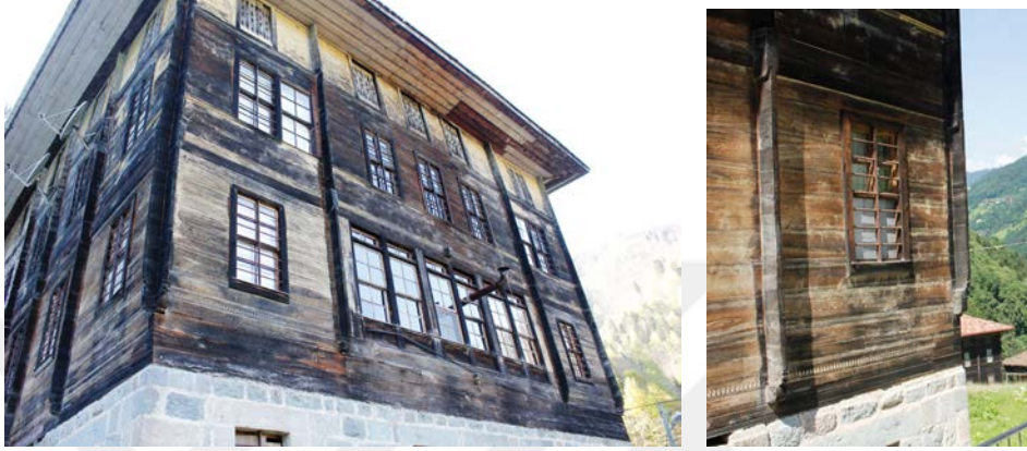
Şekil 3.32: Tahta yığma sistemde konut örneği.
