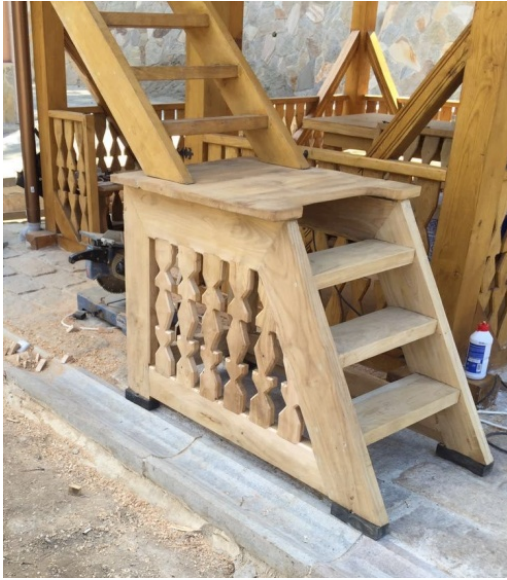
Şekil 5.88: Merdivenin hareketli ve sabit bölümleri.
