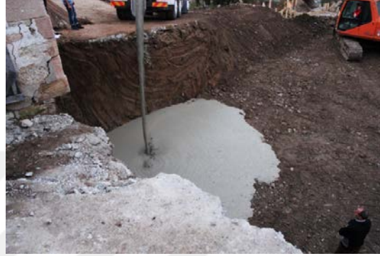
d. Grobeton dökülmesi
