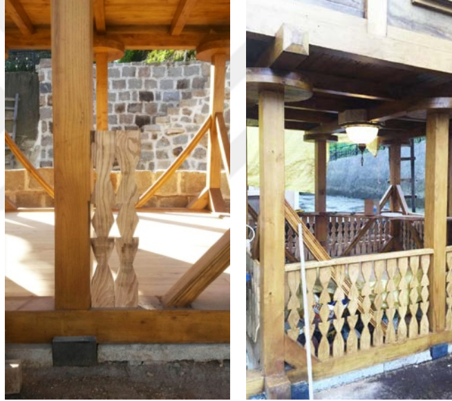
Şekil 5.89: Zemin çardak korkuluk detayı.
