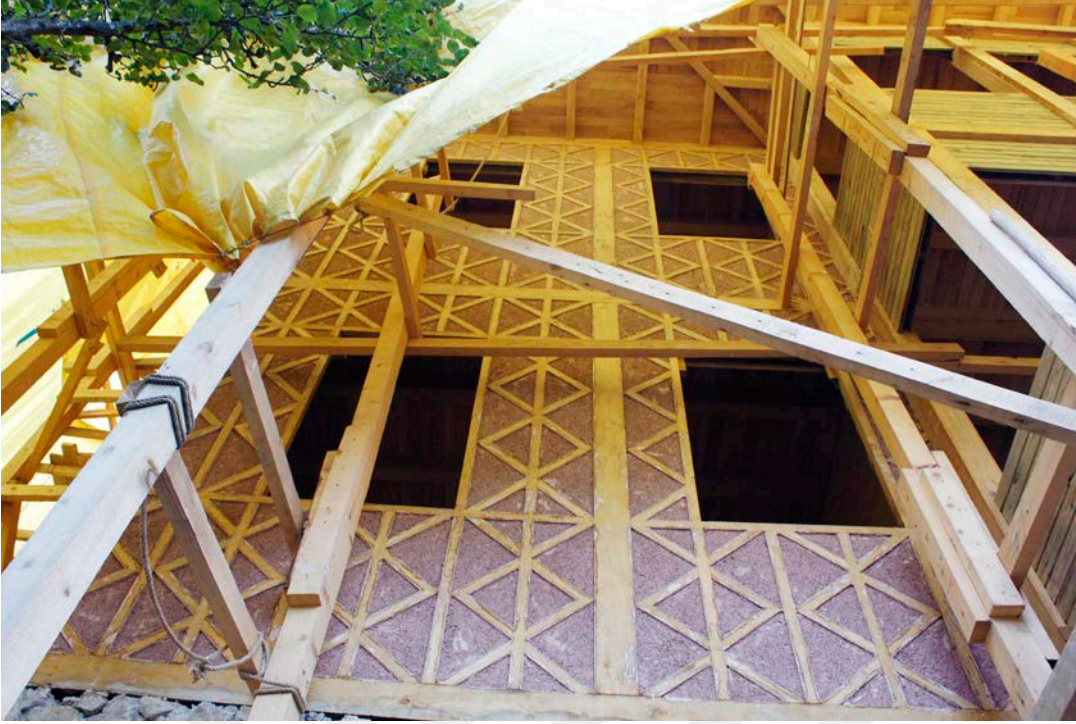
Şekil 5.66: Muska dolmaların arasına kaba sıva yapılması.
