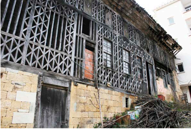
Şekil 4.92: Yapının ahır ve zemin kat giriş kapıları.
