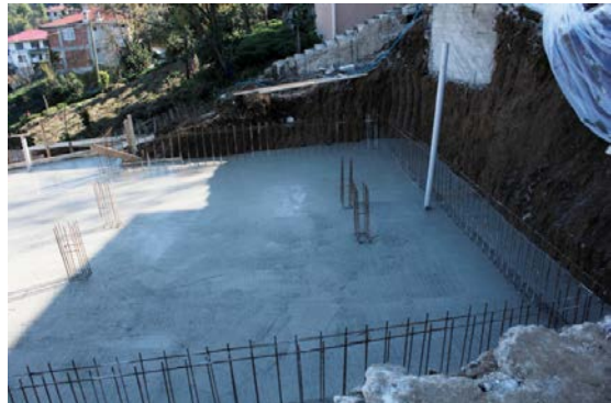
g. Radye temel ve hazır kolon ve duvarlar
