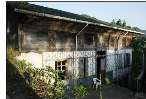
Yapının ana giriş cephesine ve çatısına yapılan saç kaplama
