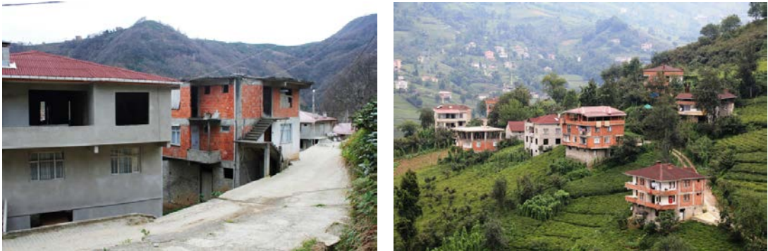
Şekil 4.122: Bitirilmeyen betonarme yapı örnekleri (URL-1).
