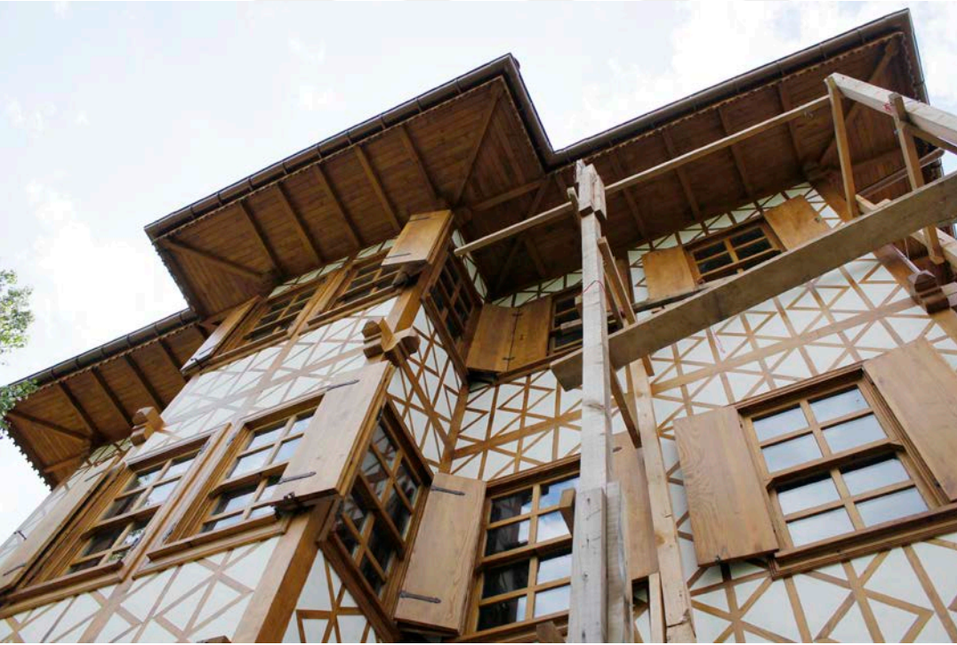
Şekil 5.67: Sıva, boya, vernik işlemlerinden sonra bitmiş cephe görünümü.
