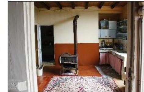
Ocağı kapatılan ve kiler yerine tezgah yapılan aşena
