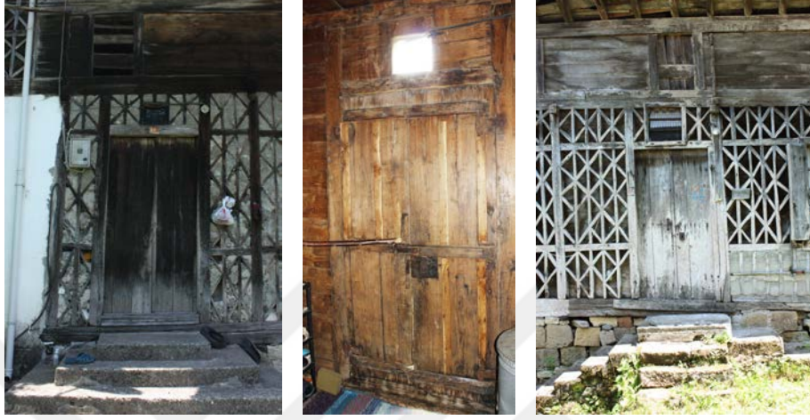
Şekil 4.67: Kuşaklı dış kapı ve kapı üstü ıřıklık.
