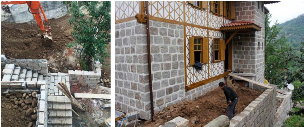
Şekil 5.74: Bodrum kata inen taş merdivenlerin yapımı ve toprak dolgu.
