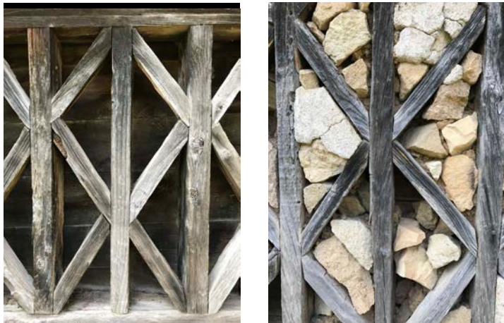
Şekil 4.51: Muska sistem detayı ve dolgu malzemesi
