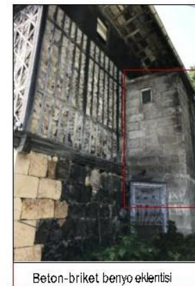
Beton-briket benyo eklentisi
