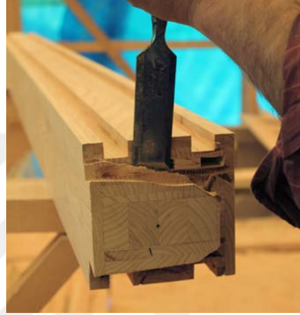
Şekil 5.38: Dişi ve erkek kırlangıç geçme detaylarının açılması.
