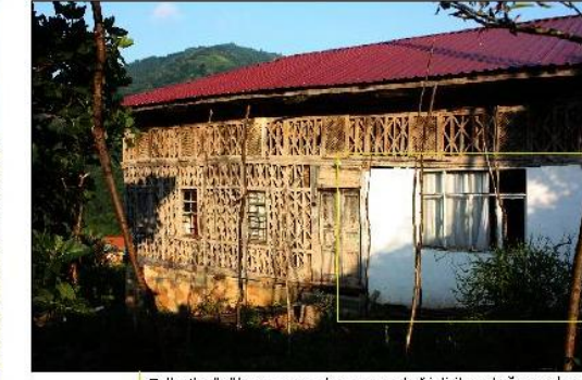
Briketle örülen aşena duvarı ve değiştirilen doğramalar
