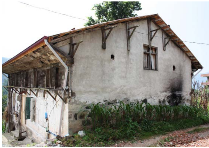
Şekil 4.60: Hoca'nın Evi ön ve arka cephe çatı görünümü.
