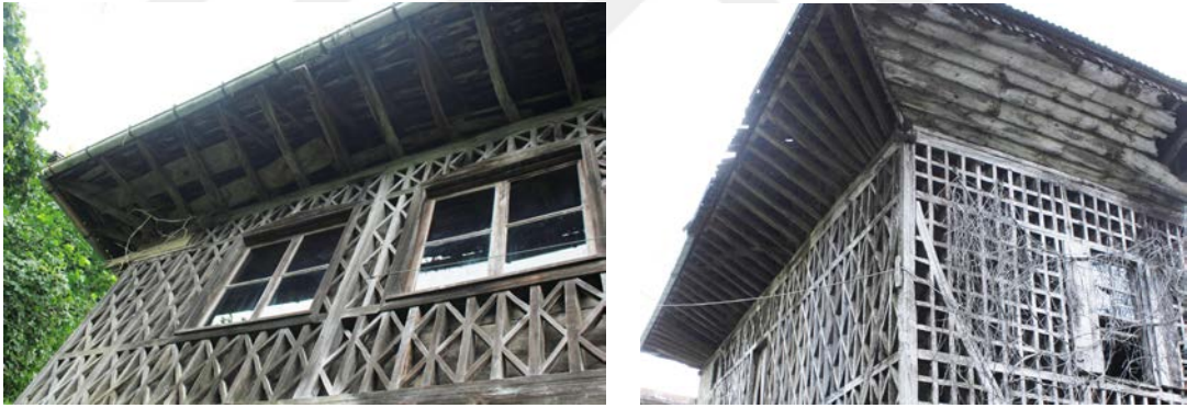
Şekil 4.63: Yatay kaplamasız saçaklı konut ve kaplama tahtaları dökülmüş konut örnekleri.
