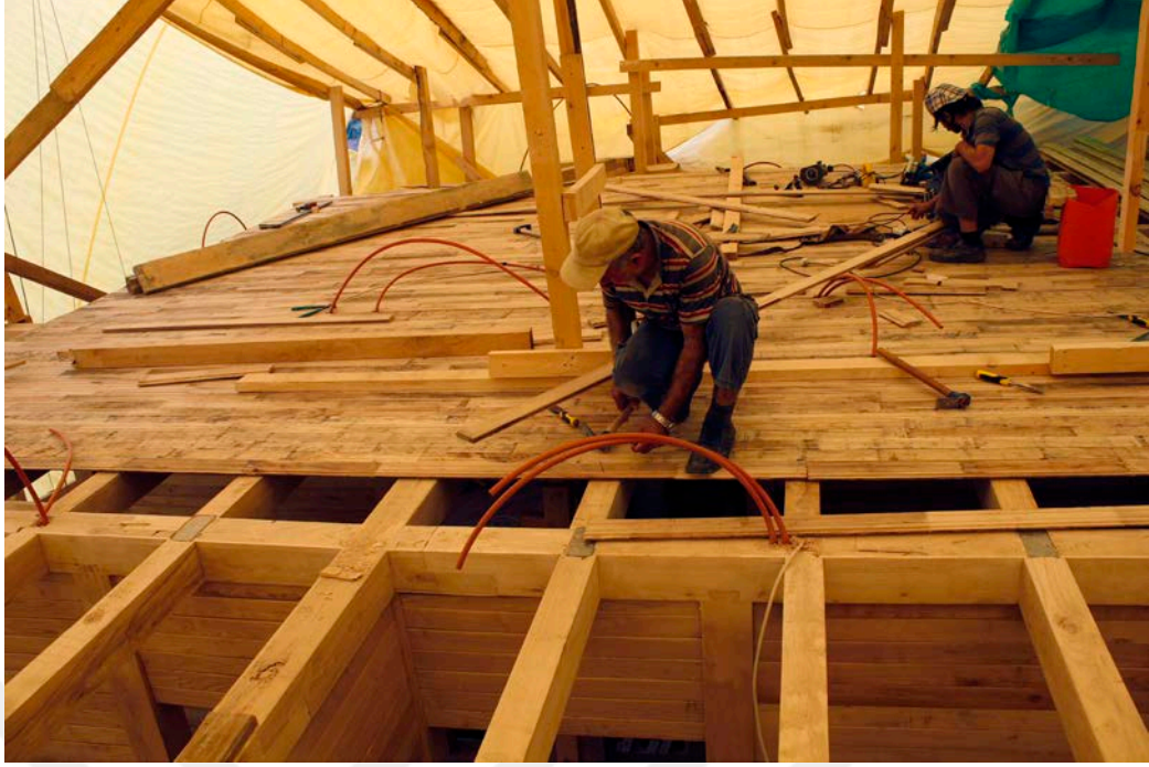
Şekil 5.52: Çatı zemin lambriyelerinin döşenmesi.
