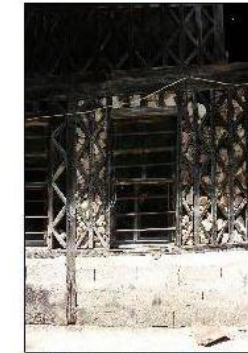
Giyotin pencere detayı
