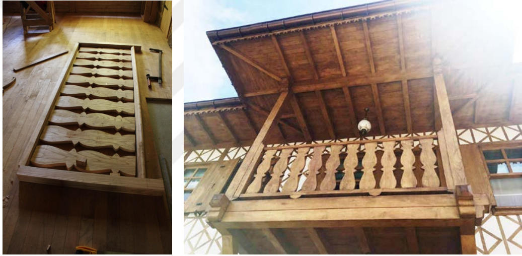
Şekil 5.61: Balkon korkuluğunun yerde imal edilip yerine takılması.
