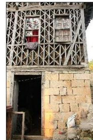
Ahırkatı taş duvar detayı
