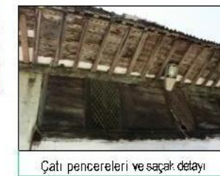
Çatı pencereleri ve saçak detayı
