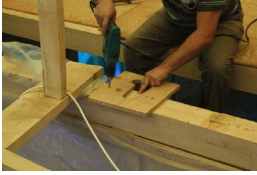
Şekil 5.37: Kalıbın kirişe matkapla sabitlenmesi ve el frezesiyle kanal açılması.
