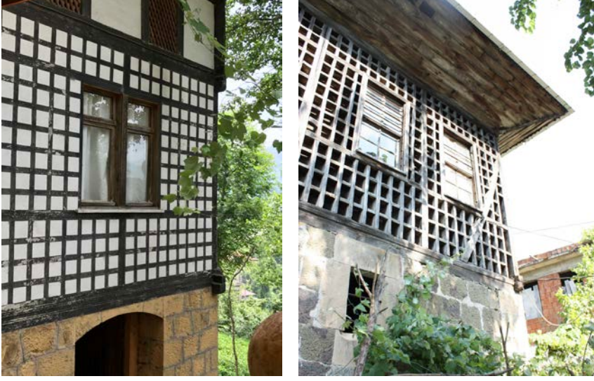
Şekil 4.54:Göz dolma duvar sistemi.
