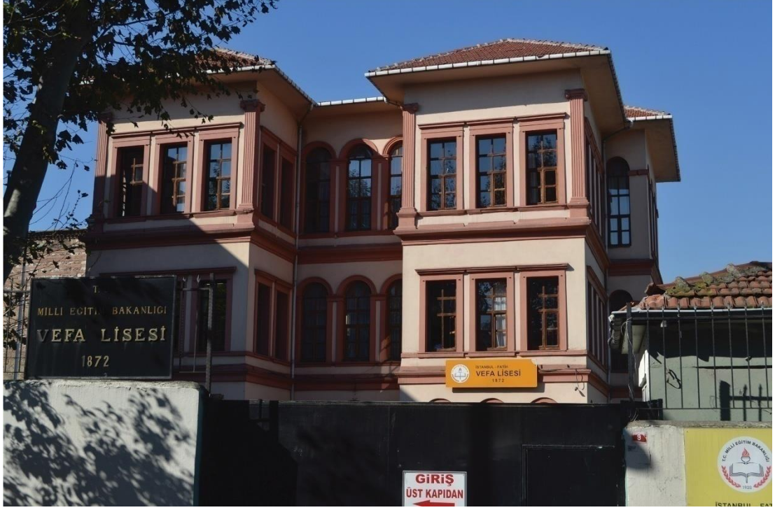
Şekil 32 : Vefa Lisesi güneydoğu cephesi
