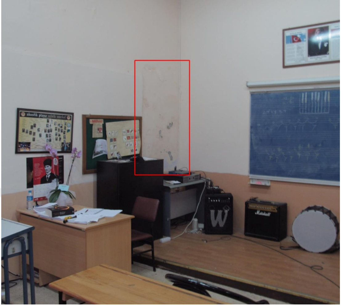
Şekil 47 : Müzik odası nem altındaki duvardan bir kesit
