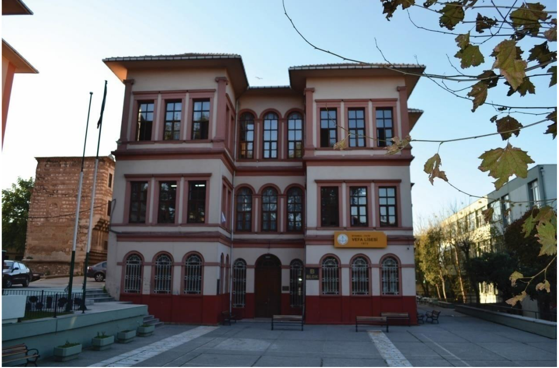
Şekil 31 : Vefa Lisesi güneydoğu cephesi
