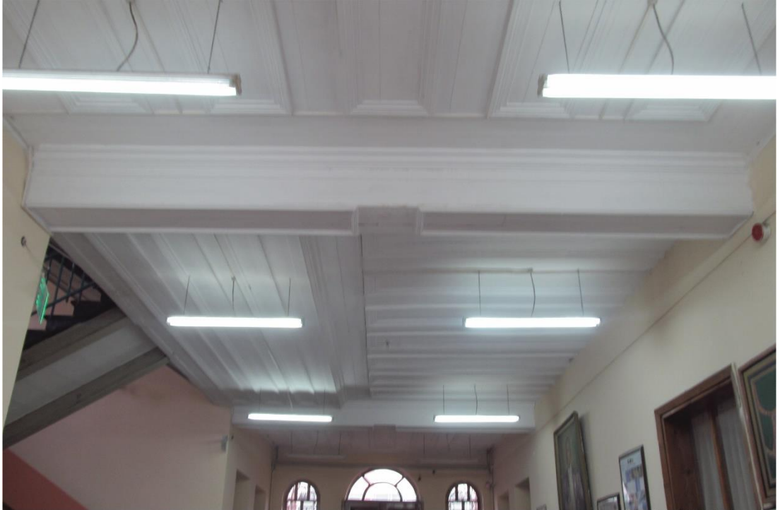
Şekil 45 : Zemin kat tavanı
