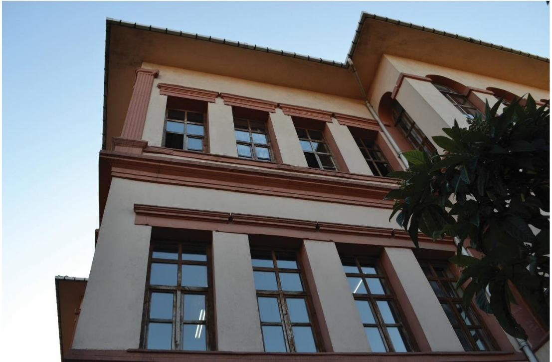
Şekil 34: Vefa Lisesi kuzeydoğu cephesi
