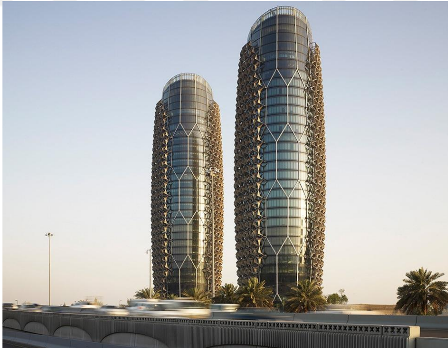
Resim 4.7: Al Bahar Kuleleri genel görünüm (Url-24).
