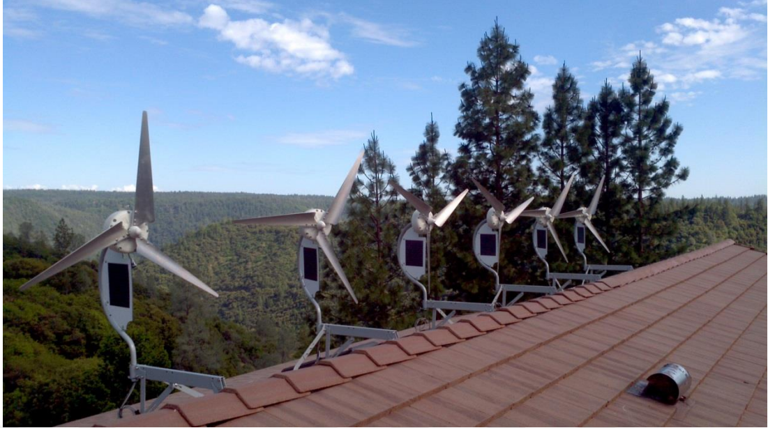
Resim 3.4: Bina-monte rüzgar türbini örneği (Url-12).
