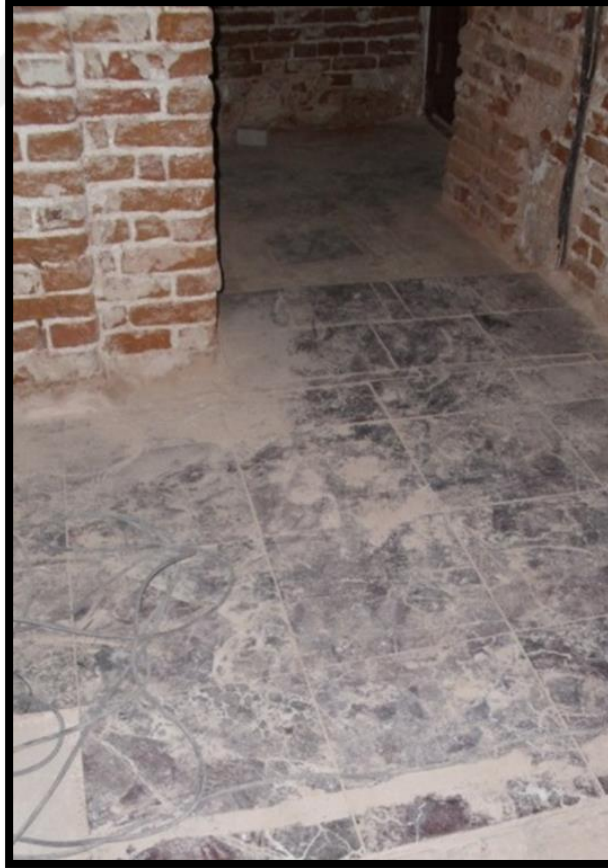
Şekil 3.23: Z01 Zemin kat son cemaat alanı giriş kapısı önü döşemesi.
