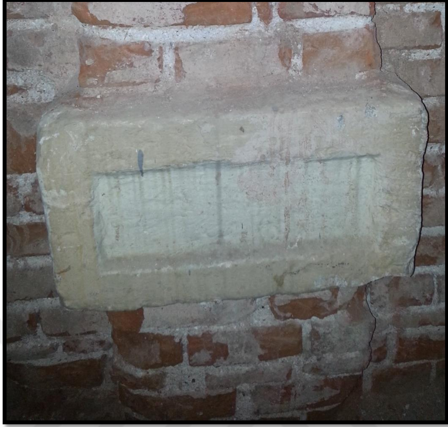
Şekil 3.90: Dikdörtgen çerçeve de oluşan renk değişimleri.
