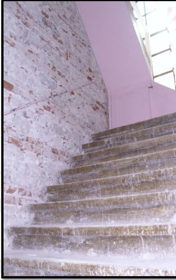
Şekil 3.33: Birinci Kata (N01 Harim katı) çıkan merdiven.
