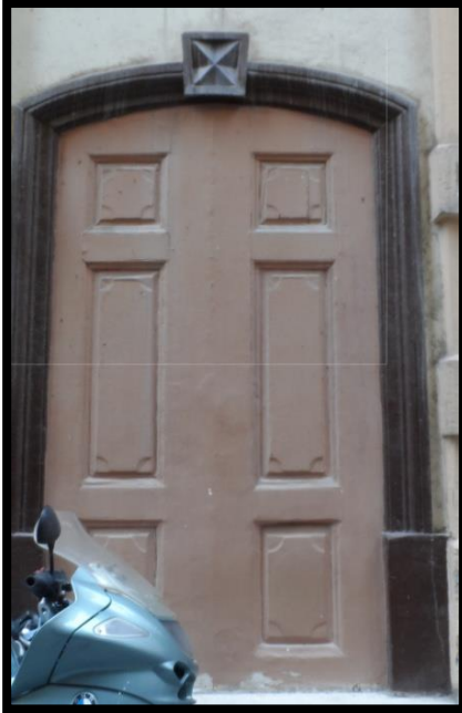
Şekil 3.38: Güney cephesi kullanılmayan özgün ahşap kapı, DV2 K2 numaralı kapı dış görünüş
