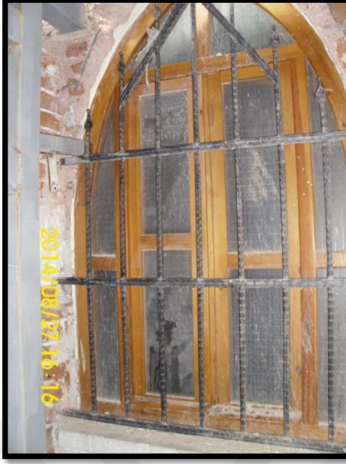
Şekil 3.45: Zemin kat DV1-P1 kodlu sivri kemerli pencere dış görünüş.
