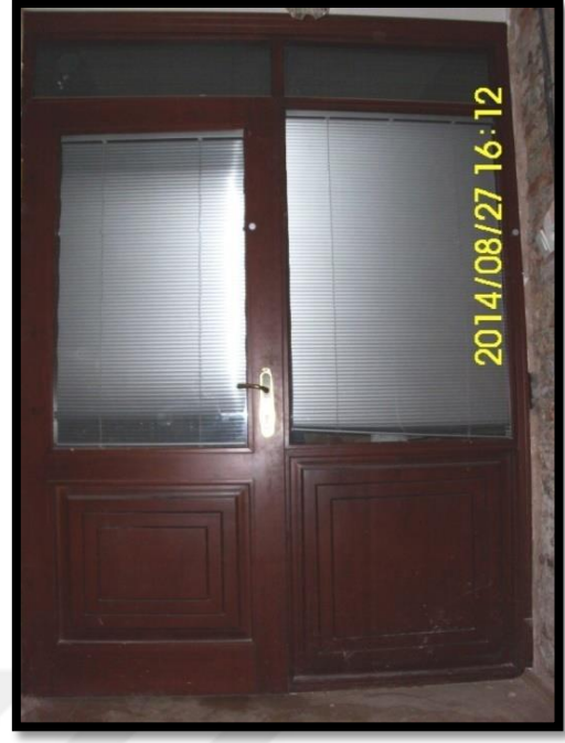
Şekil 3.41: Zemin kat giriş holü görevli yeri kapısı K3 numaralı kapı iç görünüş.
