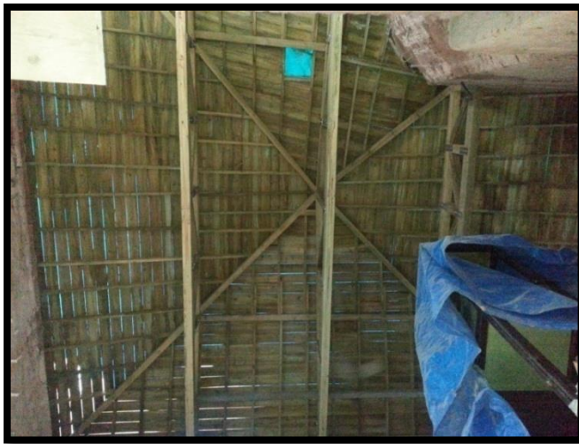
Şekil 3.27: Ahşap kırma çatı.
