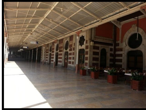
Şekil 4.20: Sirkeci Garı güney cephe at nalı kemerli silme ile yapılmış pencereleri.
