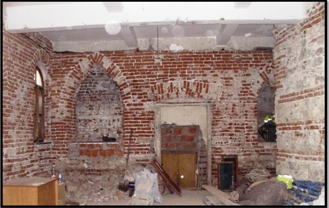
Şekil 3.9: Zemin kat son cemaat alanı batı duvarı.
