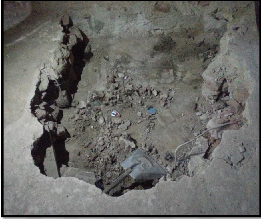
Şekil 3.24: Araştırma kazısı sonucu ortaya çıkan özgün döşeme.
