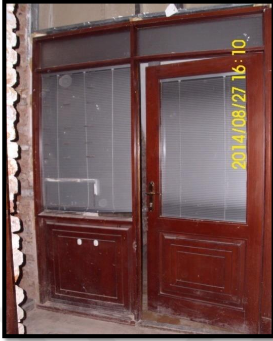
Şekil 3.40: Zemin kat giriş holü görevli yeri kapısı K3 numaralı kapı dış görünüş
