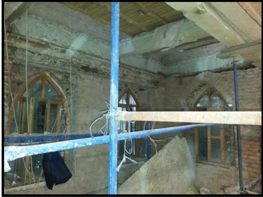
Şekil 3.25: N01 Birinci kat döşemesi döşeme kirişleri.(08/2014)
