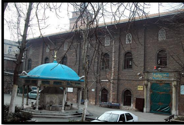
Şekil 4.24: Arap Camii avlusu ve avlu içerisinde sekiz sütunlu şadırvan.
