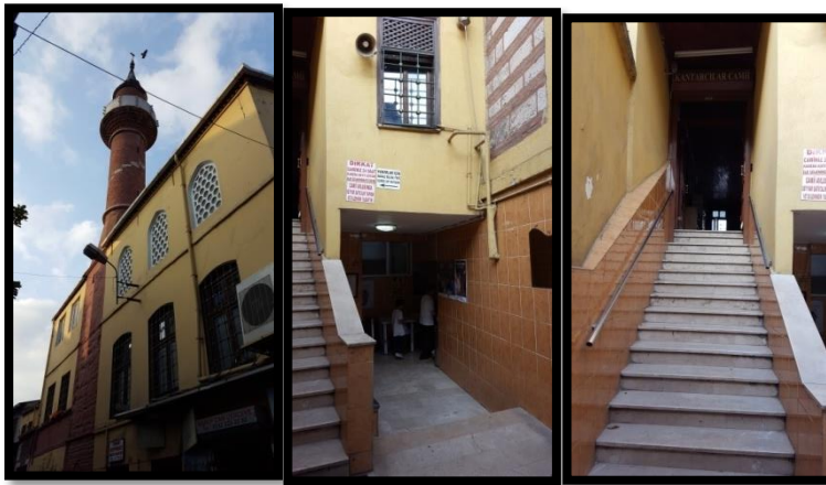
Şekil 4.16: Batı cephesindeki dükkân, daraltılmış olan son cemaat alanı ve mescit katına çıkış merdivenleri.
