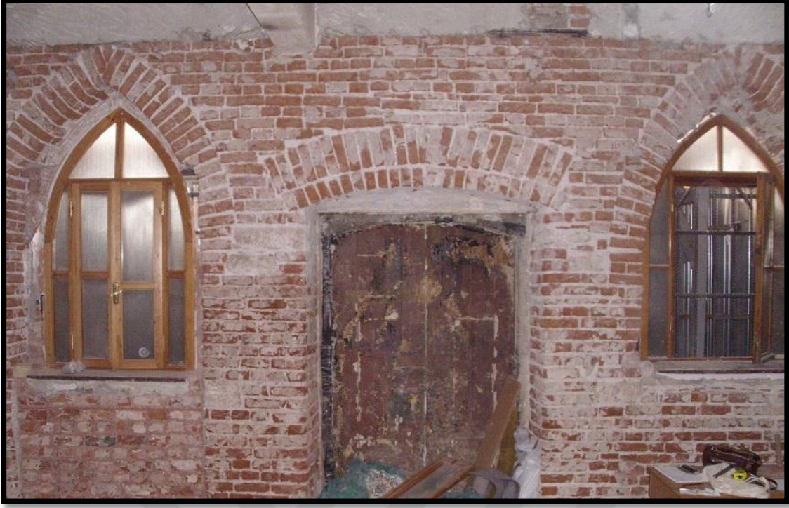
Şekil 3.8: Zemin kat son cemaat alanı güney duvarı.
