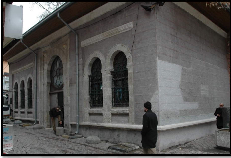
Şekil 4.26: Arap Camii'nin kuzey cephesinde bulunan yapı.
