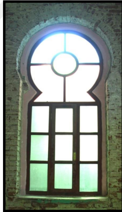
Şekil 3.51: Birinci kat DV1-P2 kodlu at nalı kemerli ahşap pencere iç görünüş.
