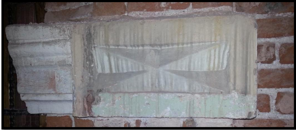
Şekil 3.91: Dikdörtgen çerçeve de oluşan renk değişimleri.
