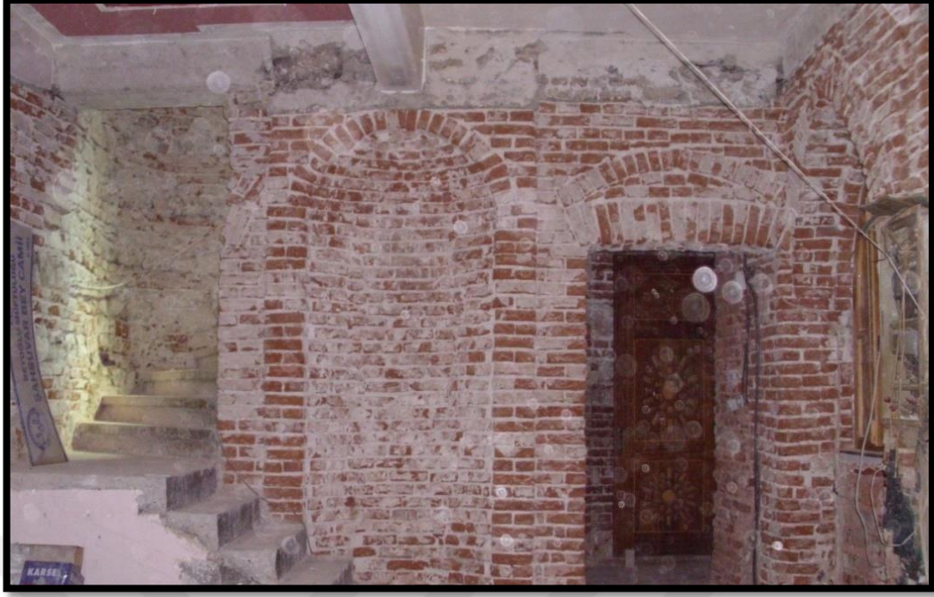
Şekil 3.6: Zemin kat son cemaat alanı kuzey duvarı giriş holü ve merdivenler.
