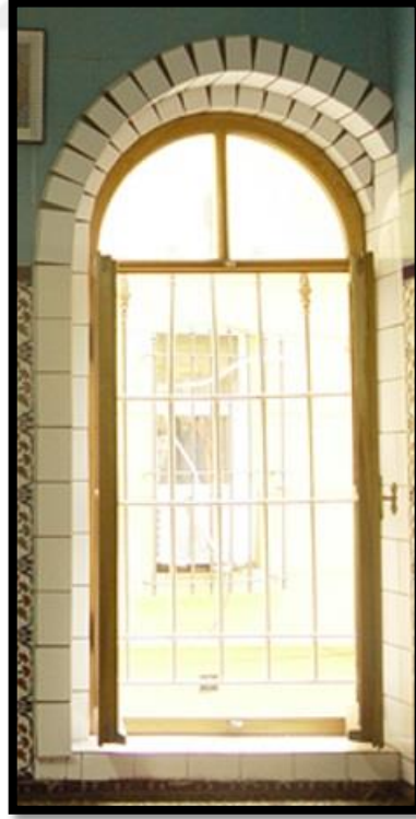
Şekil 3.47: Zemin kat DV2-P2 kodlu yuvarlak kemerli ahşap pencere.
