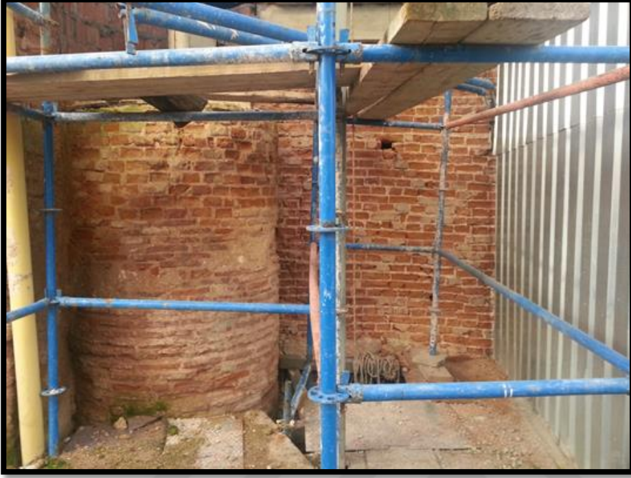
Şekil 3.65: Batı Minare duvarı.
