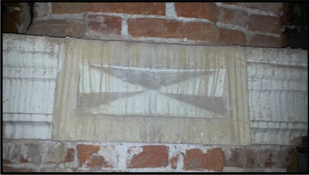
Şekil 3.89: Dikdörtgen çerçeve de oluşan renk değişimleri.
