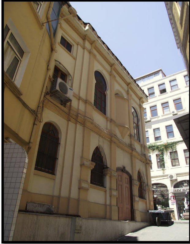
Şekil 3.3: Şahsuvar Bey Camii Güney Cephesi.
