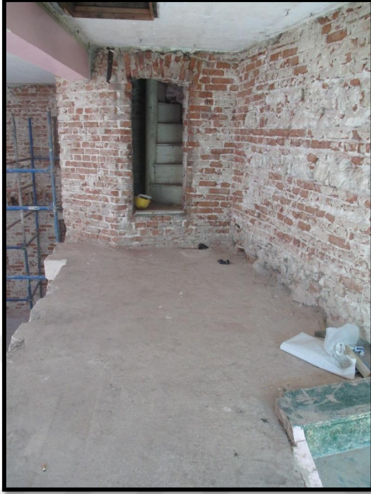
Şekil 3.26: Mahfil katı döşemesi.
