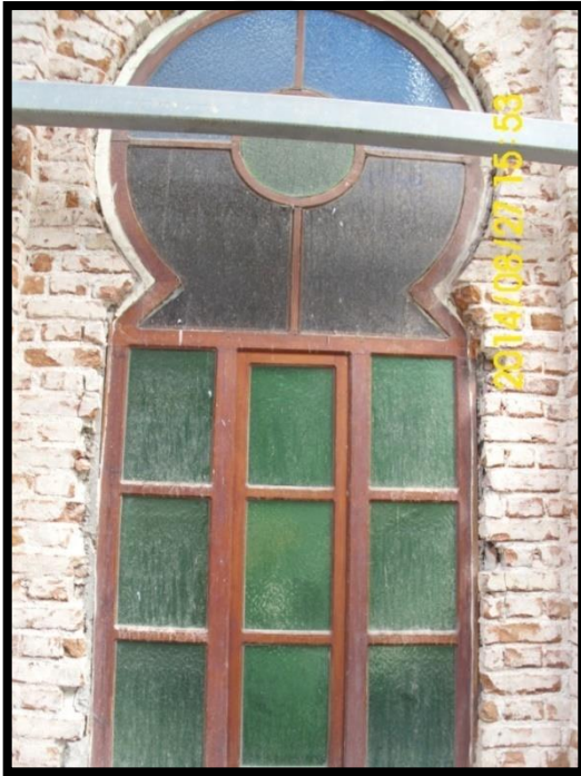
Şekil 3.50: Birinci kat DV1-P2 kodlu at nalı kemerli ahşap pencere dış görünüş.
