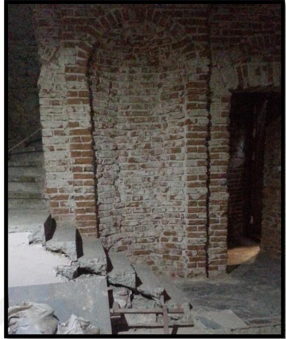
Şekil 3.57: Seramikler söküldükten sonra raspa sonrası görünüşü.(08/2014)
