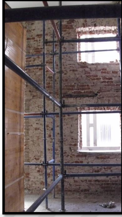
Şekil 3.52: Birinci kat DV2-P3 kodlu muhdes boşluk.
