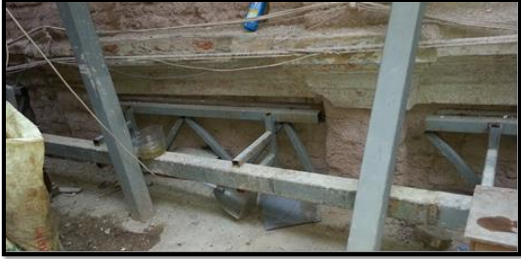
Şekil 3.86: Camii'nin güney cephesinde bulunan kat silmesinde oluşan kütle kayıpları ve renk değişimleri.
