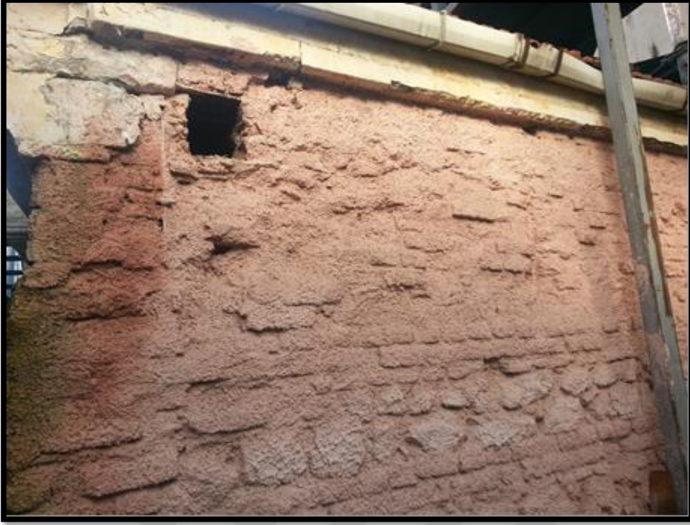
Şekil 3.75: Kuzey cephesinde havalandırma amacıyla açılmış havalandırma penceresi.
