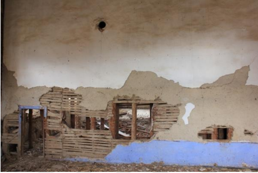
Şekil 4.14 Ahşap Karkas Sistemi(Çalbay,2017)
