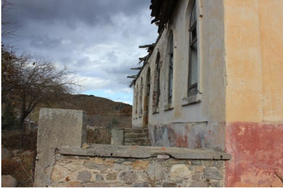
Şekil 4.37 Güneybatı Cephesi (Çalbay,2017)
