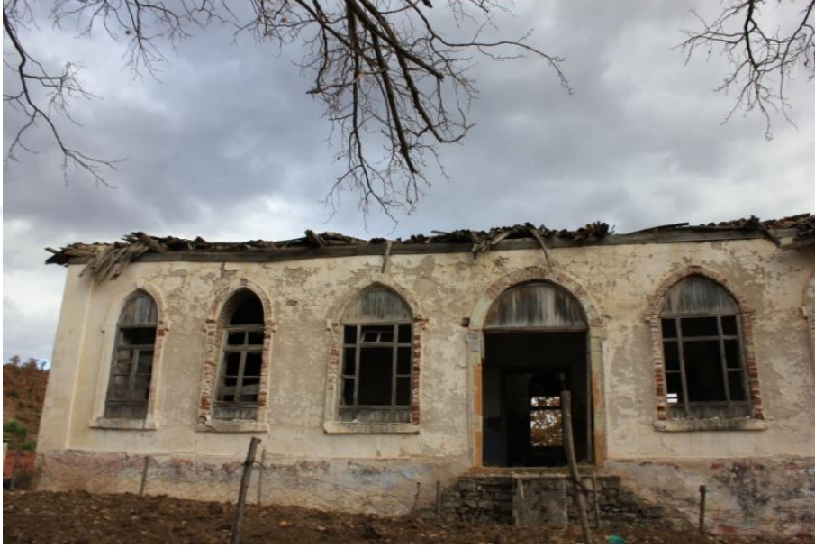
Şekil 4.25 Kuzeybatı cephesi (Çalbay,2017)
