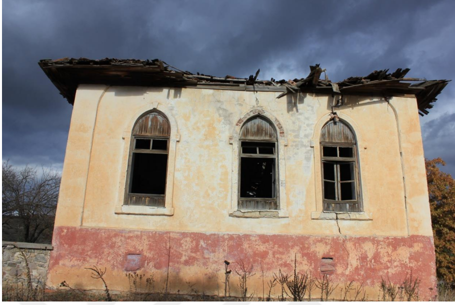
Şekil 4.36 Güneybatı Cephesi (Çalbay,2017)
