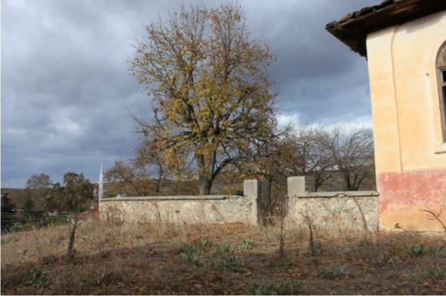
Şekil 4.6 Okul Bahçesi Duvarı (Çalbay,2017)
