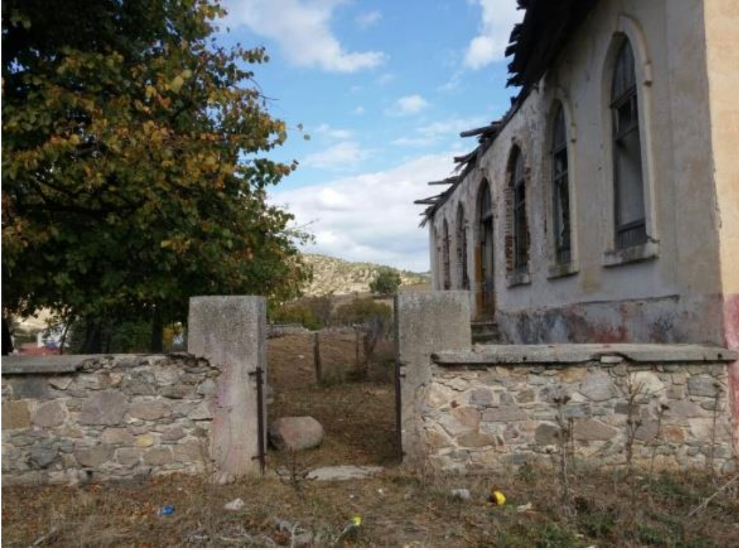
Şekil 4.38 Bahçe duvarı (Çalbay,2017)
