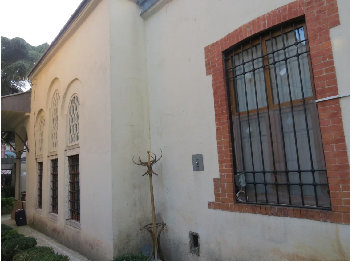
Resim 100: Doğu Cephesi Görünüşü(2016)
