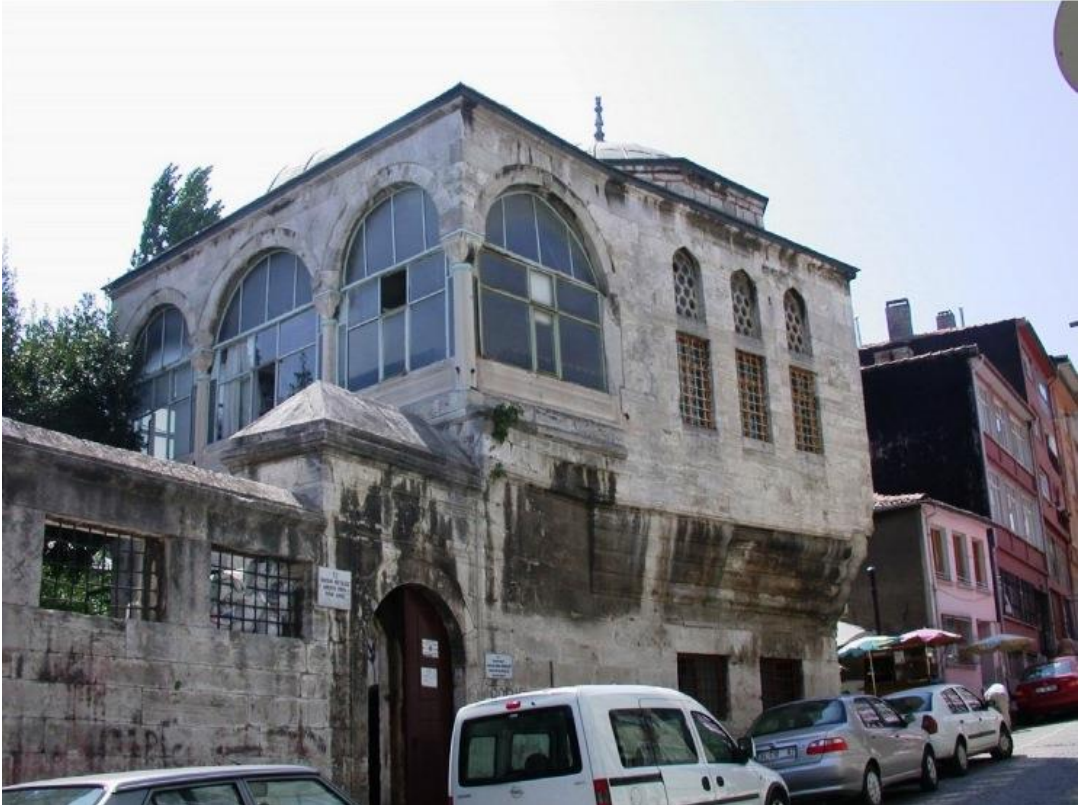
Resim 36:Ahmediye Ktphanesi Kuzey cephesi grnř
