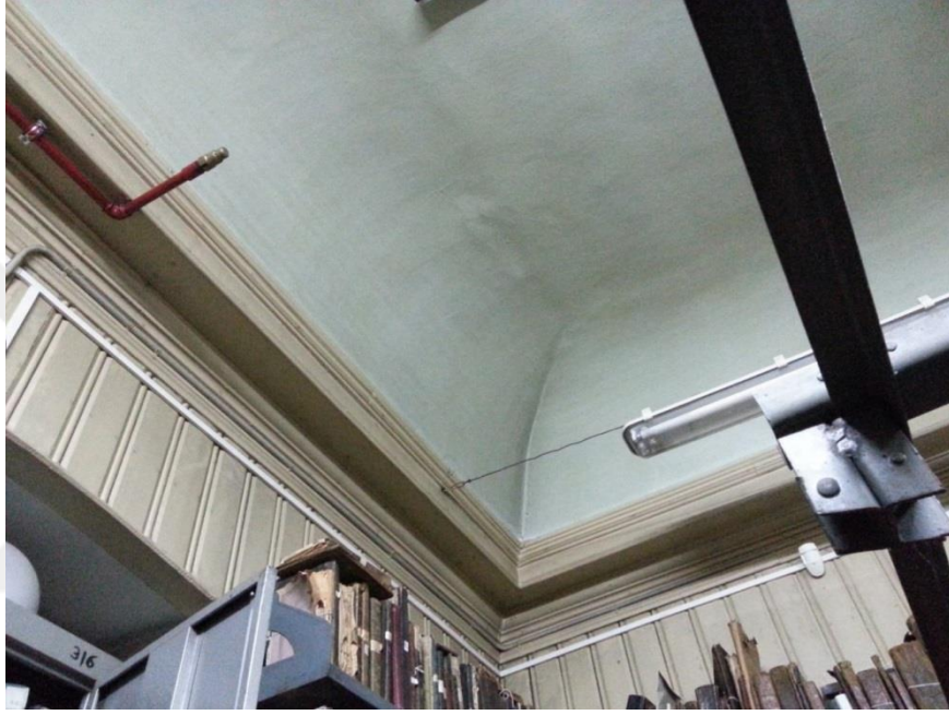
Resim 84: Depo tonoz bağlantı detayı(2016)
