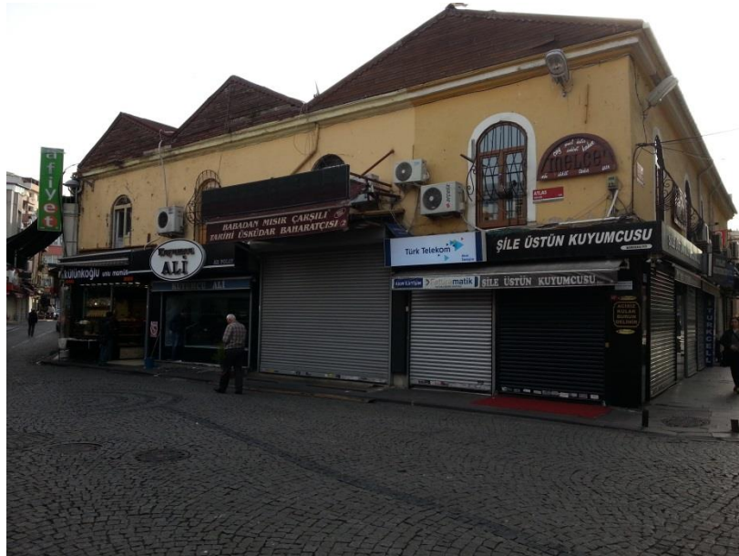
Resim 45: 12 Parselde Bulunan Hanın Güncel Durumu (2016)
