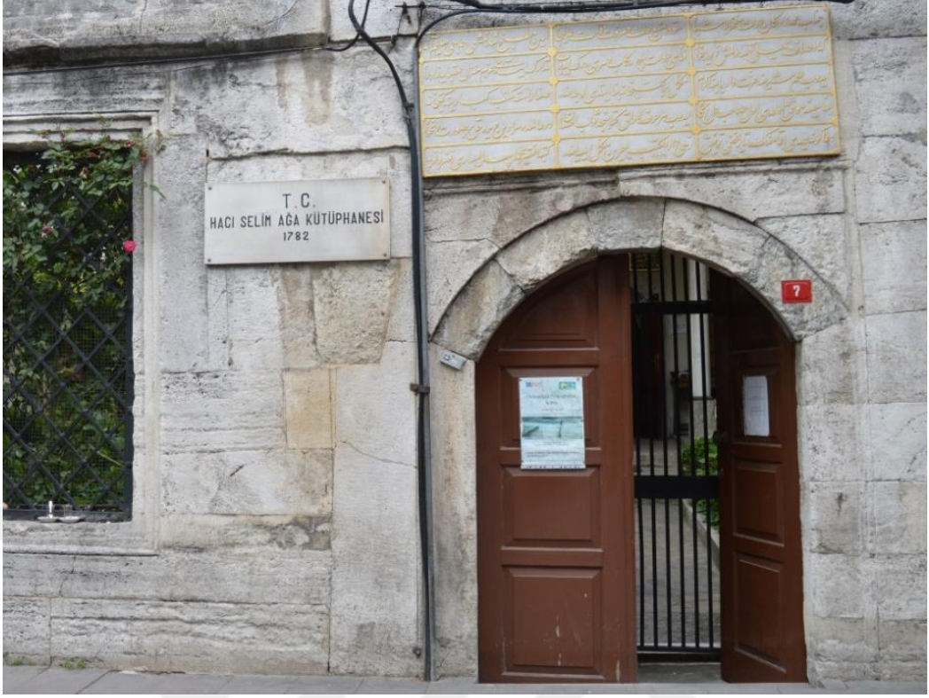
Resim 60: Bahçe giriş kapısı (2016)
