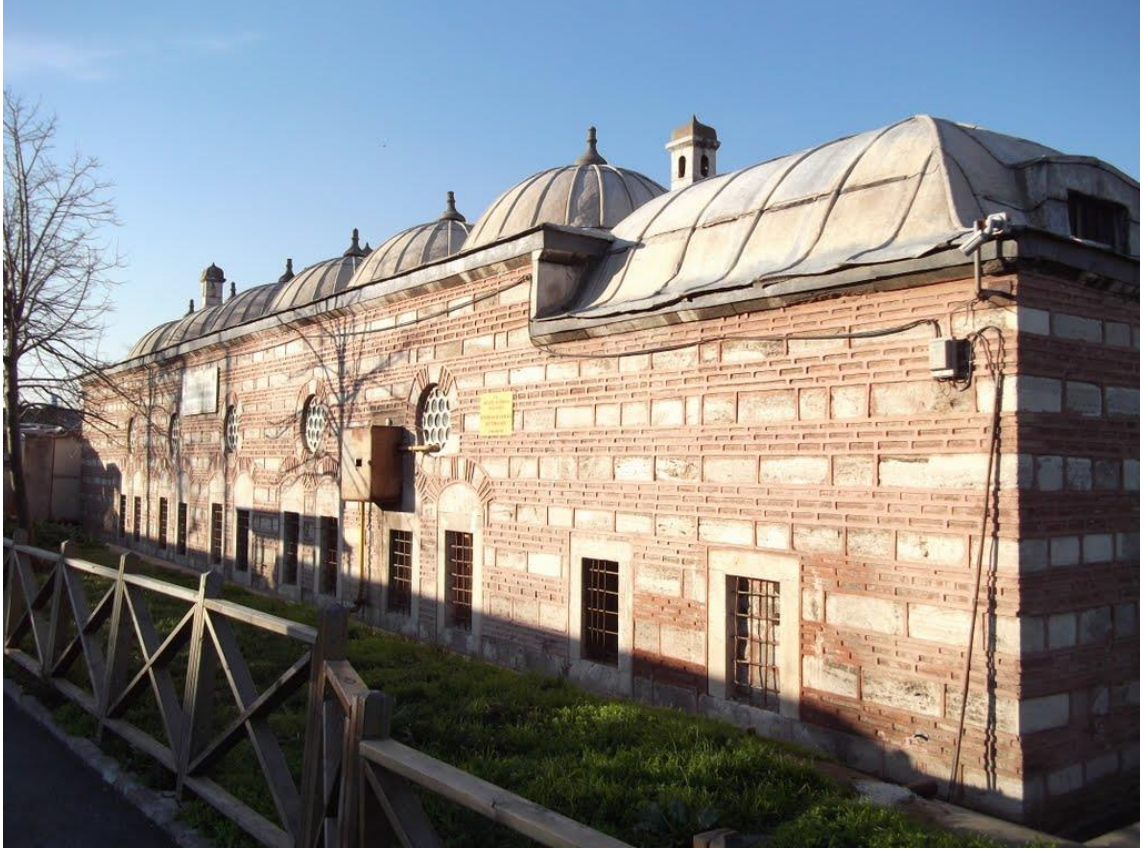
Resim 19: Şemsi Paşa kütüphanesi Doğu Cephesi
