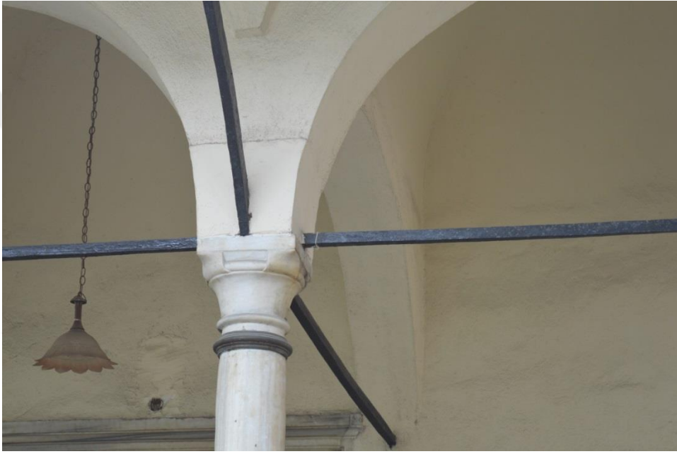
Resim 72: Revak Sütun Gergi Bilezik Detayı(2016)
