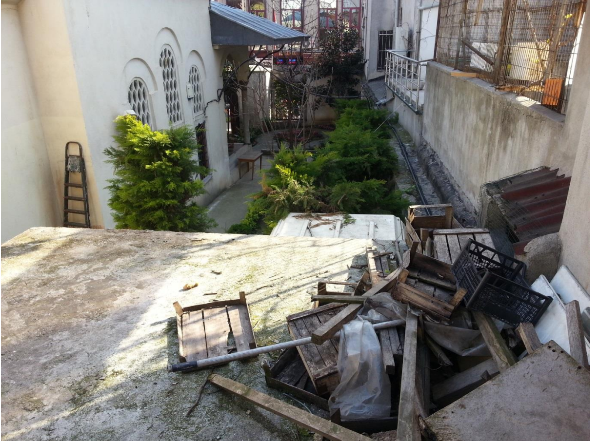
Resim 97: Muhtes yapı üst görünüş(2016)
