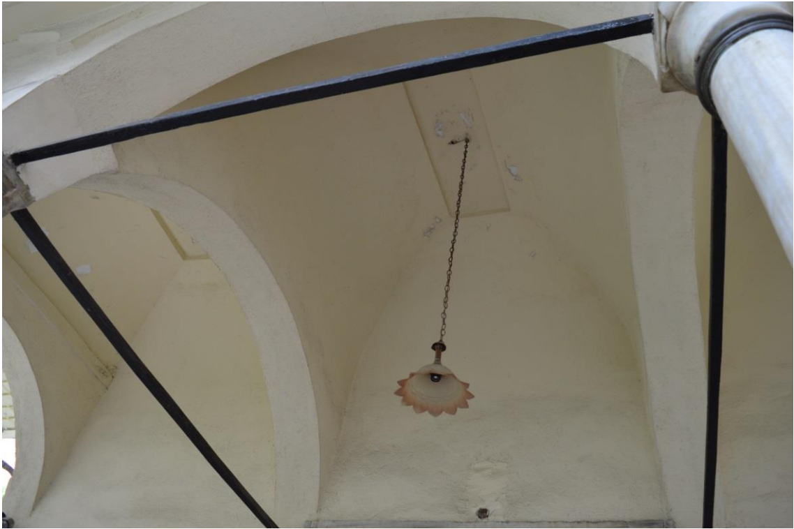
Resim 71: Revaklı Giriş Avlu Tonoz Detayı(2016)
