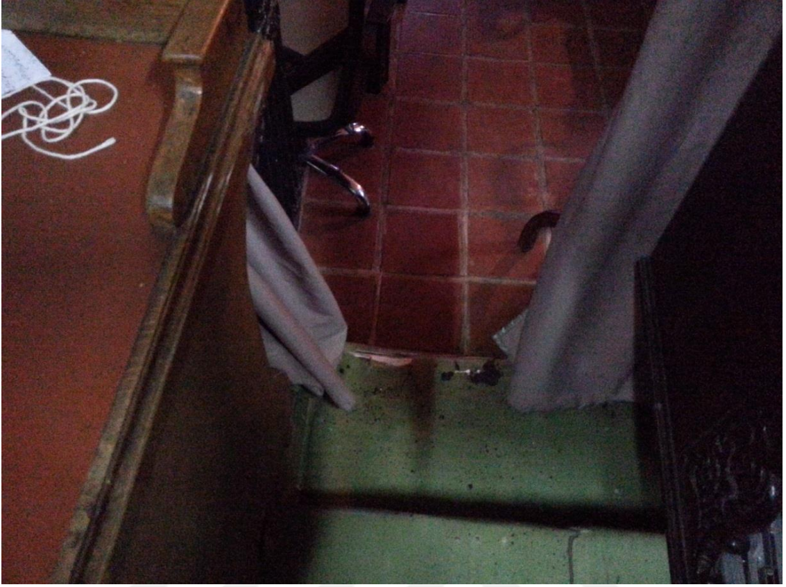
Resim 91: Zemin Kaplaması ve Kot Farkı(2016)
