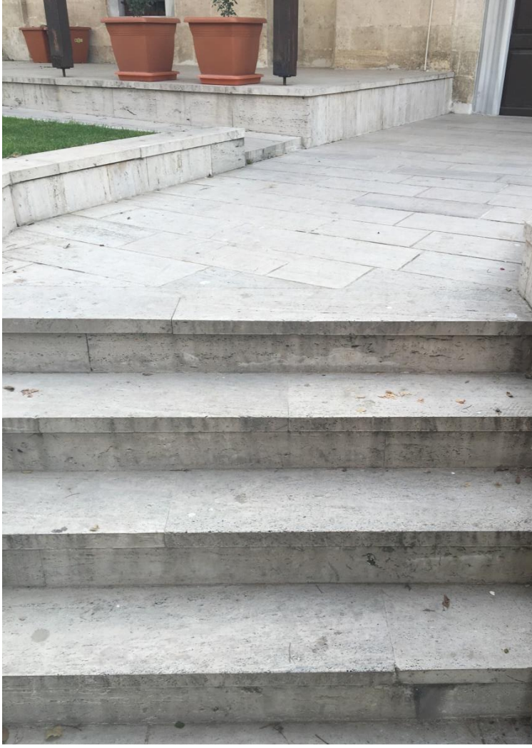
Şekil 27 : Bugünkü Avlu Döşeme Kaplaması (Restorasyon Sonrası)
