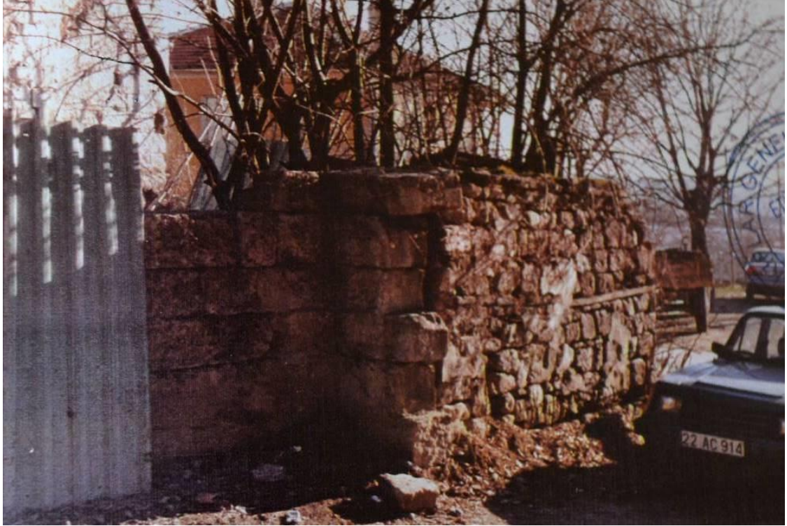
Şekil 76 : Avlu İhata Duvarına Bitişik Çeşme Kalıntıları( E.K.T.V.K.K, 2000)
