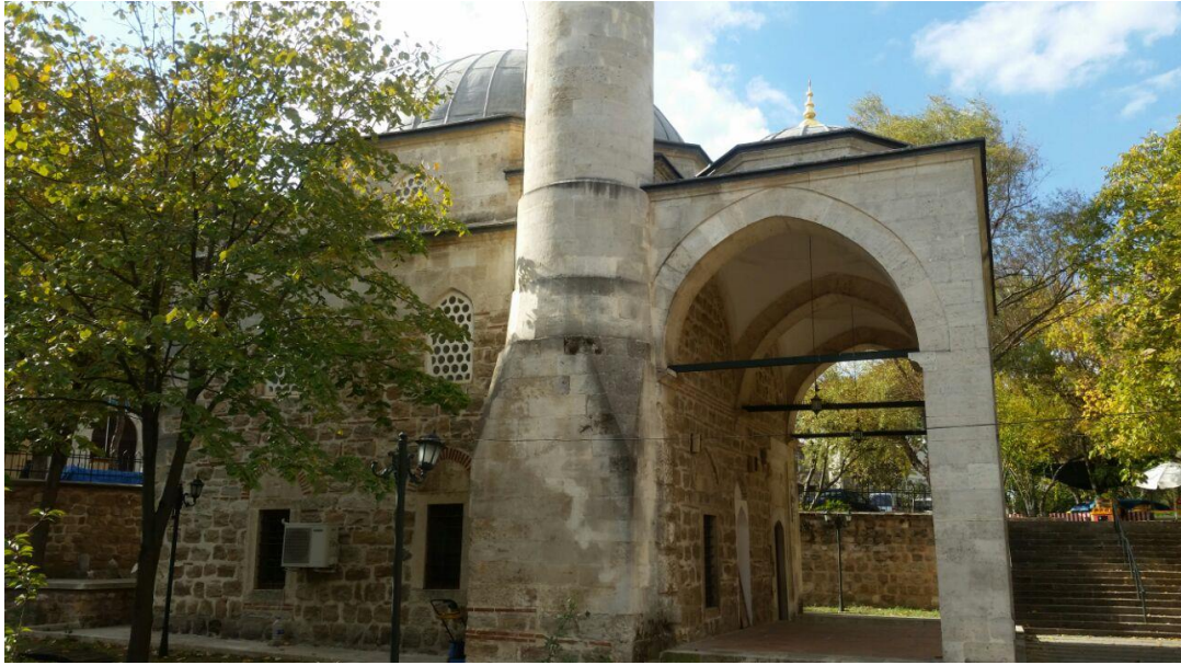
Şekil 45 :Hıdır Ağa Camii Doğu Cephesi (İ. Ceran, 2016)
