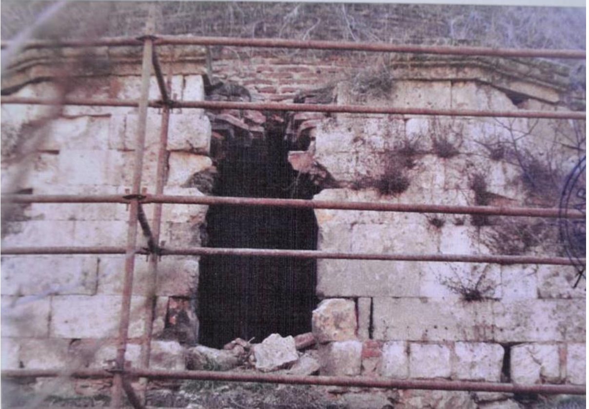
Şekil 115 : Doęu Cephesi Kasnak Penceresi (E.K.T.V.K.K., 2000)
