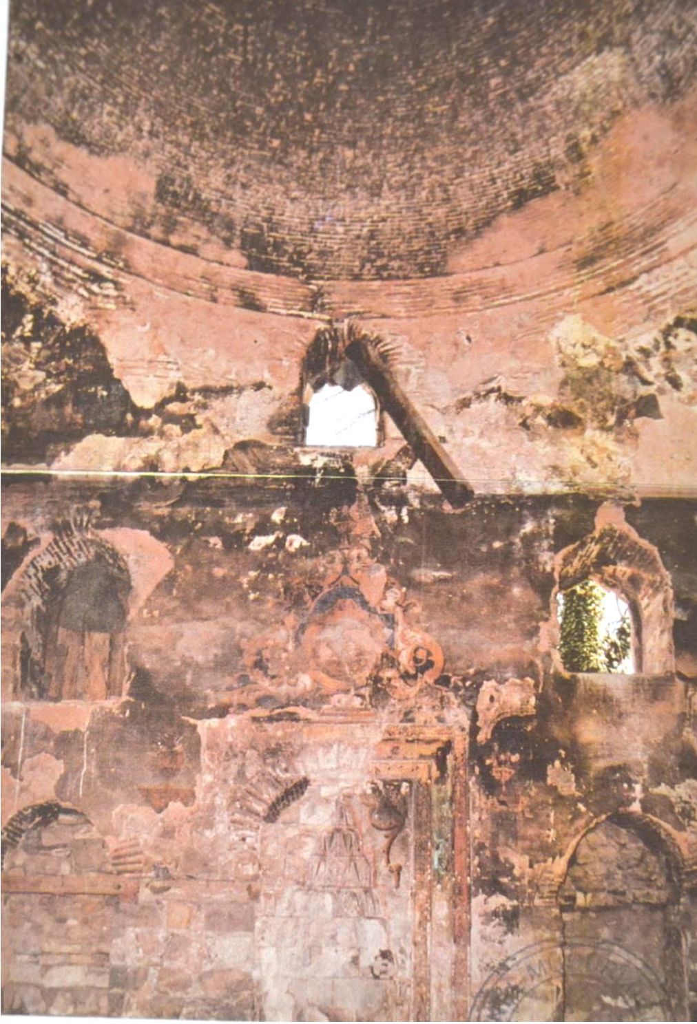
Şekil 85 : Harim Güney Cephesi ( E.K.T.V.K.K, 2000)
