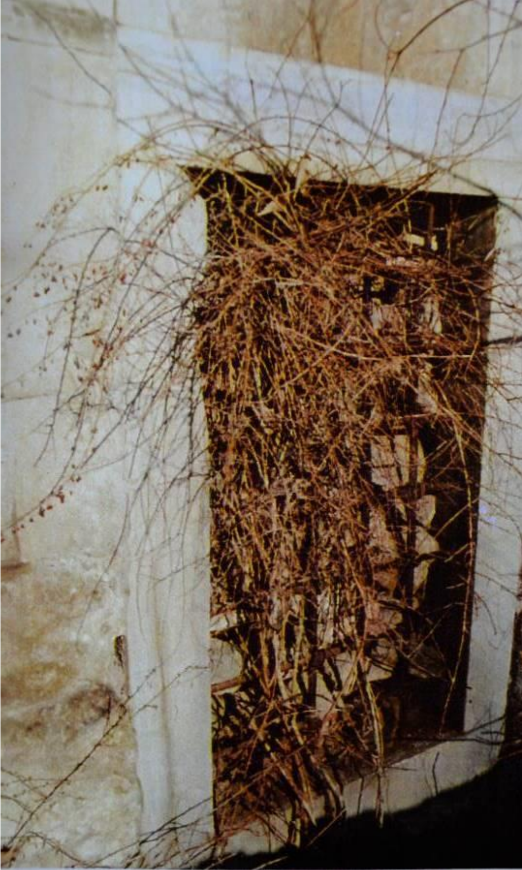
Şekil 114 : Batı Cephesi Alt Pencere ( E.K.T.V.K.K, 2000)
