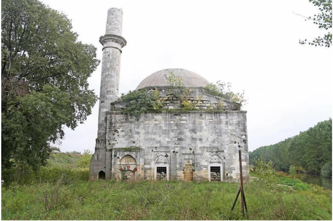
Şekil 64 : Kasım Paşa Camii Kuzey Cephesi ( Mesut Öztürk, 2016)
