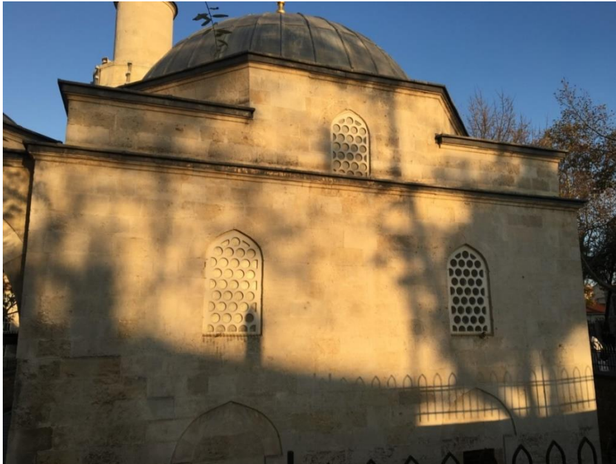
Şekil 47 :Hıdır Ağa Camii Batı Cephesi (İ.Ceran, 2016)
