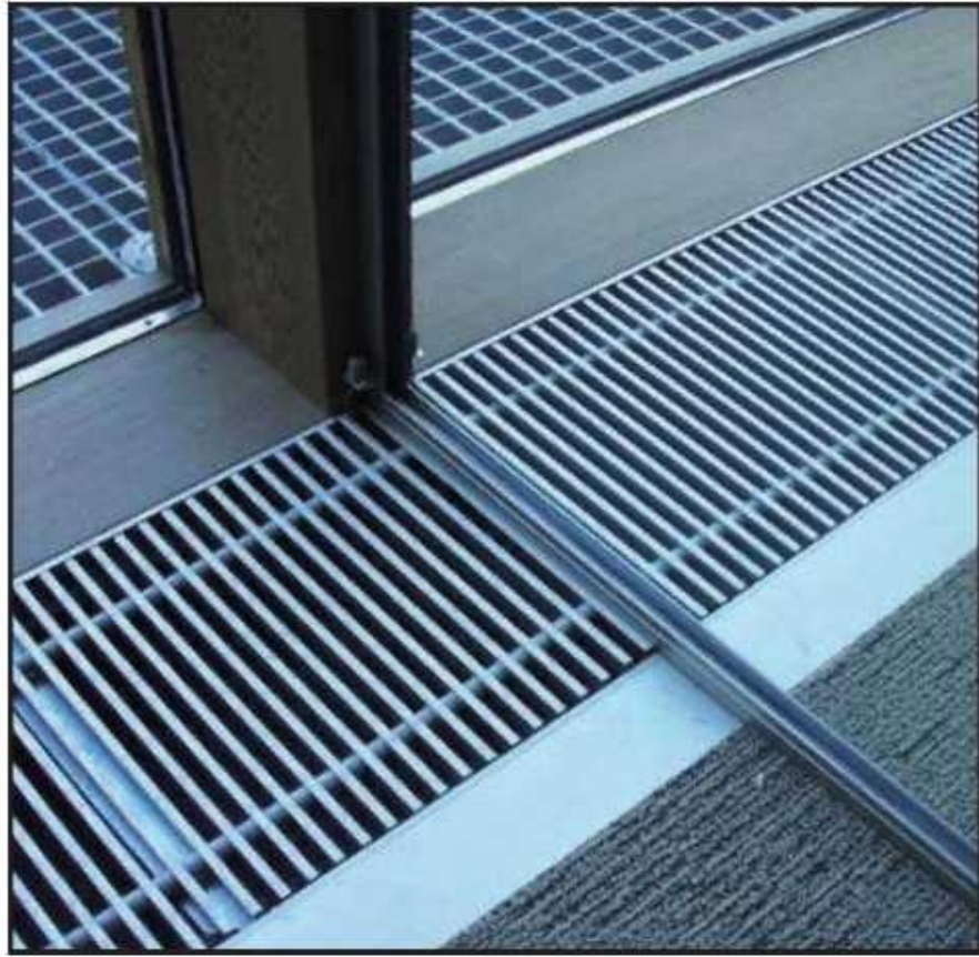
Şekil 5.2: Cam Önü Konvektör Uygulaması Elit Plaza (Anonim, 2007).
