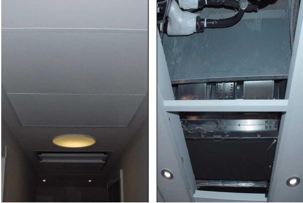
Şekil 4.16: Gizli Tavan Ünitelerinin Görseli Metrocity Rezidans(Anonim, 2007).
