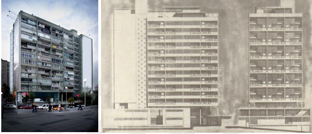
Şekil 2.6: Hukukçular Apartmanı Dış Cephe Görünüşleri (Arkiv, 2009).
