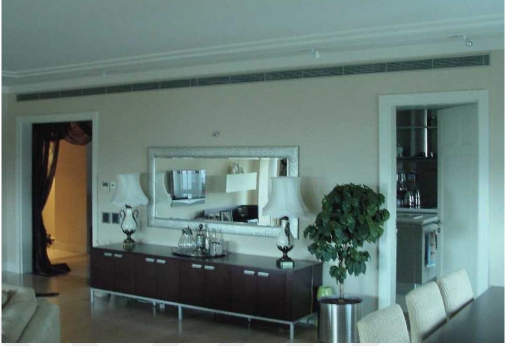
Şekil 4.15: Salonda Uygulanmış Hava Slot Difüzörleri Metrocity Rezidans (Anonim, 2007; Sohrabi, 2015).
