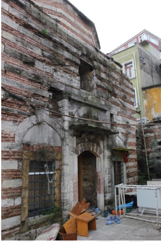
Şekil 39. Dershane kuzey cephe (Masri, 2017)
