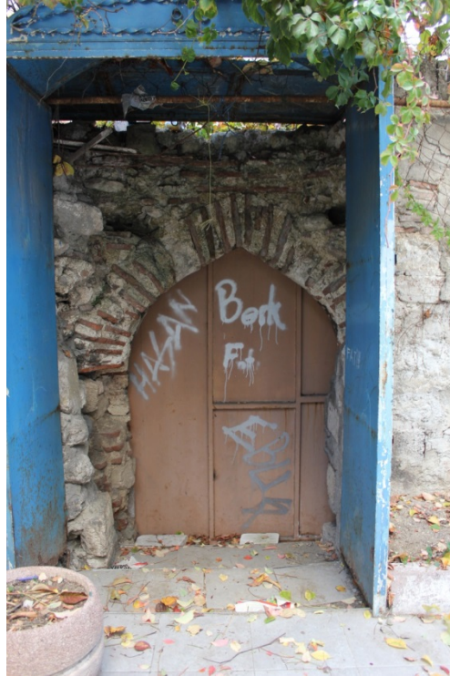
Şekil 44. Kuzey duvarında pencere boşluğuna açılan kapı (Masri, 2017)
