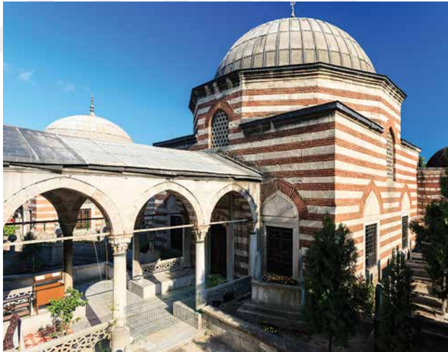
Şekil 109. Sokullu Mehmet Paşa Medresesi – Dershane (Binan, 2016, s.318)
