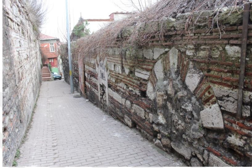
Şekil 43. Eski hücrelerin izlerinin bulunduğu kuzey dış duvar (Masri, 2017)
