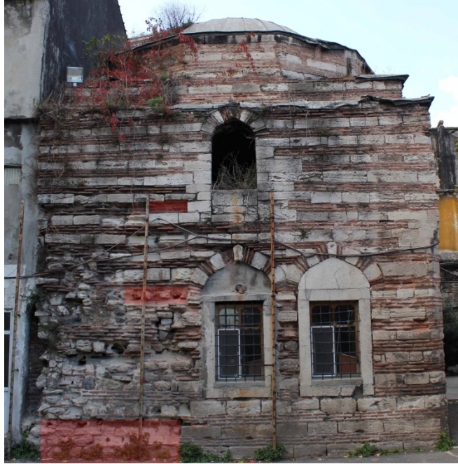
Şekil 118 Dershanenin duvarlarındaki mevcut izler (Masri, 2017)
