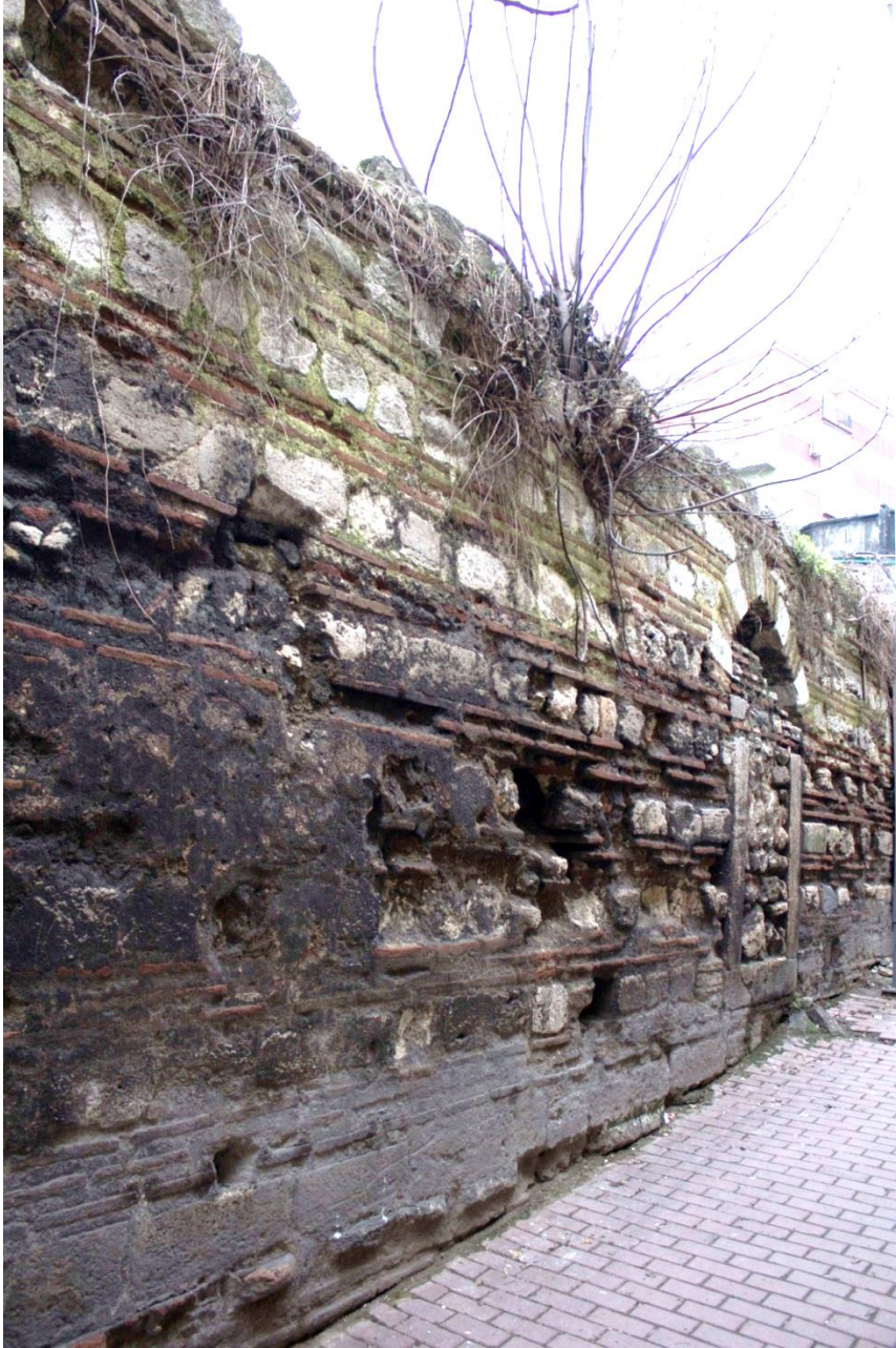
Şekil 92. Kuzey cephe - bitkilenme, taş kaybolması, siyah kabuk oluşumu, ekler ve çimento eklenmesi
