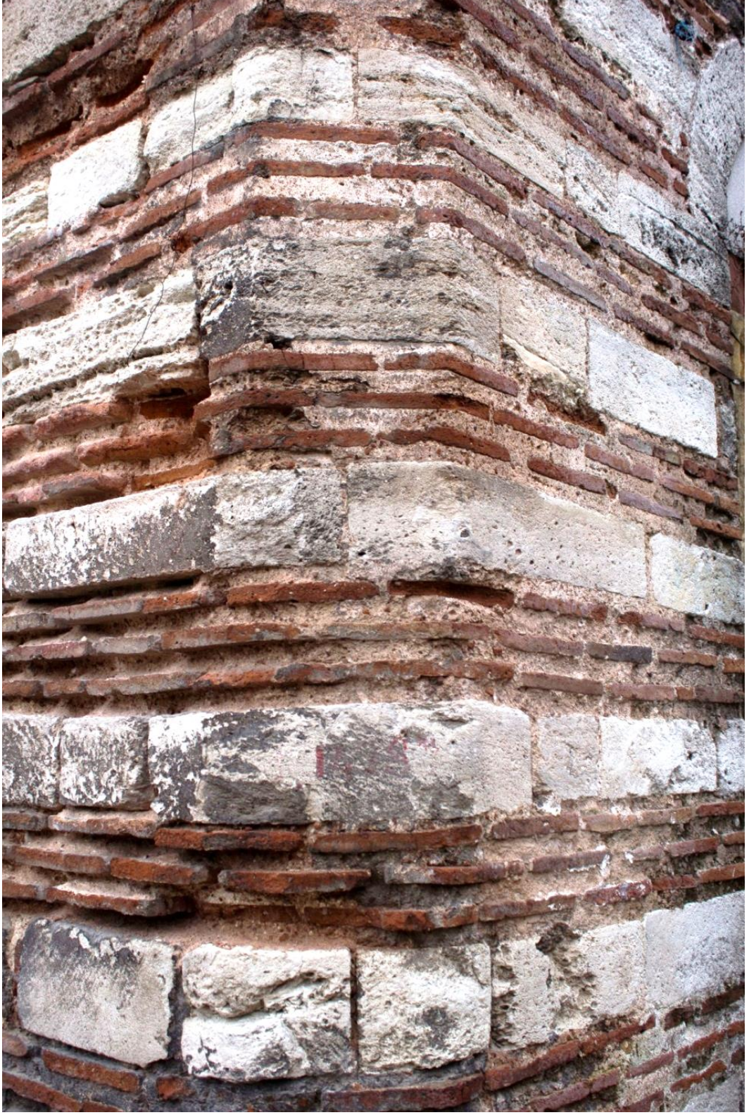
Şekil 100. Dershanenin duvarları –derz boşalması ve siyah kabuk oluşumu (Masri, 2017)
