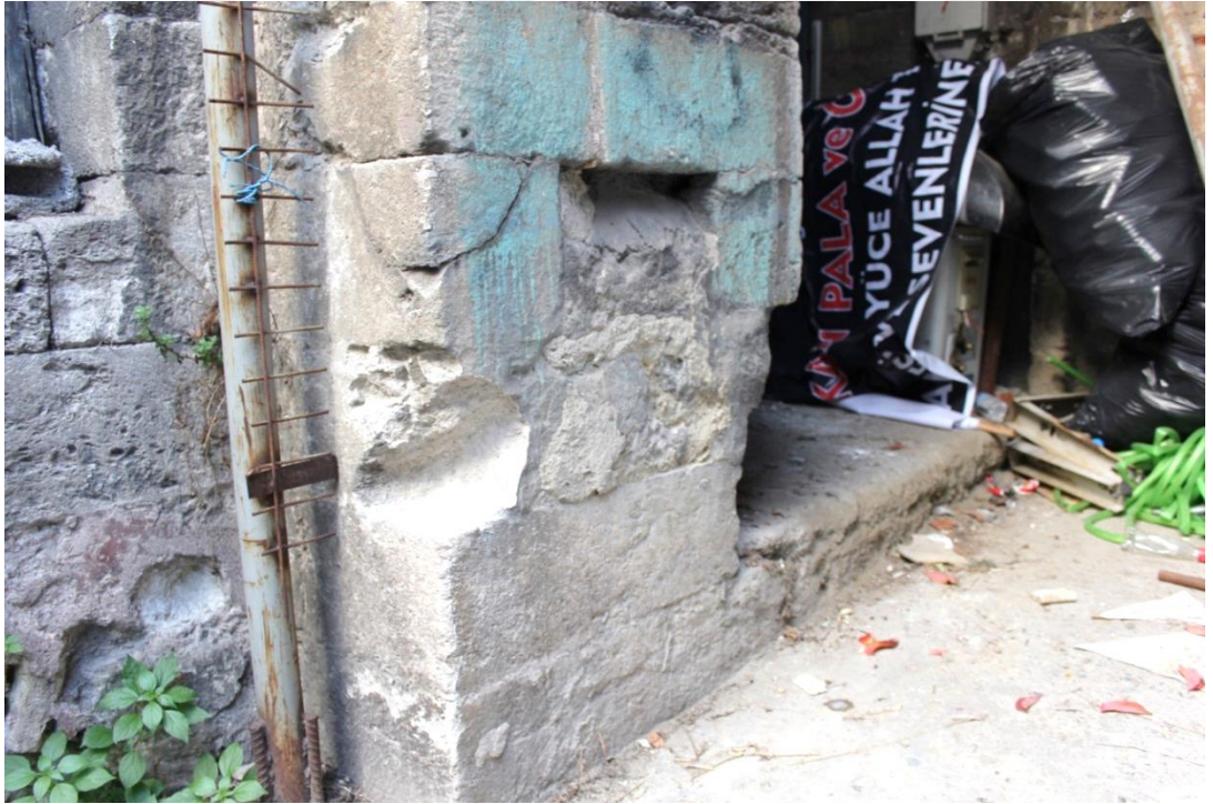
Şekil 98. Ana giriş – ekler, taş kopması ve bitkilenme (Masri, 2017)
