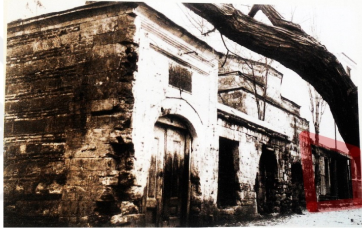
Şekil 34. Haydar Paşa Medresesi – Ana cephe 1940 (İBB, 2008, S23)
