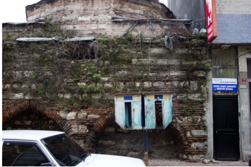
Şekil 65. Haydar Paşa medresesi – Bitişik binanın giriş kapısı
