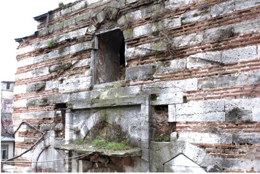
Şekil 102. Dershanenin kuzey cephesi – ekler, bitkilenme, taş kaybolması ve siyah kabuk oluşumu
