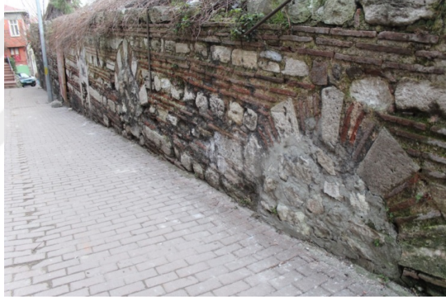
Şekil 114 Haydar Paşa Medresesi – kuzey duvarı (Masri, 2017)
