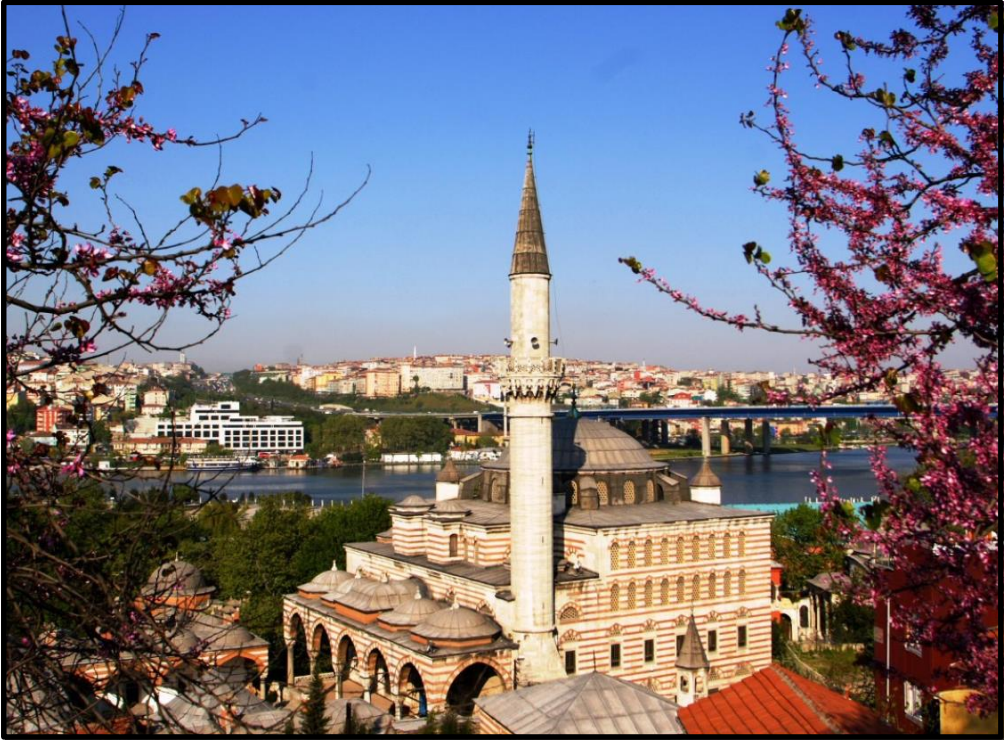
Şekil 5.20: Zal Mahmut Paşa Camii Eski ve Yeni Durumu. 128
