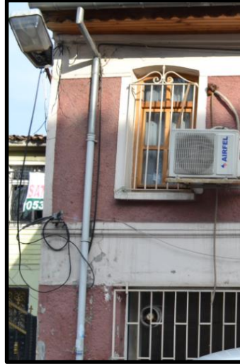
Şekil 5.153: 50 Parselde Yer Alan Yapı Yüzeyindeki Muhdes Elemanlar Ve Silme Hızasında Çatlak (Keskin, T. 2018).
