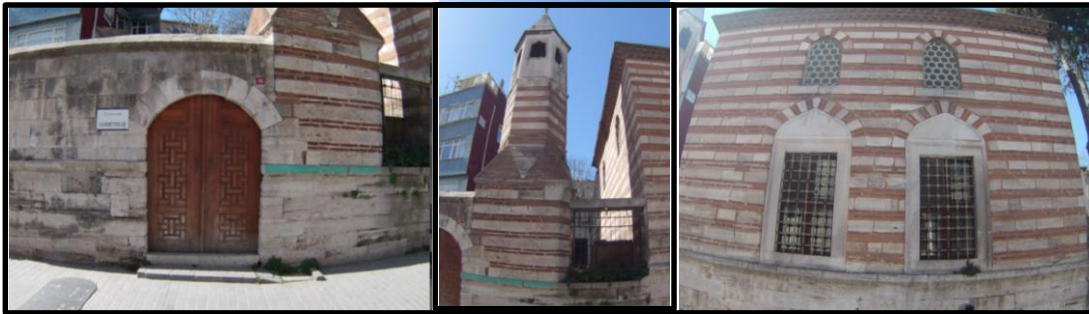
Şekil 5.204: 64 Ada 3 parsel Fotoğrafları (Keskin, T. 2018).
