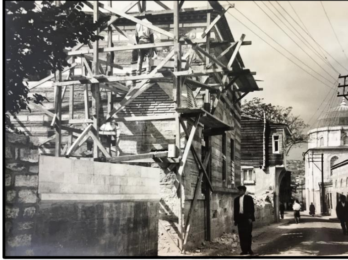
Şekil 5.202: 64 Ada 2-3 parseller 1 Nolu KTVKK Arşivinden Elde Edilen Eski Fotoğraflar.
