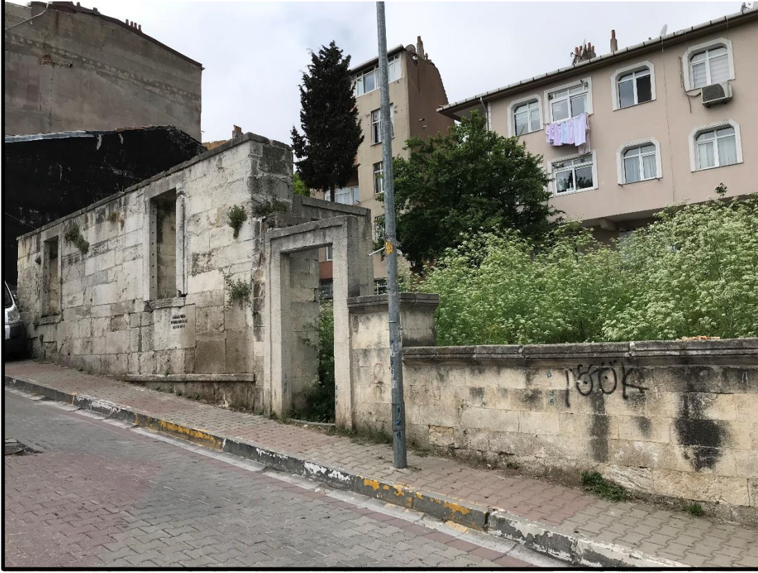
Şekil 5.62: Alaca Tekke Sokaktan Görünüş (Keskin, T. 2018).
