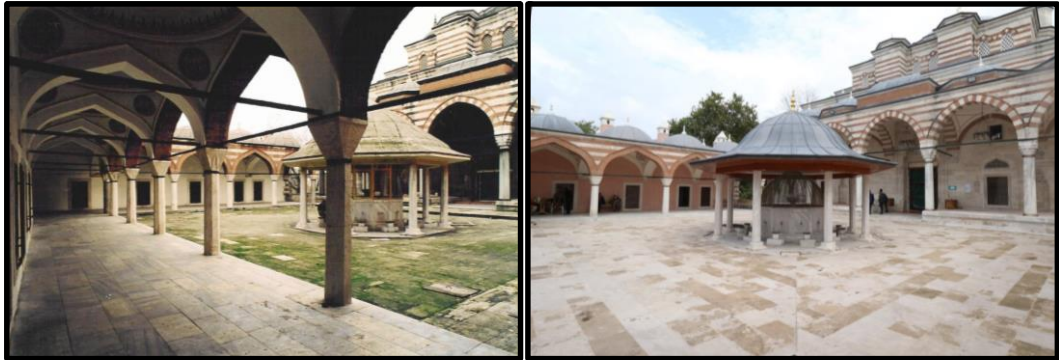
Şekil 5.21: Zal Mahmut Paşa Külliyesi Eski ve Yeni Durumu 129
