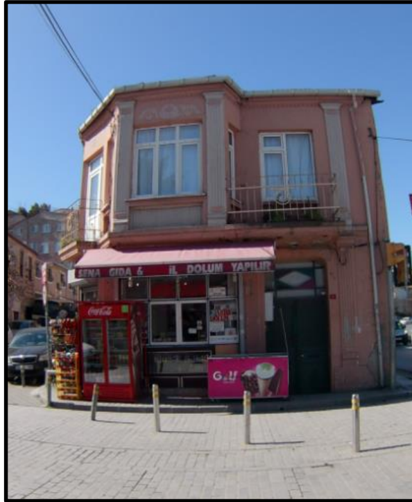
Şekil 5.213: 349 Ada, 8 Parsel Fotoğrafı (Keskin, T. 2018).
