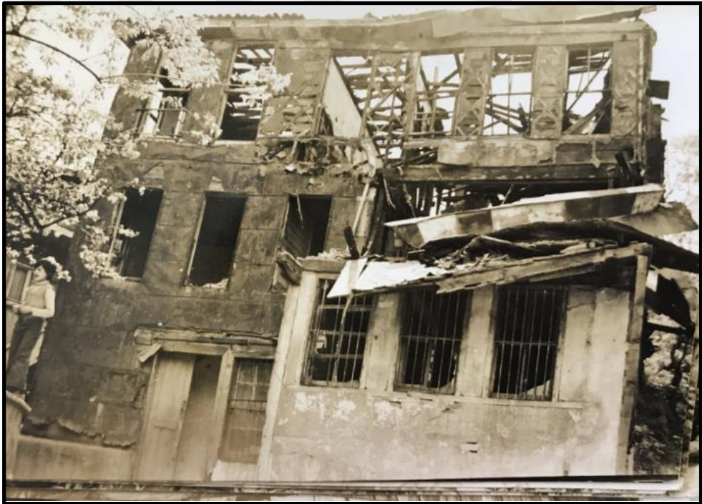
Şekil 5.201: 64 Ada 1 parsel mevcut durum (Keskin, T. 2018) ve 1 Nolu KTVKK Arşivinden Elde Edilen Eski Fotoğraflar.
