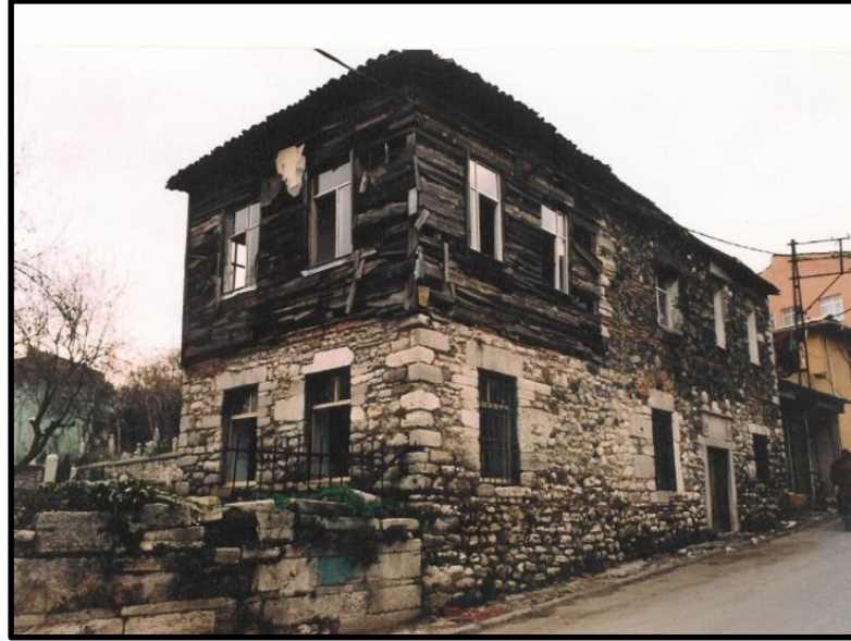
Şekil 5.63: Afife Hatun Tekkesi Restorasyon Öncesi Durum 190 .
