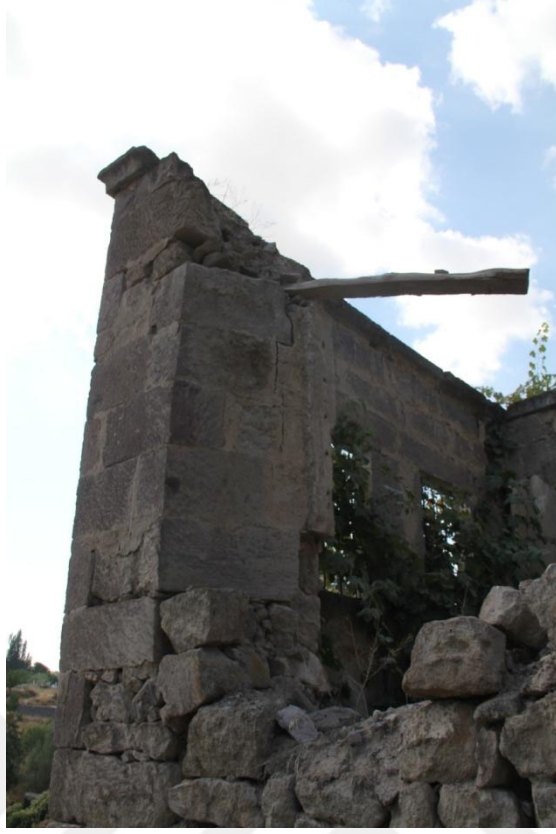
Şekil 152. Doğu duvarı kesme taş kalıntıları
