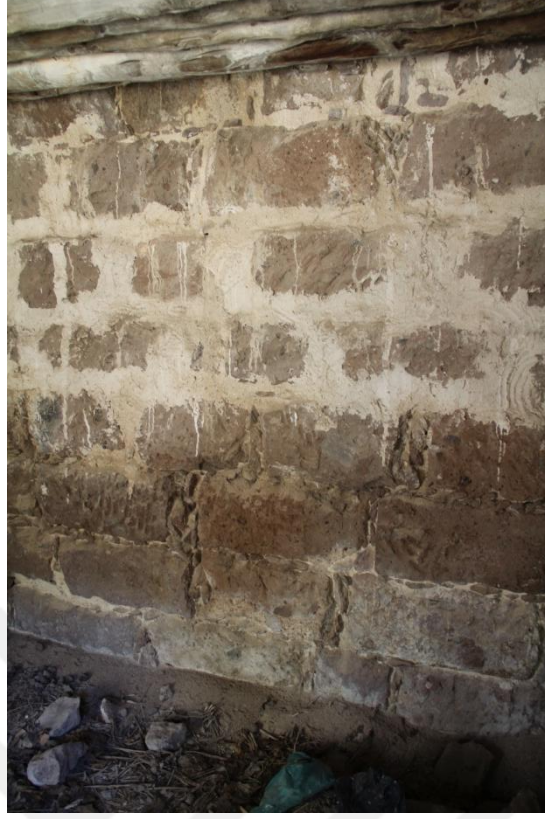
Şekil 50. Z01 mekanı güney duvarı
