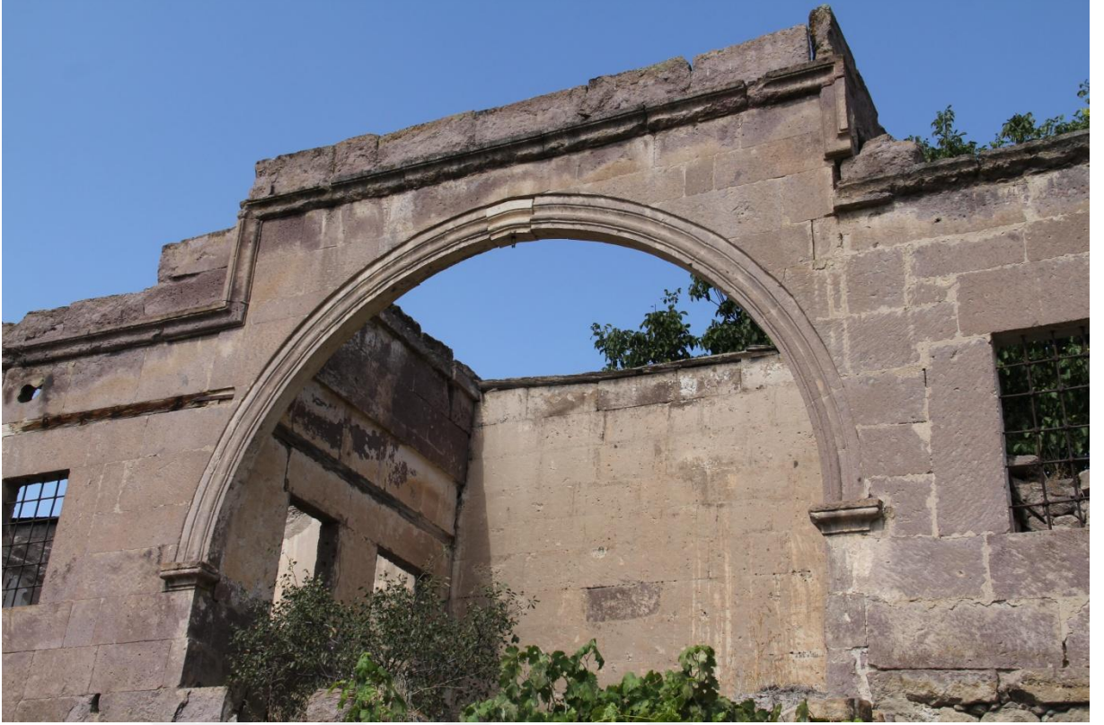
Şekil 144. Güney duvarı orta bölüm
