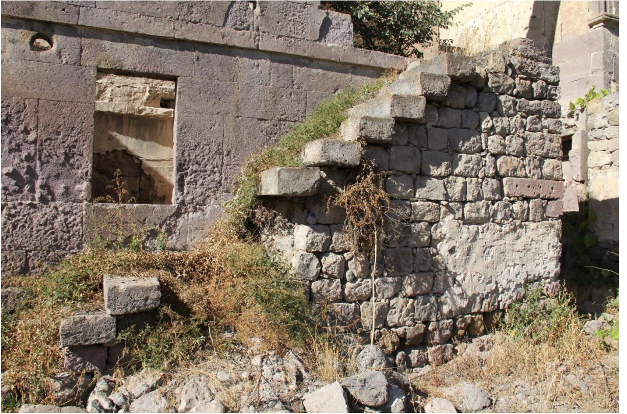
Şekil 145. Güney duvarı 101 mekanına çıkan merdiven
