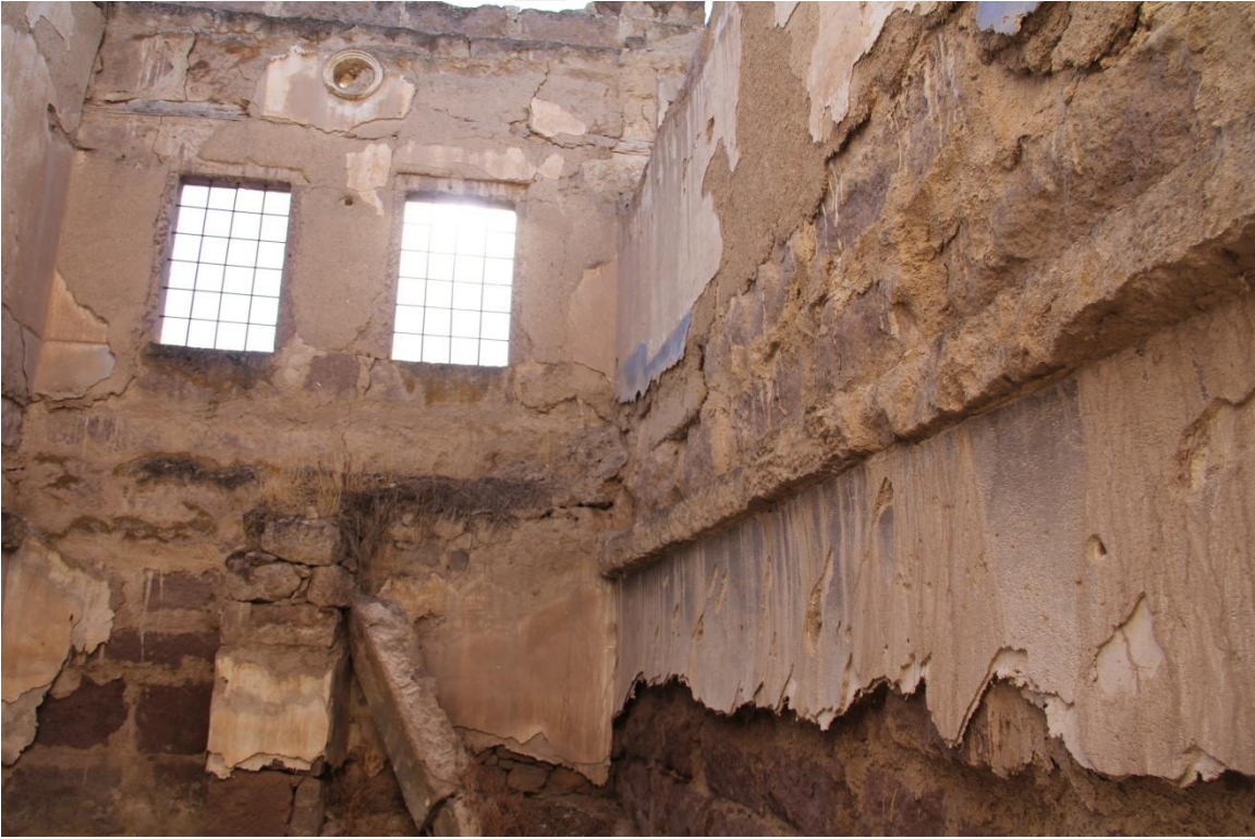
Şekil 75. Z04 mekanı ahşap kirişleri taşıyan yatay taşlar
