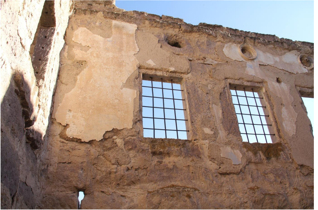
Şekil 113. 103 mekanı güney duvarındaki ışıklık boşlukları
