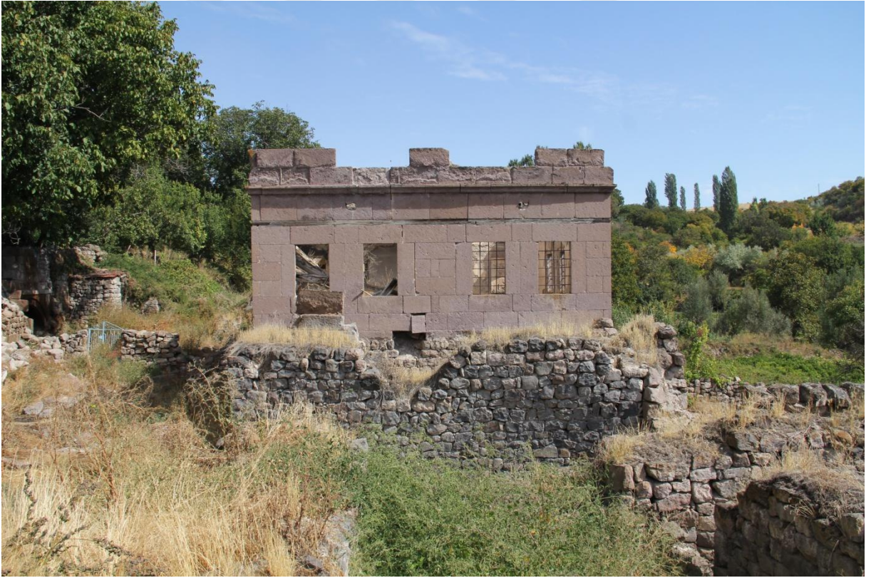
Şekil 141. Batı duvarı görünümü
