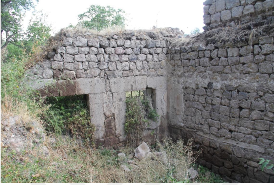
Şekil 38. D01 mekanı pencere boşlukları
