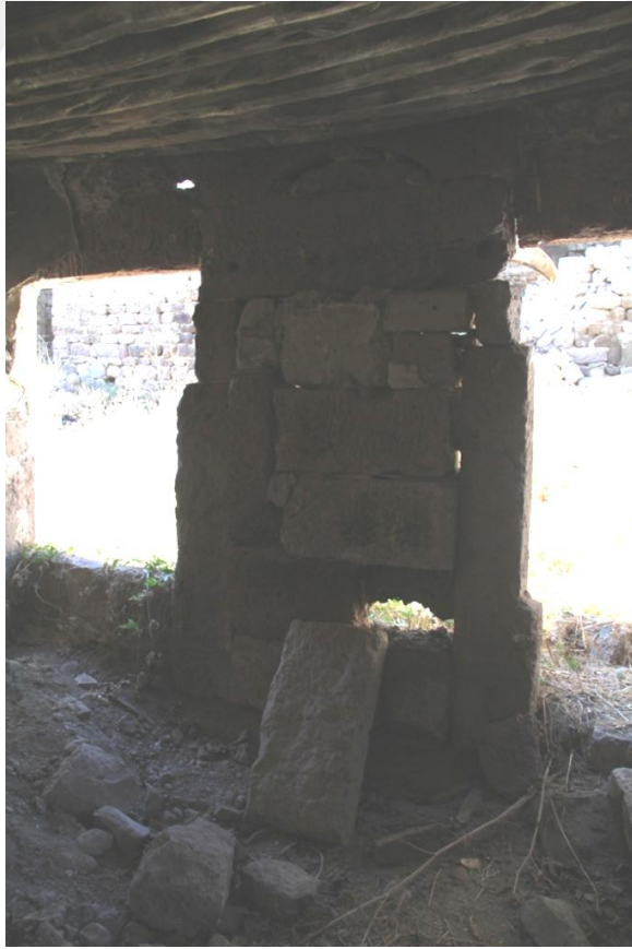
Şekil 45. Z01 mekanı kuzey duvarındaki pencere boşlukları
