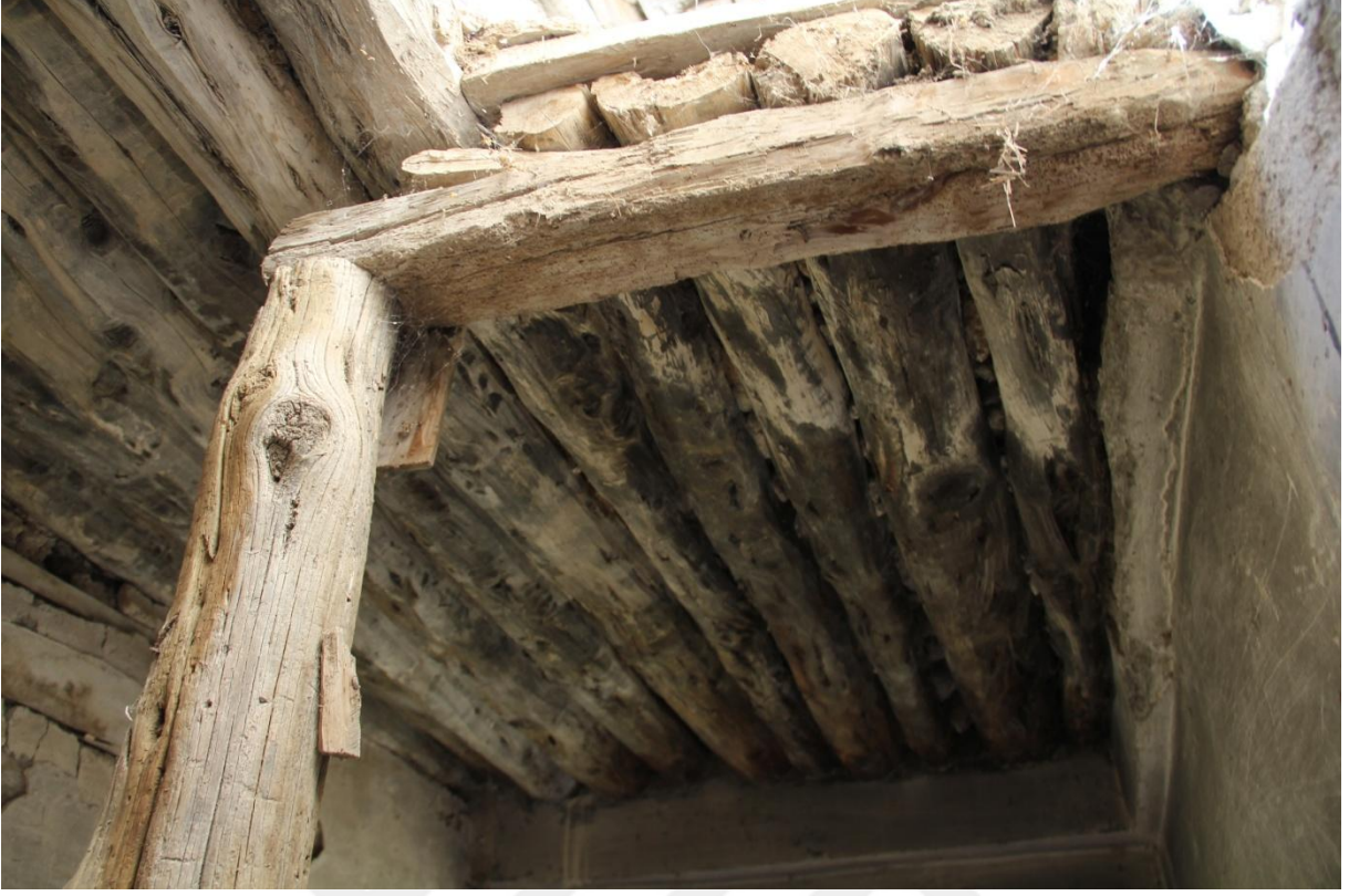
Şekil 62. Z02 mekanı kuzey güney doğrultusunda yerleştirilen ahşap kirişler
