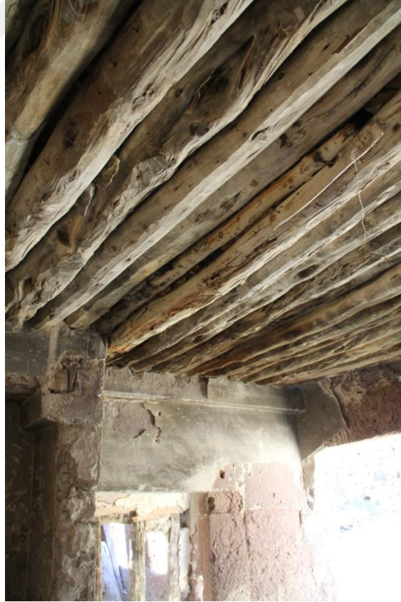
Şekil 53. Z01 mekanı ahşap kirişleri taşıyan taşlar
