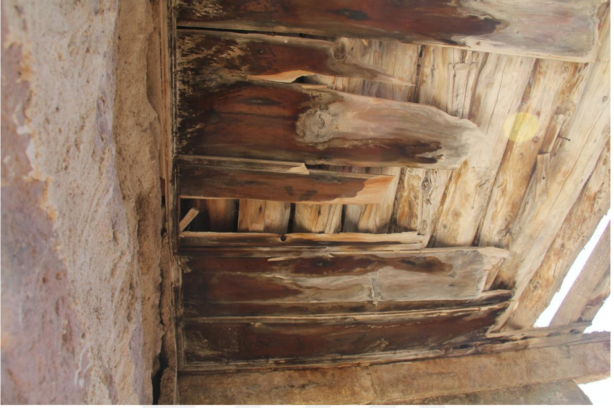
Şekil 106. 102 mekanı ahşap kirişler ve güney tarafındaki tavan kaplaması
