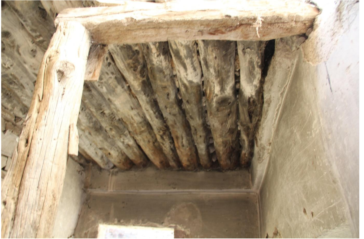
Şekil 61. Z02 mekanı ahşap kirişleri taşıyan yatay taşlar
