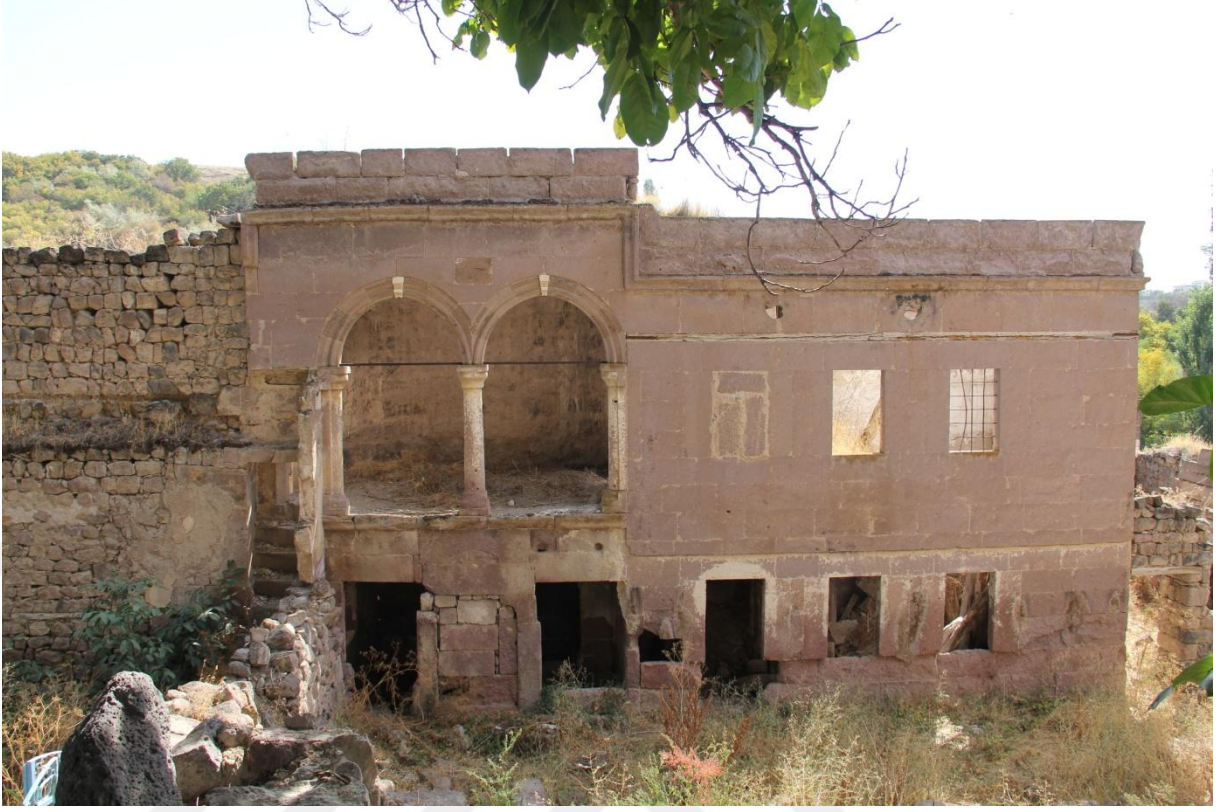
Şekil 136. Kuzey duvarı batı bölümü genel görünüm
