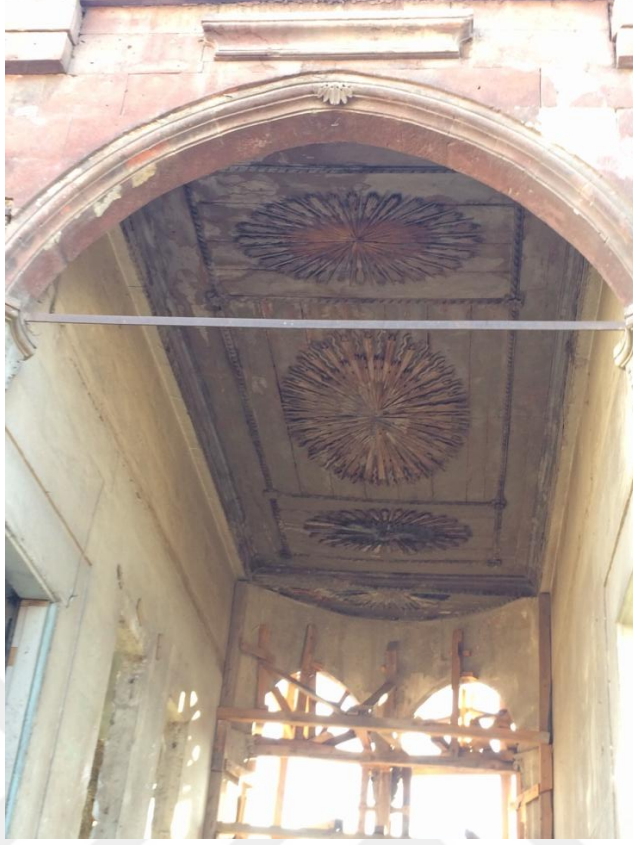
Şekil 7. Ahşap tavan kaplaması
