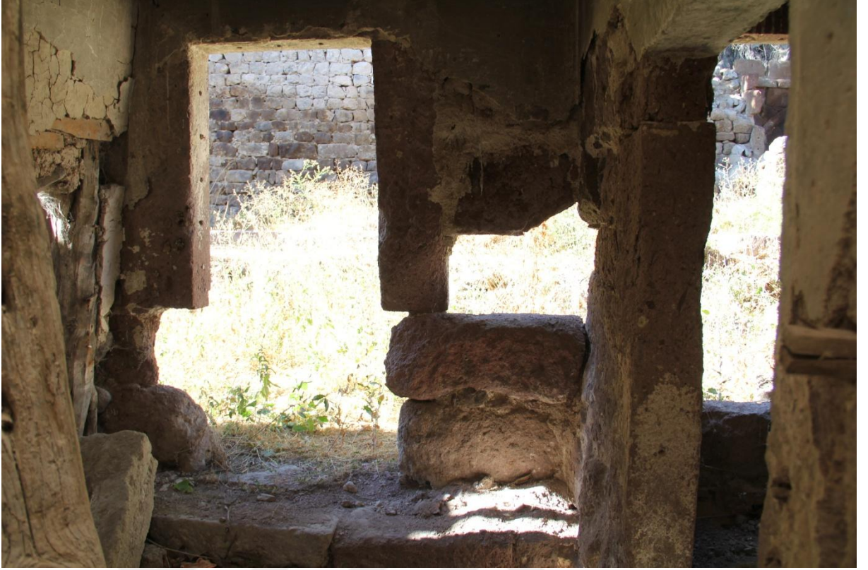
Şekil 56. Z02 mekanı kuzey duvarındaki pencere boşluğu
