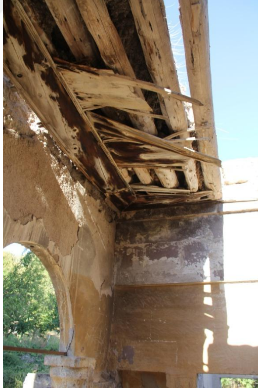
Şekil 101. 101 mekanı ahşap kirişler ve tavan kaplaması
