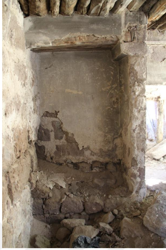
Şekil 52. Z01 mekanı batı duvarındaki niş
