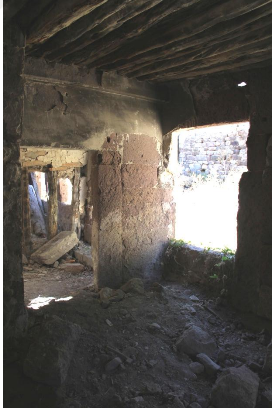
Şekil 51. Z01 mekanı batı duvarı ve Z01-Z02 mekanları arasındaki kapı
