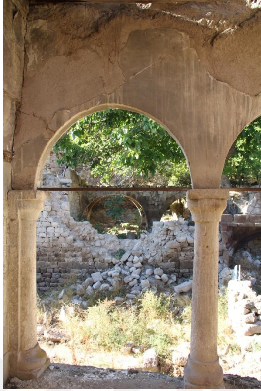
Şekil 96. 101 mekanı batı yönündeki sütunlar
