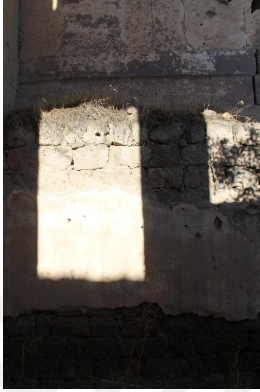
Şekil 78. Z05 mekanı dođu duvarı
