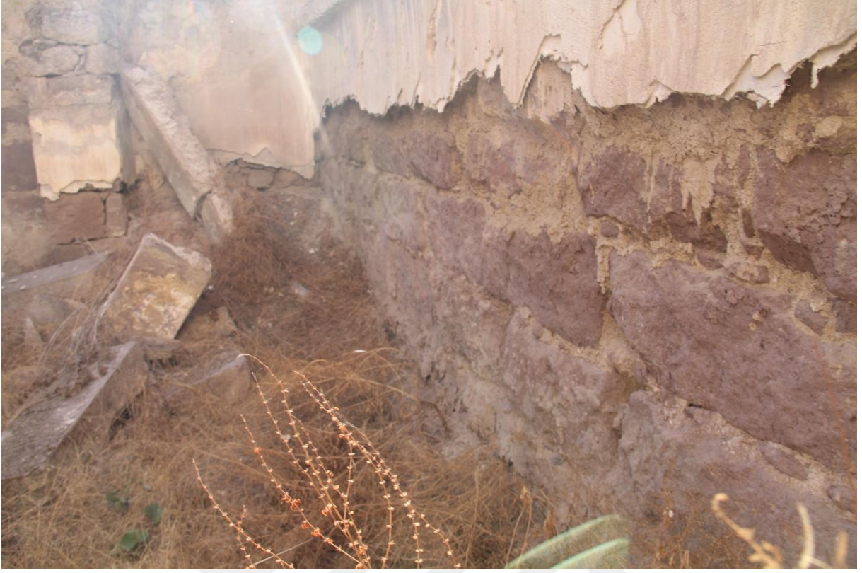
Şekil 70. Z04 mekanı kuzey duvarı
