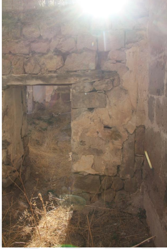
Şekil 76. Z05 mekanı toprak kaplı zemin
