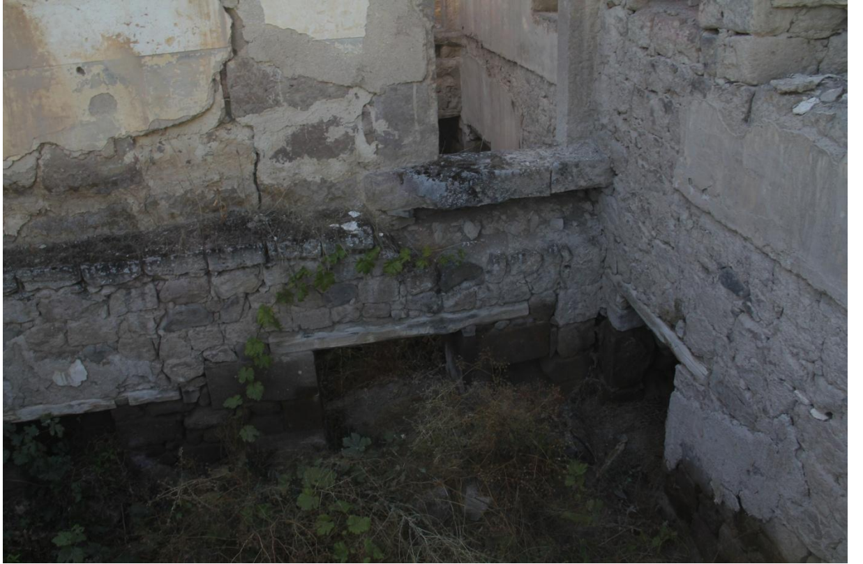
Şekil 93. Z07 mekanı batı yönündeki molozların içinde kalmış duvar
