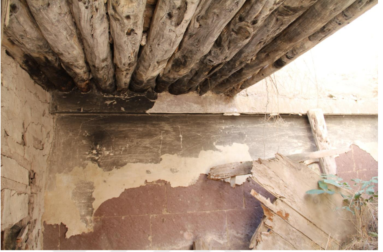
Şekil 68. Z03 mekanı kuzey güney doğrultusundaki ahşap kirişler
