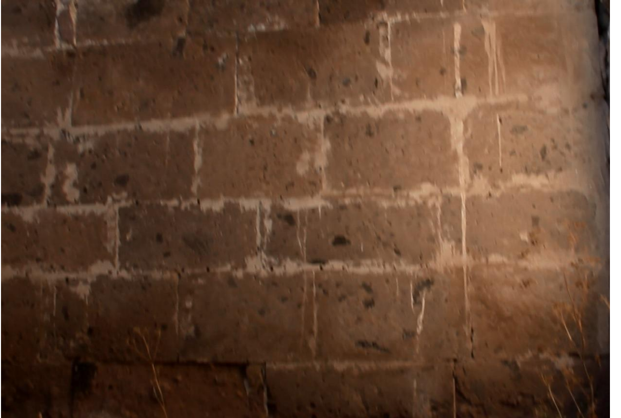
Şekil 77. Z05 mekanı kuzey duvarı
