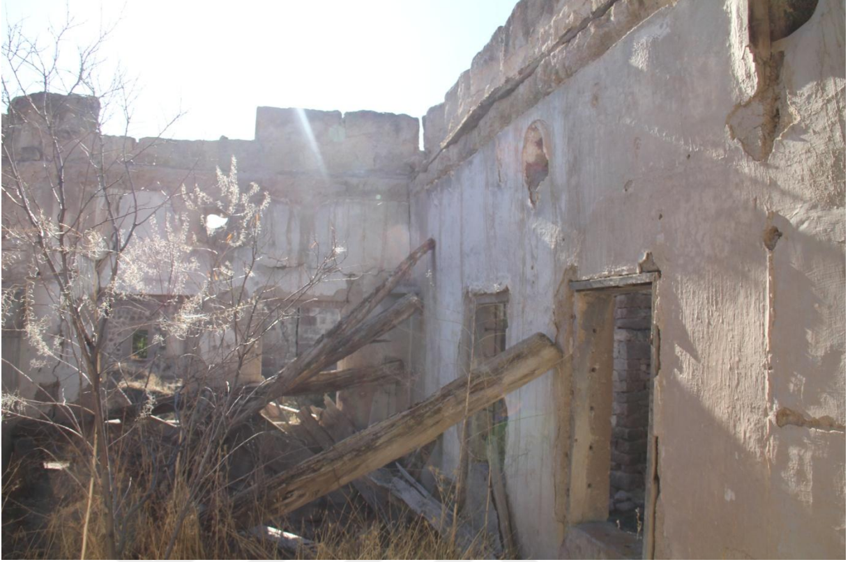
Şekil 108. 102 mekanı sıvalı kuzey duvarı ve pencere boşlukları
