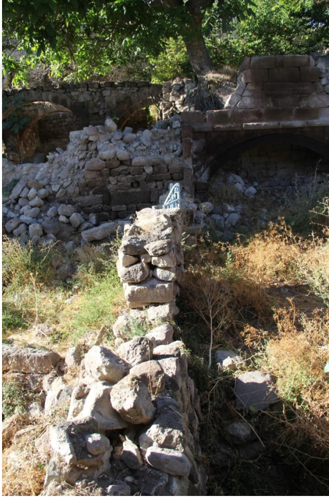
Şekil 39. D01 mekanı ocağı
