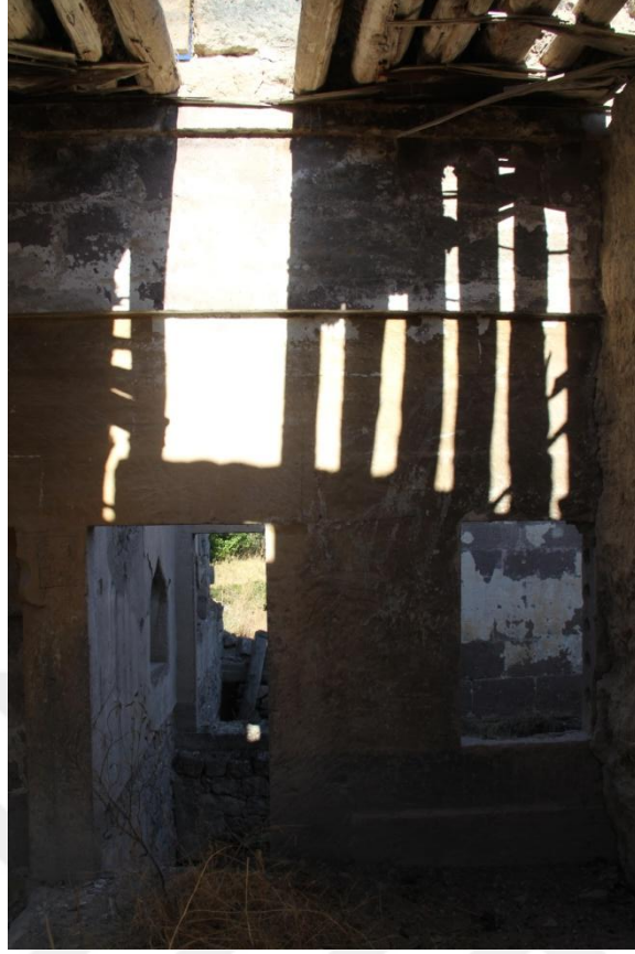
Şekil 98. 101 mekanı doğu duvarındaki kapı ve pencere
