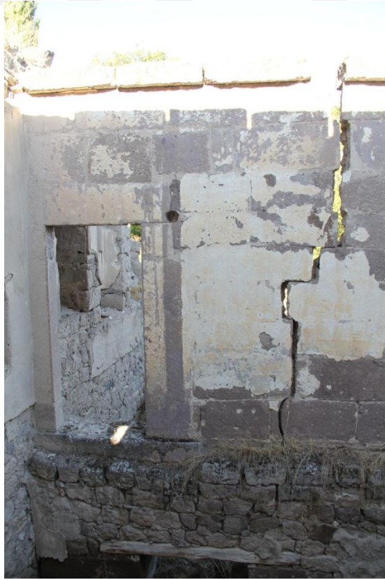
Şekil 125. 105 mekanı 105-106 mekanları arasındaki kapı boşluğu
