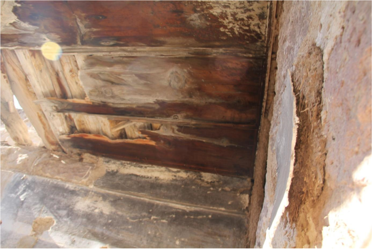
Şekil 107. 102 mekanı ahşap kirişler ve kuzey tarafındaki tavan kaplaması
