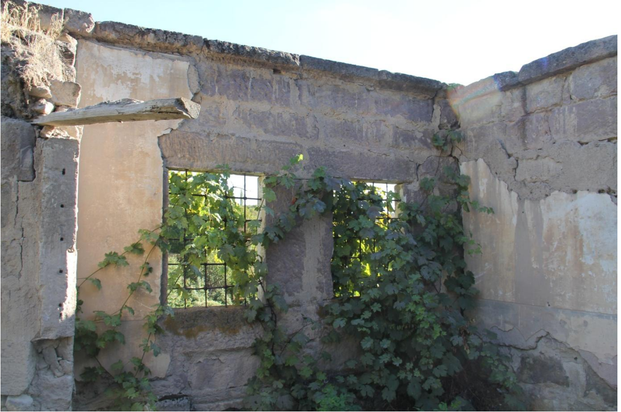
Şekil 131. 106 mekanı güney duvarındaki pencereler
