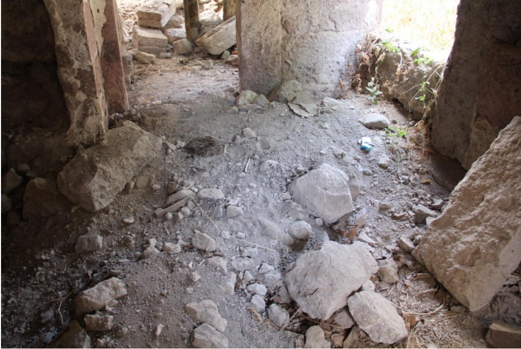
Şekil 47. Z01 mekanı toprak kaplanmış zemin
