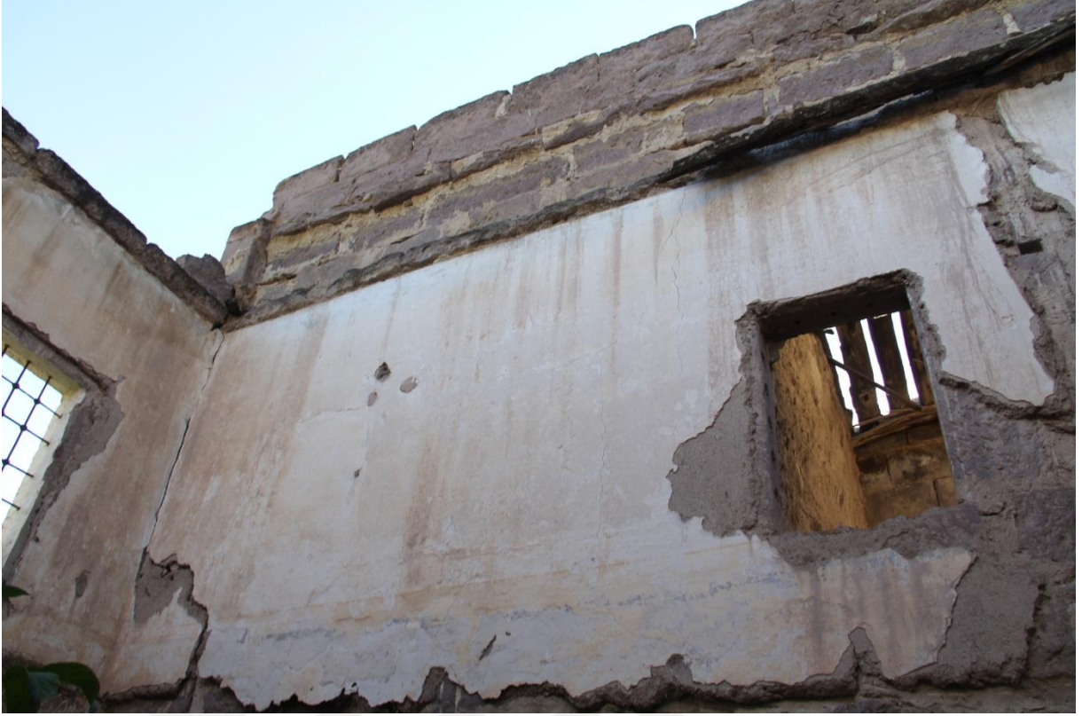
Şekil 124. 105 mekanı 104-105 mekanları arasındaki kapatılmış kapı ve pencere boşlukları
