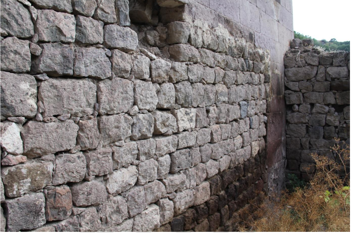
Şekil 142. Batı duvarı moloz taş ve kesme taş birleşimi
