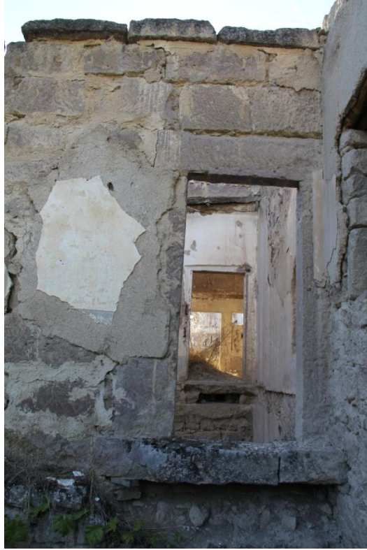
Şekil 129. 106 mekanı batı duvarındaki 105-106 mekanları arasındaki kapı boşluğu
