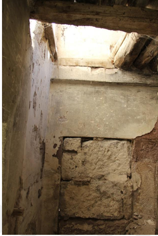
Şekil 60. Z02 mekanı Z02-Z04 mekanları arasındaki örülmüş kapı boşluğu
