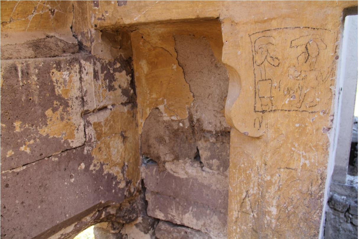
Şekil 99. 101 mekanı merdiven yanındaki niş
