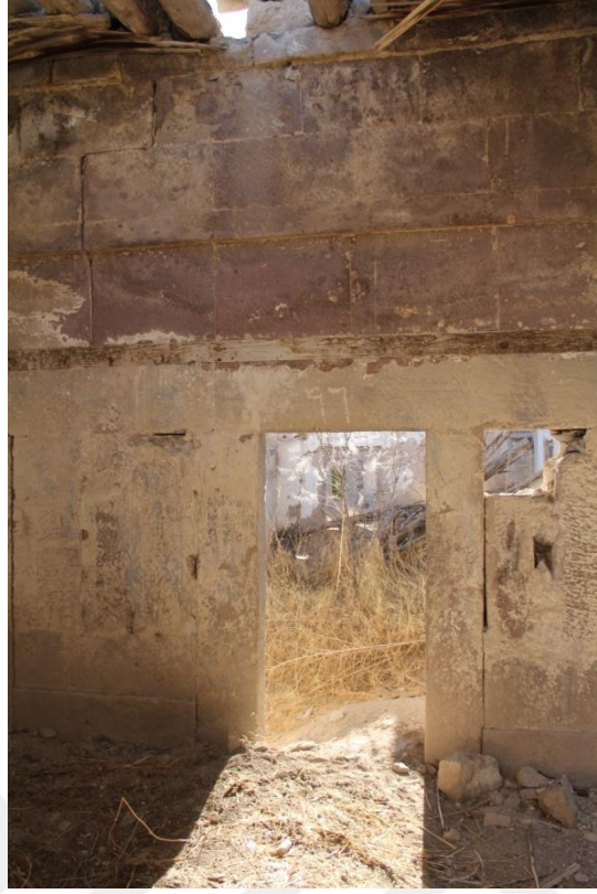
Şekil 100. 101 mekanı batı duvarındaki kapı ve kapatılmış pencereler
