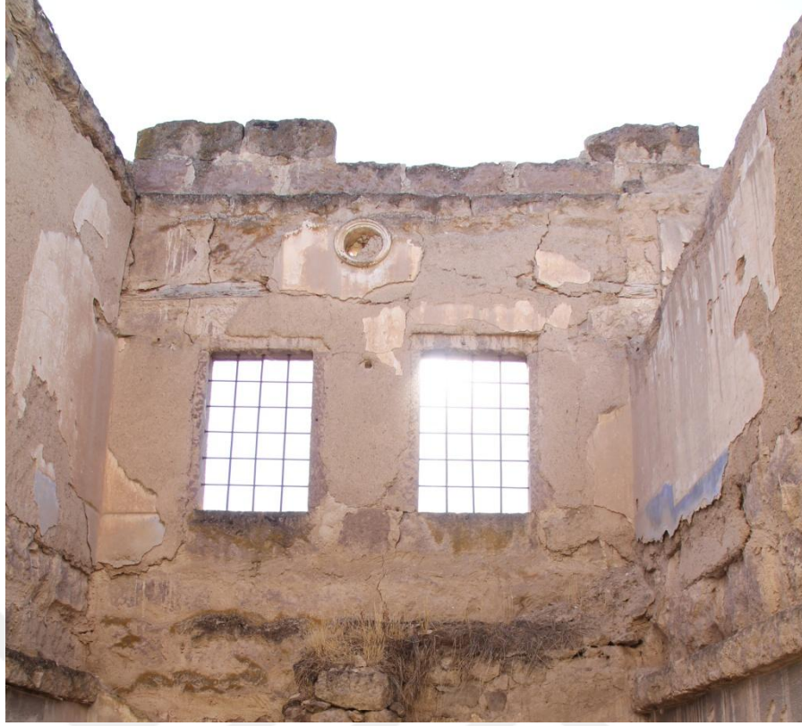
Şekil 116. 103 mekanı batı duvarı
