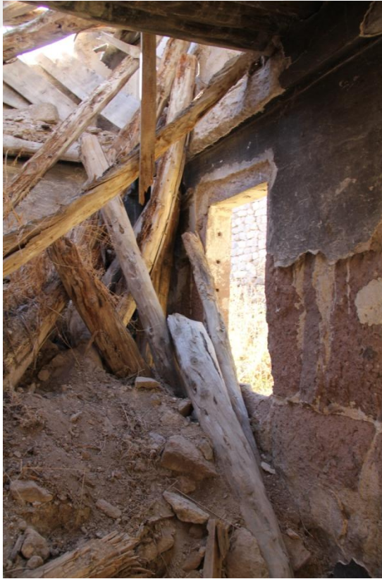
Şekil 65. Z03 mekanı kuzey duvarı
