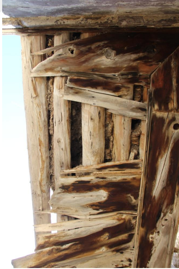
Şekil 103. 101 mekanı tavan kaplaması
