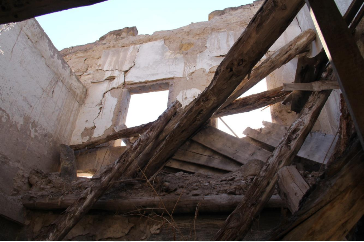
Şekil 110. 102 mekanı batı duvarındaki pencereler
