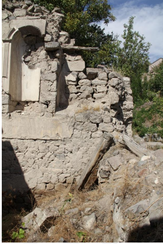
Şekil 92. Z07 mekanı kuzey duvarındaki niş
