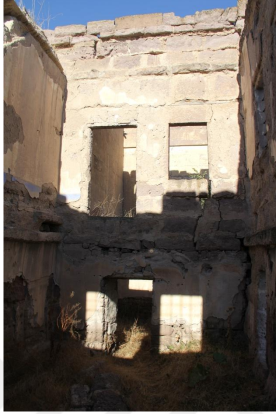
Şekil 72. Z04 mekanı doğu duvarı
