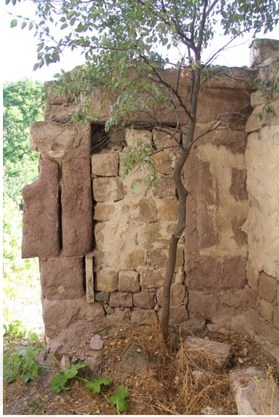
Şekil 80. Z05 mekanı güney duvarında bulunan taşla örülmüş niş
