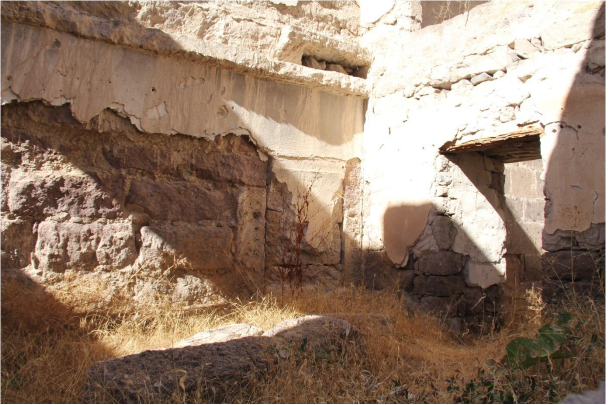
Şekil 71. Z04 mekanı Z02-Z04 mekanları arasındaki örülmüş kapı boşluğu
