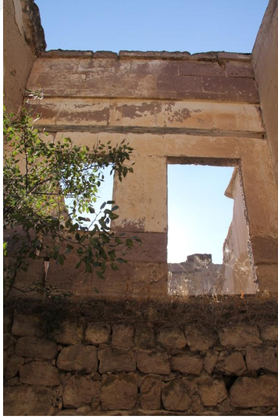
Şekil 119. 104 mekanı batı duvarı, kapı ve pencere boşlukları
