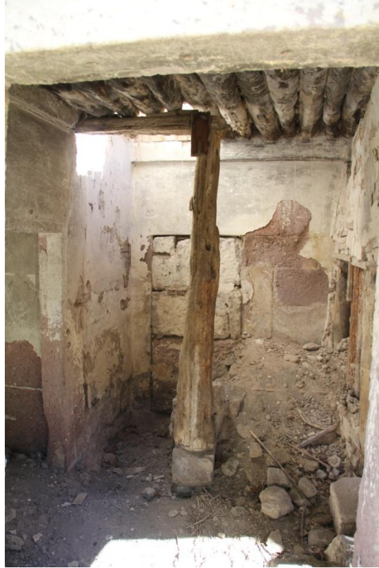
Şekil 55. Z02 mekanı içerisinde bulunan ahşap dikme
