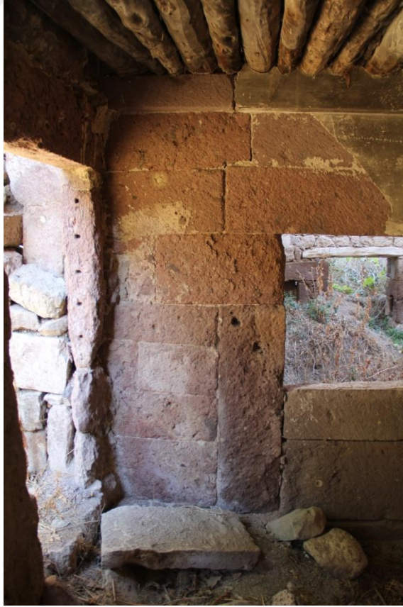
Şekil 49. Z01 mekanı parapet seviyesinde kapatılan kapı boşluğu
