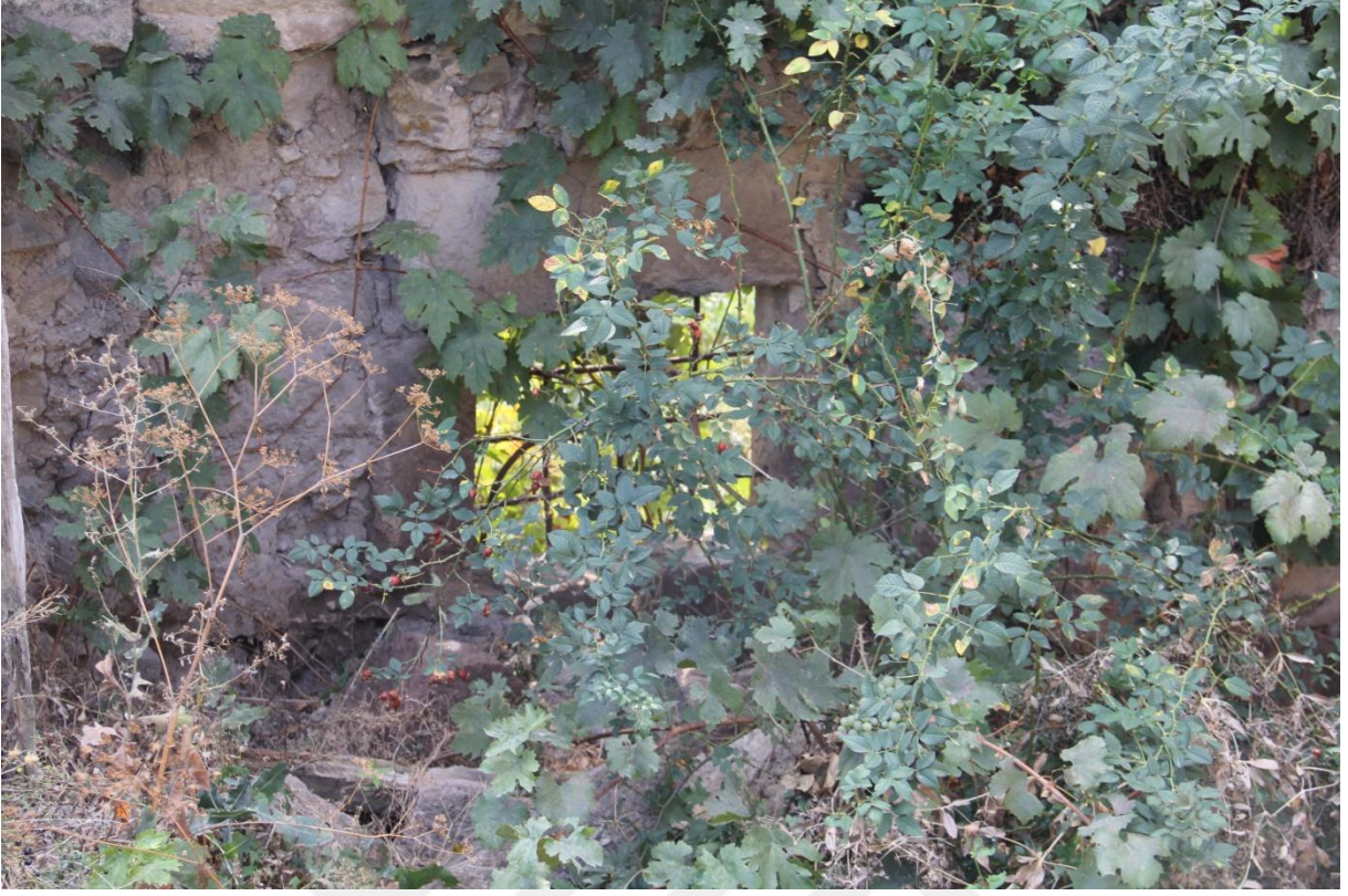
Şekil 90. Z07 mekanı güney duvarındaki pencere boşluğu
