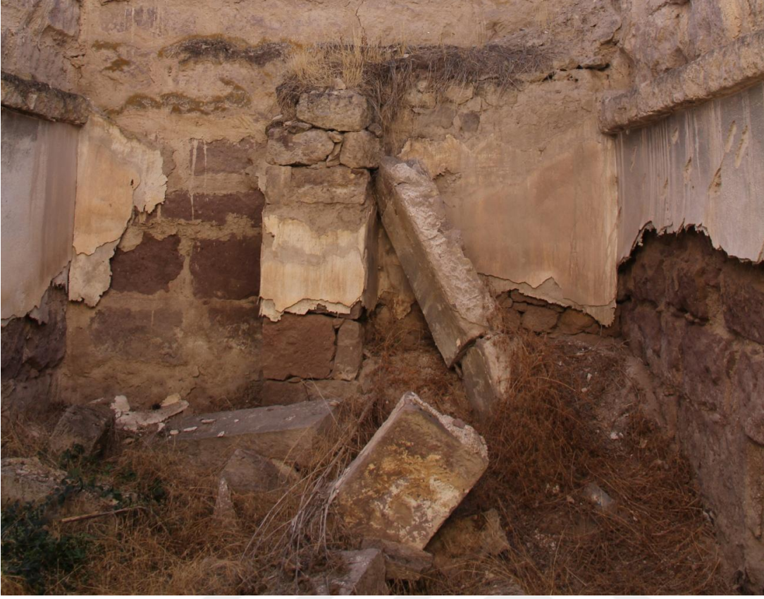
Şekil 74. Z04 mekanı batı duvarı ve niş
