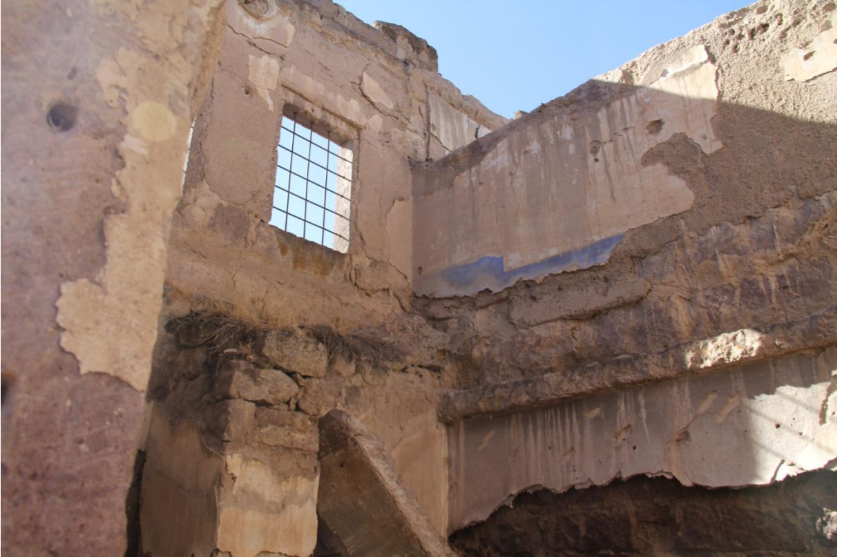
Şekil 115. 103 mekanı batı ve kuzey duvarı
