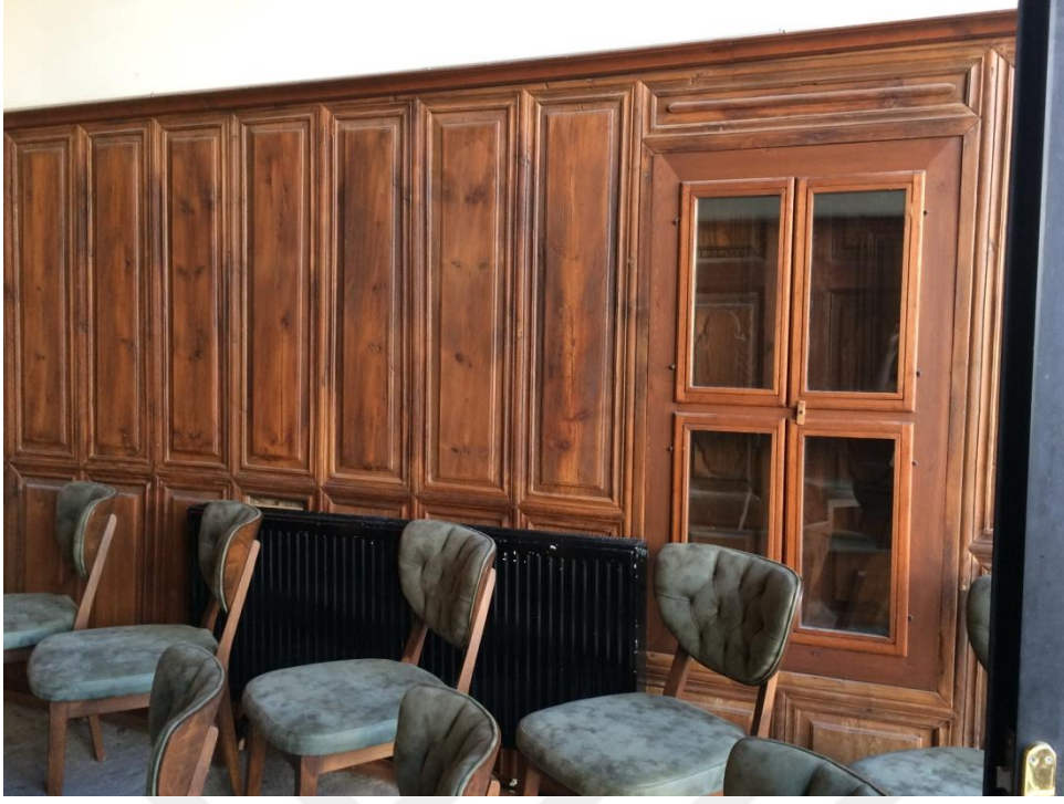
Şekil 9. Ahşap duvar kaplaması
