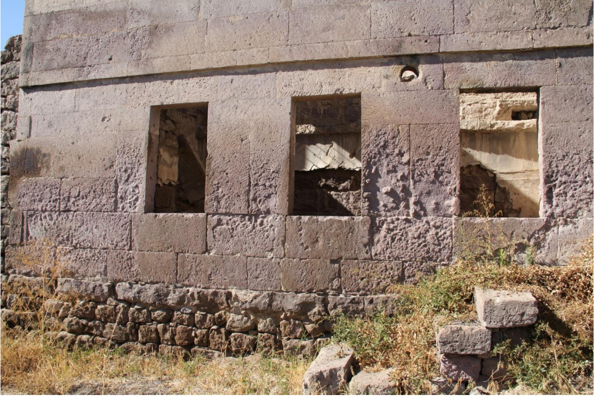
Şekil 147. Güney duvarı batı bölümündeki pencere boşlukları
