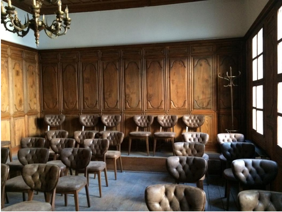
Şekil 6. Ahşap duvar kaplaması
