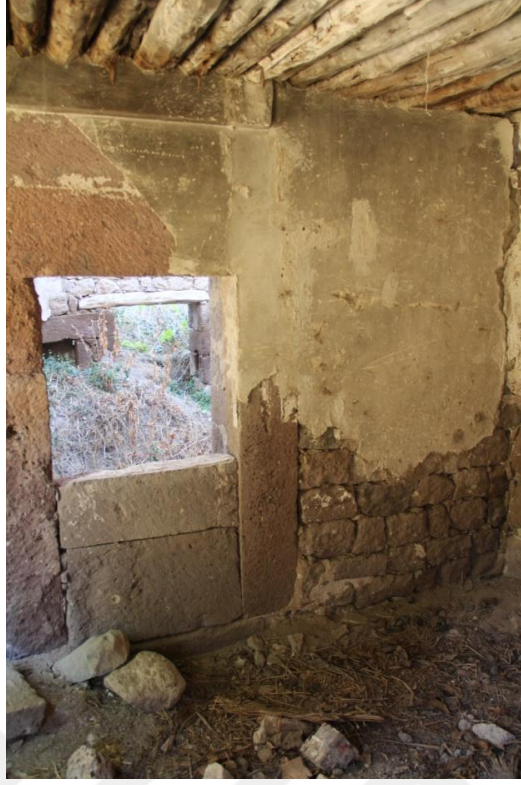
Şekil 48. Z01 mekanı doğu duvarı
