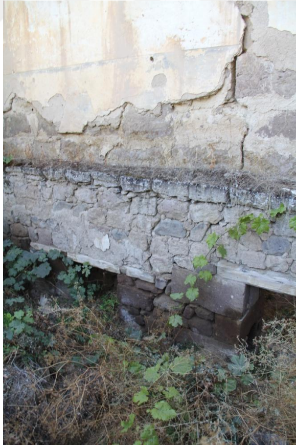
Şekil 91. Z07 mekanı batı duvarındaki niş
