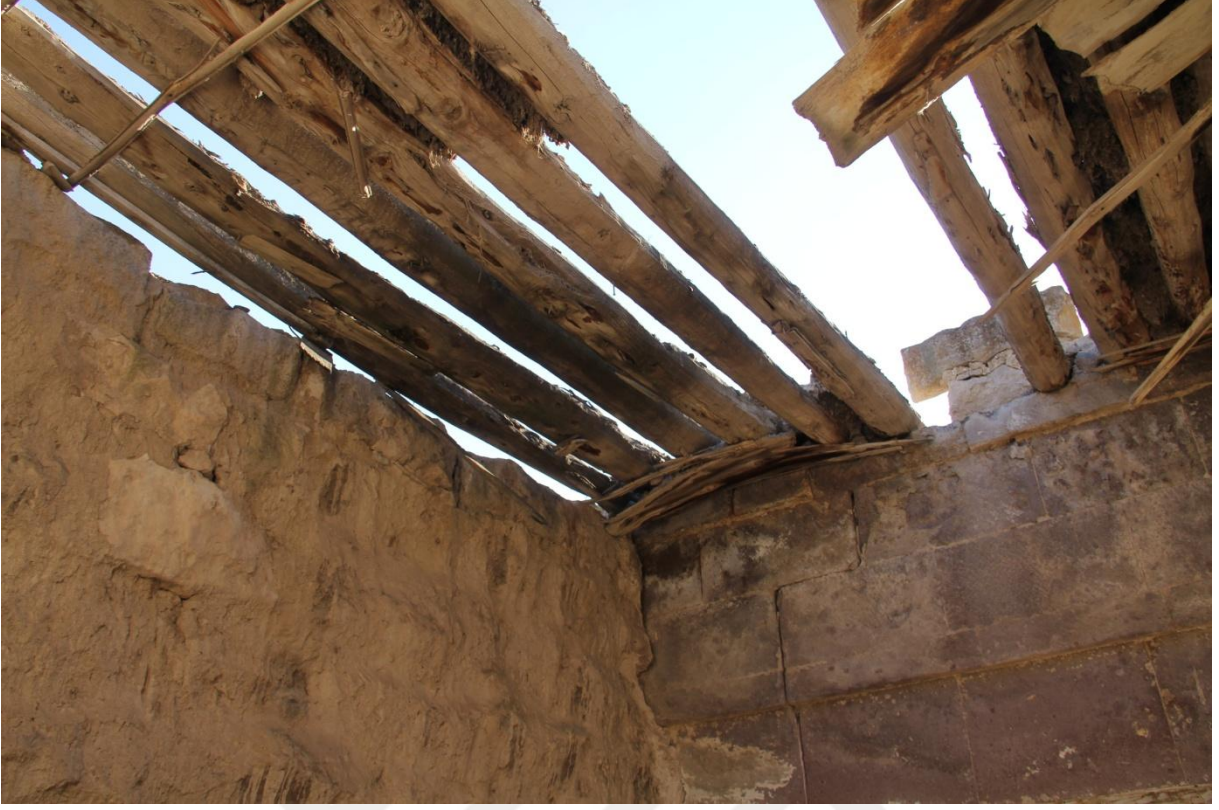
Şekil 102. 101 mekanı ahşap kirişler ve kirişleri taşıyan yatay taşlar
