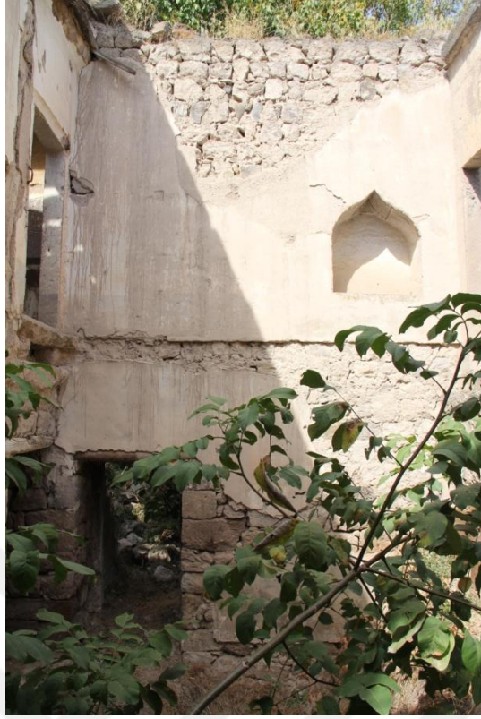
Şekil 122. 105 mekanı kuzey duvarı ve niş
