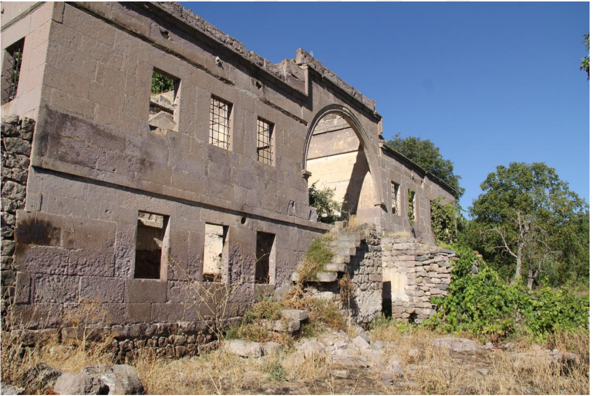
Şekil 143. Güney duvarı görünümü
