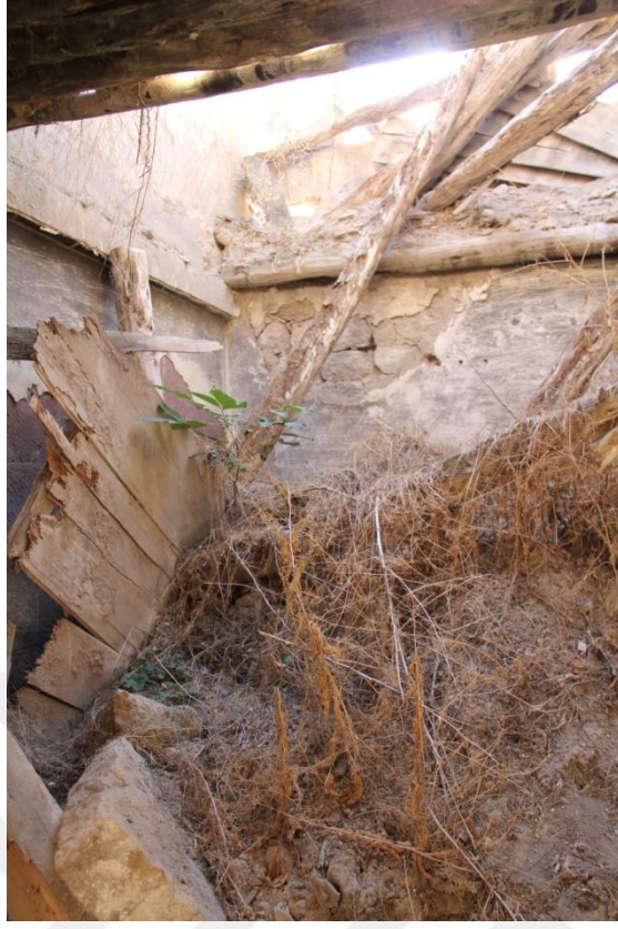
Şekil 66. Z03 mekanı batı ve güney duvarı
