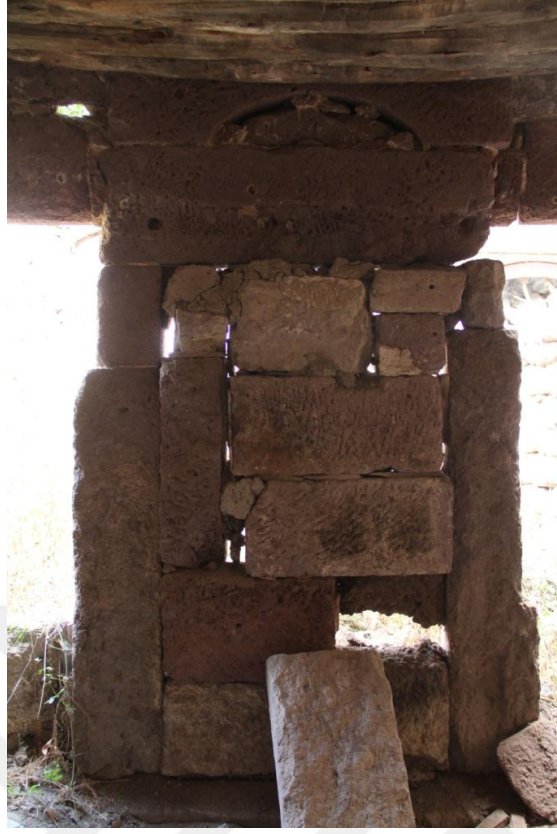
Şekil 46. Z01 mekanı kuzey duvarında taş ile örülen kapı boşluğu
