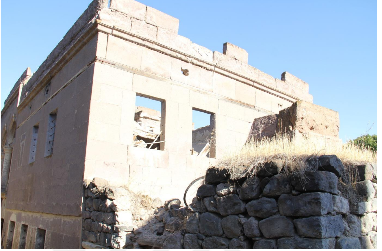
Şekil 140. Batı duvarı görünümü
