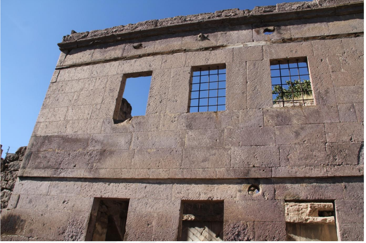
Şekil 146. Güney duvarı batı bölümündeki pencere boşlukları
