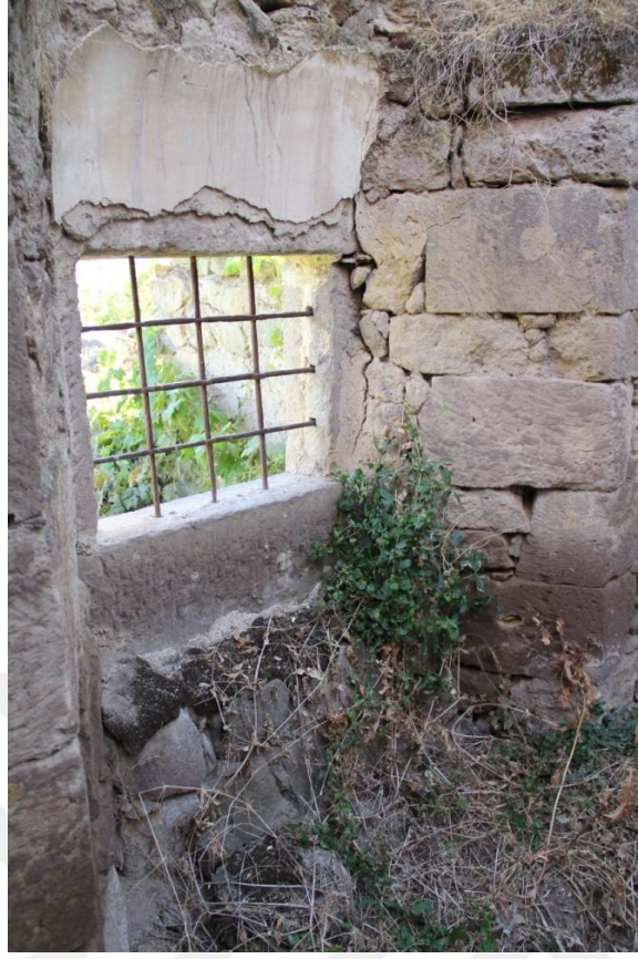
Şekil 86. Z06 mekanı güney duvarında bulunan pencere boşluğu
