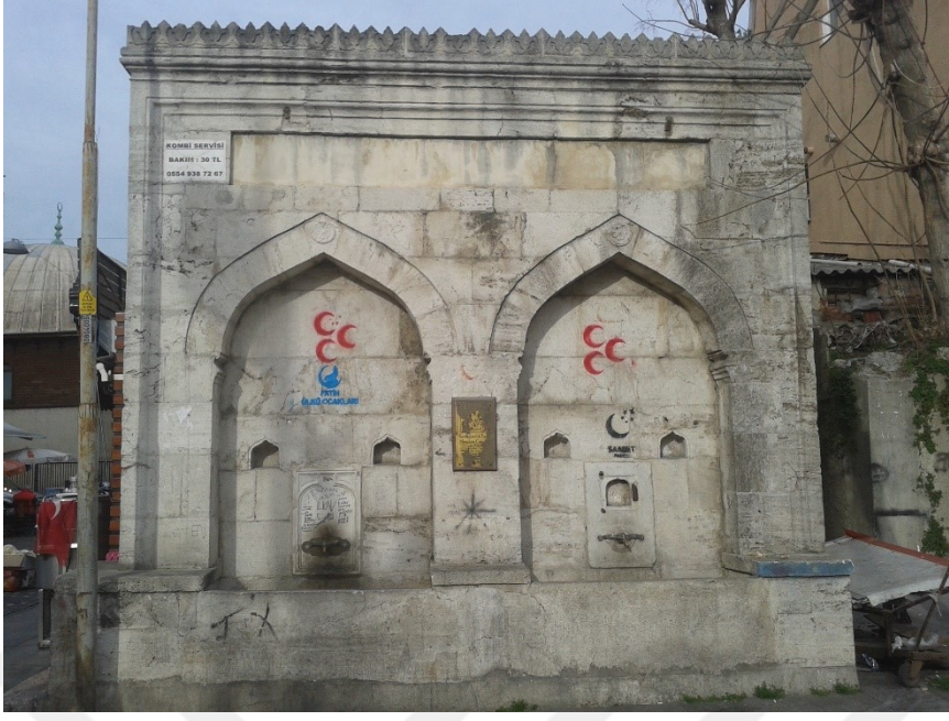
Resim 6.32 Çeşme Güney Cephesi Görünüşü
