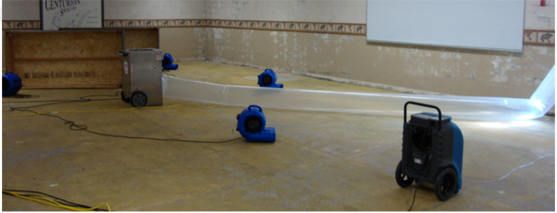
Resim 4.4 Su Hasarlarına Müdahale
