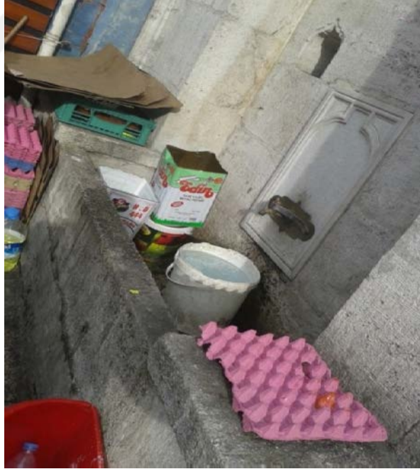
Resim 6.36 Köşelerdeki Yüzey Erimeleri Ve Form Kaybı
