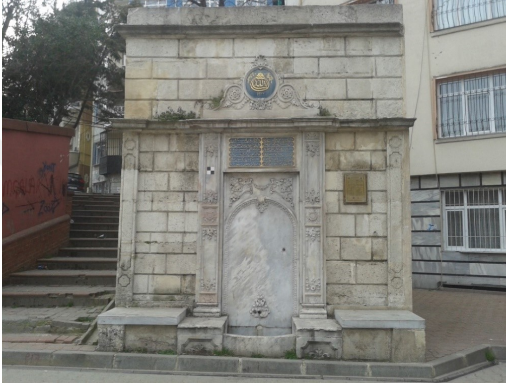
Resim 6.17 Doğu Cephesi Görünüşü
