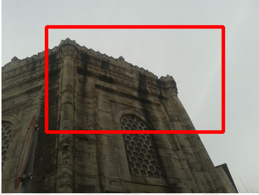
Resim 6.8 Hüsrev Paşa Türbesi Saçak Mukarnaslardaki Erimeler ve Dendanlardaki Parça Kopmaları
