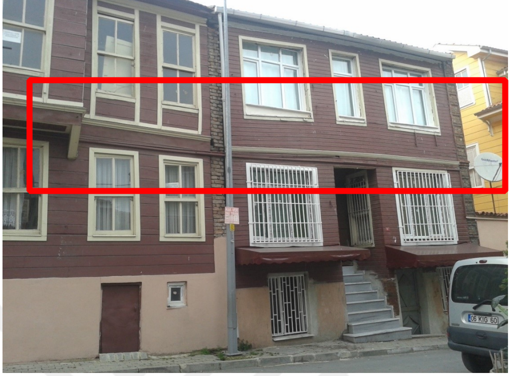
Resim 6.38 Zeyrek Ali Tekin Sokak Kat Döşemelerindeki Strüktürel Sapmalar
