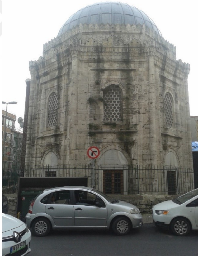
Resim 6.1 Hüsrev Paşa Türbesi Kuzey Cephesi Bitkilenme
