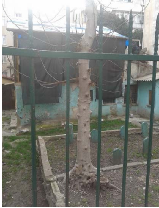
Resim 6.5. Türbedar Evi İzinsiz İnşaat Hali
