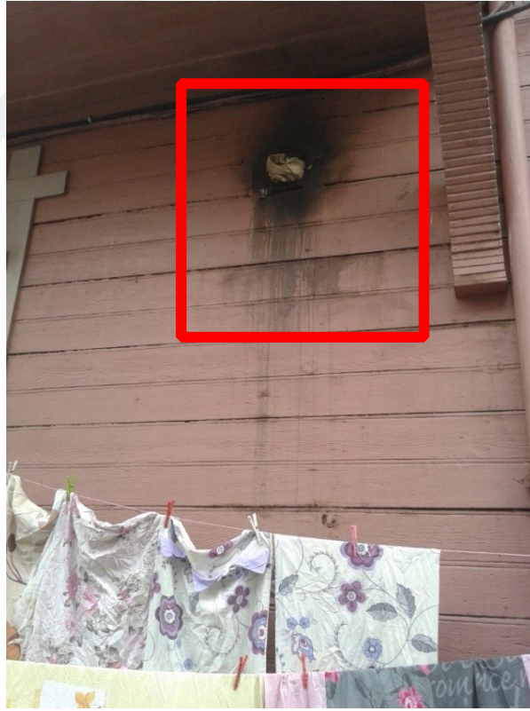
Resim 6. 44 Yanlıř Kullanımdan Kaynaklanan Ahřap Kaplama Bozulmaları
