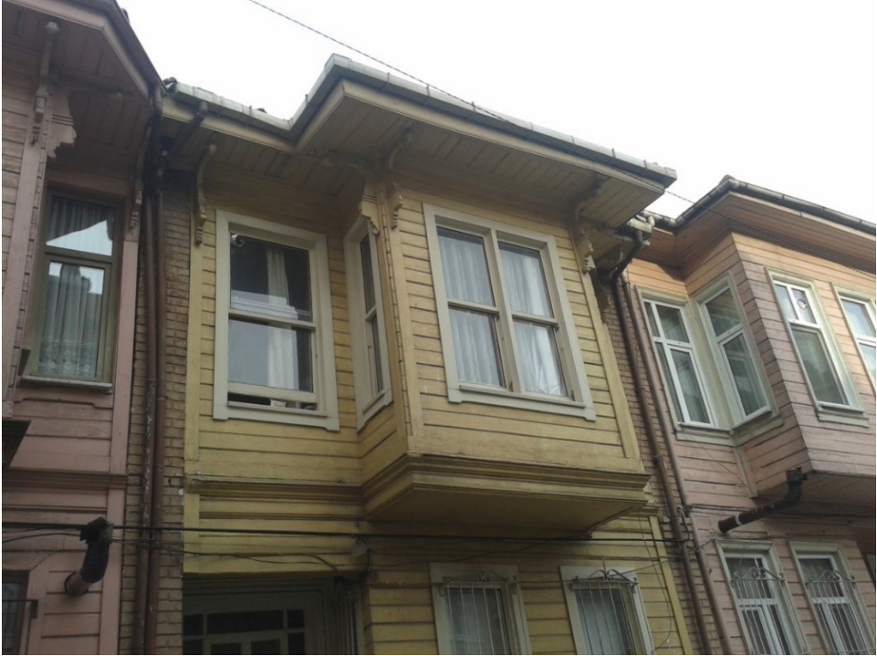
Resim 6.46 Salih Paşa Caddesi Ahşap Sıra Evler Görünüşü
