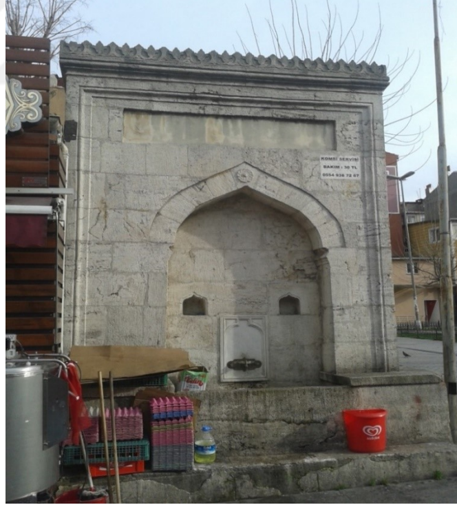
Resim 6.34 Doğu Cephesi Yüzey Kirlenmeleri
