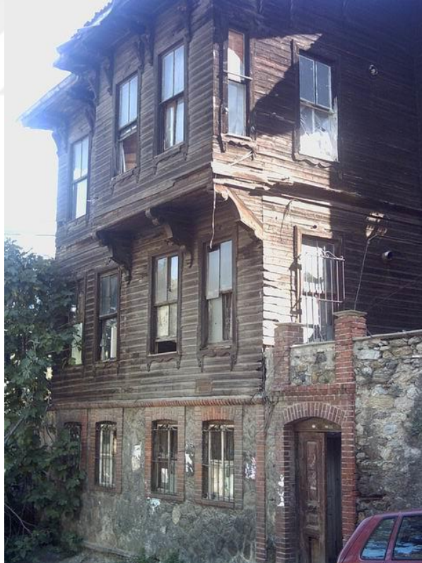
Şekil 3.79: Tunus Bağı Caddesi, Dönme Dolap Sokak, No:31 (126 ada, 2 parsel)
