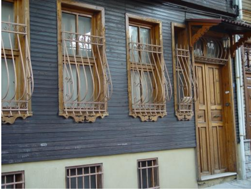
Şekil 3.41: Mehmet Paşa Değirmeni S.No:22 (379 ada, 5parsel)
