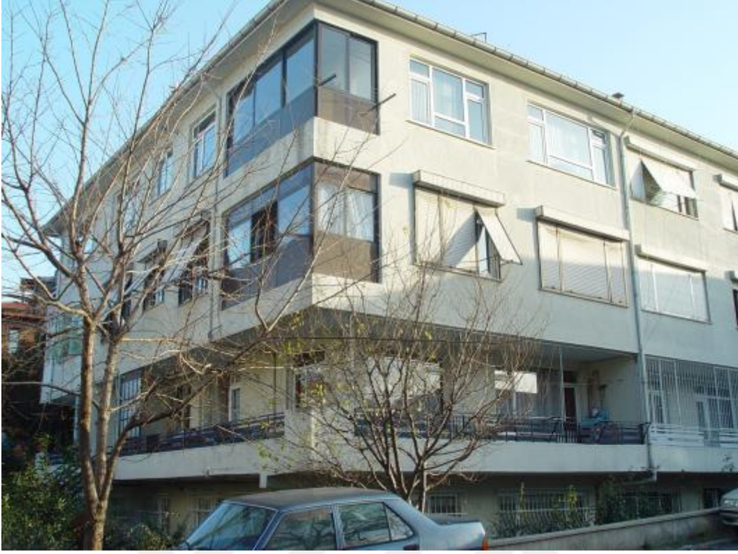
Şekil 3.48: Tulumbacılar Sokak. No:9 (378 ada, 1 parsel)
