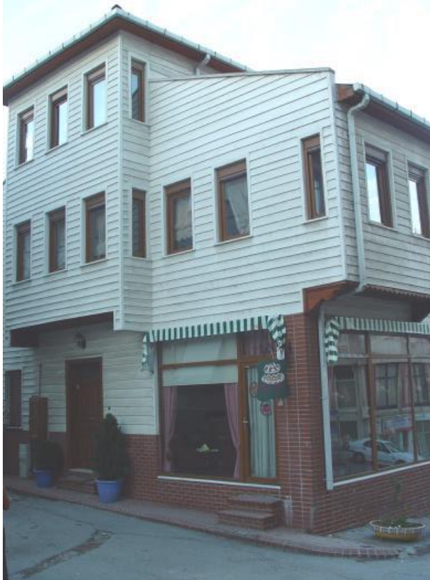
Şekil 3.55: Tebhirhane Sokak, No:2 (427 ada, 11 parsel)
