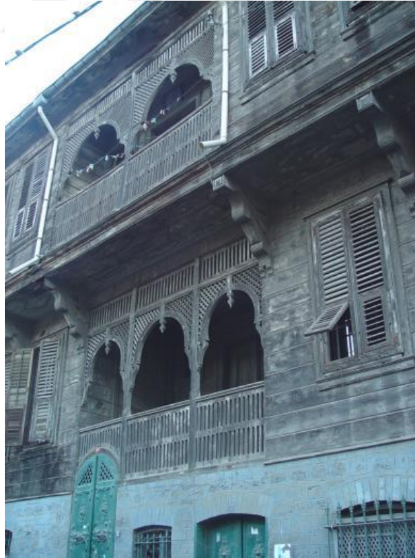
Şekil 3.57: Tebhirhane Sokak, No:6,8 (427 ada, 12 parsel)
