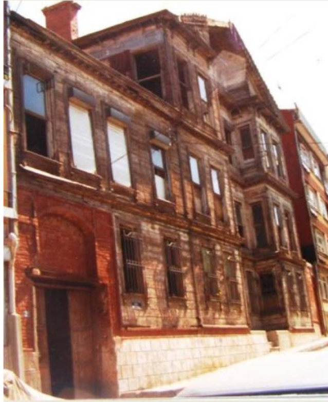
Şekil 3.5: Konağın Restorasyondan Önceki Durumu (1995)
