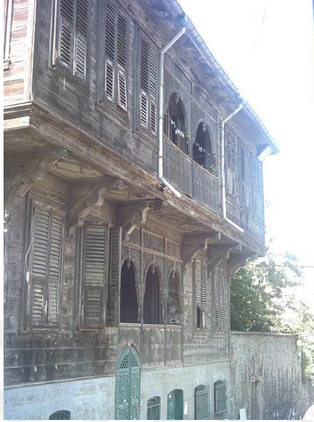
Şekil 3.56: Tebhirhane Sokak, No:6,8 (427 ada, 12 parsel)
