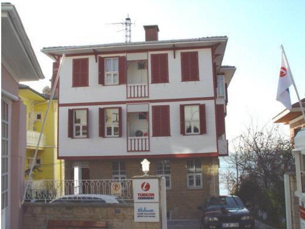
Şekil 3.23: Egemen Sokak, No:11 (353 ada, 38 parsel)
