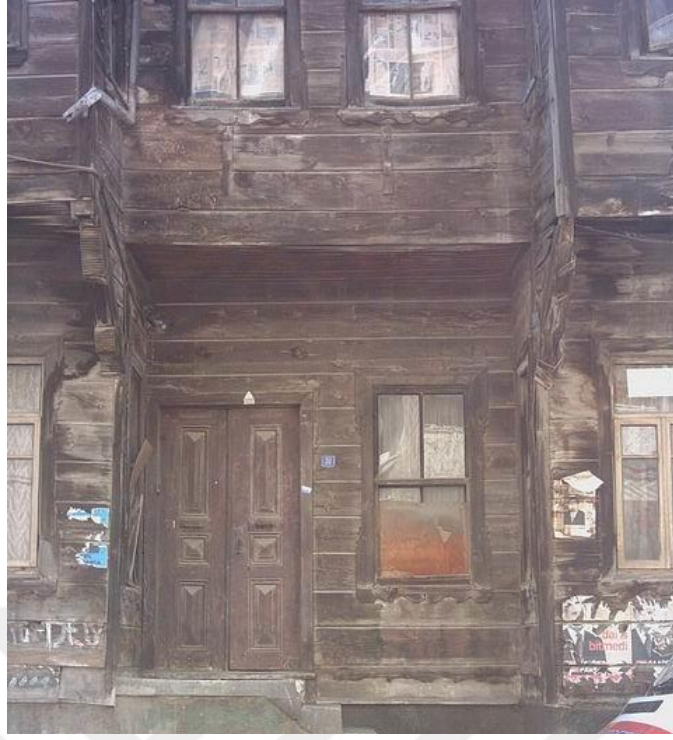
Şekil 3.78: Tunus Bağı Caddesi, Dönme Dolap Sokak, No:31 (126 ada, 2 parsel)
