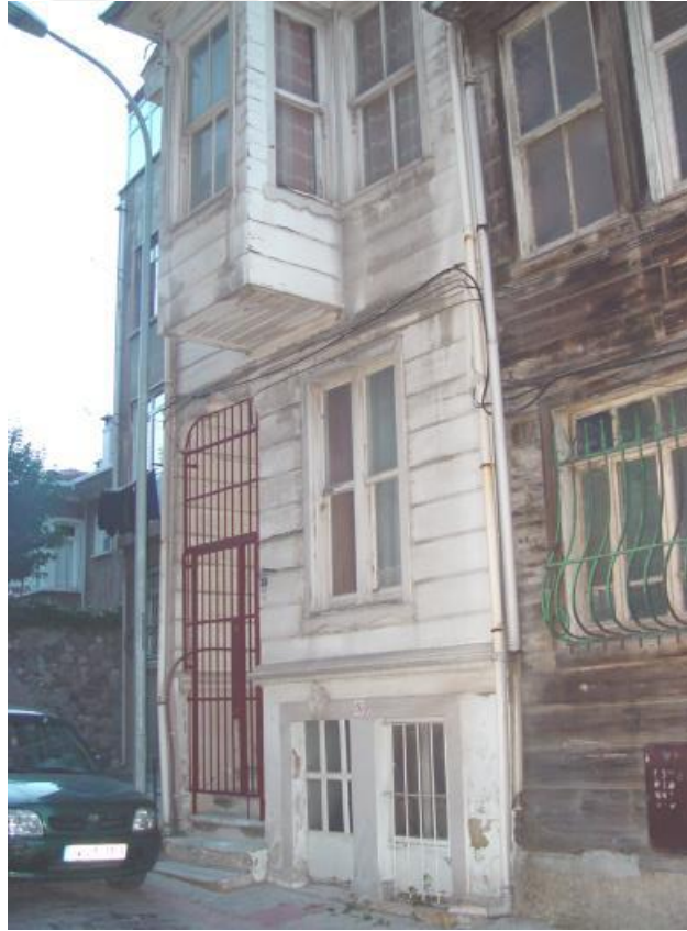
Şekil 3.75: Kaptan Paşa Camii S. No:8 (401 ada, 8 parsel)
