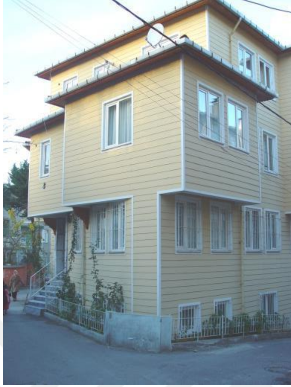
Şekil 3.58: Eşref Saati Sokak, No:31 (427 ada, 14 parsel)
