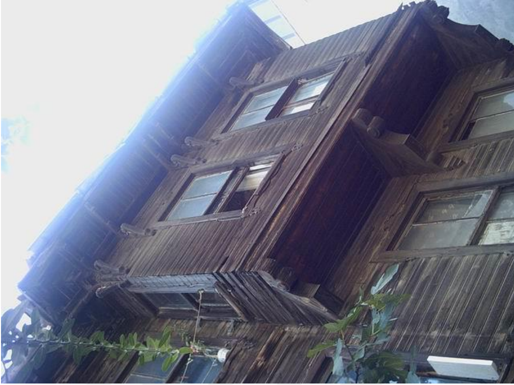
Şekil 3.80: Tunus Bağı Caddesi, Dönme Dolap Sokak, No:1 (127 ada, 4 parsel)
