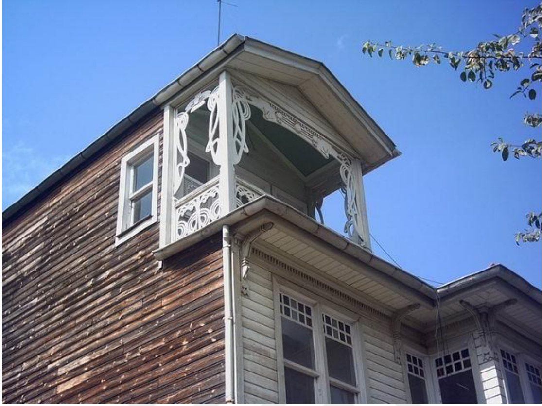
Şekil 3.82: Beylerbeyi Mahallesi, Eski Çınar Sokak, No:37
