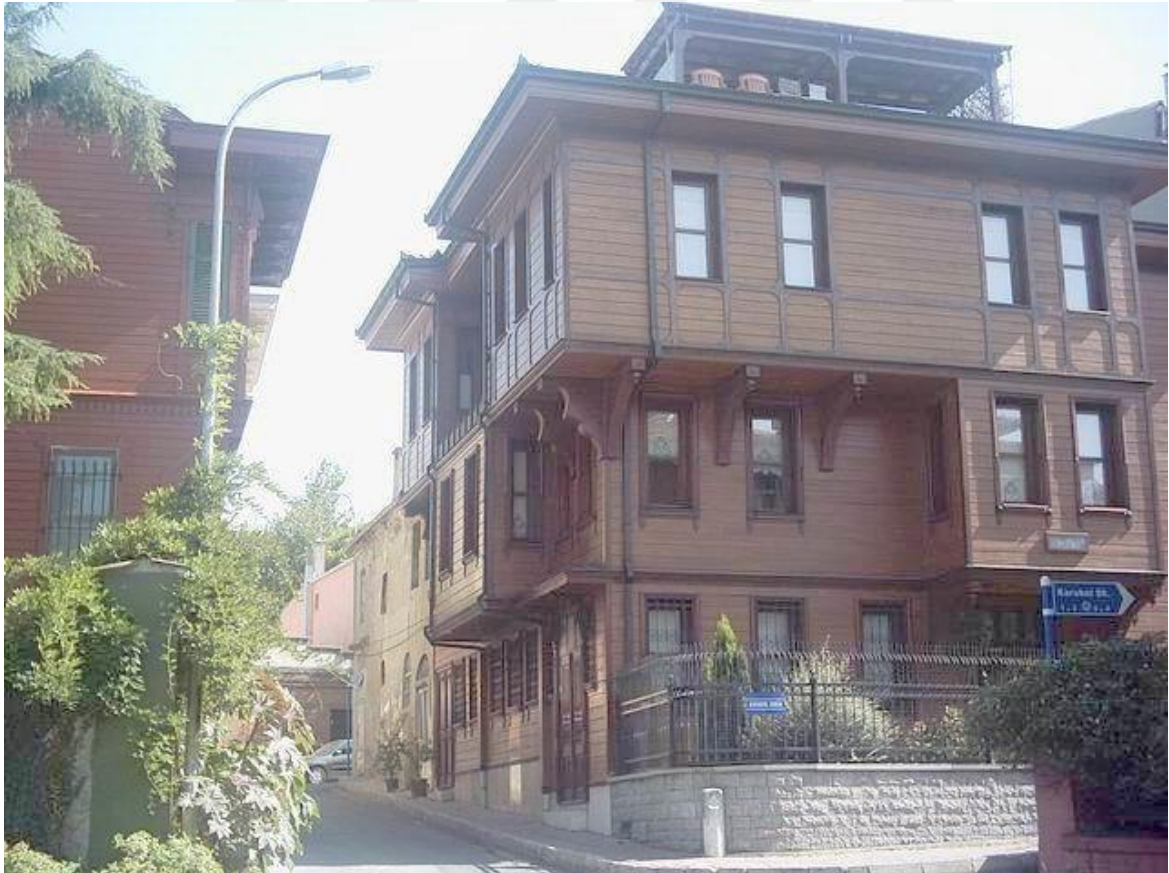
Şekil 3.43: Tulumbacılar Sokak, No:3,5 (374 ada, 1-2 parsel)
