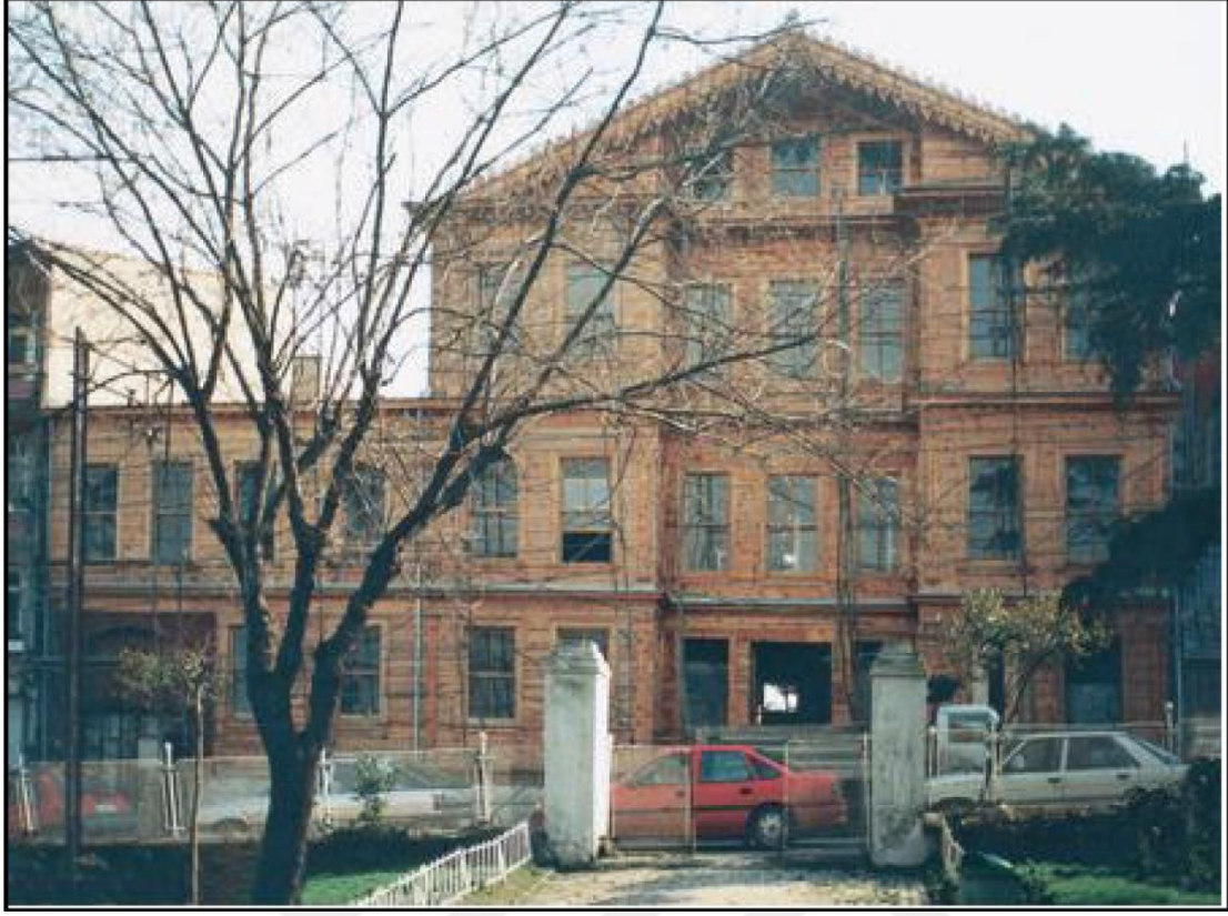
Şekil 3.7: Konağın Restorasyondan Sonraki Durumu (2000)
