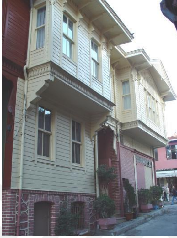
Şekil 3.46: Tulumbacılar Sokak, No:2 (373 ada, 7 parsel)
