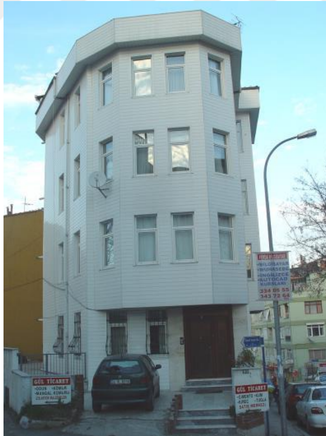
Şekil 3.59: Eşref Saati Sokak, No:90 (428 ada, 6 parsel)
