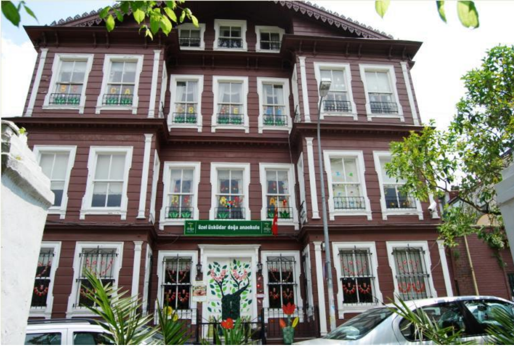
Şekil 3.11: Konağın Ön Cephesinin Restorasyondan Sonraki Durumu (Aras L., 1991)
