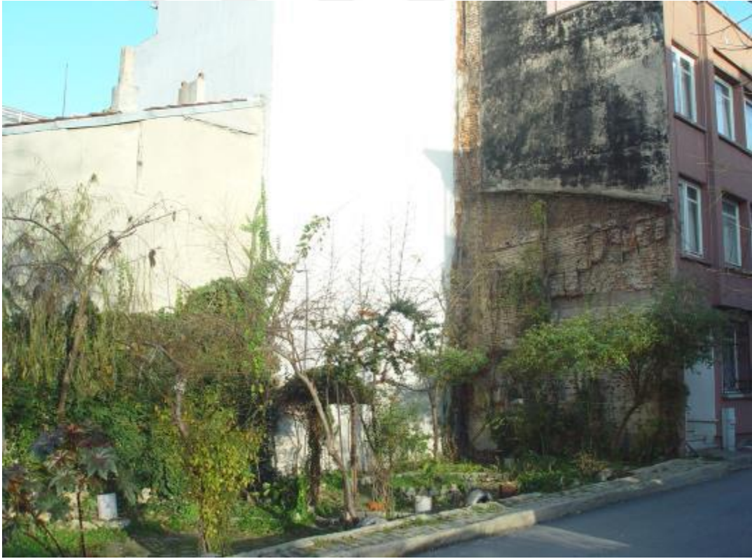
Şekil 3.49: Tulumbacılar Sokak, No:16 (380 ada, 4 parsel)
