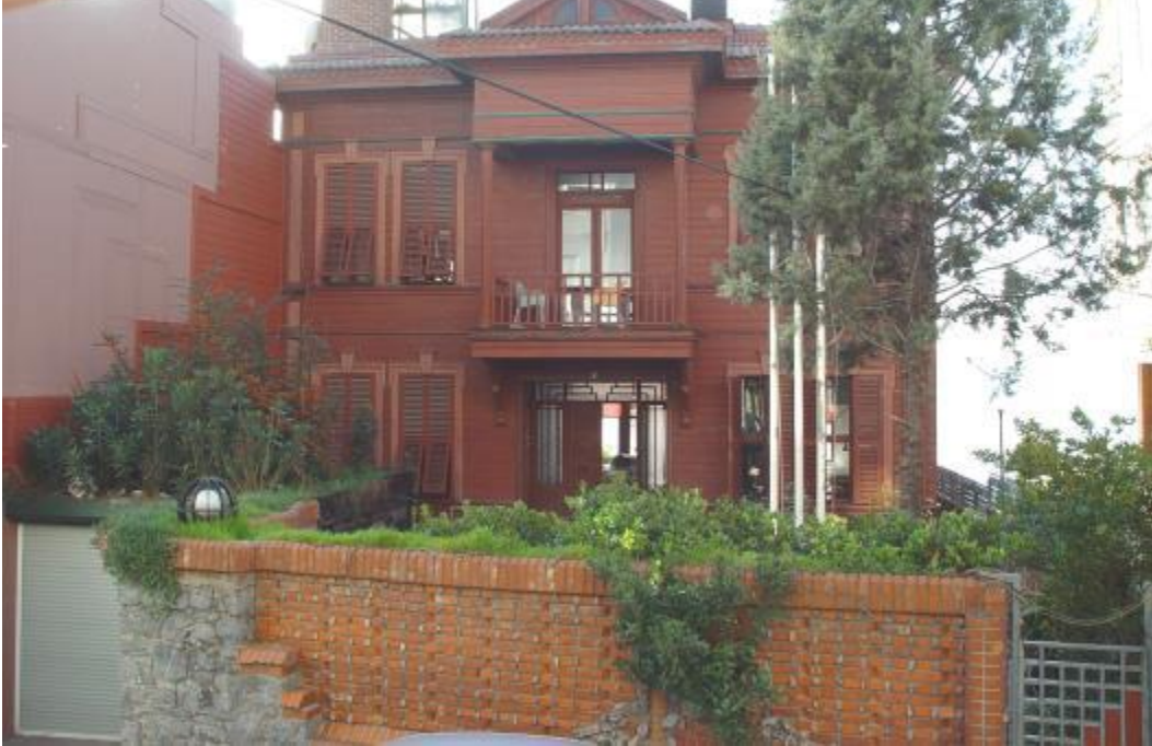
Şekil 3.21: Egemen Sokak, No:7 (353 ada, 34 parsel)
