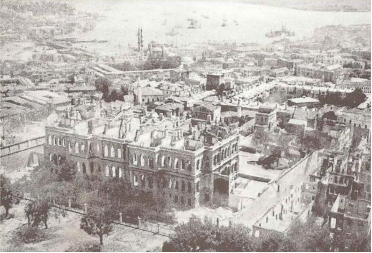
Şekil 2.20: 1911 Yılında Mercan'daki Yangın Sonrası Ali Paşa Konağının Durumu (Eldem, S. H., 1984)
