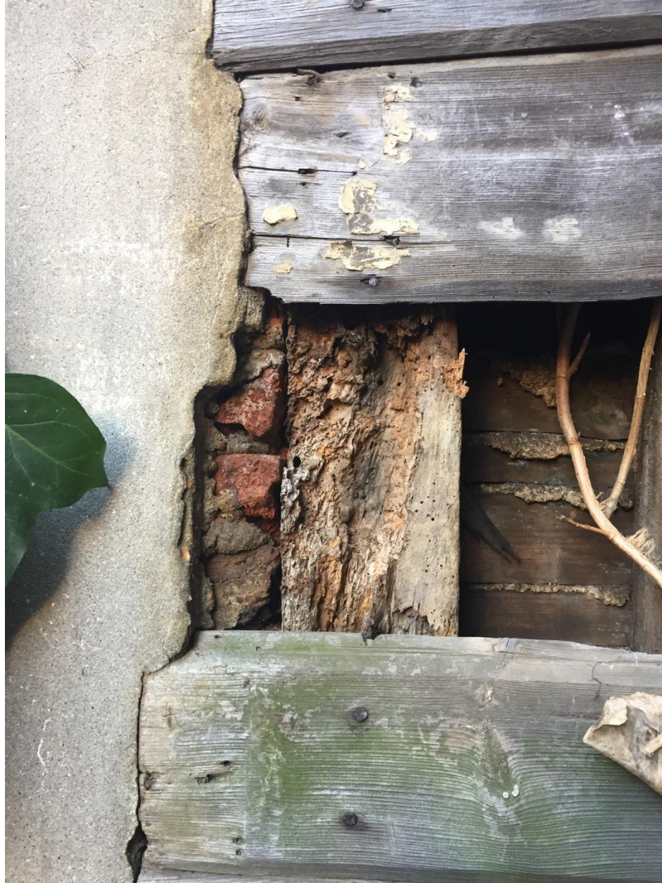
Fotoğraf 82: Mutfak Cephesi (Ahşap Ve Tuğla Birleşimi)
