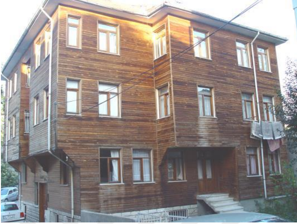
Şekil 3.50: Veliolu Sokak, No:4 (373 ada, 1 parsel)
