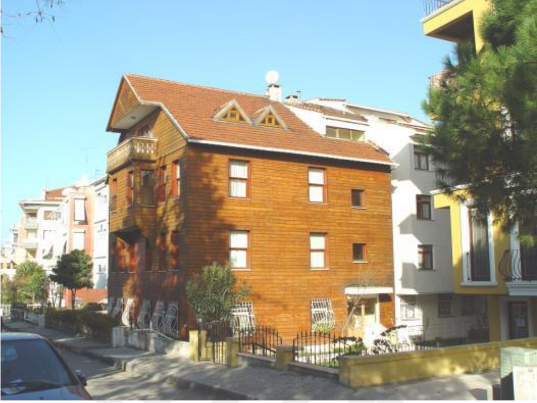
Şekil 3.18: Topraklı Tahir Sokak, No:10 (361 ada, 18 parsel)
