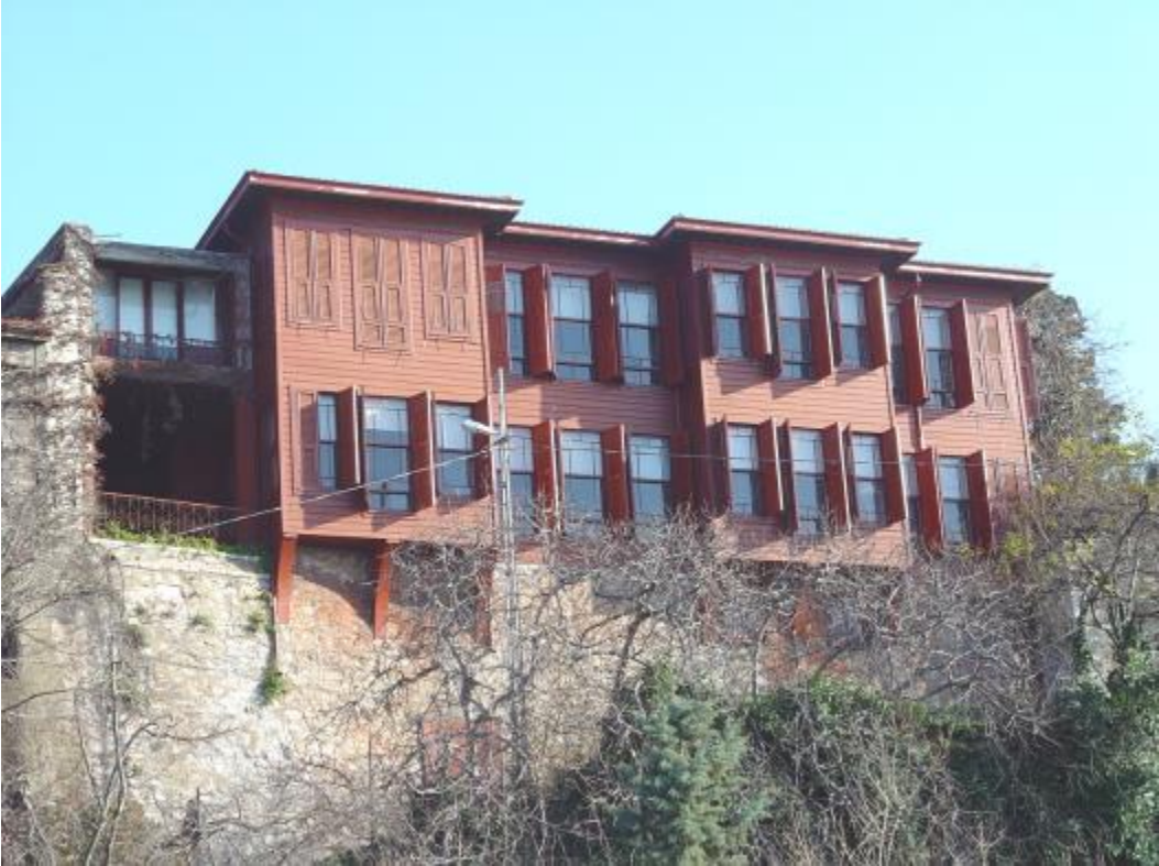
Şekil 3.19: Kuruntu Sokak, No:5 (368 ada, 25 parsel)
