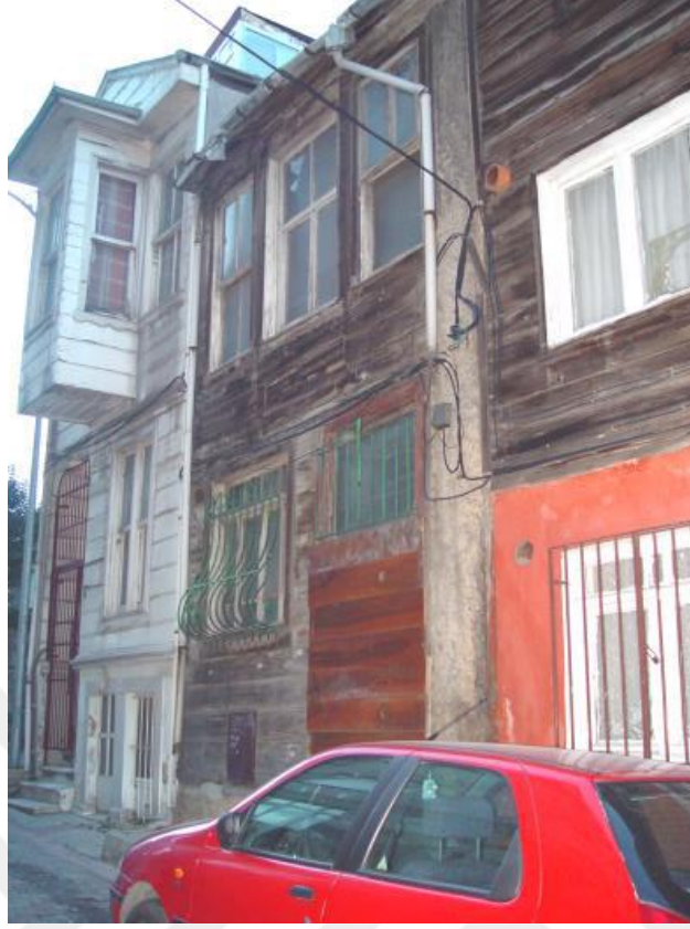
Şekil 3.74: Kaptan Paşa Camii S. No:6 (401 ada, 5 parsel)
