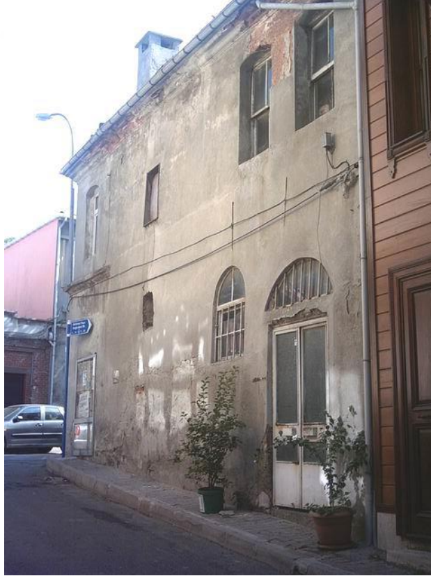
Şekil 3.47: Tulumbacılar Sokak, No:1 (374 ada, 3 parsel)
