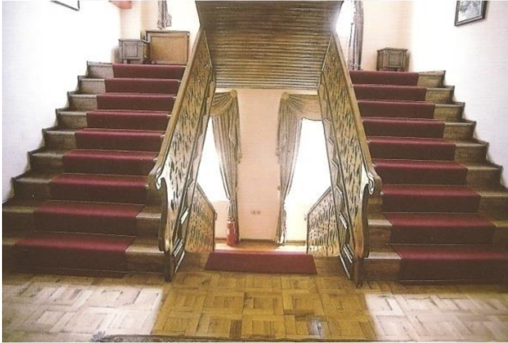
Şekil 3.9: Konağın Selamlık Merdiveninin Restorasyondan Sonraki Durumu (Aras L., 1991)
