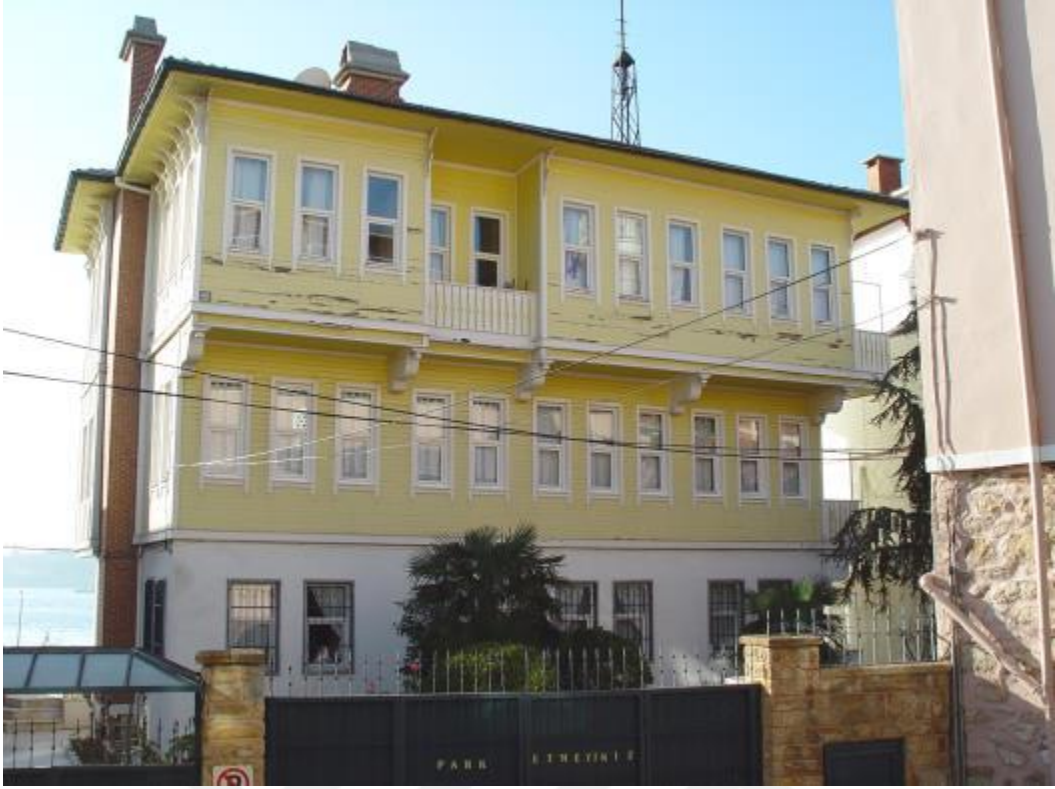
Şekil 3.22: Egemen Sokak, No:9 (353 ada, 40 parsel)
