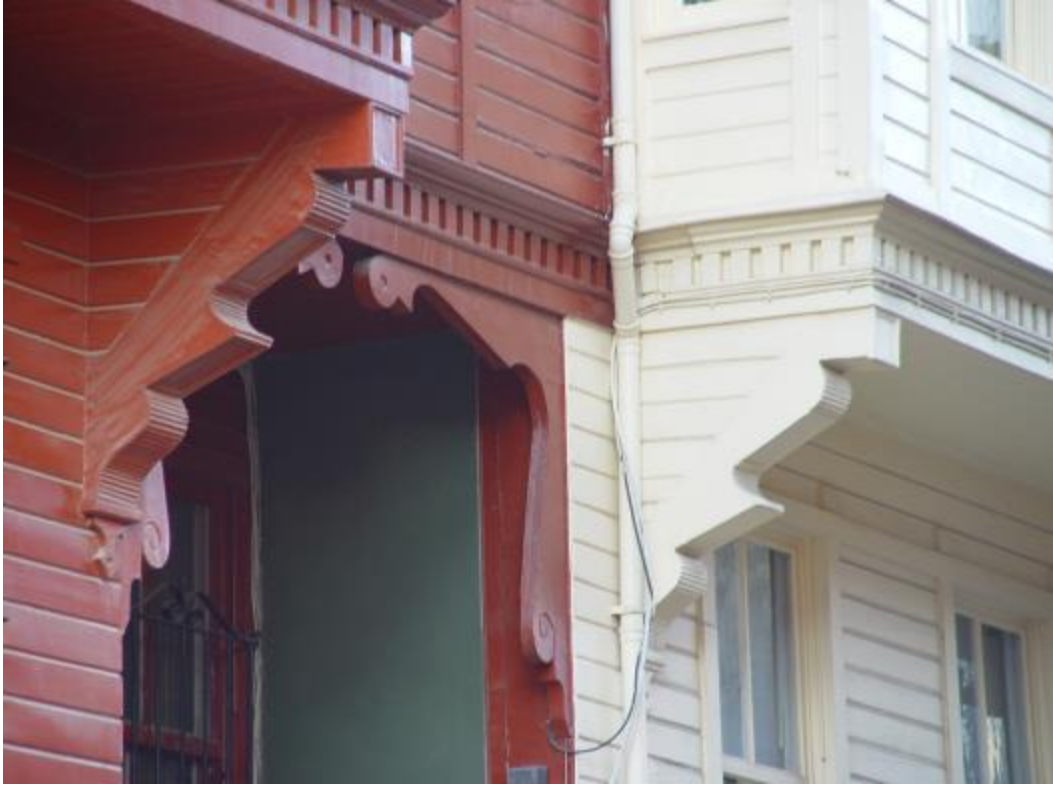
Şekil 3.45: Tulumacılar Sokak, No:4 (373 ada, 8 parsel)
