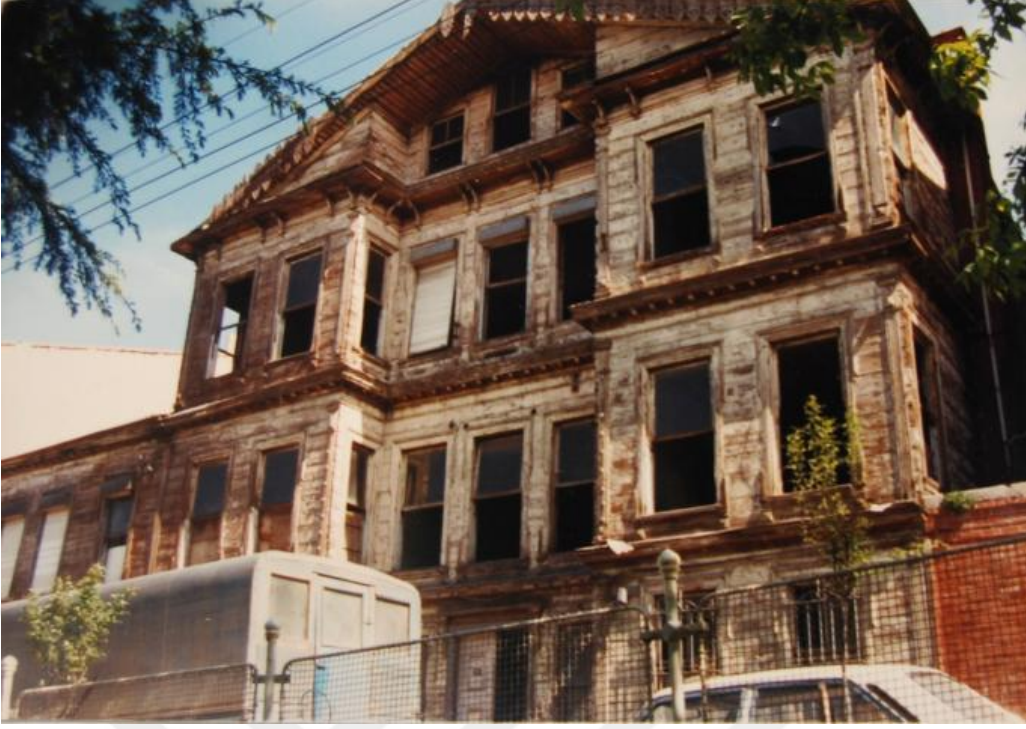
Şekil 3.10: Konağın Ön Cephesinin Restorasyondan Önceki Durumu (Aras L., 1991)
