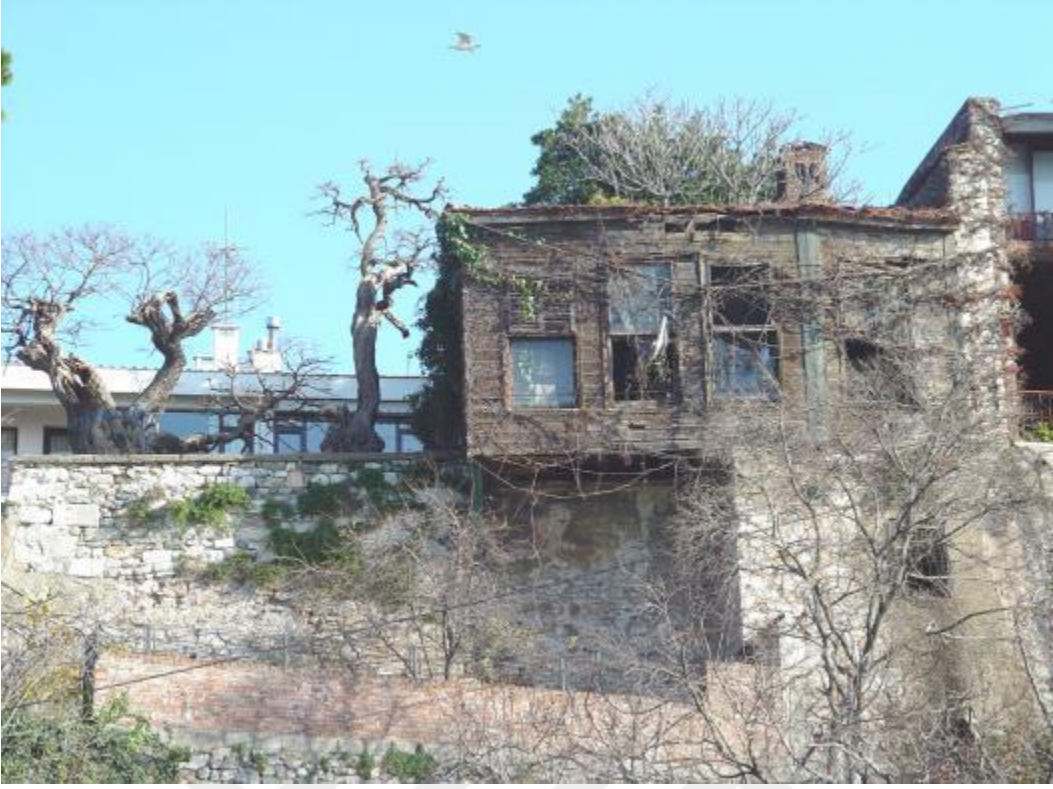
Şekil 3.20: Kuruntu Sokak, No:7 (368 ada, 16 parsel)
