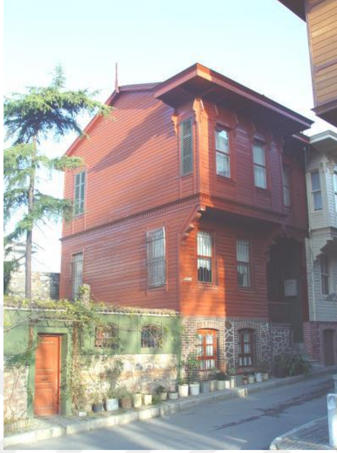
Şekil 3.44: Tulumacılar Sokak, No:4 (373 ada, 8 parsel)
