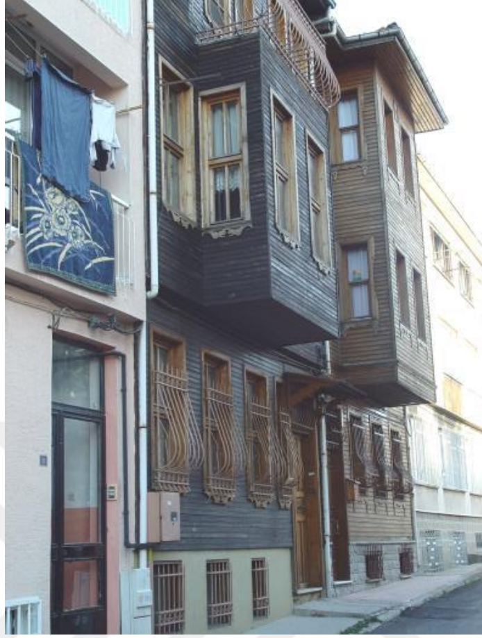
Şekil 3.40: Mehmet Paşa Değirmeni S. No:24, 22 (379 ada, 5-6 parsel)
