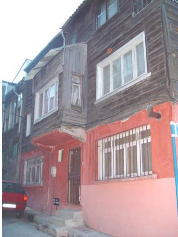
Şekil 3.73: Kaptan Paşa Camii S. No:4 (401 ada, 7 parsel)
