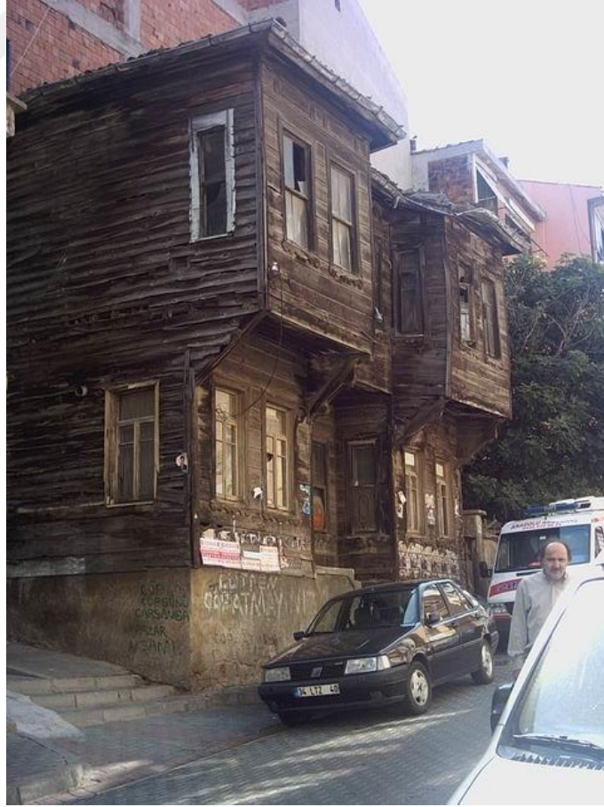
Şekil 3.77: Tunus Bağı Caddesi, Dönme Dolap Sokak, No:31(126 ada, 2 parsel)
