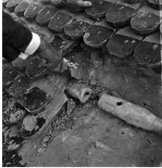
Şekil 4.35: Sidi İbrahim Riyahi Zaviyesinin K bbe yapı sistemi (kaynak: İNP arşivleri, 1967)
