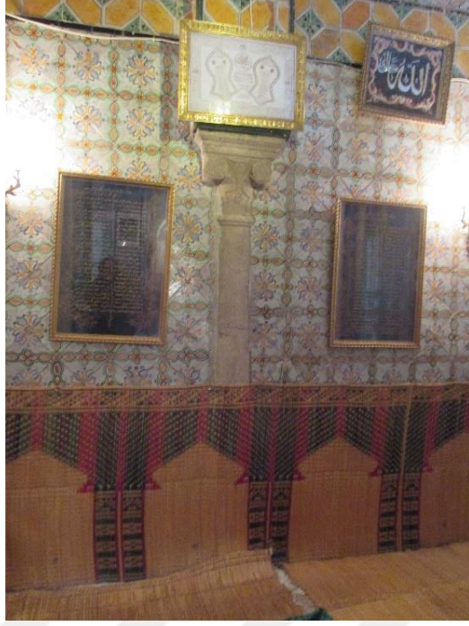
Şekil 4.15: Türbenin duvarında ankastre sütün (kaynak: Hazırlayan Çekimi, Ağostus 2017)
