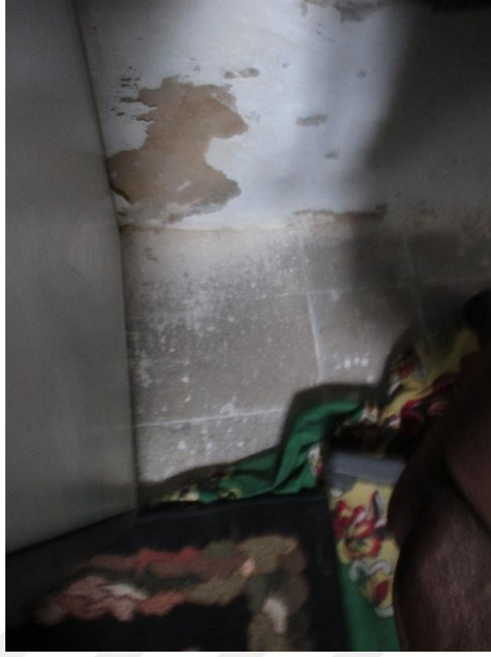
Şekil 4.18: Şeyh Odası'nda görünen zemin döşemesi (kaynak: Hazırlayan Çekimi, Aralık 2016)
