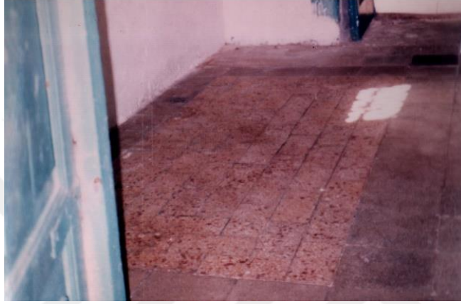
Şekil 5.11 : Mekan Z05'in döşemesi : orijinal karosiman yeni karosiman ile birleştirilmiş (Kaynak: Leyla Riyahi belgeleri– Aralık 2016)
