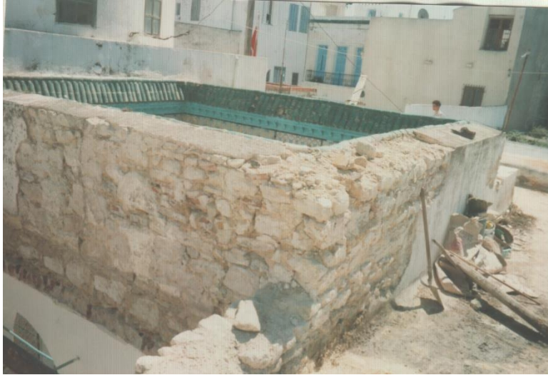
řekil 4.33: atıdan görünen tařıyıcı duvar örgüsü
