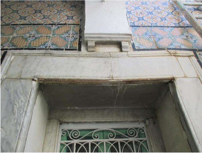
Şekil 4.48: Zaviyede Strüktür Hasarlar Örnekleri : Avlu (kaynak: Hazırlayan çekimi, Aralık 2016-Ağustos 2017)
