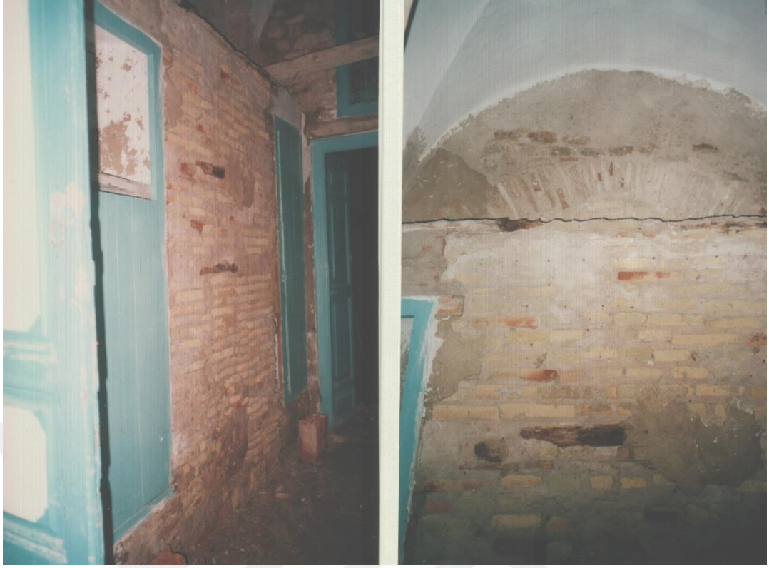
Şekil 4.34: Z05 hücresinde mihrap arkasındaki tuğla duvarı (kaynak: Layla Riyahi, Riyahi ailesinin 2000'deki tamir müdahalası)
