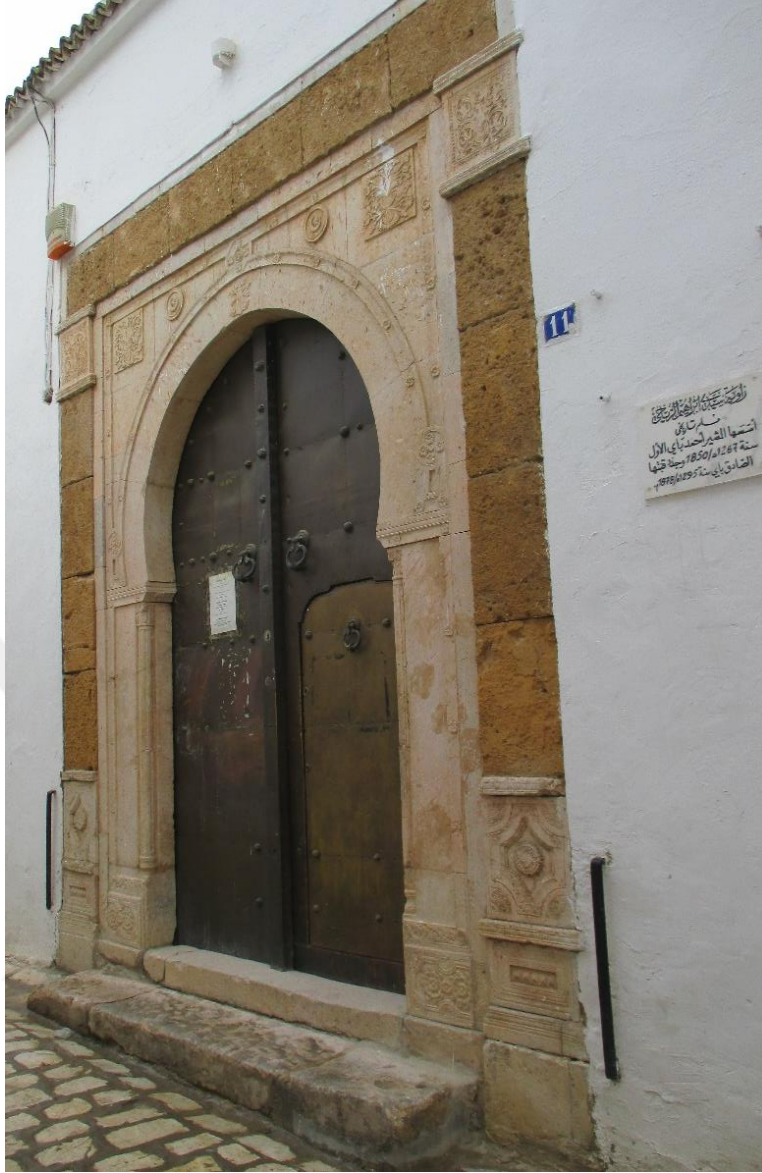
Şekil 4.28 : Giriş Kapısı Görünüşü
