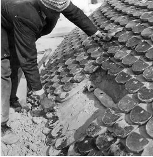
Şekil 4.35: Sidi İbrahim Riyahi Zaviyesinin K bbe yapı sistemi (kaynak: İNP arşivleri, 1967)
