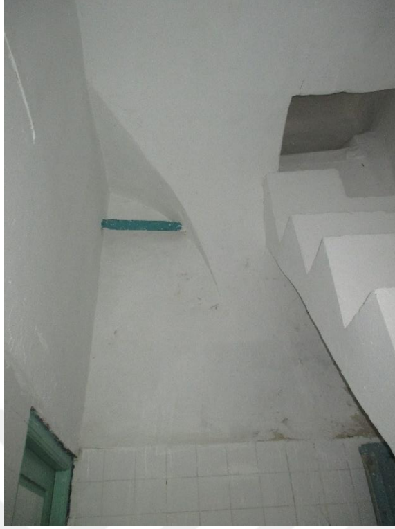
Şekil 4.26: tonoz /duvar sistemi (kaynak: Hazırlayan Çekimi, Aralık 2016)
