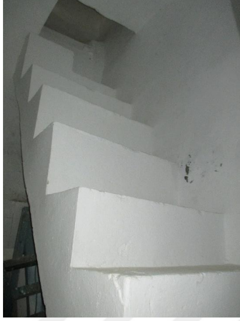
Şekil 4.45: Merdivenler Mevcut Hale
