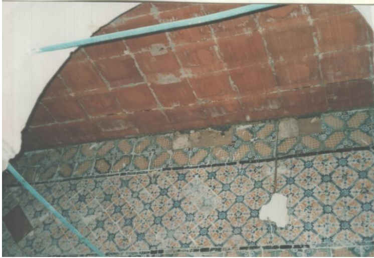
Şekil 4.37: Çatı görülen sistemleri ve 2000' de yapıldı müdahalesi sonucu (kaynak: Layla Riyahi, Riyahi ailesinin 2000'deki taamir müdahalası)
