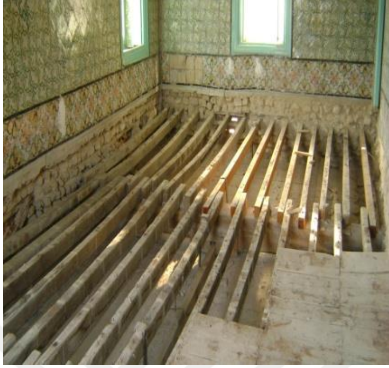
Şekil 5.16 : Bayram Konağında mermer döşeme sağlamlaştırması (Kaynak The Knowledge Hotels & Resorts Raporu. Bayram Konağı Restorasyon Projesi Tanımı- Tunus Belediyesi. 2005-2014).
