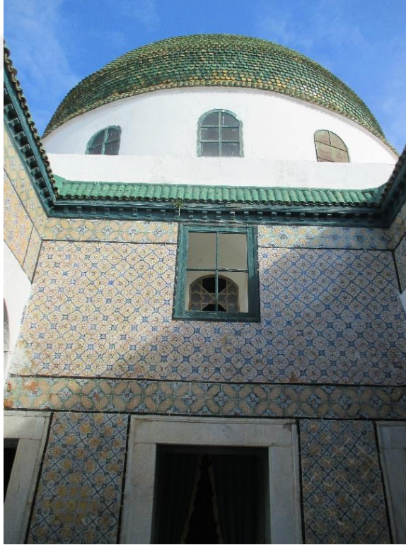
Şekil 4.32: İbadethane cephesindeki çini panolar, düz pencere, ahşaplı kiremitli silmesi ve Kübbe (kaynak: Hazırlayan Çekimi, Ağustos 2017)
