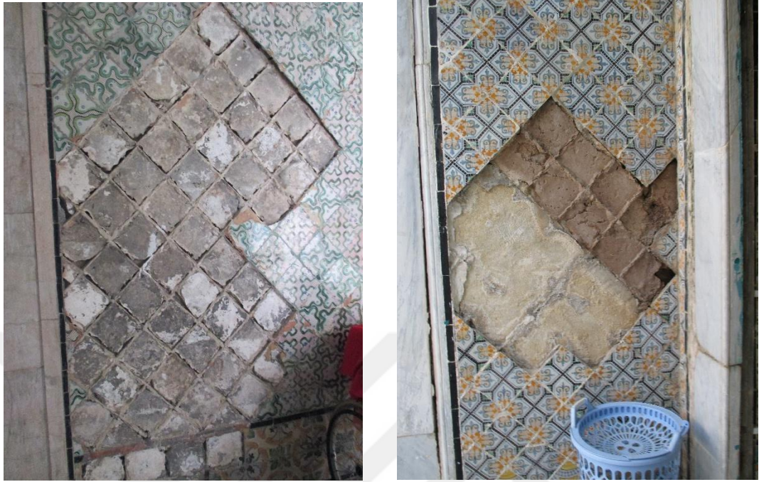
Şekil 4.47: Zaviyede Malzeme Kaybı Örnekleri : Giriş Holü – Avlu (kaynak: Hazırlayan çekimi, Aralık 2016-Ağustos 2017)
