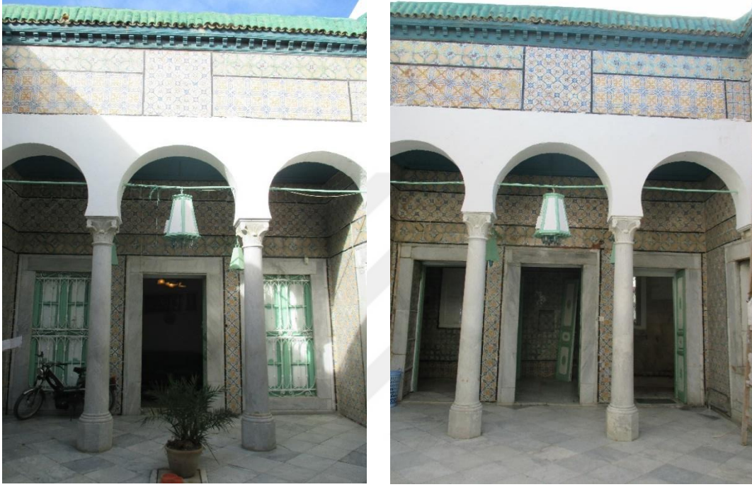
Şekil 4.30: Avlusunun Kuzey-Batı (Sağa) ve Güney-Doğu (Sola) Revakları (kaynak: Hazırlayan Çekimi, Ağustos 2017)
