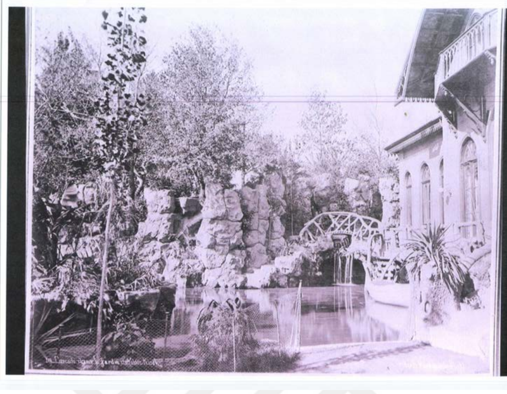
Şekil 4-25 Dal şekli korkuluk, köprü, nimfeum ve grotto görünüşleri (Kaskat Köşkü)
