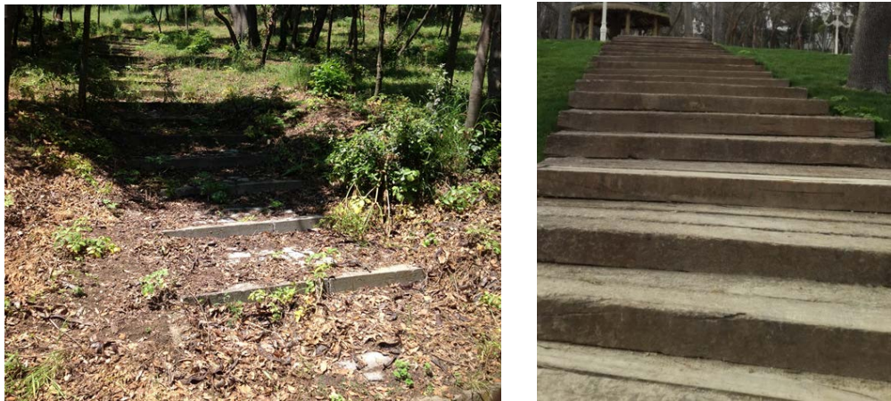
Şekil 5-95 Merdivenlerin müdahale öncesi durumu ve müdahale sonrası merdiven uygulaması (ZONTUR 2013;2014).
