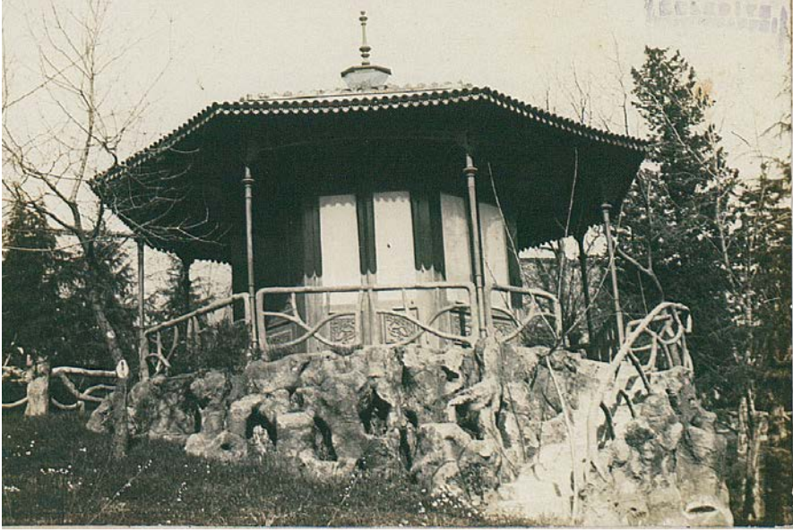
Şekil 5-13 Bahçede yer alan bahçe köşkü (Atatürk Kitaplığı, Albüm 156/2).
