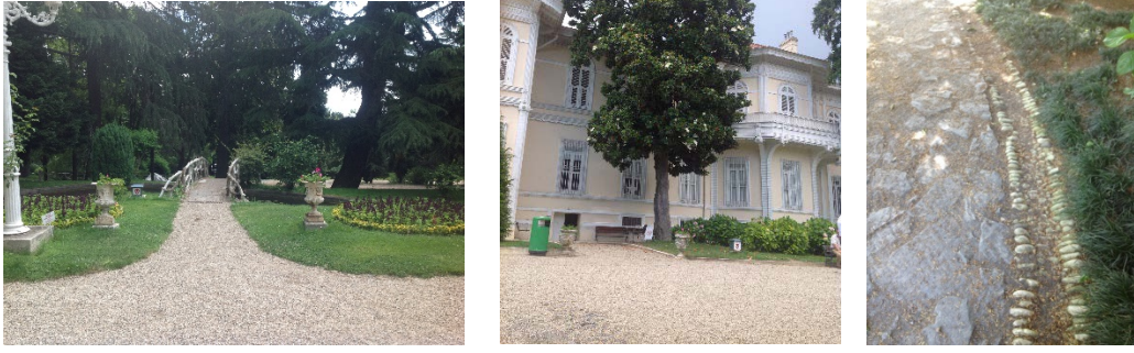
Şekil 5-92 İç bahçede, yollarda yer alan ince çakıl döşemesi ve orijinal yağmur kanalları (ZONTUR,2014).
