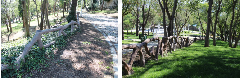
Şekil 5-37 Müdahale sonrası korkulukların durumu (ZONTUR,2017).
