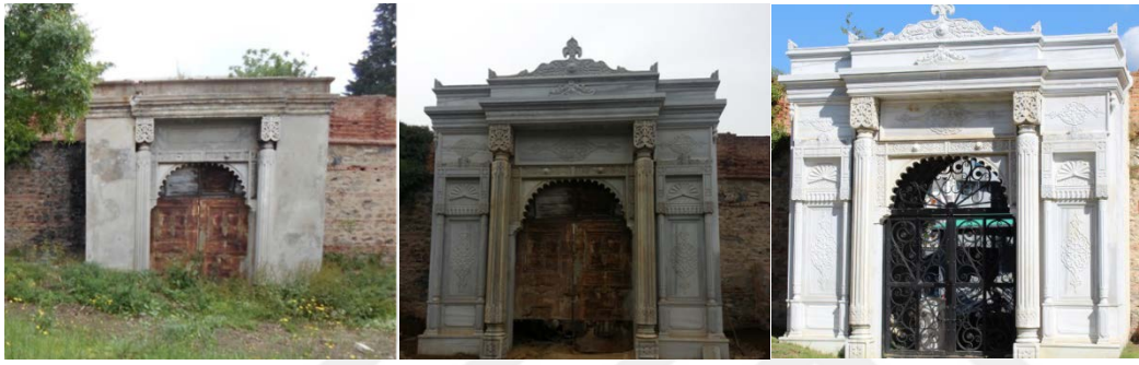
Şekil 5-67 Güney kapısı müdahale öncesi (ZONTUR, 2013), sonrası (ZONTUR,2014) ve güncel durumu (ZONTUR, 2017).
