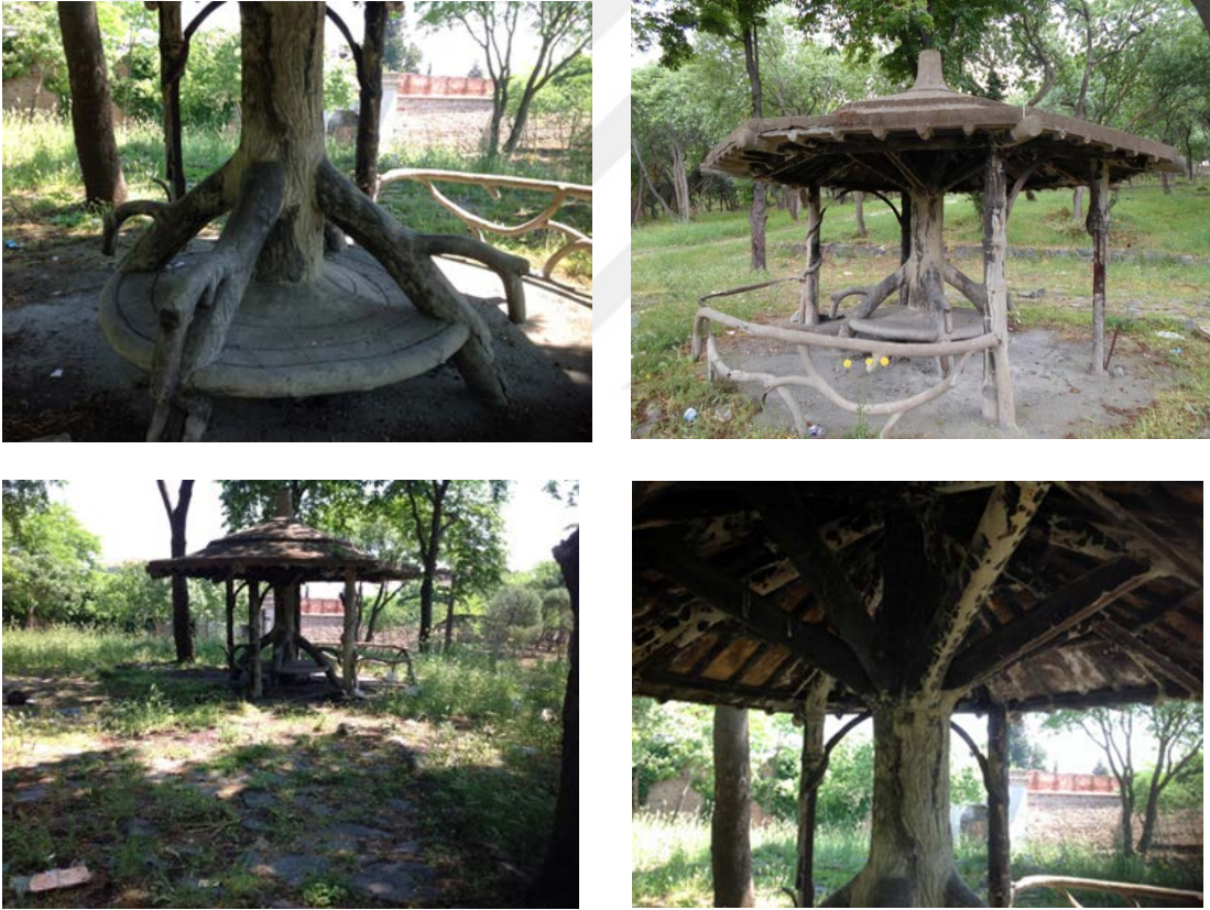
Şekil 5-25 Bahçe köşkünün müdahale öncesi durumu (ZONTUR, 2013).
