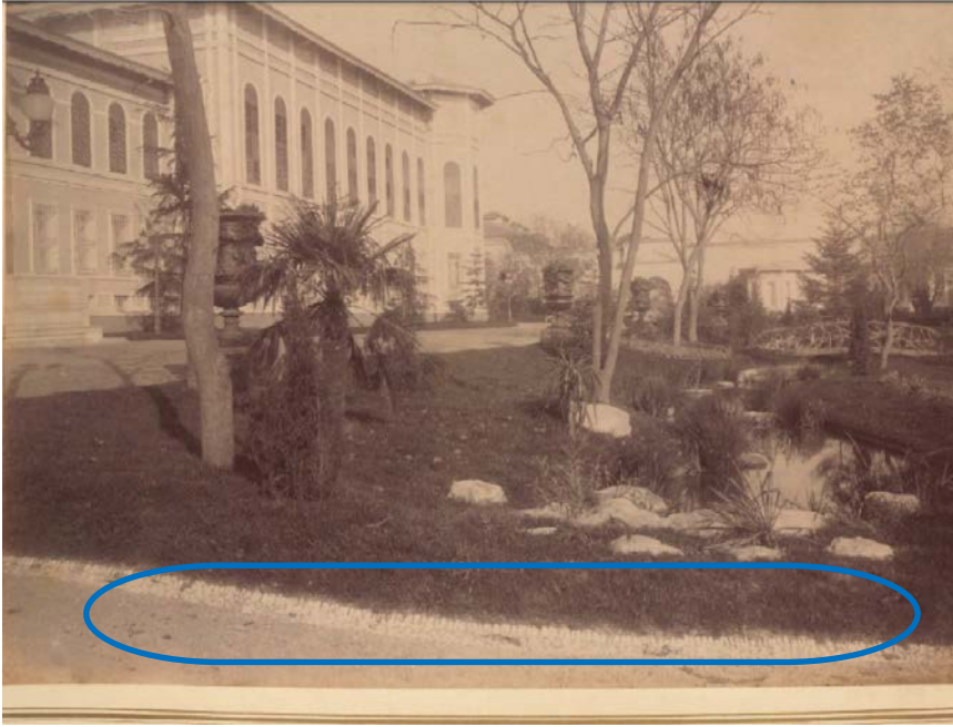
Şekil 5-93 Arşiv fotoğraflarında doğal zemin yollar ve kenarlarında açıkça görülen podima taşından yağmur kanalı uygulaması (TBMM Milli saraylar, 11/267 numaralı albüm).
