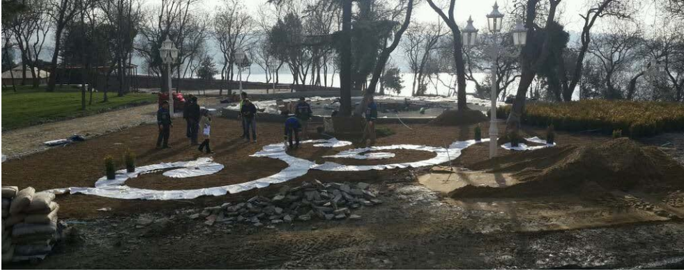
Şekil 5-60 Meydanın aplikasyonu sırasında şimşir çit desen için oluşturulan branda kalıp uygulaması (ZONTUR, 2014).
