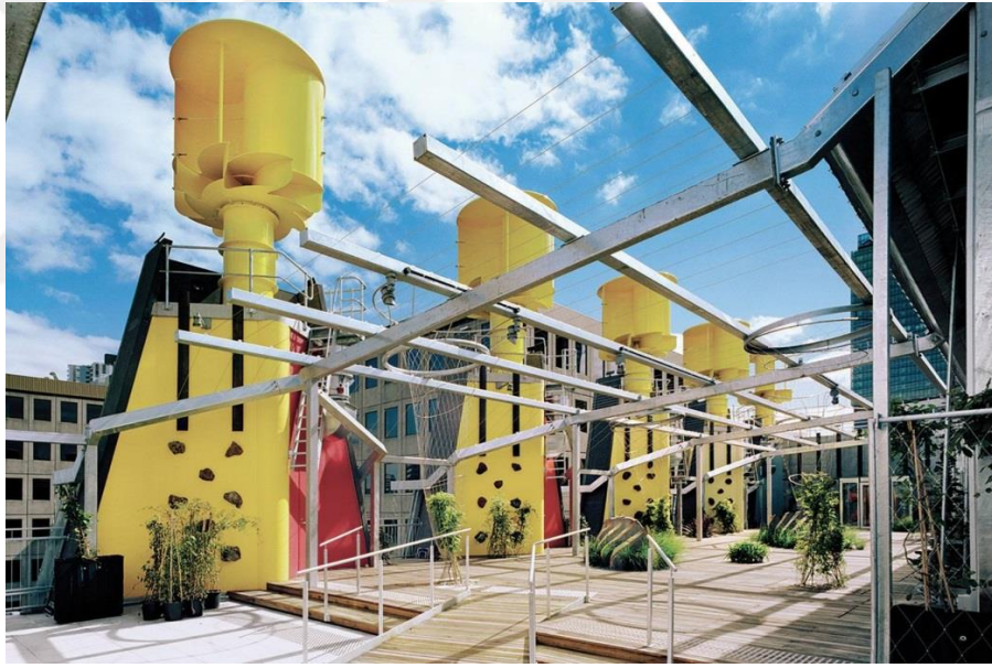
Resim 5.8: Çatıda bulunan rüzgâr türbinleri (Url-30).
