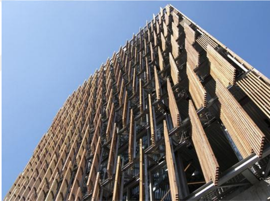
Resim 5.6: CH2 yerel yönetim binası cephe görünüşü (Url-30).
