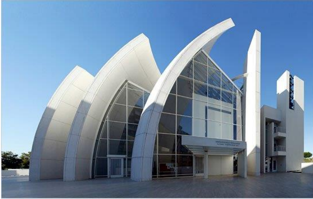
Resim 4.5: Yatay ve düşey dış gölgeleme elemanı (Url-20).
