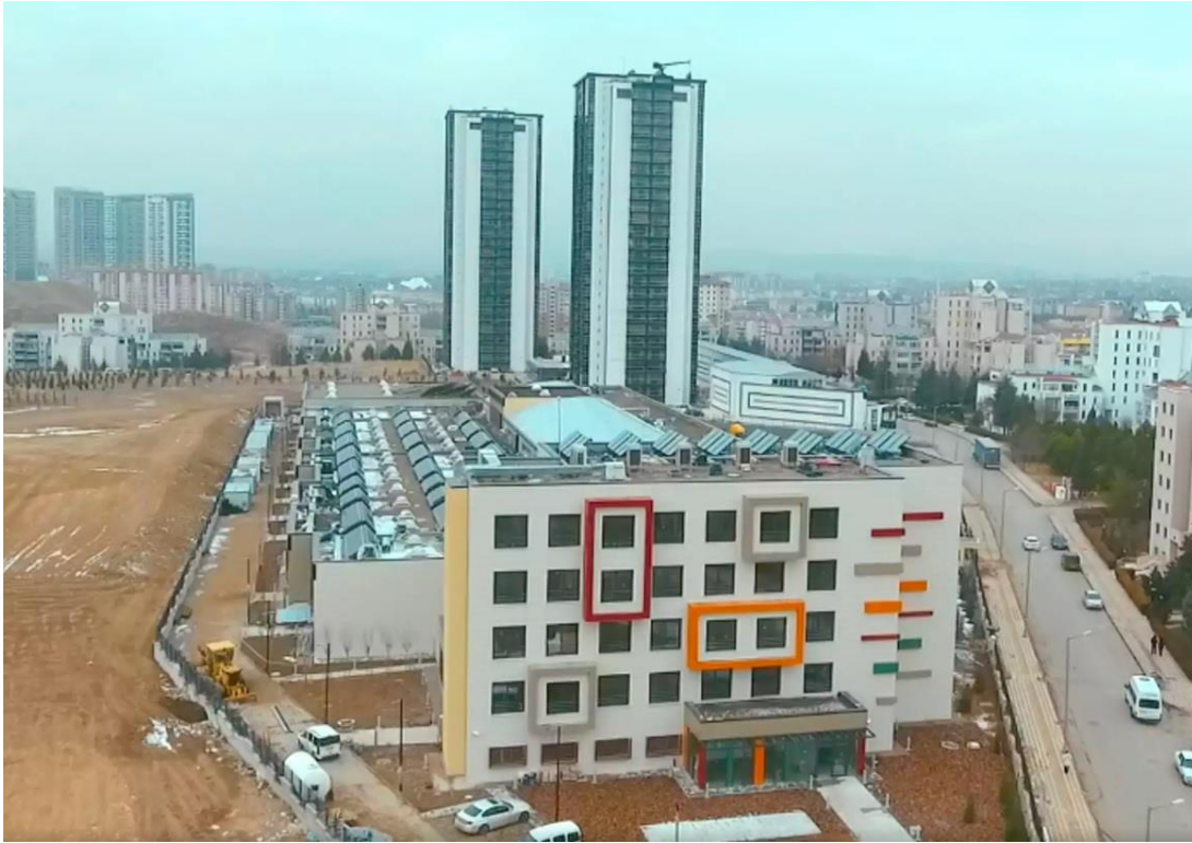
Resim 5.56: Cezeri yeşil teknoloji endüstri meslek lisesi çatı ve cephe görünümü (Url-57).
