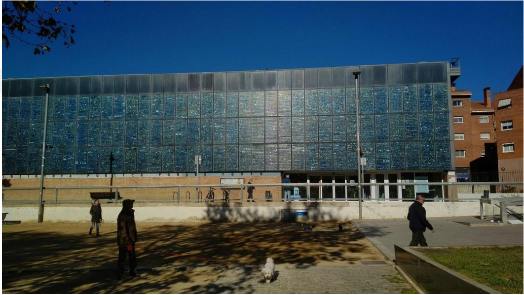
Resim 5.14: Güney cephesini kaplayan PV panellerden görünüm (Url-33).
