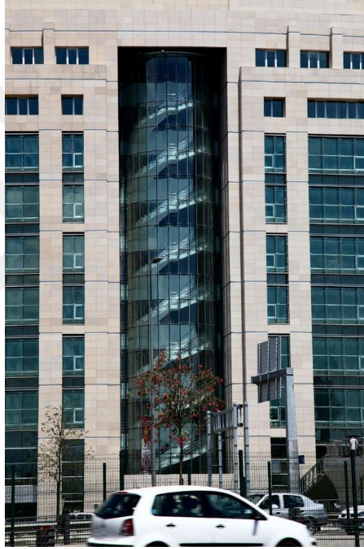
Resim 5.46: Merdiven kısmının doğal aydınlatılması (Url-52).
