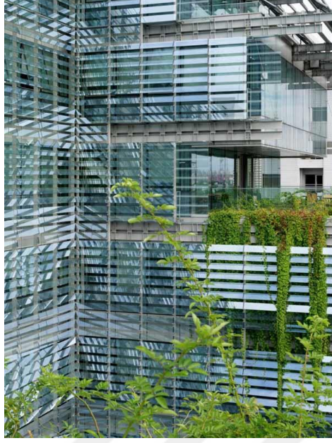
Resim 5.32: Batı cephesi-çift tabakalı cephe kuruluşu (Url-48).
