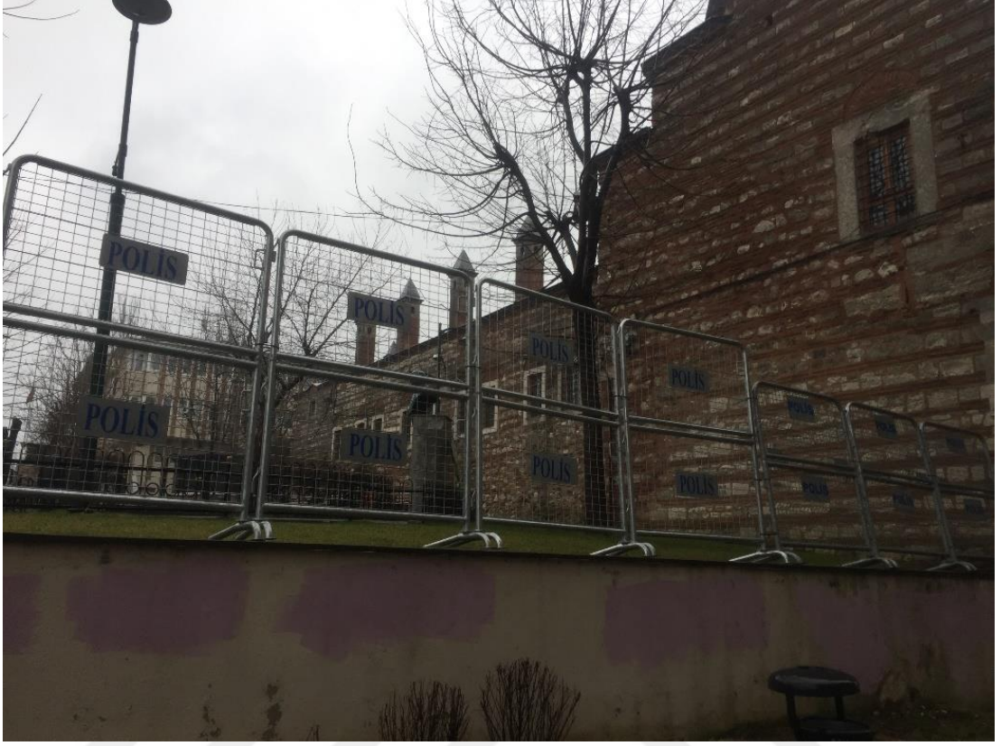
Şekil 594.Kuzey cephe görünümü (Öztürk, 2017)
