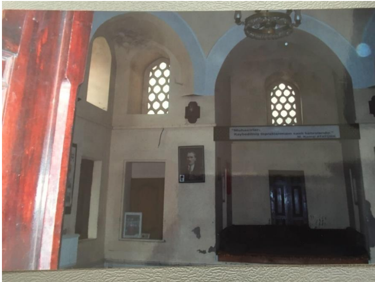
Şekil 330. Restorasyondan önceki dershane görünümü (Hizmet Vakfı)
