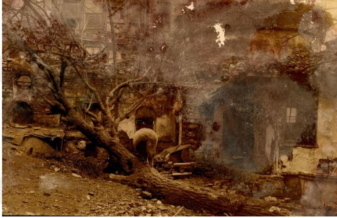
Şekil 40. Medresenin kuzeybatı cephesi görünümü (10 Şubat 1941, Encümen arşivi)
