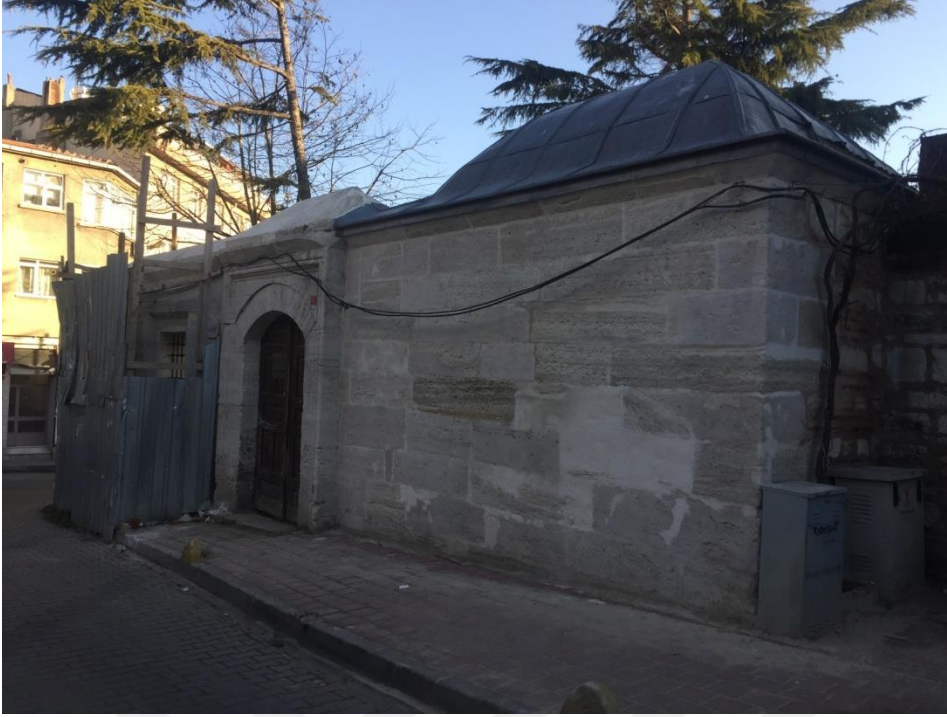
Şekil 417.Restorasyon esnasında medrese, hazire bölümünün giriş kapısı görünümü (Öztürk, 2017)
