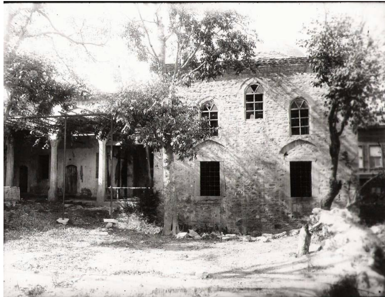
Şekil 576. Dershane cephesi görünümü 1934, Encümen arşivi)
