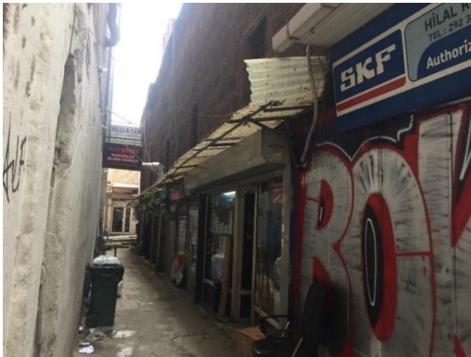
Şekil 496. Doğu cephesi görünümü (Öztürk, 2017)
