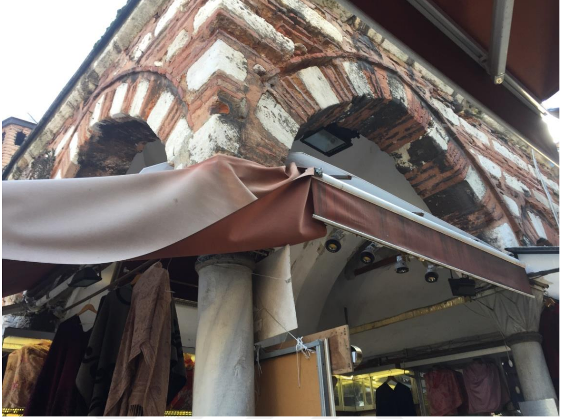
Şekil 531.Malzeme boşalmaları ve yapılan muhdes ekler (Öztürk, 2017)
