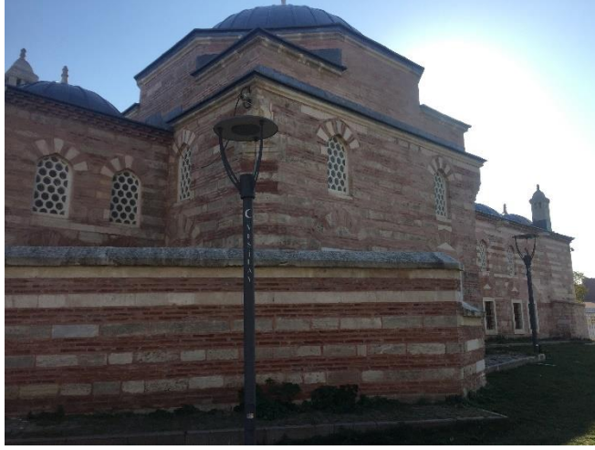
Şekil 157. Batı cephesi görünümü (Öztürk, 2017)
