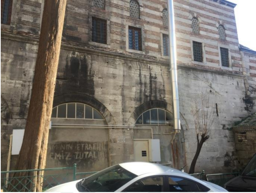
Şekil 240.Kirlenmeye bağlı malzeme bozulmaları (Öztürk, 2017)
