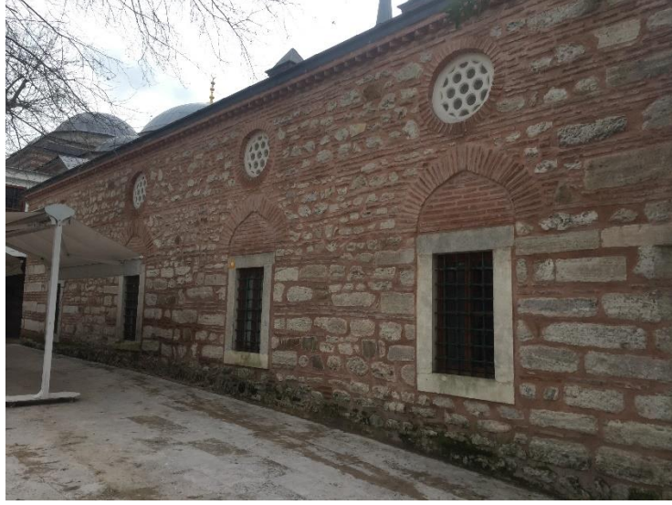
Şekil 116. Doğu cephesi görünümü (Öztürk, 2017)
