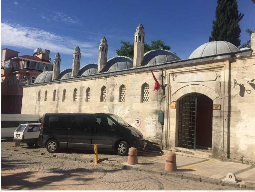
Şekil 288.Batı cephesi görünümü (Öztürk, 2017)
