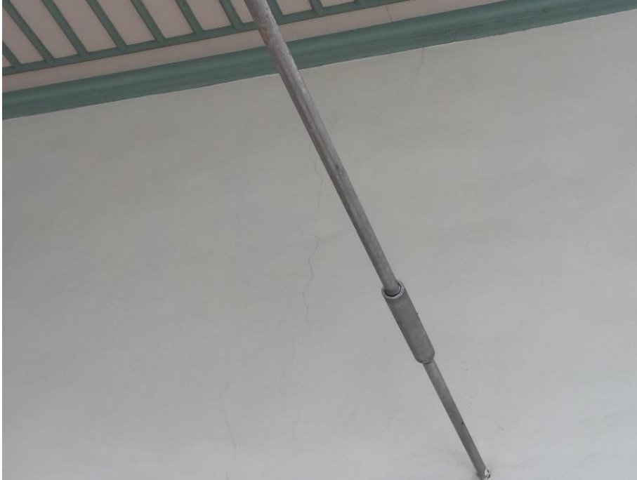
Şekil 121.Revaklardaki kılcal çatlaklardan bir görünüm (Öztürk, 2017)
