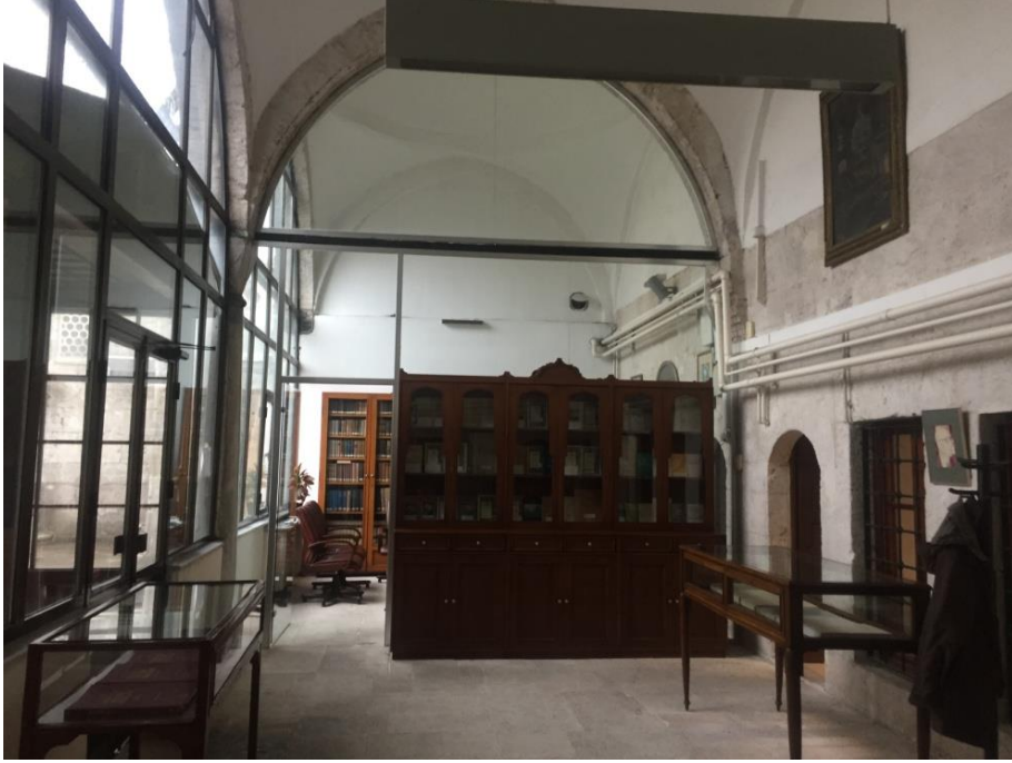
Şekil 454.Revak kapatılarak yapılan oda (Öztürk, 2017)
