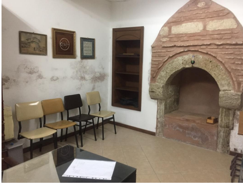
Şekil 450.Hücre içindeki su problemleri (Öztürk, 2017)
