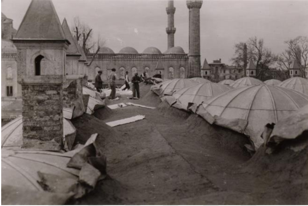
Şekil 406.Sultanahmet Medresesi çatı onarımı
