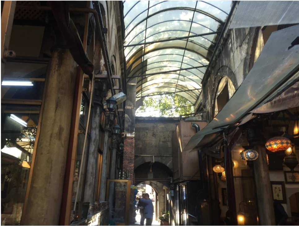
Şekil 537.Girişi holü için yapılan niteliksiz üst örtü, derslane önü için yapılan demir doğrama ve niteliksiz aydınlatma öğeleri (Öztürk, 2017)
