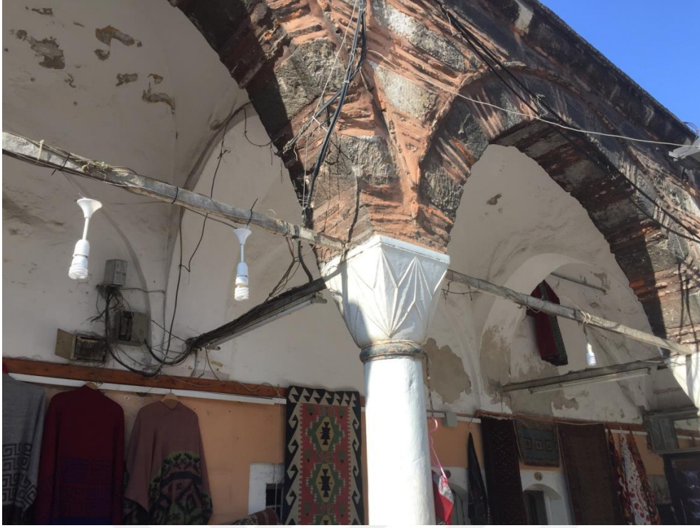
Şekil 536.Revaklara yapılan tesisat uygulamaları (Öztürk, 2017)
