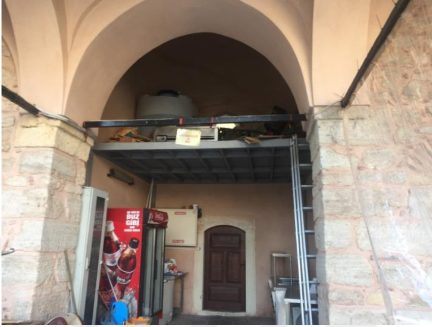
řekil 97.Hcre giriřine yapılmıř asma kat (ztrk, 2017)
