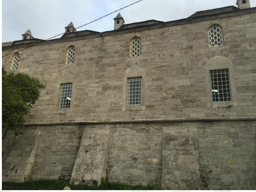
Şekil 58. Batı cephesi görünümü (Öztürk, 2017)
