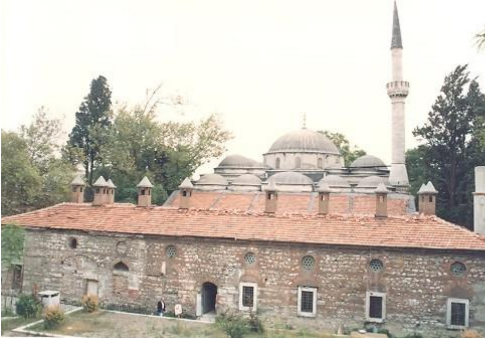
Şekil 118.Kuzey cephesi görünümü (1993, Kurul arşivi)
