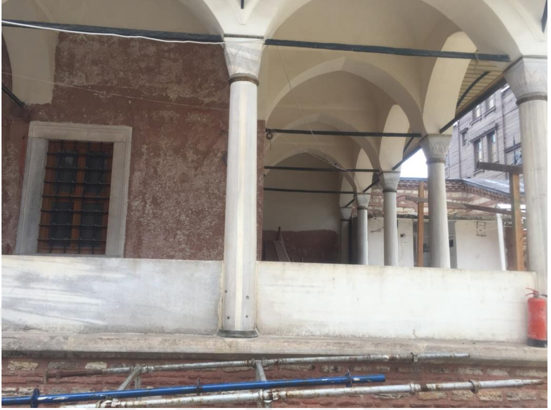
Şekil 545.Restorasyon sırasında kütüphane revaklarının görünümü (Öztürk, 2017)
