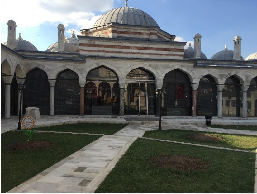
Şekil 269. Medrese revakları görünümü (Öztürk, 2017)
