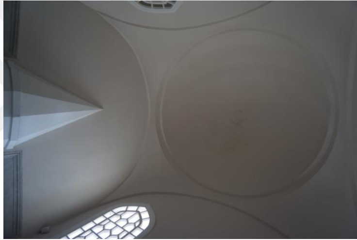
Şekil 408.Kubbede meydana gelen rutubet (T.Ç.K.M., 2017)
