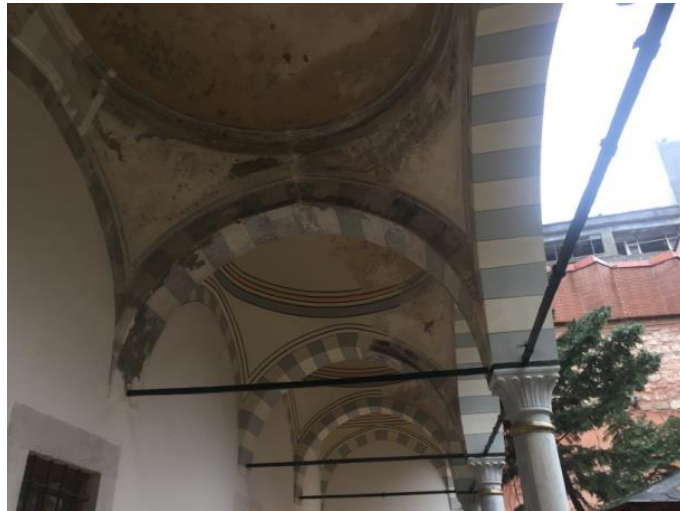
Şekil 589.Revakların restorasyon çalışmaları (Öztürk, 2017)
