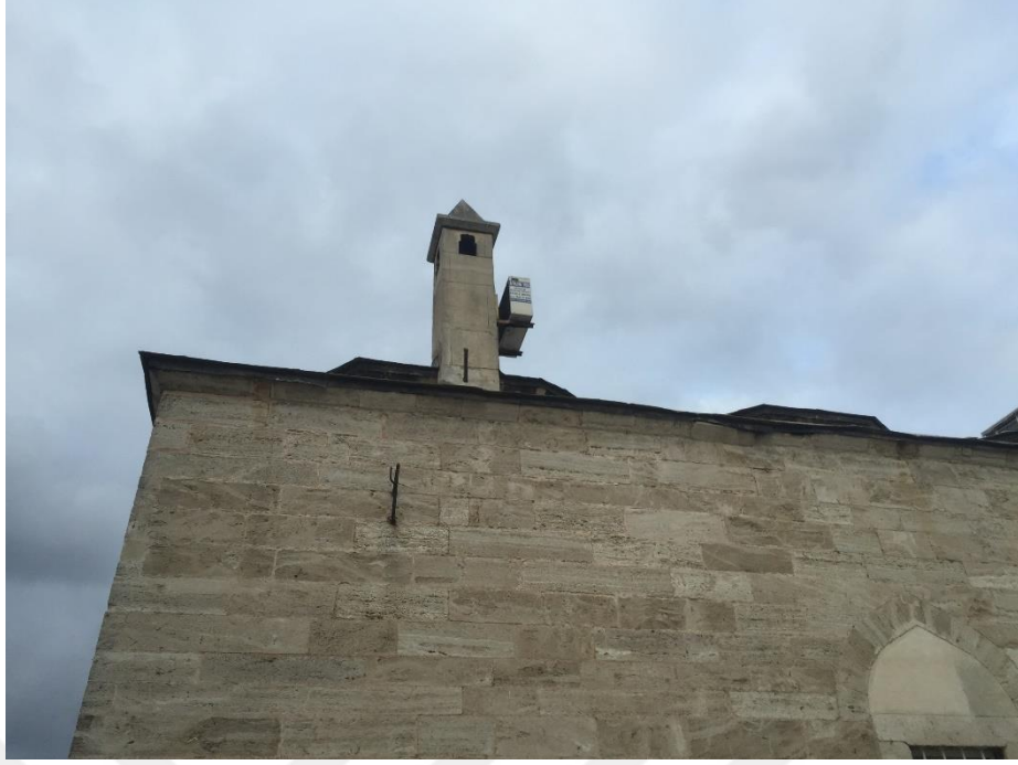
Şekil 65.Bacaya montaj yapılmış dış ünite görünümü (Öztürk, 2017)
