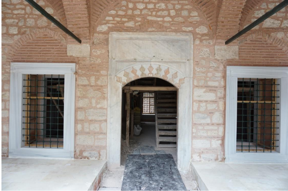
Şekil 211. Restorasyon sırasında dersane görünümü (T.Ç.K.M., 2017)
