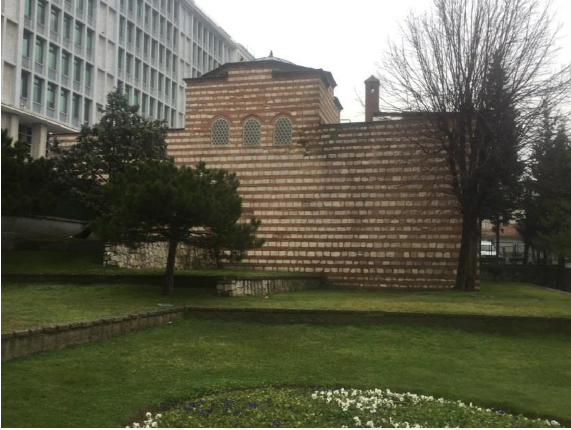
Şekil 509.Kuzey Batı cephesi görünümü (Öztürk, 2017)
