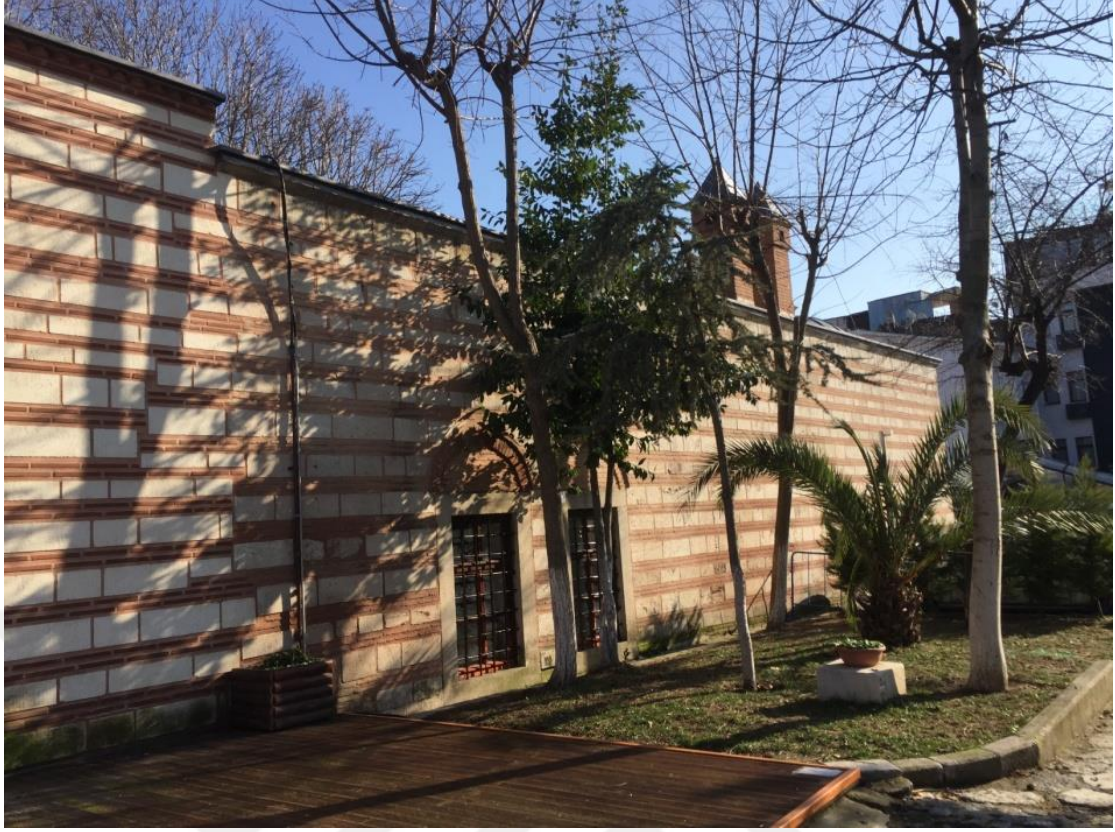
Şekil 486.Güneybatı cephe görünümü (Öztürk, 2017)
