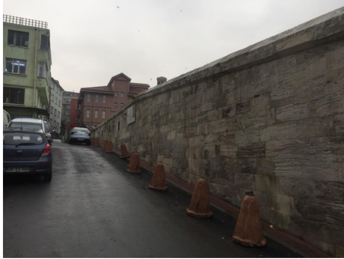
Şekil 315.Doğu cephesi görünümü (Öztürk, 2017)
