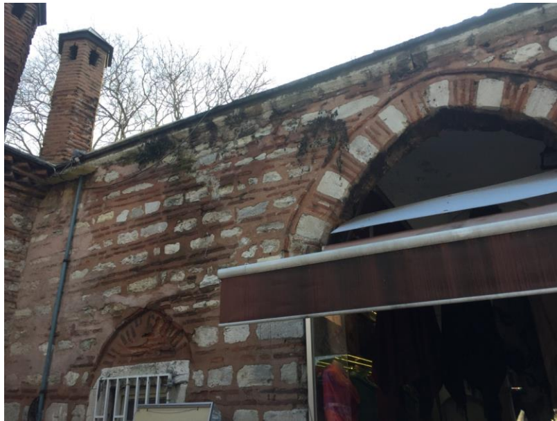
Şekil 528.Cephede yıkanmalar, bitkilenme ve malzeme kayıpları ( Öztürk, 2017)
