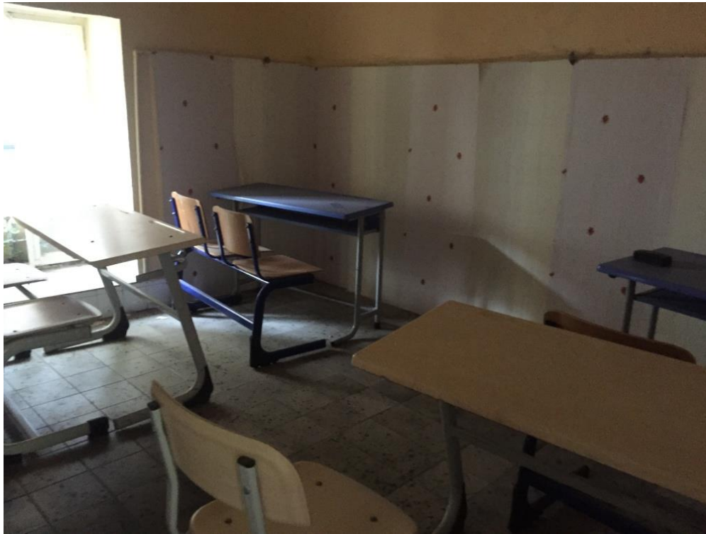
Şekil 196. Hücrelerin içlerine yapılmış mantolama sistemleri ve yer kaplamaları (Öztürk, 2017)
