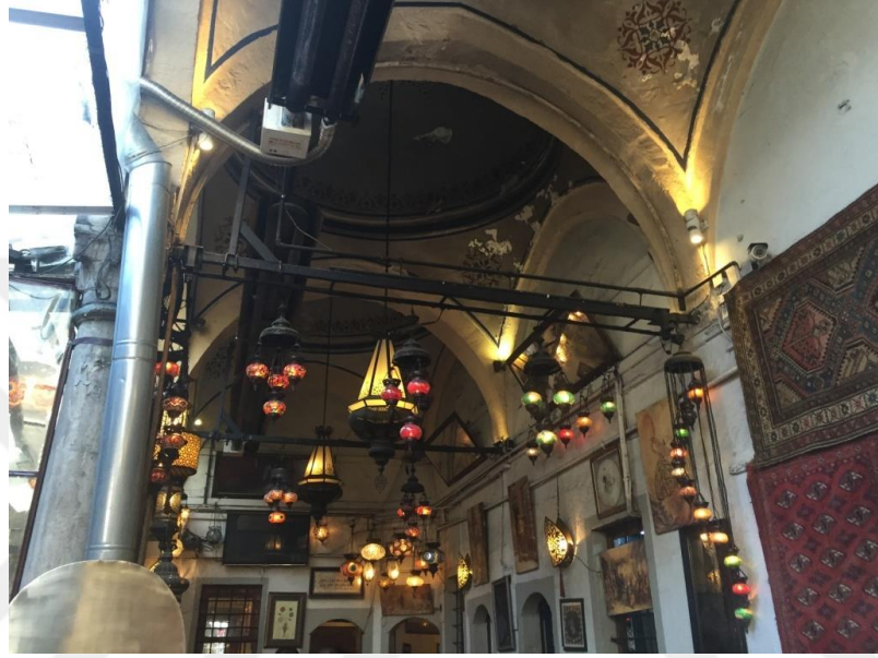
Şekil 527.Revaklarda siyah kabuk oluşumu (Öztürk, 2017)
