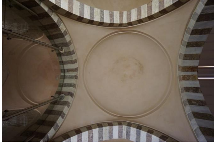
Şekil 407.Kubbede meydana gelen rutubet (T.Ç.K.M., 2017.)
