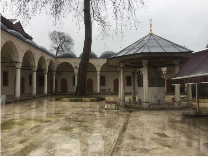
Şekil 543.Restorasyon sırasında medrese avlusunun görünümü (Öztürk, 2017)
