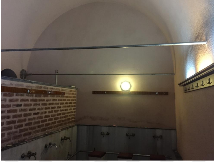
Şekil 357. Restorasyonda yapılan gergi demirleri (Öztürk, 2017)
