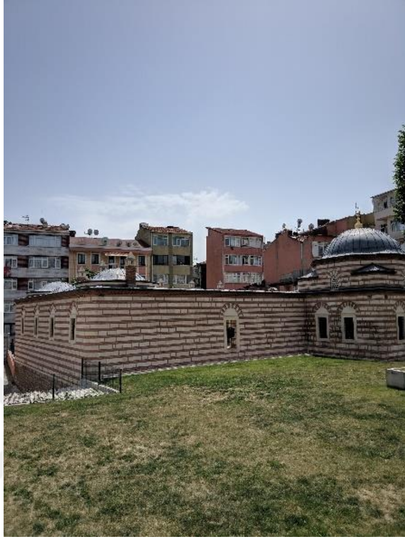
Şekil 175.Batı cephesi görünüm (Öztürk, 2017)
