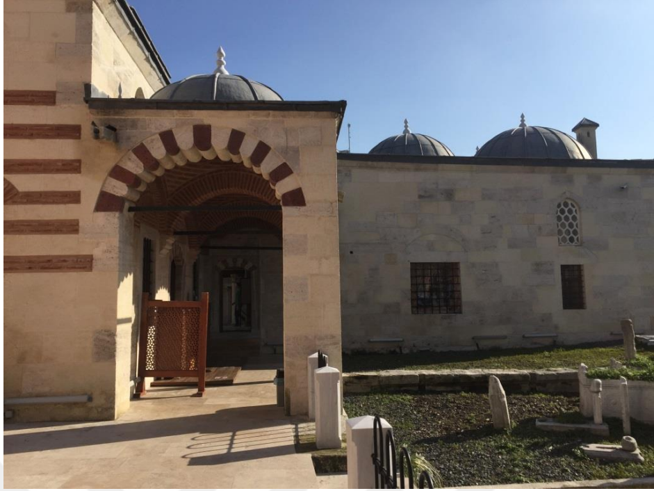
Şekil 328.Batı cephesi görünümü (Öztürk, 2017)
