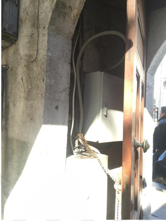
Şekil 453.Giriş kapısının arkasında bulunan elektrik tesisatı (Öztürk, 2017)
