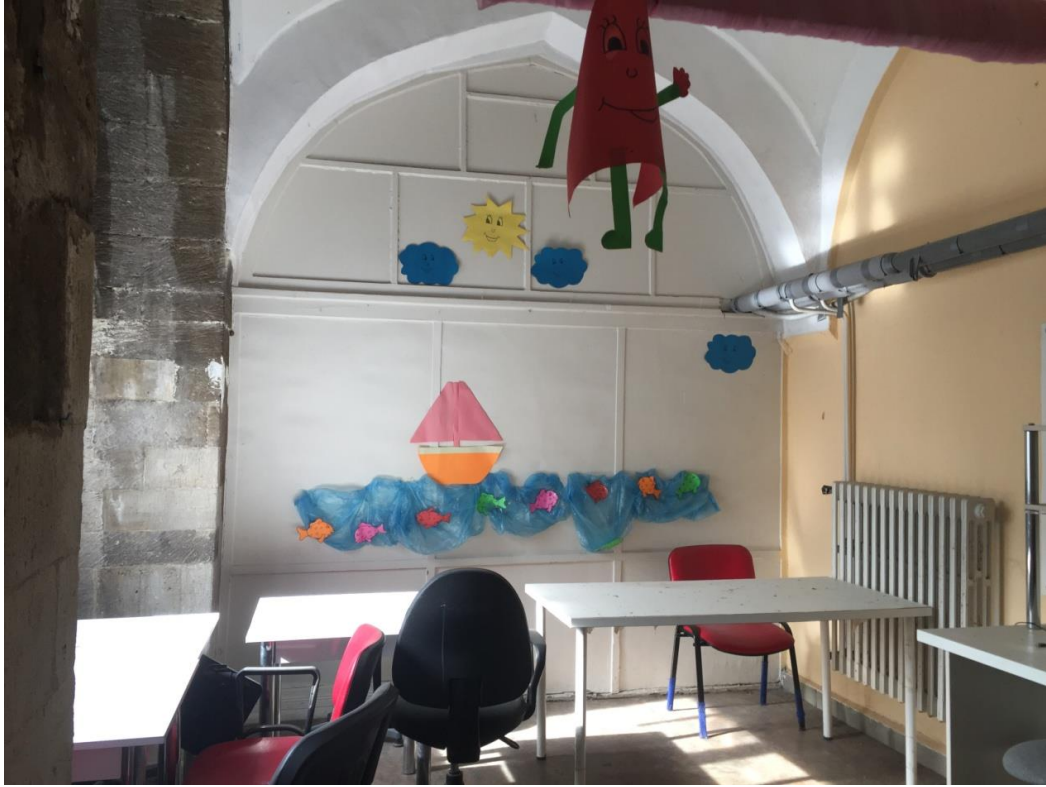
Şekil 194.Revaklar yer yer hürelere dik bir şekilde kapatılmıştır (Öztürk, 2017)
