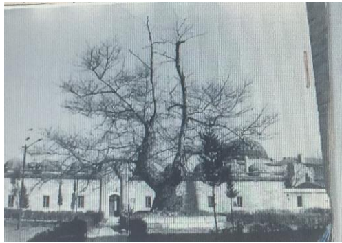
Şekil 52.Medrese giriş cephesi görünümü (Tarih belli değil, kurul arşivi)
