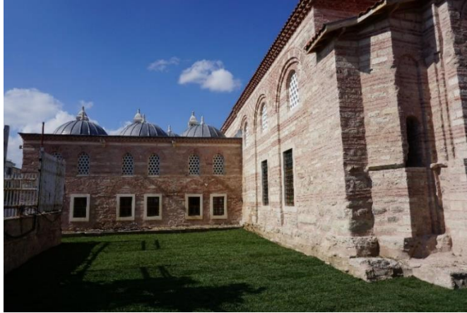
Şekil 158. Batı cephesi görünümünün (Öztürk, 2017)
