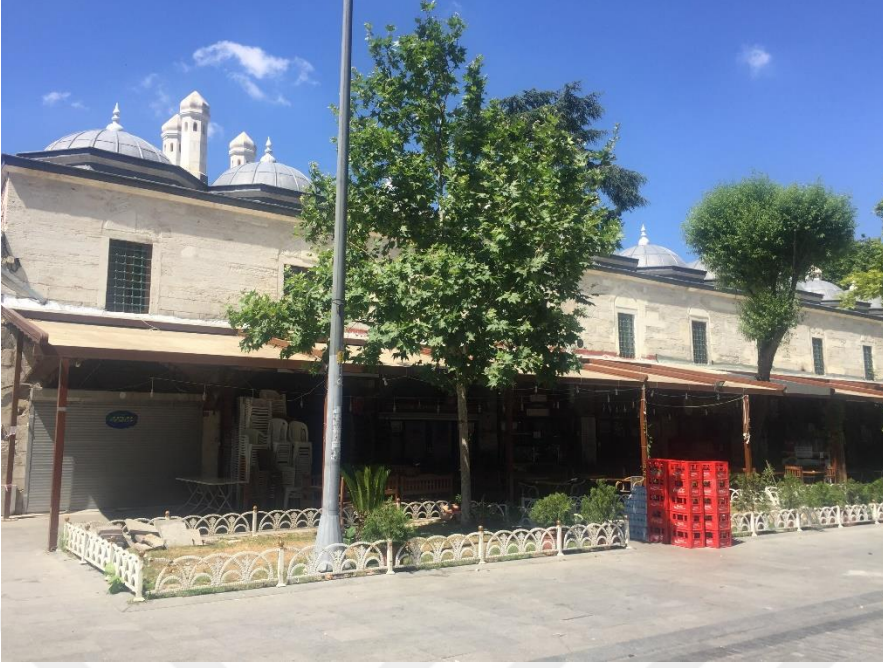
Şekil 130.Evvel Medrese'nin güney cephe görünümü (Öztürk, 2018)
