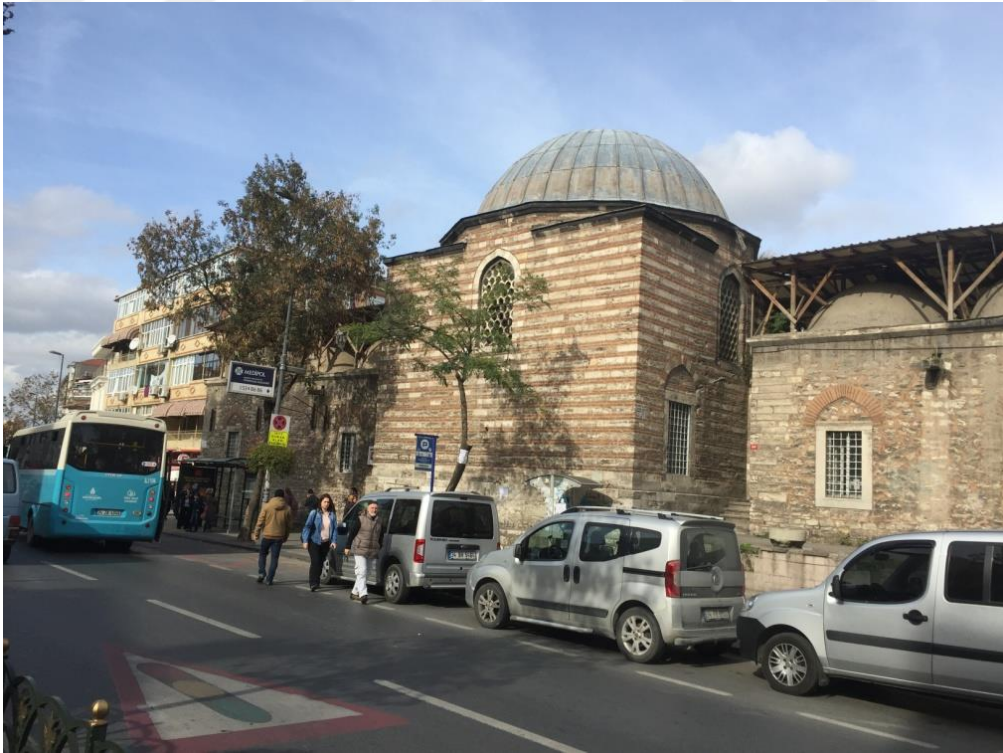
Şekil 183.Güneydoğu cephesi görünümü
