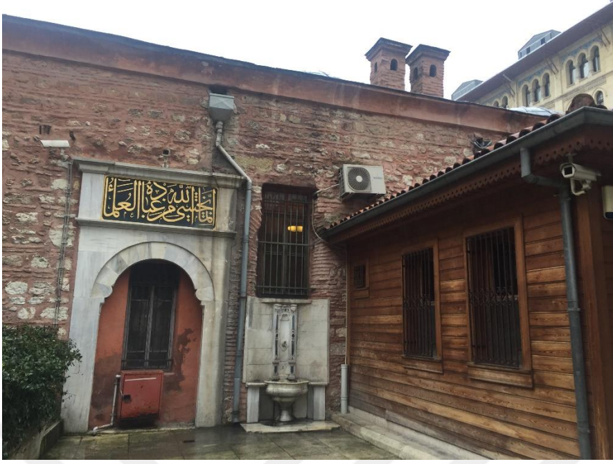
Şekil 640.Doğu cephesinden bir görünüm (Öztürk, 2017)
