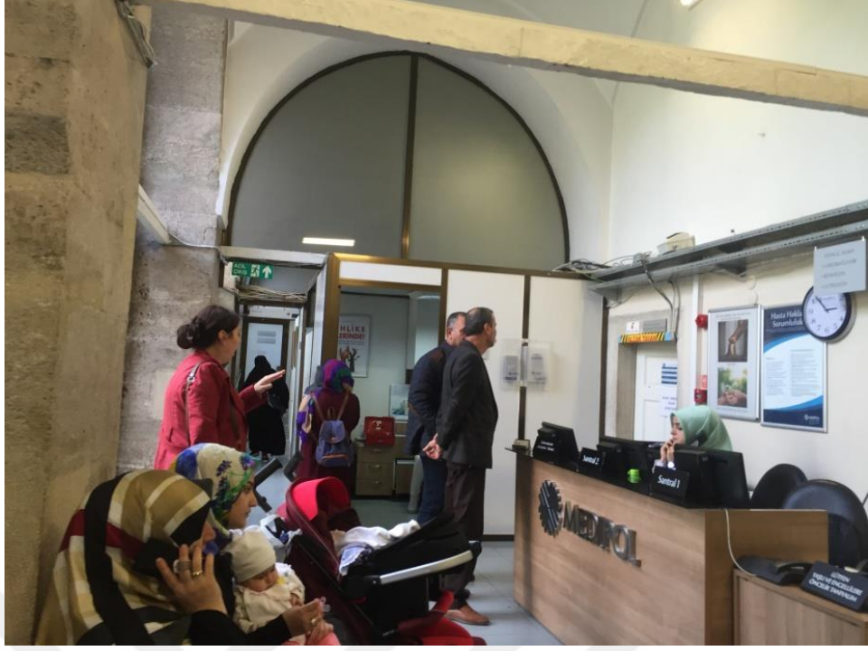
Şekil 79.Köşe revak kapatılarak odaya çevrilmiş (Öztürk ,2017)
