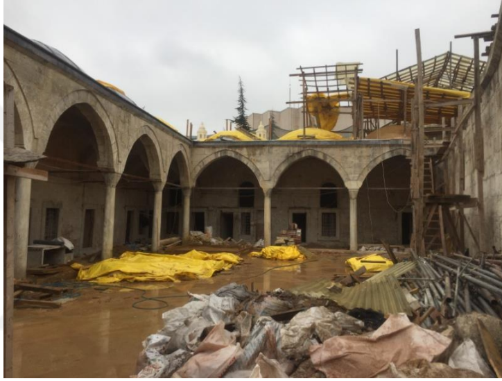
Şekil 382.Restorasyon esnasında medrese avlusundan görünüm (Öztürk, 2017)
