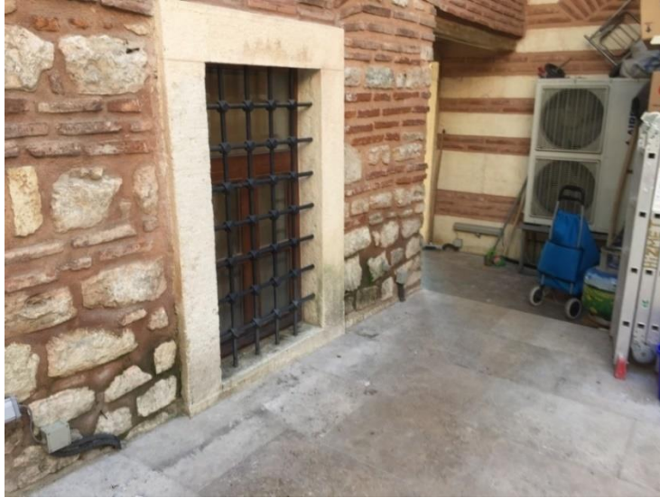
Şekil 334. Klimalar ve zemin hizasında yeşillenmeler (Öztürk, 2017)
