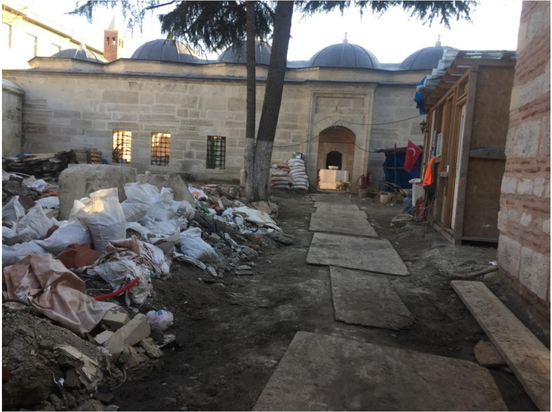
Şekil 416.Restorasyon esnasında medrese asıl giriş kapısı görünümü (Öztürk, 2017)
