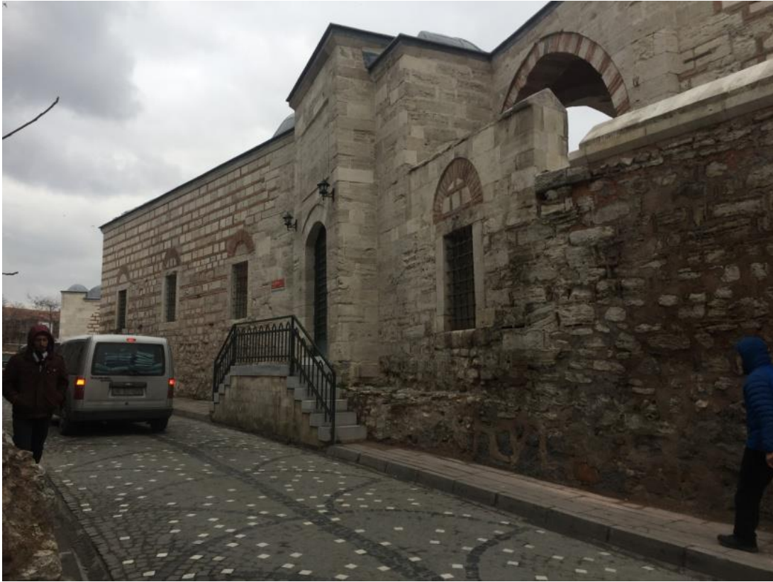
Şekil 219.Kuzeybatı cephesinde bulunan kapının görünümü (Öztürk, 2017)
