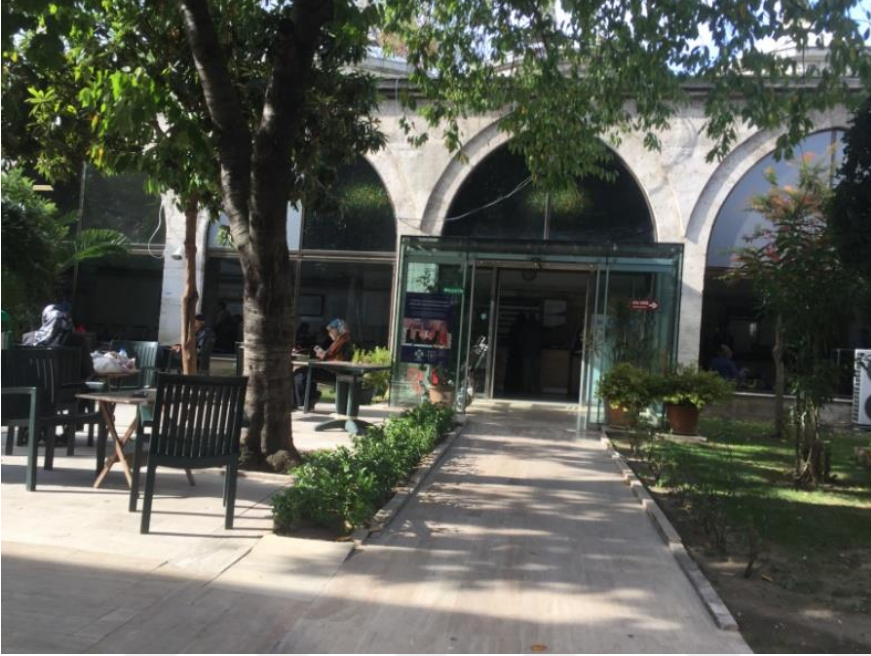
Şekil 70. Medrese avlusu ve revaklarının görünümü
