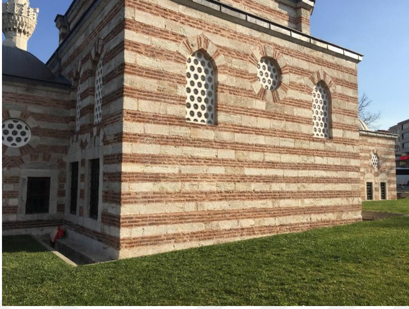
Şekil 272. Güney cephe görünümü (Öztürk, 2017)
