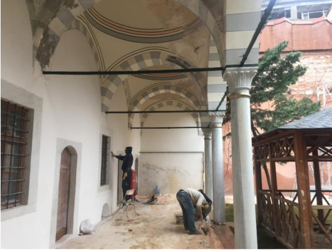
Şekil 590.Revakların restorasyon çalışmaları (Öztürk, 2017)
