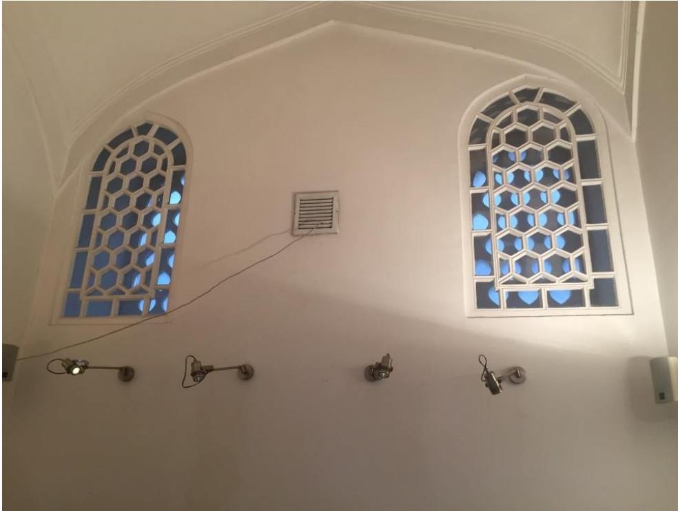
Şekil 305.Hücre içindeki aydınlatma görünümü (Öztürk, 2017)
