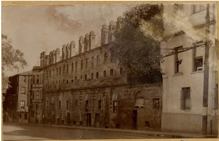
Şekil 140. Medresenin doğu cephesi görünümü (26 Ekim 1945, Encümen arşivi)
