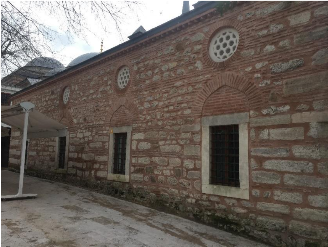
Şekil 342.Doğu cephesi görünümü (Öztürk, 2017)
