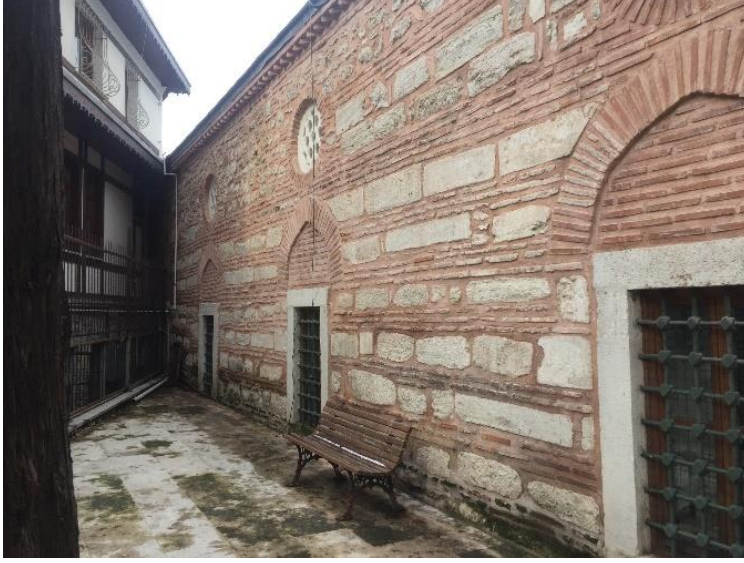
Şekil 343.Batı cephesi görünümü (Öztürk, 2017)
