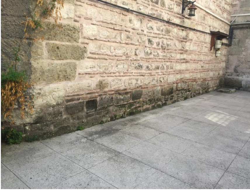
Şekil 433.Zemin suyundan dolayı rutubet ve yer yer bitkilenme (Öztürk, 2017)
