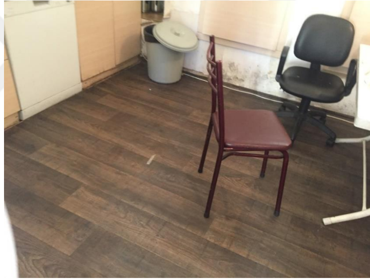
Şekil 303.Çay ocağı içindeki rutubet görünümü (Öztürk, 2017)
