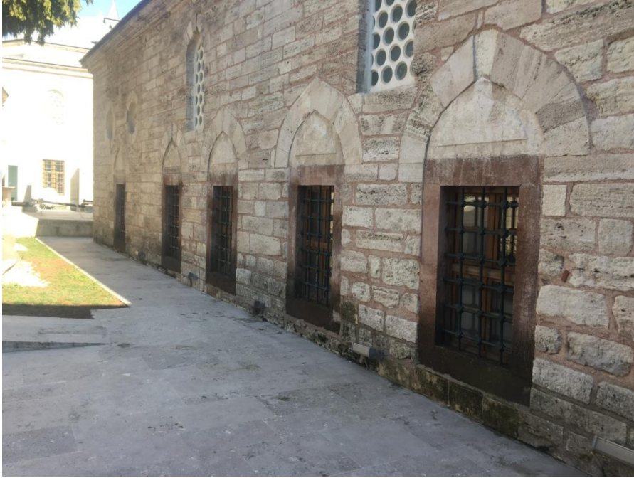
Şekil 33.Batı cephesindeki kararmalar (Öztürk, 2017)
