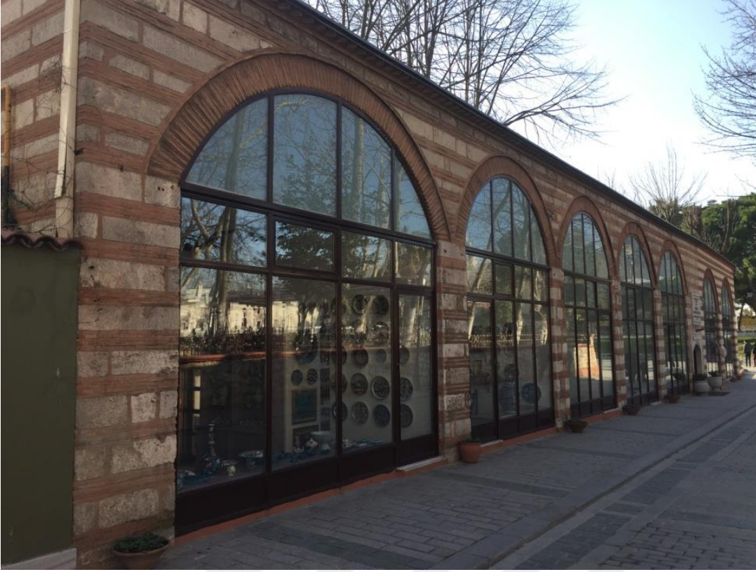
Şekil 485.Kuzeybatı cephe görünümü (Öztürk, 2017)
