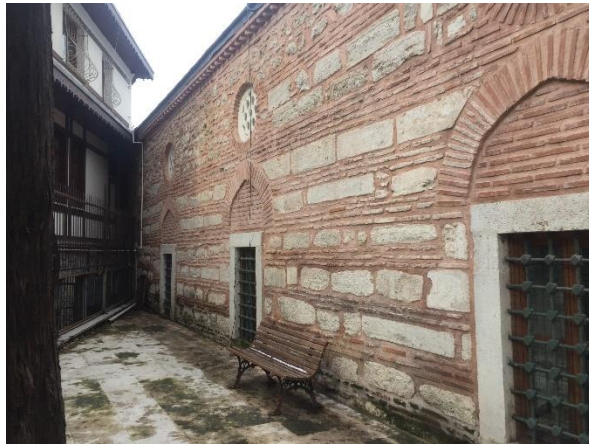
Şekil 117. Batı cephesi görünümü (Öztürk, 2017)
