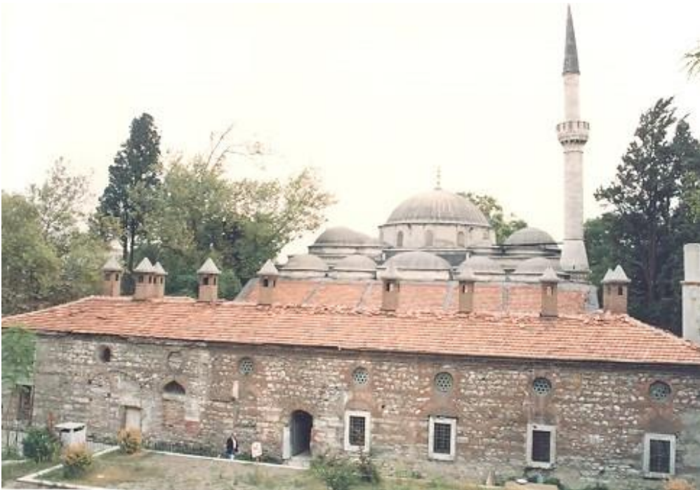
Şekil 344.Kuzey cephesi görünümü (1993, Kurul arşivi)
