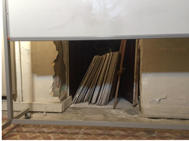
Şekil 253.Hücre içindeki sıva dökülmeleri (Öztürk, 2017)
