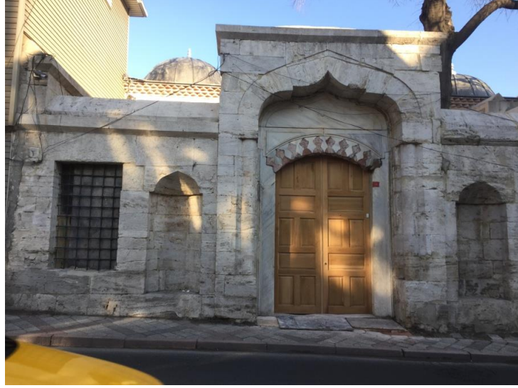
Şekil 203. Güney Cephe giriş kapısı (Öztürk, 2017)
