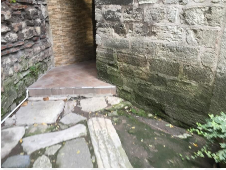
Şekil 145.Zemin suyu yükselmesi, bitkilenme (Öztürk, 2017)
