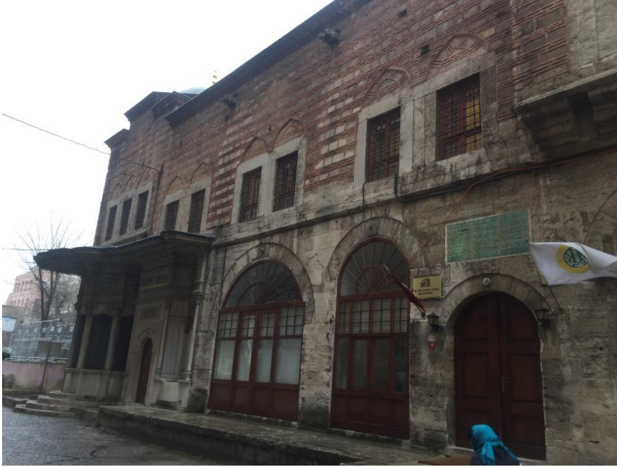
Şekil 593.Güney cephe görünümü
