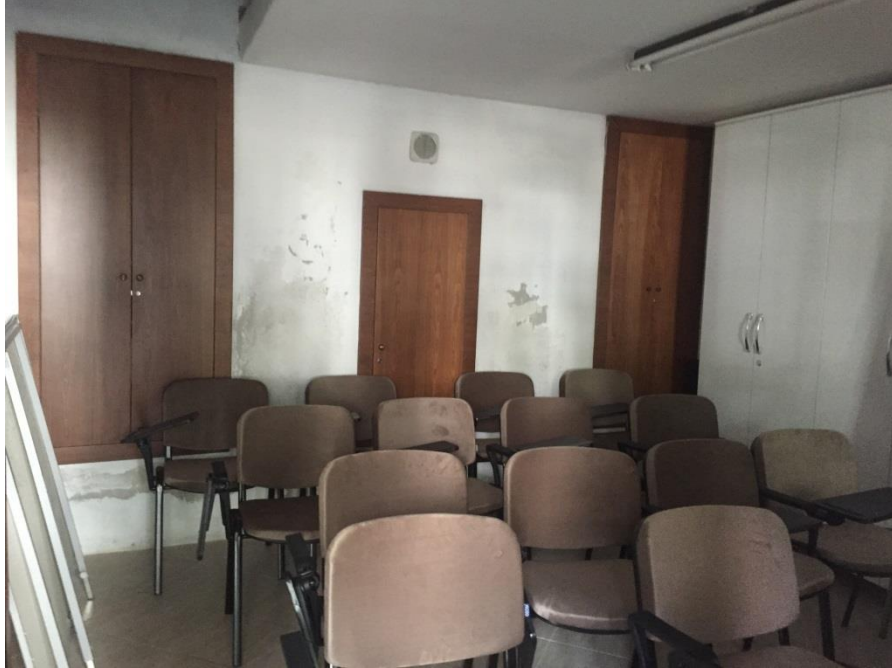
Şekil 435.Sıva dökülmeleri (Öztürk, 2017)
