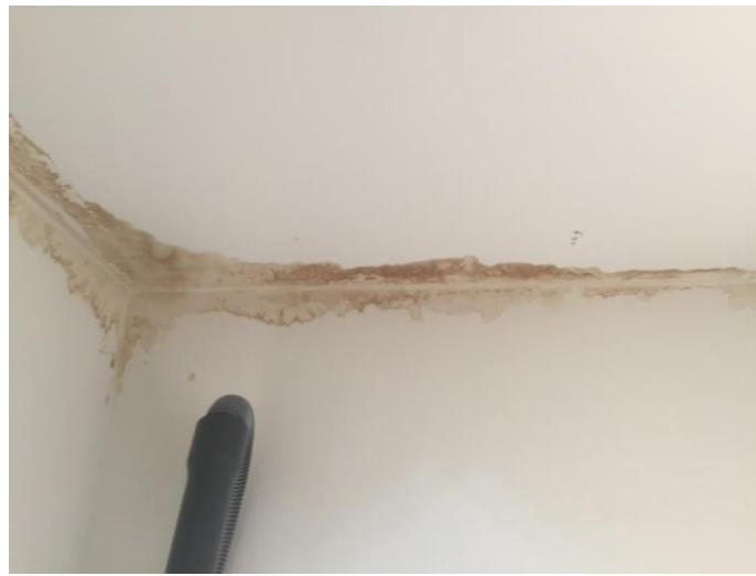
Şekil 53.Hücrelerde ortaya çıkan su problemleri (Öztürk, 2017)
