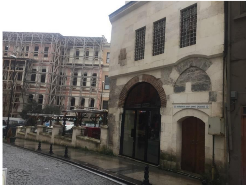
Şekil 369.Batı Cephesi görünümü (Öztürk, 2017)
