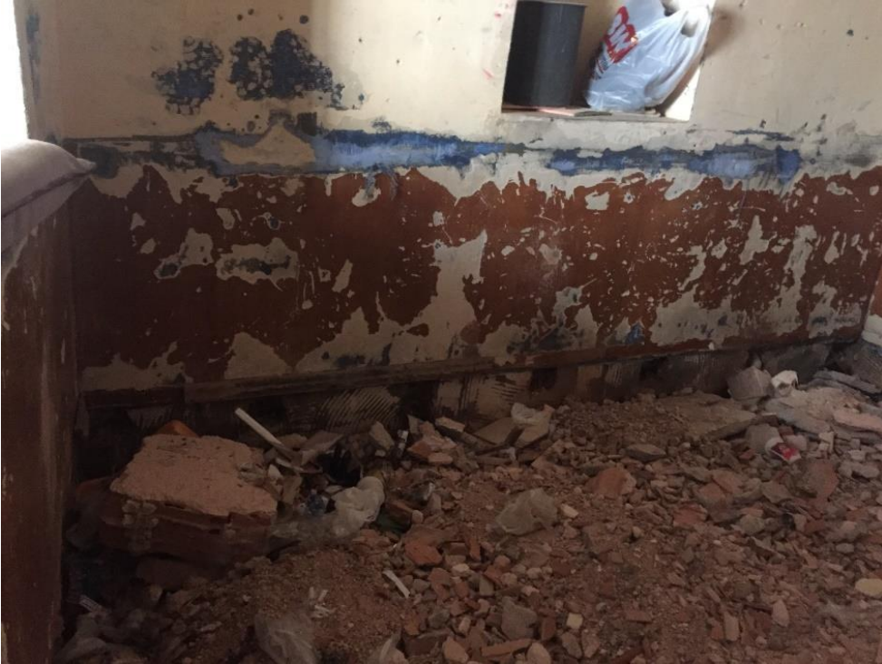
Şekil 10.Döşeme kaldırılmış, duvarlara mantolama yapılmış (Öztürk, 2017)
