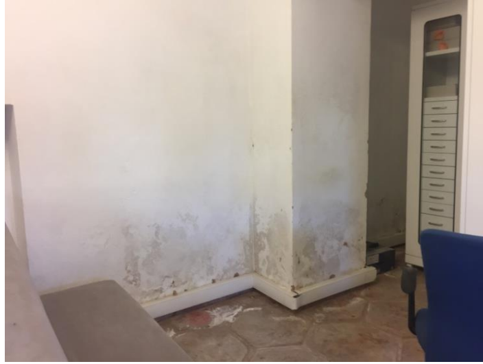
Şekil 95.Hücrelerdeki su problemleri (Öztürk, 2017)
