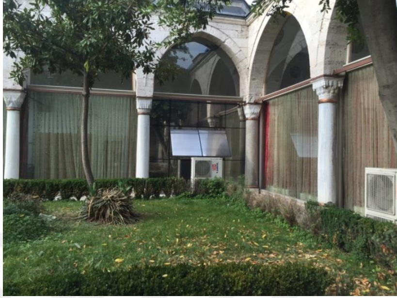
Şekil 170.Kapatılan revaklar ve klima dış üniteleri görünümü (Öztürk, 2017)
