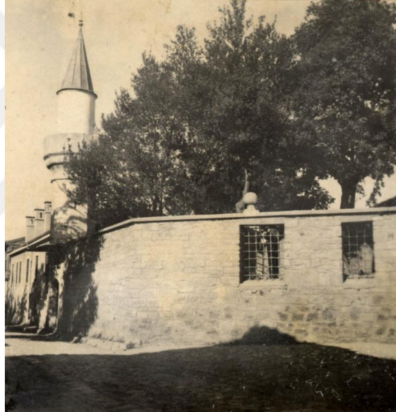
Şekil 23. Medresenin kuzeybatı cephe görünümü (24 Haziran 1946, Encümen arşivi)
