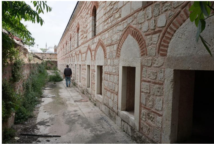
Şekil 229.Güney cephe görüntüsü (K.M.K.M., 2017)
