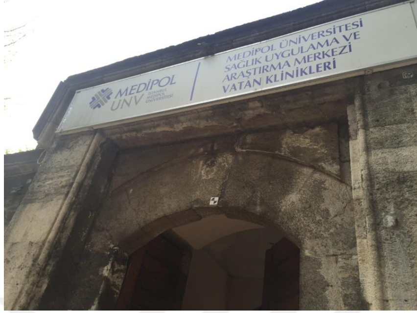
Şekil 75.Giriş kapısı üzerinde bulunan tabela ve siyah kabuk oluşumu (Öztürk, 2017)
