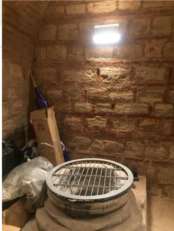
Şekil 374.Zemin katta bulunan su kuyusunun görünümü (Öztürk, 2017)
