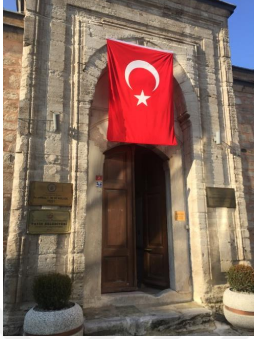
Şekil 90.Giriş kapısı görünümü (Öztürk, 2017)
