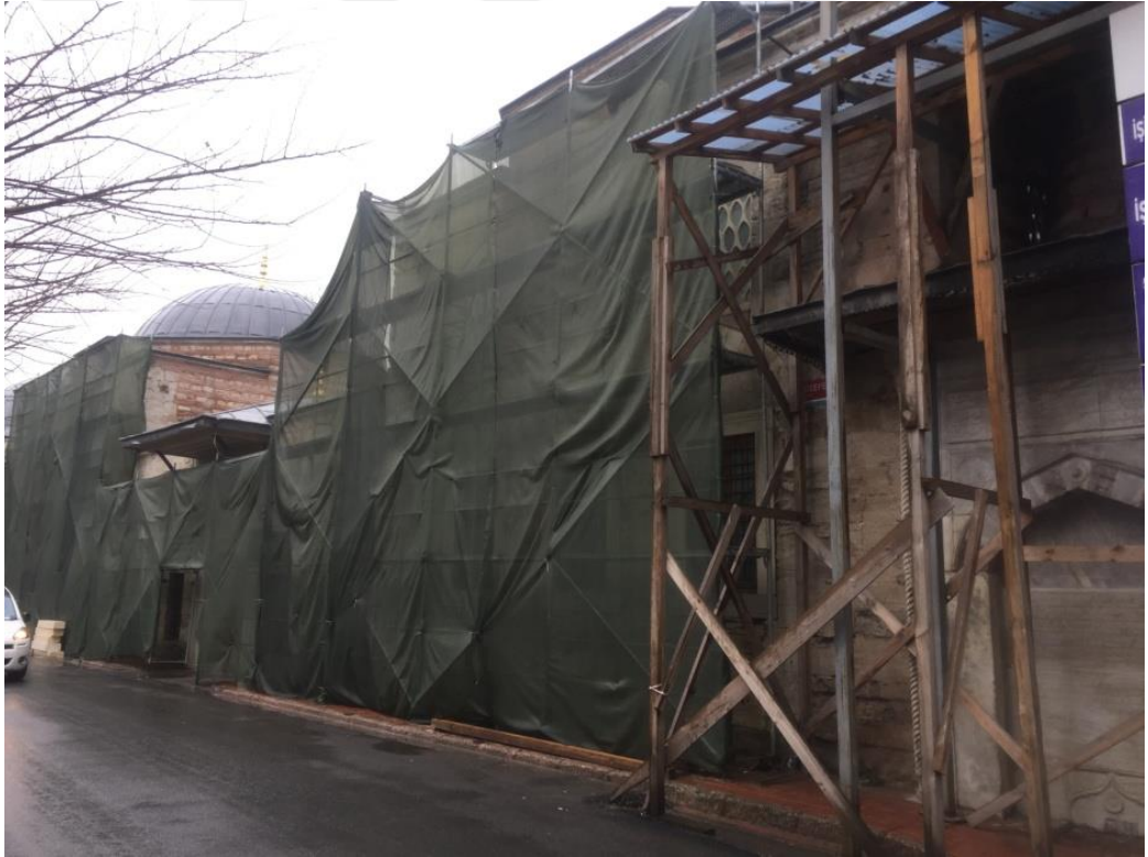
Şekil 546.Restorasyon sırasında girişi cephesi görünümü (Öztürk, 2017)
