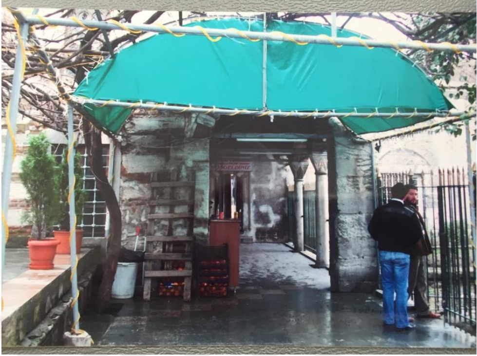
Şekil 331.Restorasyondan önceki dershane revak görünümü (Hizmet Vakfı)
