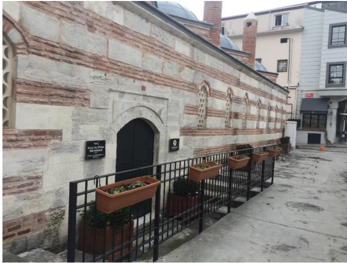
Şekil 264.Batı Cephesi görünümü (Öztürk, 2017)
