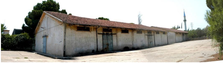
Şekil 6.12 : Ambar binaları kuzeydoğu yönünden görünüm (Kepez Belediyesi).
