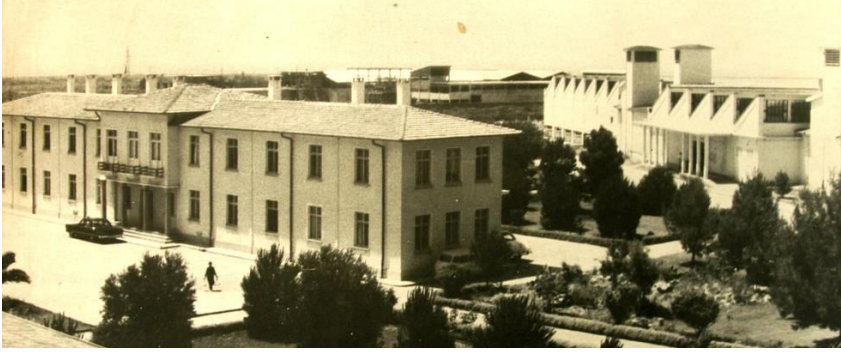
Şekil 6.6 : Antalya Pamuklu Dokuma Fabrikası, İdare binası (Kepez Belediyesi).
