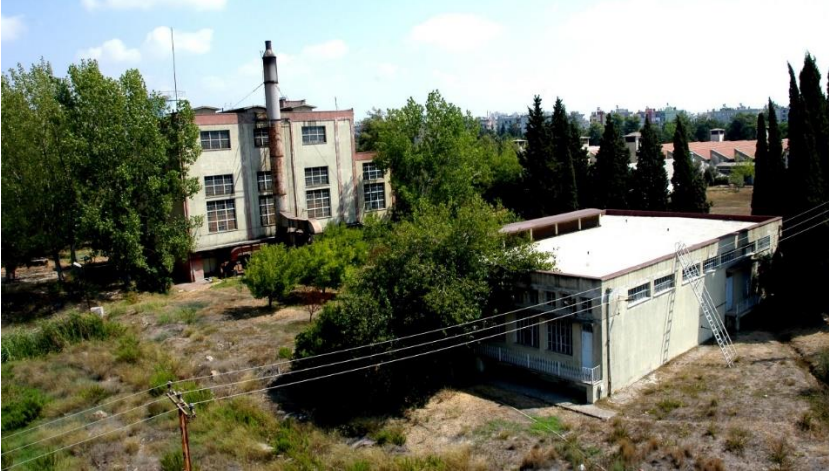
Şekil B. 47 : Isıtma Merkezi ve Trafo binası(Kepez Belediyesi).
