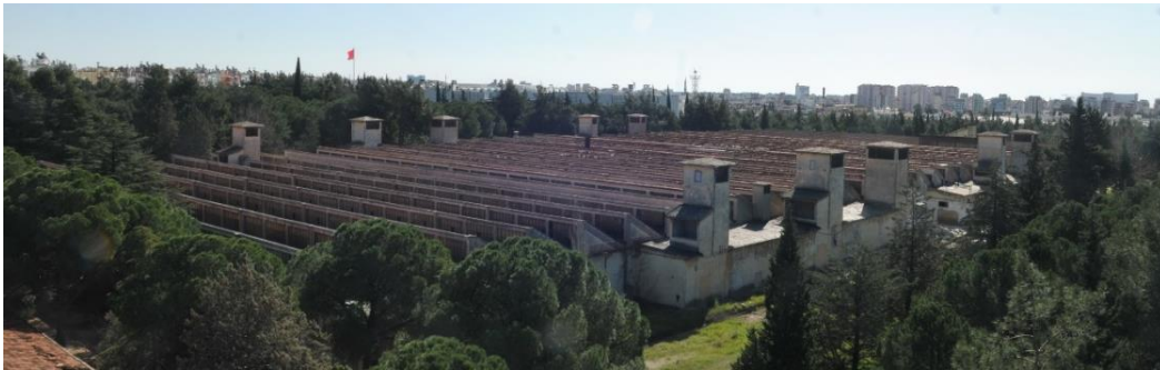
Şekil 6.27 : İşletme binası şed çatıda mevcut olan bacaların görünümü, (Kepez Belediyesi).
