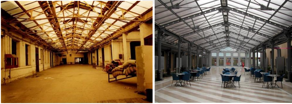
Şekil 5.19 : Cibali Tütün Fabrikası, restorasyon öncesi (solda) ve restorasyon sonrası (sağda), (Url-41).
