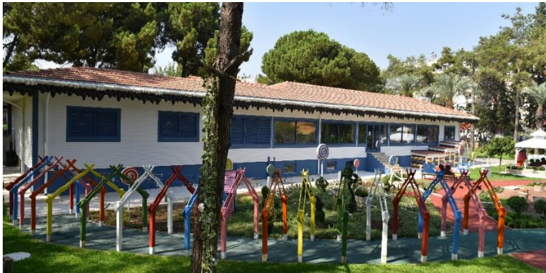
Şekil 6.18 : Kreş binası güneydoğu cephesi, restorasyon öncesi (üstte) (Kepez Belediyesi) ve restorasyon sonrası (altta)(Ceylan Akış).
