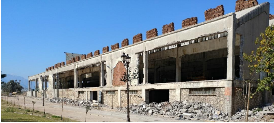
Şekil B. 19 : Doğu cephesi uygulama aşaması görünümü (Kepez Belediyesi).
