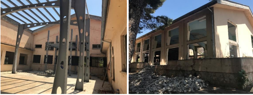
Şekil 6.11 : Yemekhane binası restorasyon aşamasında eklenen çelik konstrüksiyon, restorasyon aşamasında İşçi yemekhanesi sökülen pencere doğramaları, (Ceylan Akış).
