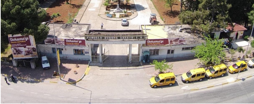
Şekil 6.4 : Antalya Pamuklu Dokuma Fabrikası Giriş kapısı, 2015 (Kepez Belediyesi).
