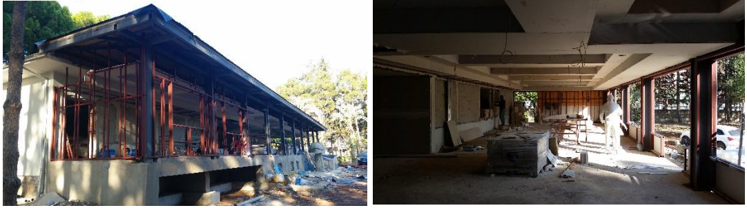
Şekil 6.16 : Kreş binası restorasyon aşaması ilave döşeme alanı, (Kepez Belediyesi).
