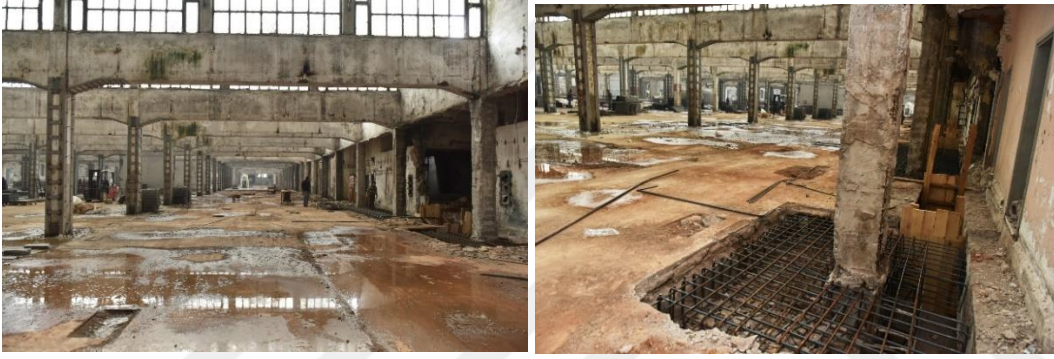
Şekil B. 23 : İşletme binası iç mekân güçlendirme aşamasında yıkılan bölücü duvarlar (Ceylan Akış).
