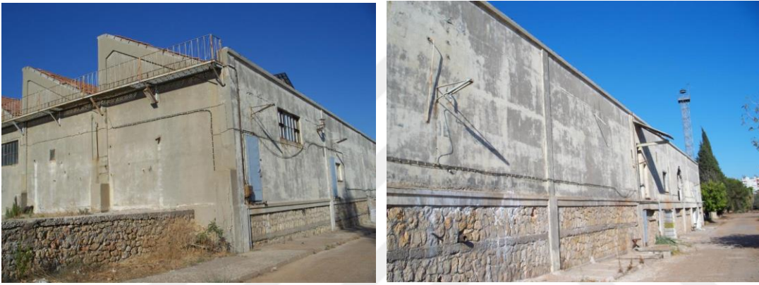
Şekil B. 17 : Güney cephesi restorasyon uygulaması öncesi görünümü (Kepez Belediyesi).
