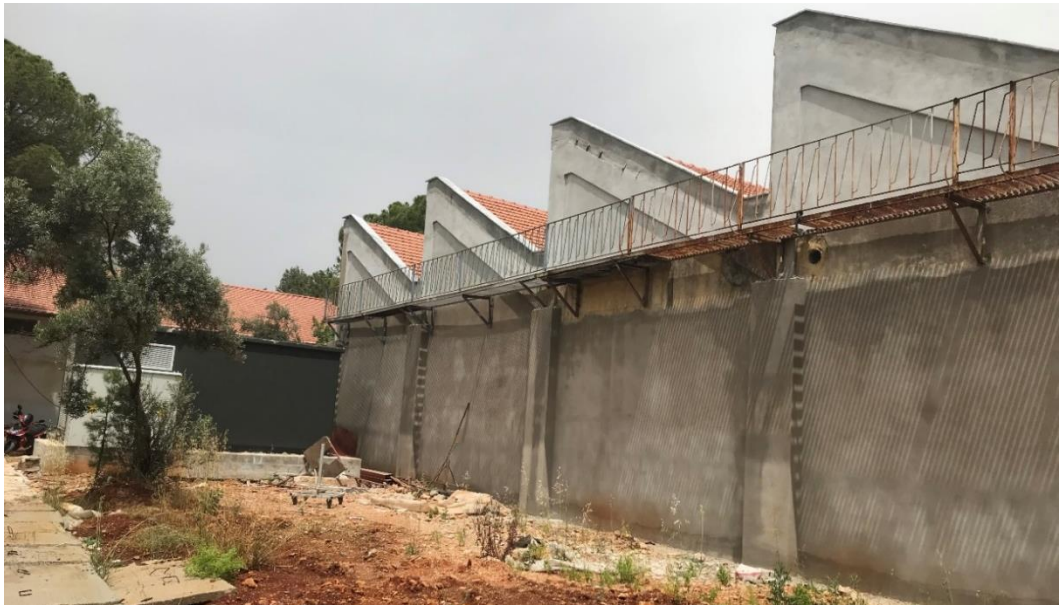
Şekil B. 9 : Uygulama aşaması batı yönünün kuzey köşesinde kaldırılan bölüm (Ceylan Akış).
