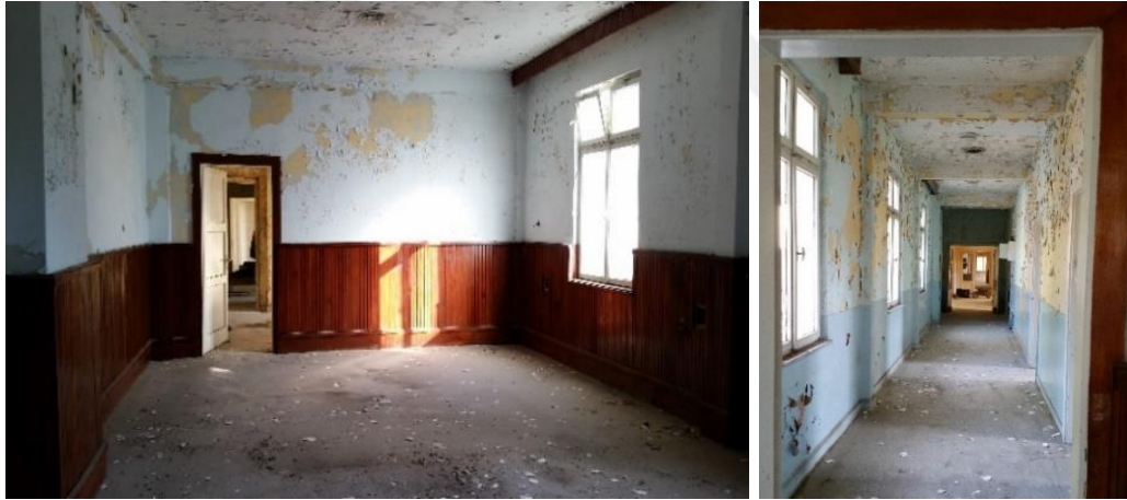
Şekil 6.7 : İdare binası birinci kat iç mekanı restorasyon öncesi (Kepez Belediyesi).
