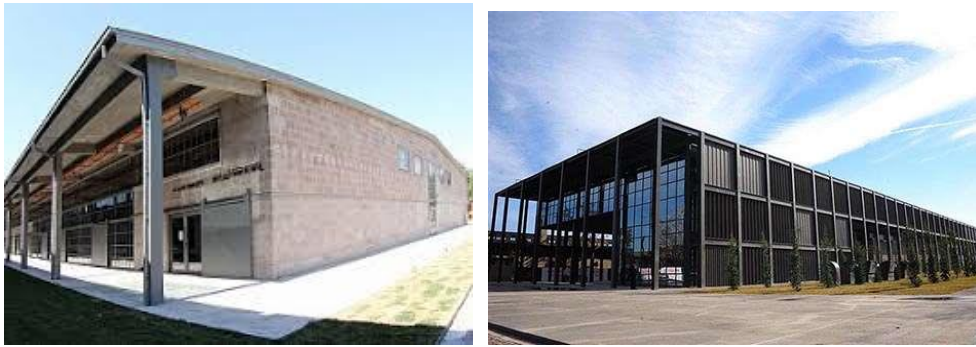
Şekil 5.25 : AGÜ Sümer Kampüsü Ambar Binası, 2015, (solda), (Url-48), Alana ekelenen yeni bina (sağda), (Url-49).
