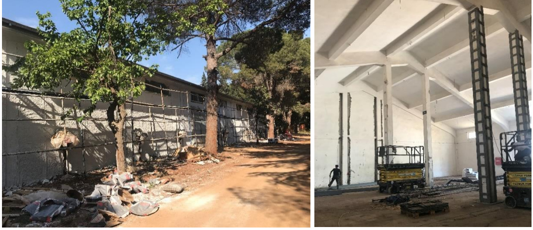
Şekil 6.14 : 2 numaralı ambar binası güney cephesi ve depo 1 iç mekanı restorasyon aşaması, (Ceylan Akış).
