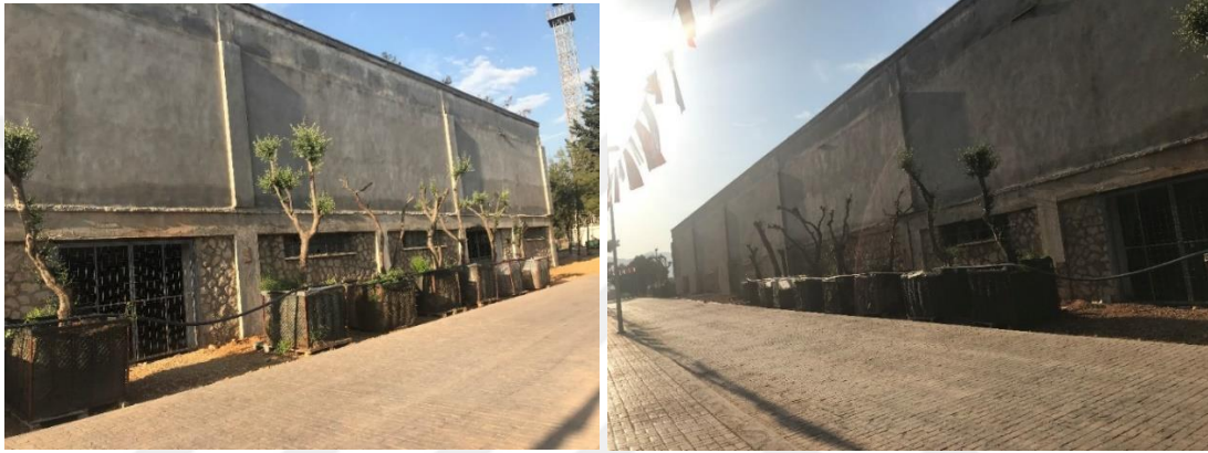
Şekil B. 20 : Bodrum kat kapı ve pencere detayları, (solda) ile kapatılan kapı ve pencere yerleri, (sağda) (Ceylan Akış).
