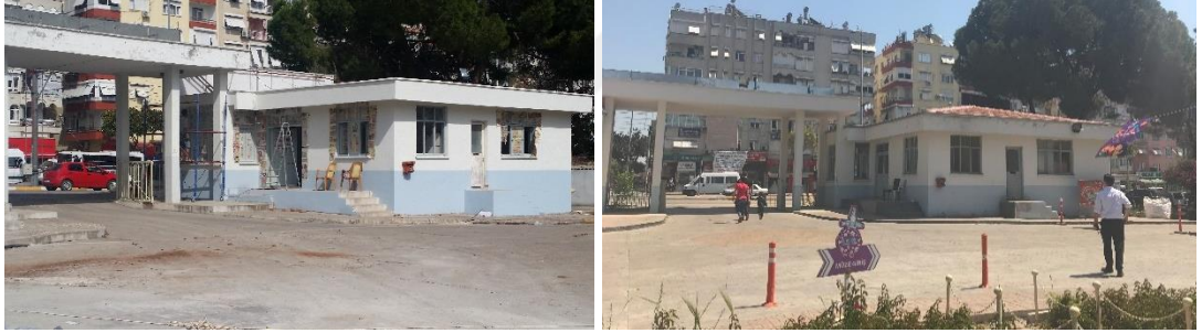
Şekil 6.5 : Giriş kapısı onarım aşaması (solda), 2015 (Kepez Belediyesi), Giriş kapısı onarım sonrası (sağda), 2018 (Ceylan Akış).
