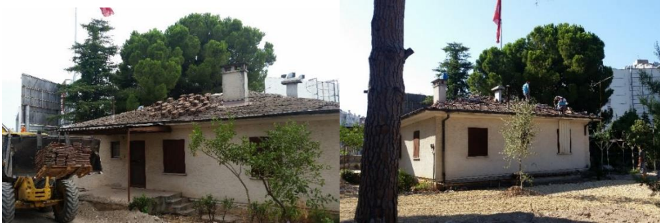
Şekil 6.19 : Müdür Lojmanı çatı onarımı görünümüleri, (Kepez Belediyesi).
