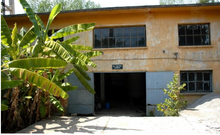
Şekil B. 44 : Pompa dairesi (Kepez Belediyesi).
