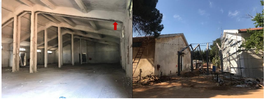
Şekil 6.15 : 1 numaralı ambar binası yıkılmış olan bölücü duvar detayı (solda), 1 ve 2 numaralı ambar binası arasında inşa edilen çelik konstrüksiyon (sağda), (Ceylan Akış).
