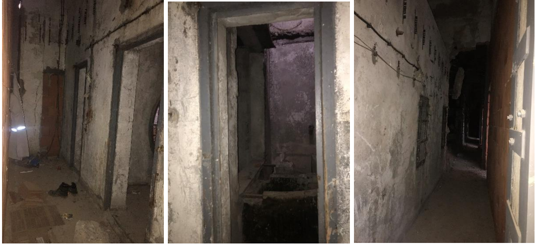
Şekil B. 25 : İşletme binası doğu yönü korunması önerilen bölümler (Ceylan Akış).
