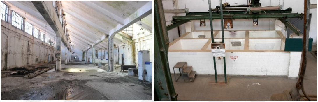
Şekil 6.30 : İşletme binası güney yönü iç mekânı mevcut bölücü duvarları (solda), bekleme havuz alanı (sağda), (Kepez Belediyesi).
