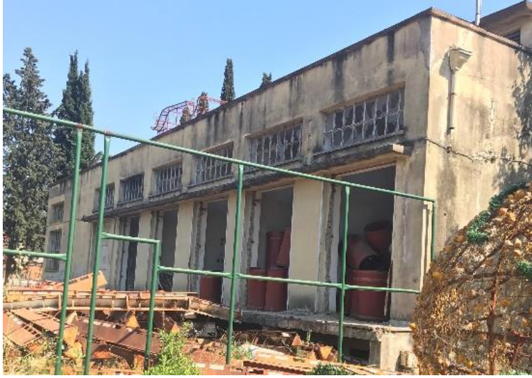
Şekil B. 41 : Trafo Binası günümüz cephesi görünümü (Kepez Belediyesi).
