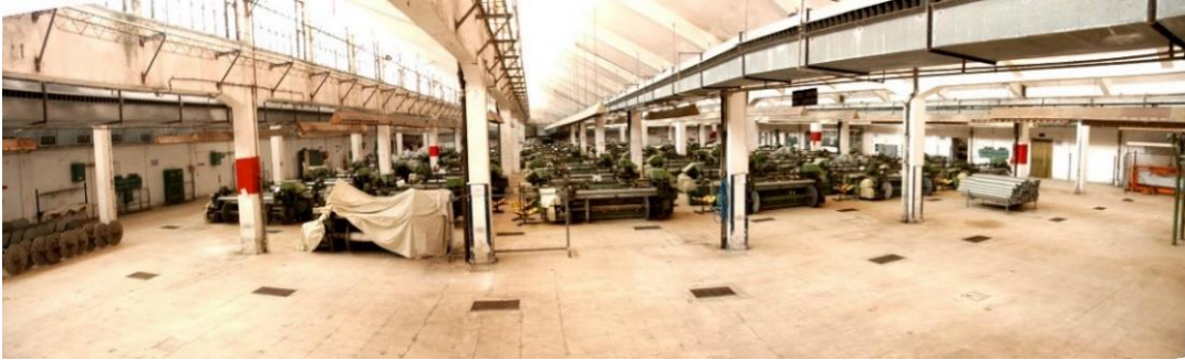
Şekil 6.26 : İşletme binası şed çatılı ana mekân, (Kepez Belediyesi).
