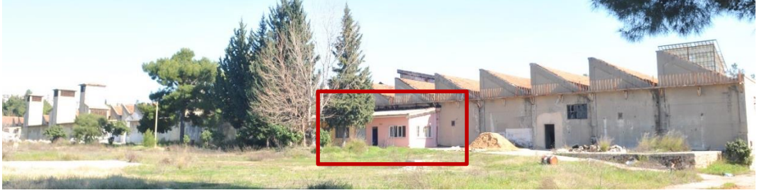
Şekil B. 1 : Uygulama öncesi batı yönünün güney köşesinde mevcut tek katlı bölüm (Kepez Belediyesi).
