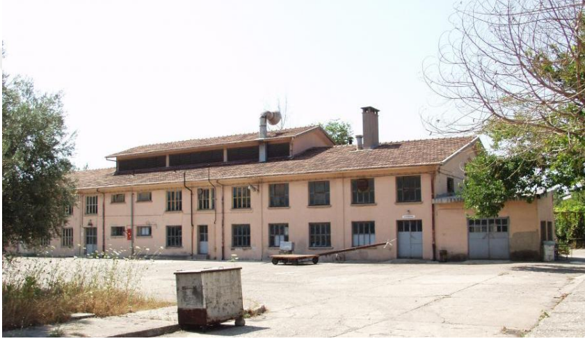
Şekil B. 50 : Atölye binası (Kepez Belediyesi).
