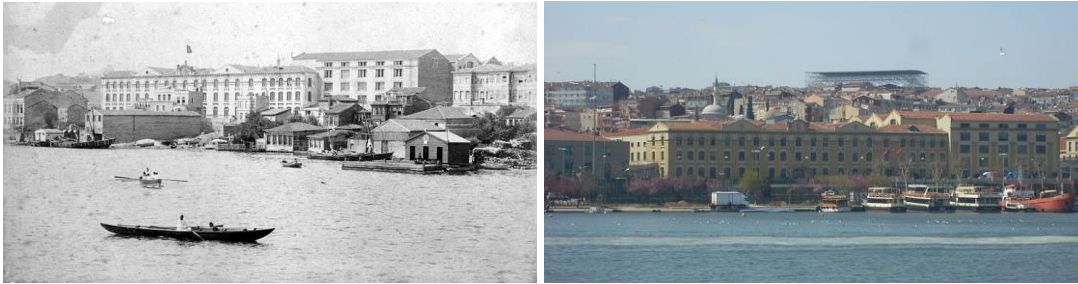
Şekil 5.20 : Cibali Tütün Fabrikası, geçmişteki (solda), (Url-42) ve günümüzdeki hali (sağda), (Url-43).
