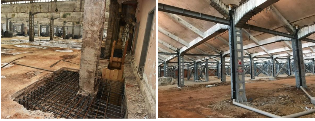
Şekil 6.32 : İşletme binası restorasyon aşaması; temel, kolon ve kirişlerde güçlendirme, (Ceylan Akış).
