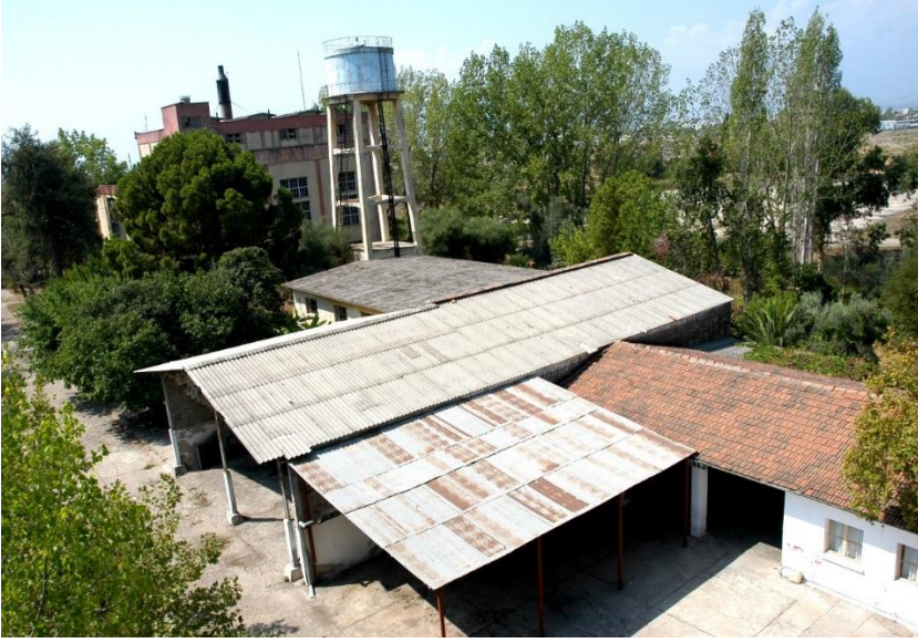
Şekil B. 46 : Isıtma Merkezi, Su Kulesi, Tamirhane binaları (Kepez Belediyesi).
