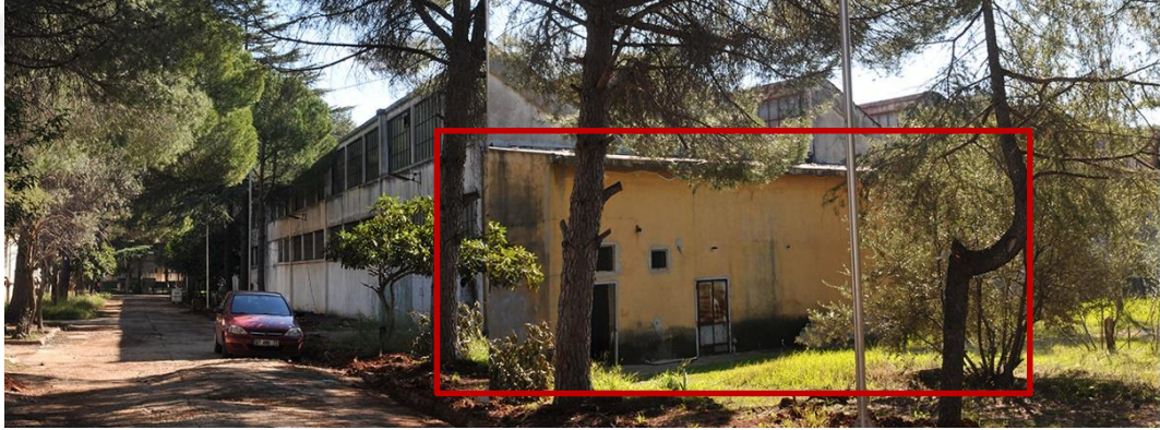
Şekil B. 8 : Uygulama öncesi batı yönünün kuzey köşesinde mevcut tek katlı bölüm ve doğu cephesinin özgün pencere görünümü (Kepez Belediyesi).
