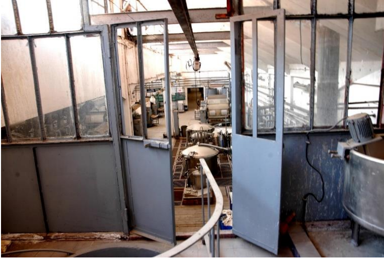
Şekil B. 29 : Uygulama öncesi iç mekân görünümü (Kepez Belediyesi).
