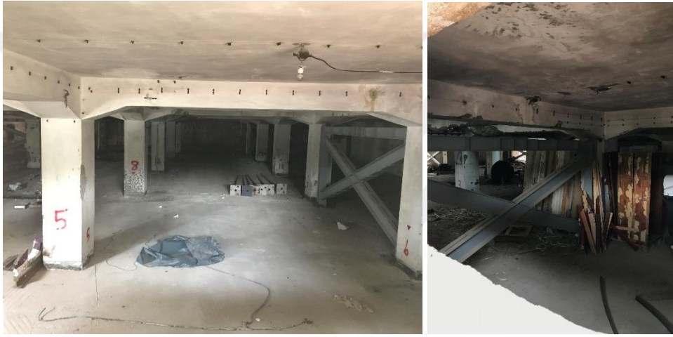
Şekil B. 26 : Bodrum kat iç mekan mevcut olmayan bölme duvarlar (Ceylan Akış).
