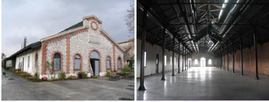
Şekil 5.34 : 1. Bölüm restorsayon sonrası dış cephesi ve iç mekânı, (Kıraç vd.,2018).
