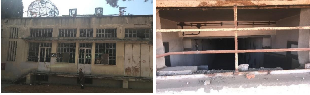
Şekil 6.25 : Trafo binası kuzeydoğu cephesi ve bodrum kat görünümler, (Ceylan Akış).
