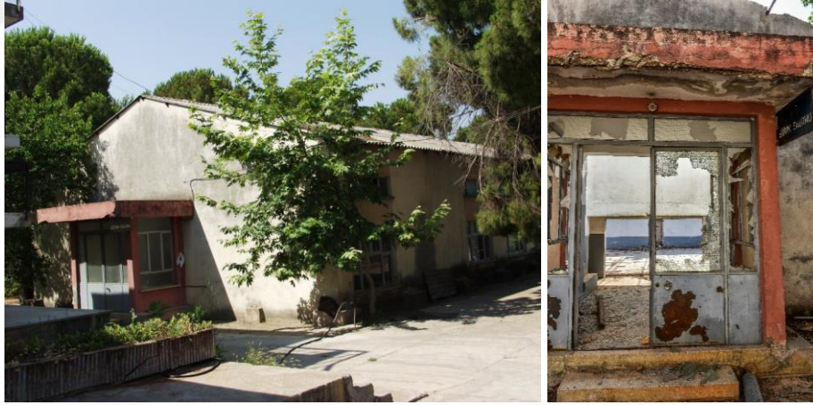
Şekil 6.24 : Eğitim salonu kuzeydoğu cephesi, (Kepez Belediyesi).
