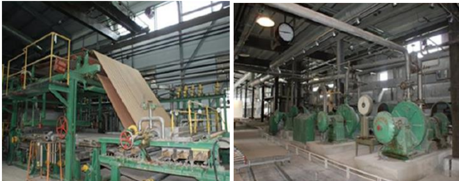
Şekil 5.41 : Kâğıt hamuru makinası (solda) ile hamur hazırlama bölümünde emerson makinalarından görünüm, 2015, (Çakır; Yıldırım, 2015).
