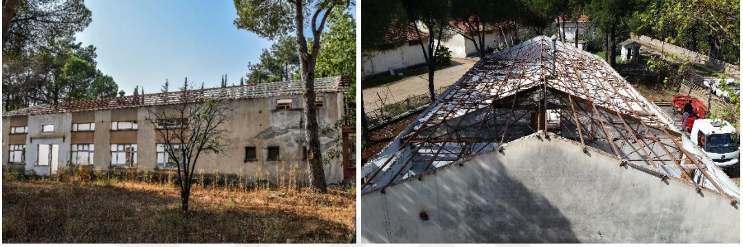
Şekil 6.23 : Eğitim binası güney cephesi (solda), 2015, çatı onarımı (sağda) (Kepez Belediyesi).
