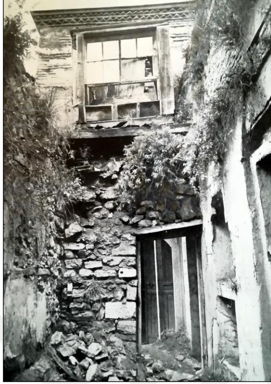
Resim 3.75: 1939 yılında İmrahor Odasının durumu ve yapı içerisindeki moloz duvar bölmeler. 419
