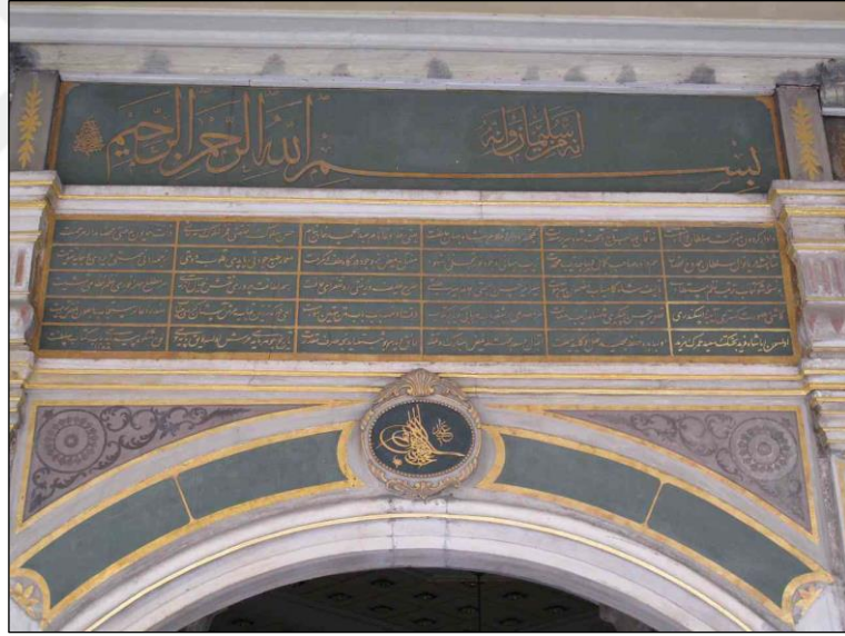
Resim 3.91: Bâbüssaâde’de yer alan Raik tarafından yazılan ve 1774 tarihli olan onarım kitabesi. 456
