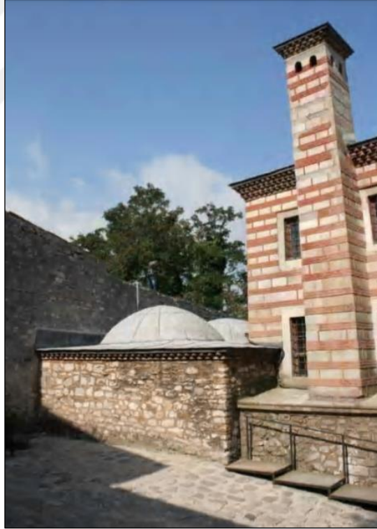
Resim 3.84: Beşir Ağa Camii Hamamı. 434
