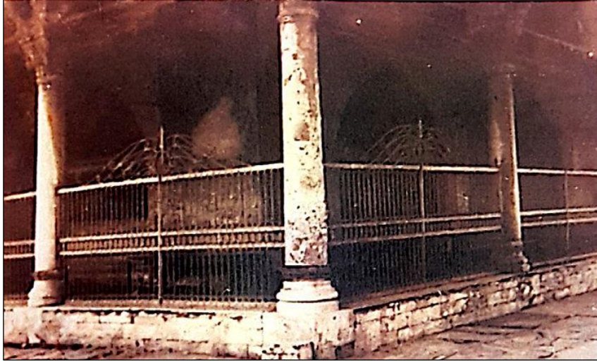
Resim 3.39: Kubbealtı revağında bulunan, 1943 onarımlarında kaldırılan demir korkuluklar ve duvar sekisi. 326
