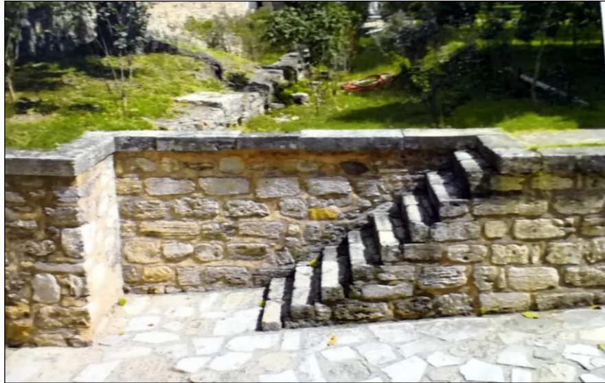
Resim 3.109: Darü's-saâde Ağası Yazıcıları Dairesi ve istinad duvarı üzerindeki merdiven.
