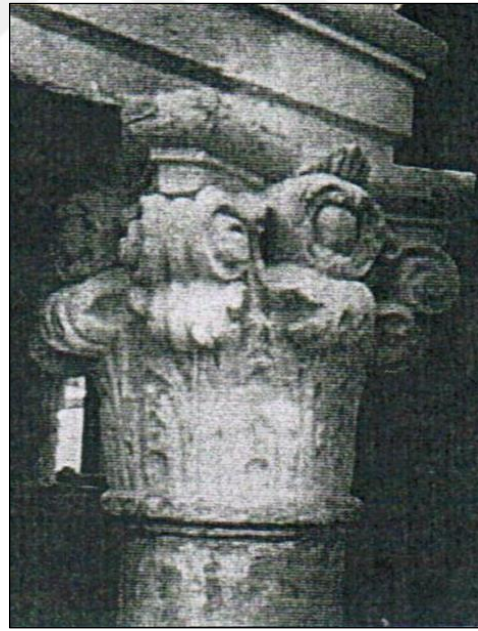
Resim 3.56 : Onarım öncesi sütun başlarındaki bozulmalar(sol) ve onarım sonrası sütun başları (sağ) 365
