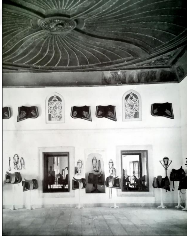
Resim 3.76: 1940-1941 yıllarında yapılan onarım çalışmalarından sonra İmrahor Odası'nın durumu. 420
