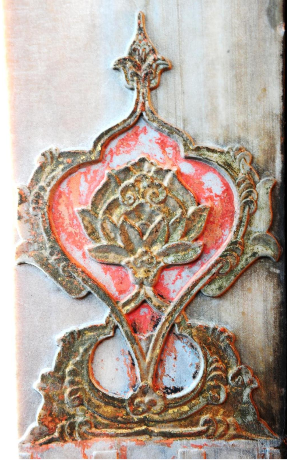
F. 96 Giriş Kapısı Kasasındaki Tezyinat
