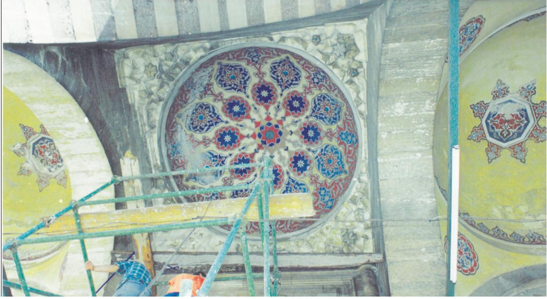
F. 102 Cümle Kapısı Kubbe Restorasyon
