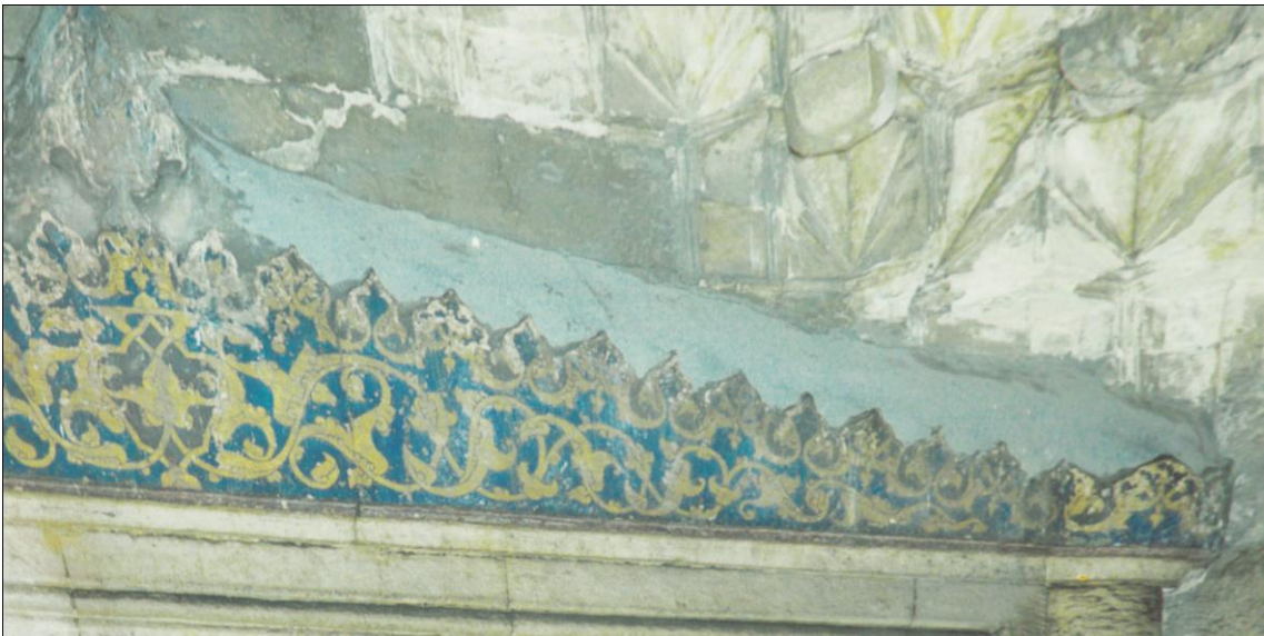
F. 98 Giriş Kapısı Tâc Restorasyon Öncesi
