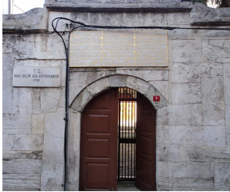
F. 1. Hacı Selim Ağa Kütüphanesi Dış Kapı Girişi
