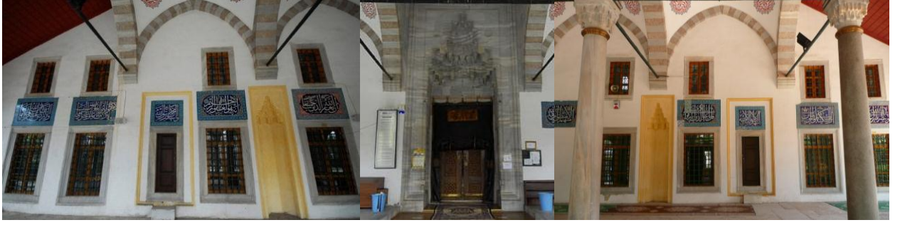
R.63: Soncemaat Mahallindeki Hatlı Çini Panoların Cepheden Görünüşü.
