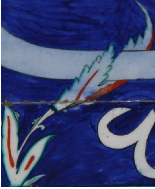
R.221: Güney Duvarında Üçüncü Sıra Alınlıkta Hatlı Çini Panodaki Yaprak Motifi.
