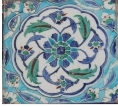
R.287: Soncemaatte Dördüncü Pencere Alınlık Bordüründe Sağ Üst Köşe Yanında Eksilen Çini 16-17. yüzyıl Sultanahmet Camii Mahfili Çinilerine Benzer Çiniler İle Tamamlanmıştır.
