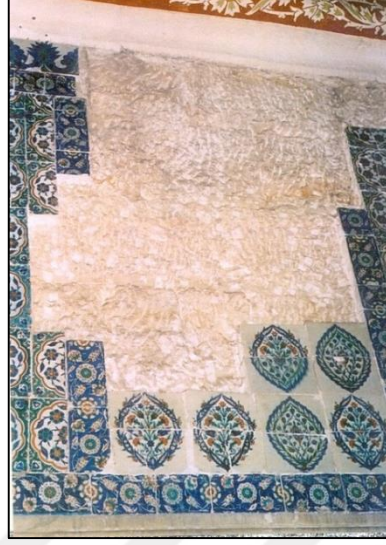
R. 646. Sultan Ahmet Camii çinileri
