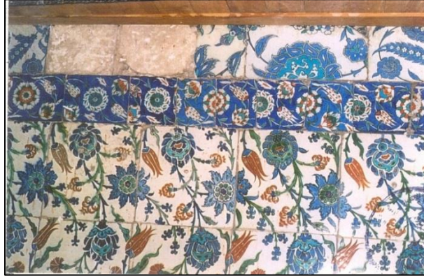
R. 643. Sultan Ahmet Camii çinileri
