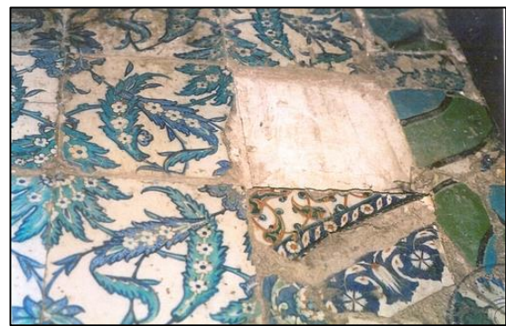
R. 639. Sultan Ahmet Camii çinileri
