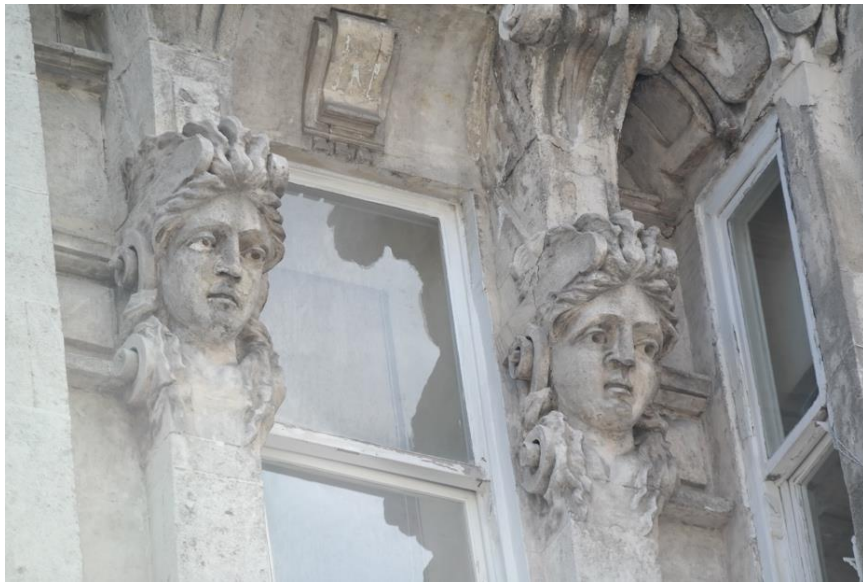
R. 185 İstanbul Art Nouveau Mimarisi Kapsamında Bir Yapı Da İnönü Caddesi No: 26 Gümüşsuyu Palas'ın Dış Cephesinden Detay
