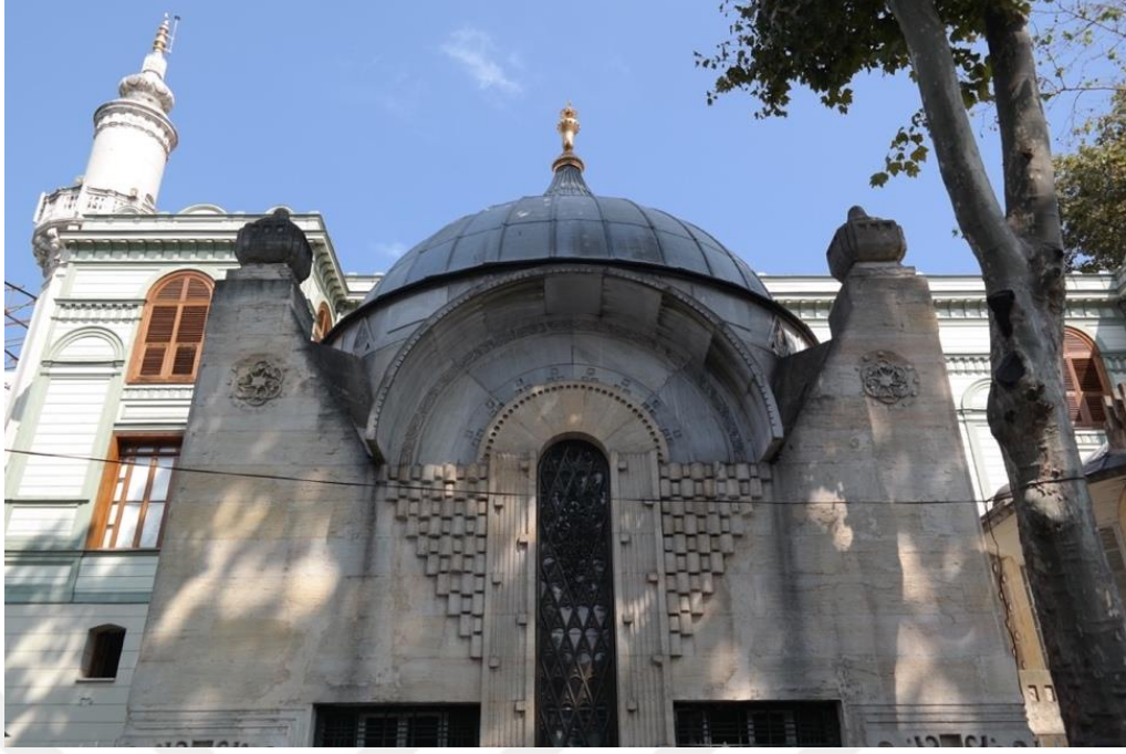
R. 106 Şeyh Zafır Türbesi
