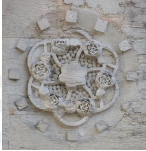
R. 166 Şeyh Zafir Türbesi Dış Cephesinde Rozet
