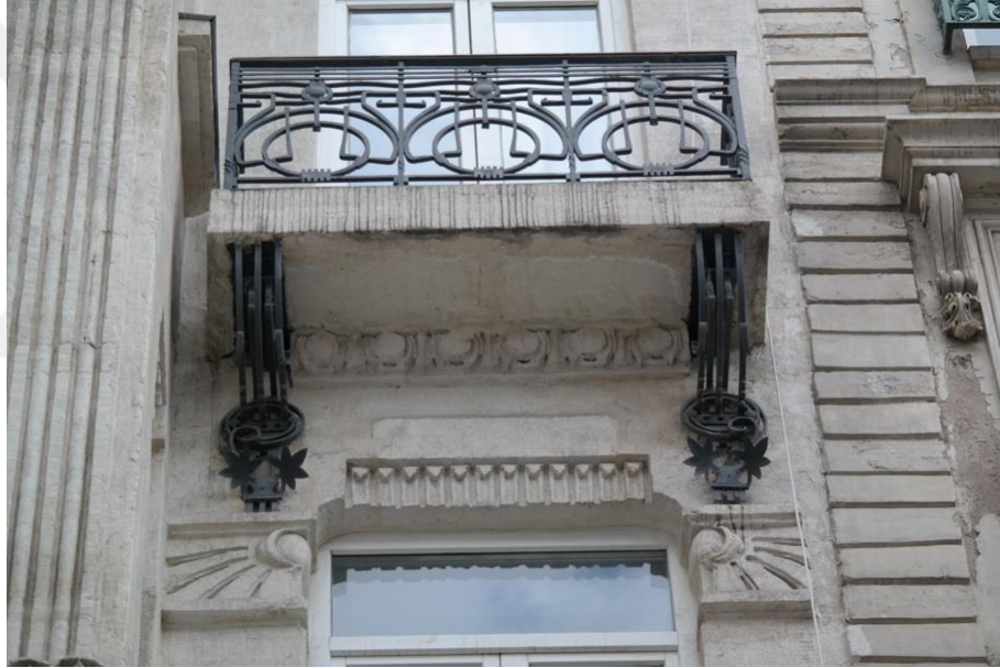
R. 180 İstiklal Caddesi No: 201. Apartman Dış Cephe
