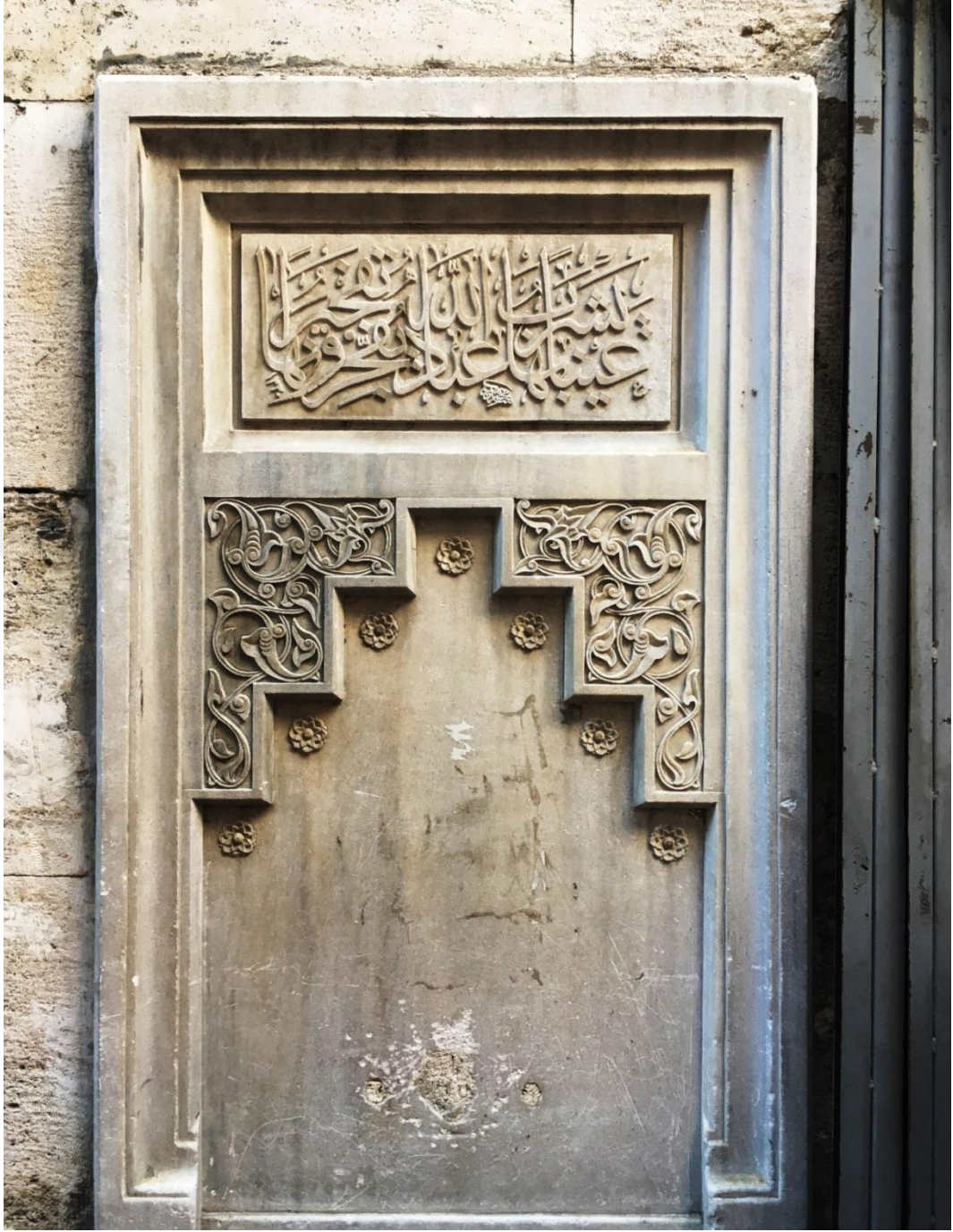
Resim 55. Sultanhamam duvarındaki Çeşme.( Fotoğraf: Ebubekir Altrok 11/08/2016)
