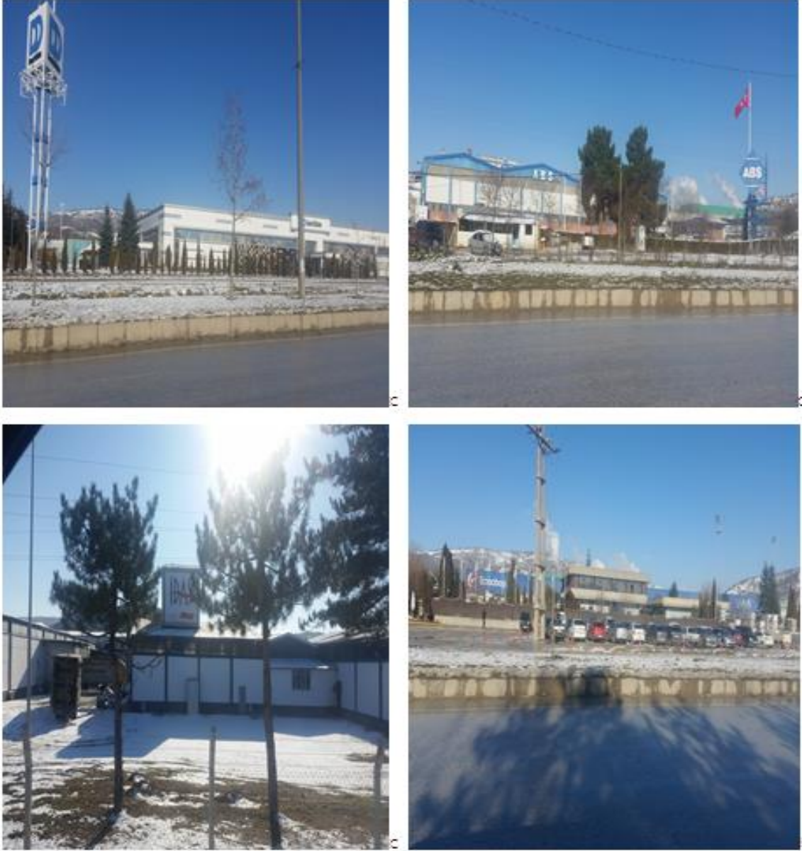
Şekil 4.4. Bozüyük sanayii tesisleri
