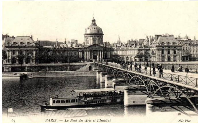
Şekil 3.41. Sanatlar Köprüsü (Pont des Arts), Paris. Delon de Cessart, 1801-1803 ( http-50 ).
