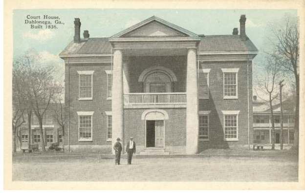
Şekil 3.10. Adliye Binası, Dahlonega, Georgia, 1836, Ephraim Clayton ( http-20 ).
