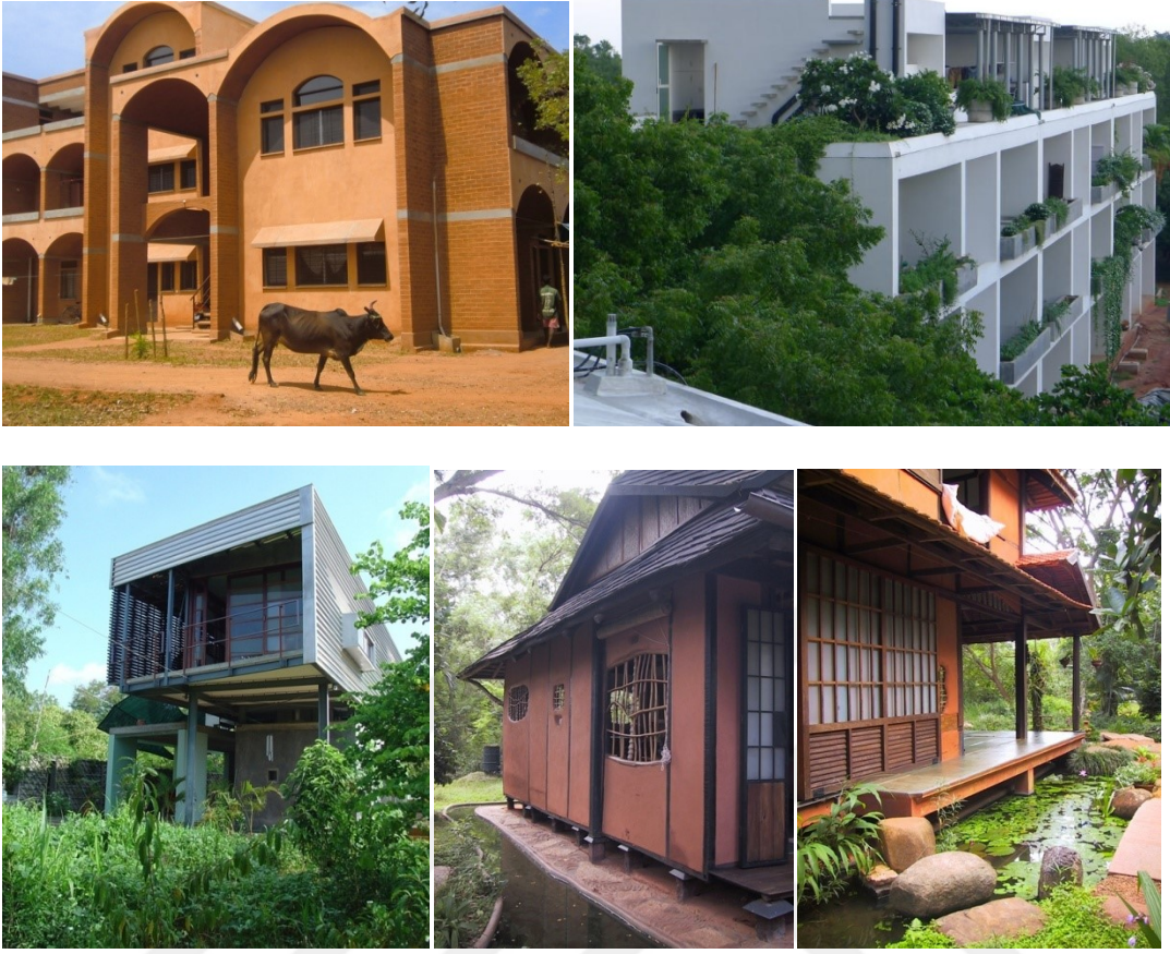
Görsel 2.8. Yerleşkedeki yapılara örnekler (AUROVILLE, 2018)
