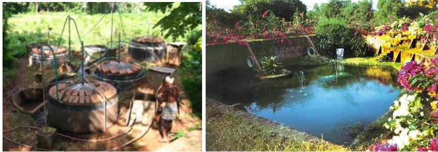
Görsel 2.7. Biyogaz ve Atıksu arıtma tesisi (AUROVILLE, 2018)
