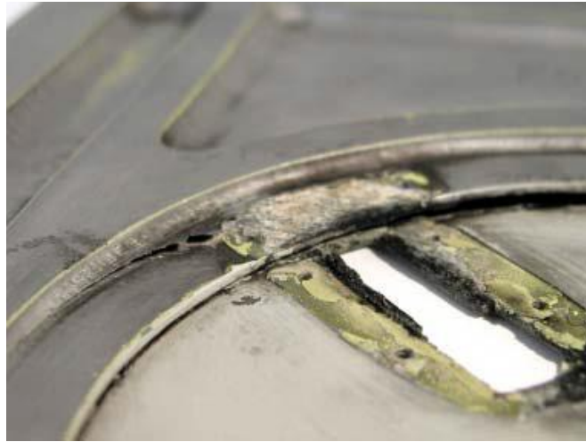
Görsel 3.13. Bakım kapağı altındaki korozyon (Findlay and Harrison, 2002)
