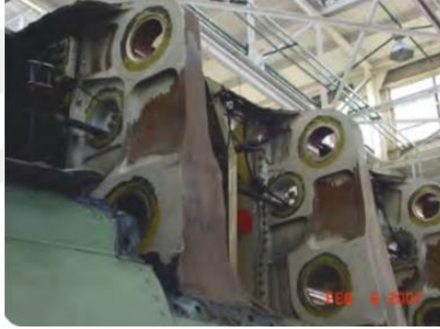
Görsel 3.12. F-18 uçağında korozyon (Rose and Legg, 2014)
