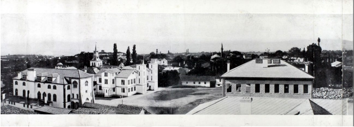
Şekil 3.10. Anadolu Hastanesi'nden Kuzey Koleji, ana bina ve Kütüphane-Müze Binası'nın görünüşü (http-23)
