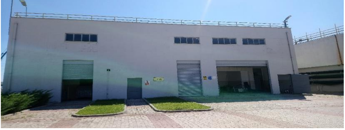
Görsel 5.1. Fiziksel arıtma ünitesi görüntüsü
