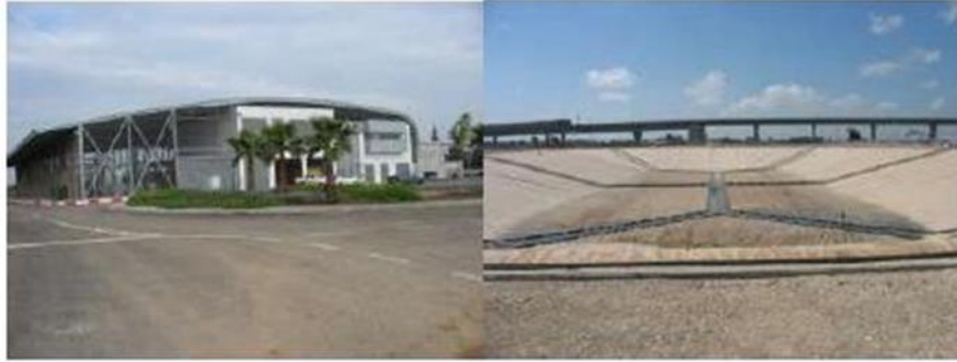
Görsel 2.1. Ben Gurion Havaalanı geri kazanım tesisi
